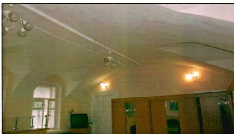
8. Сводчатые перекрытия в уровне первого этажа.
