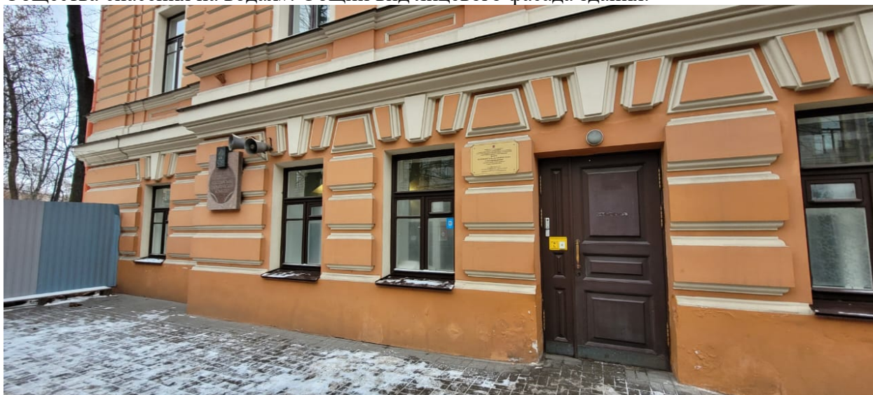
Фото 2. Объект культурного наследия регионального значения «Правление и склад Общества спасения на водах». Фрагмент лицевого фасада здания.
