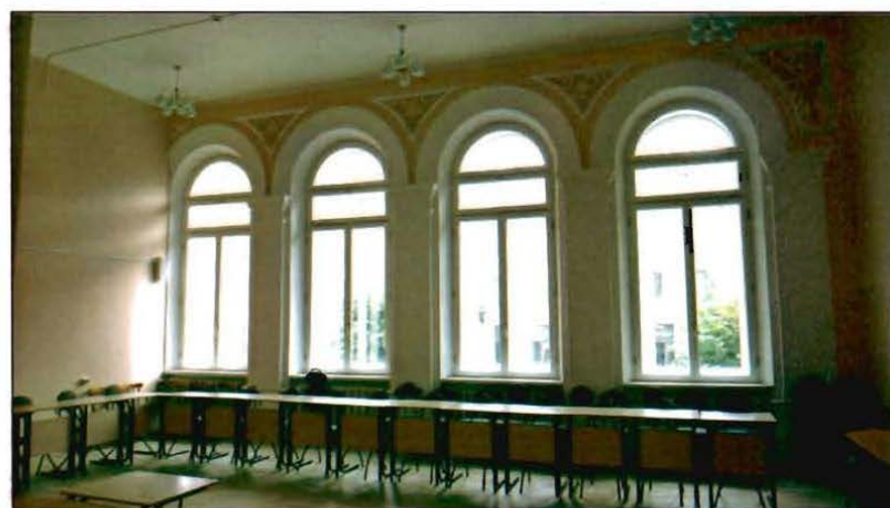
9. Оформление оконных проемов в помещении третьего этажа.
