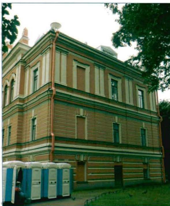
4. Северо-восточный фасад. Вид с востока.
