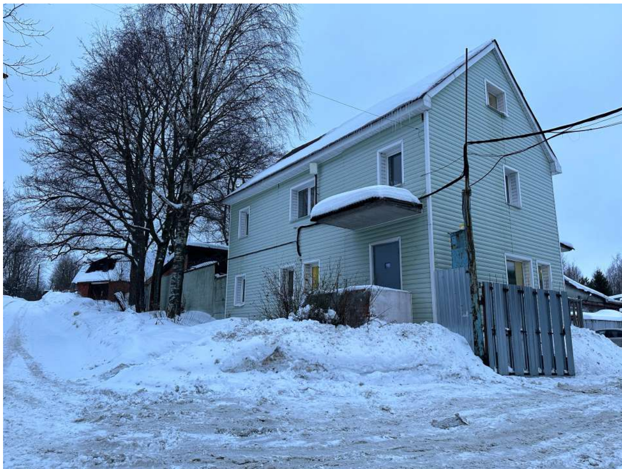
Точка фотофиксации 1. Общий вид на объект газификации с В.
