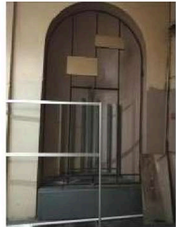
вестибюль при входе с северной стороны
