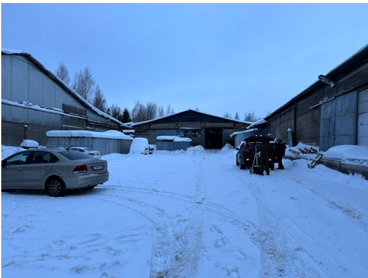
Точка фотофиксации 4. Внутренняя территория объекта газификации. Вид с ЮВ.
