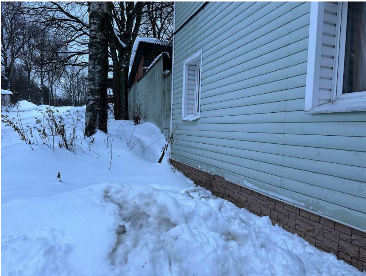
Точка фотофиксации 3. Общий вид на объект газификации с В.
