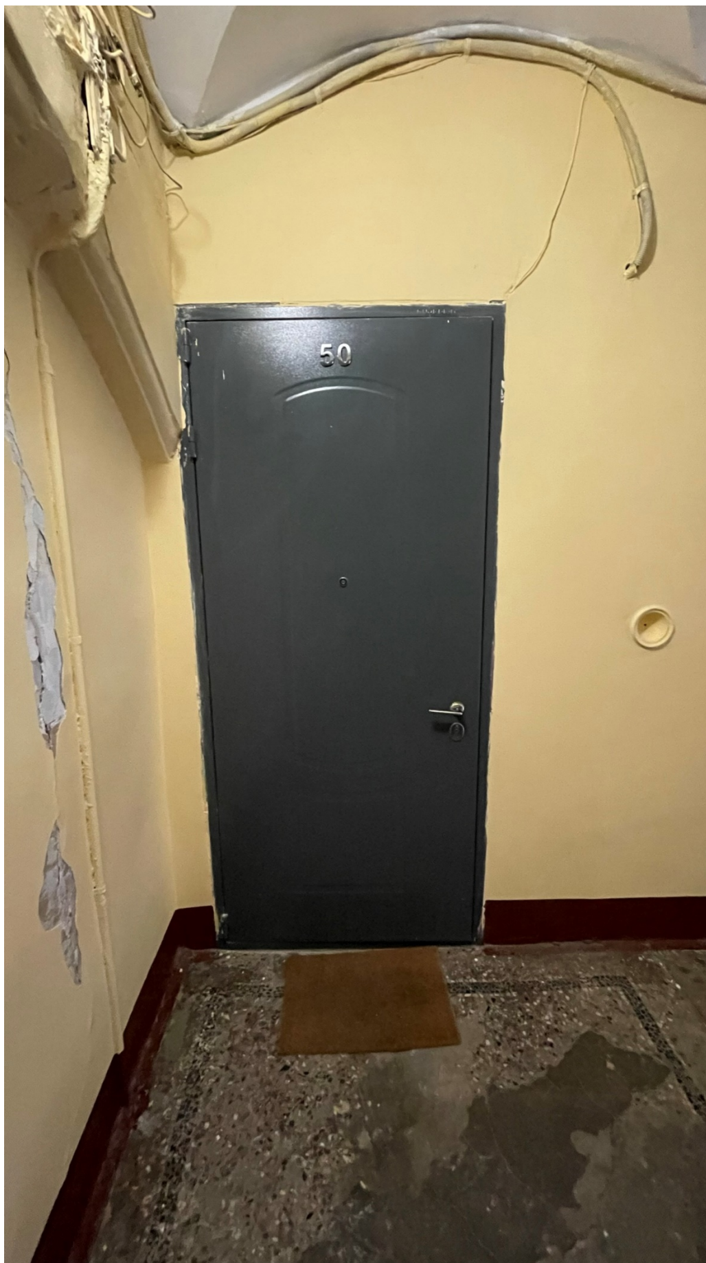
17. Вид на входную дверь в квартиру;
