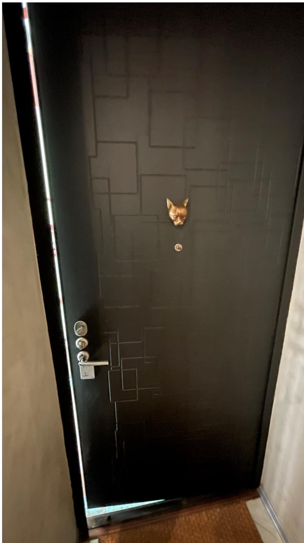
4. Вид на входную дверь в квартире;
