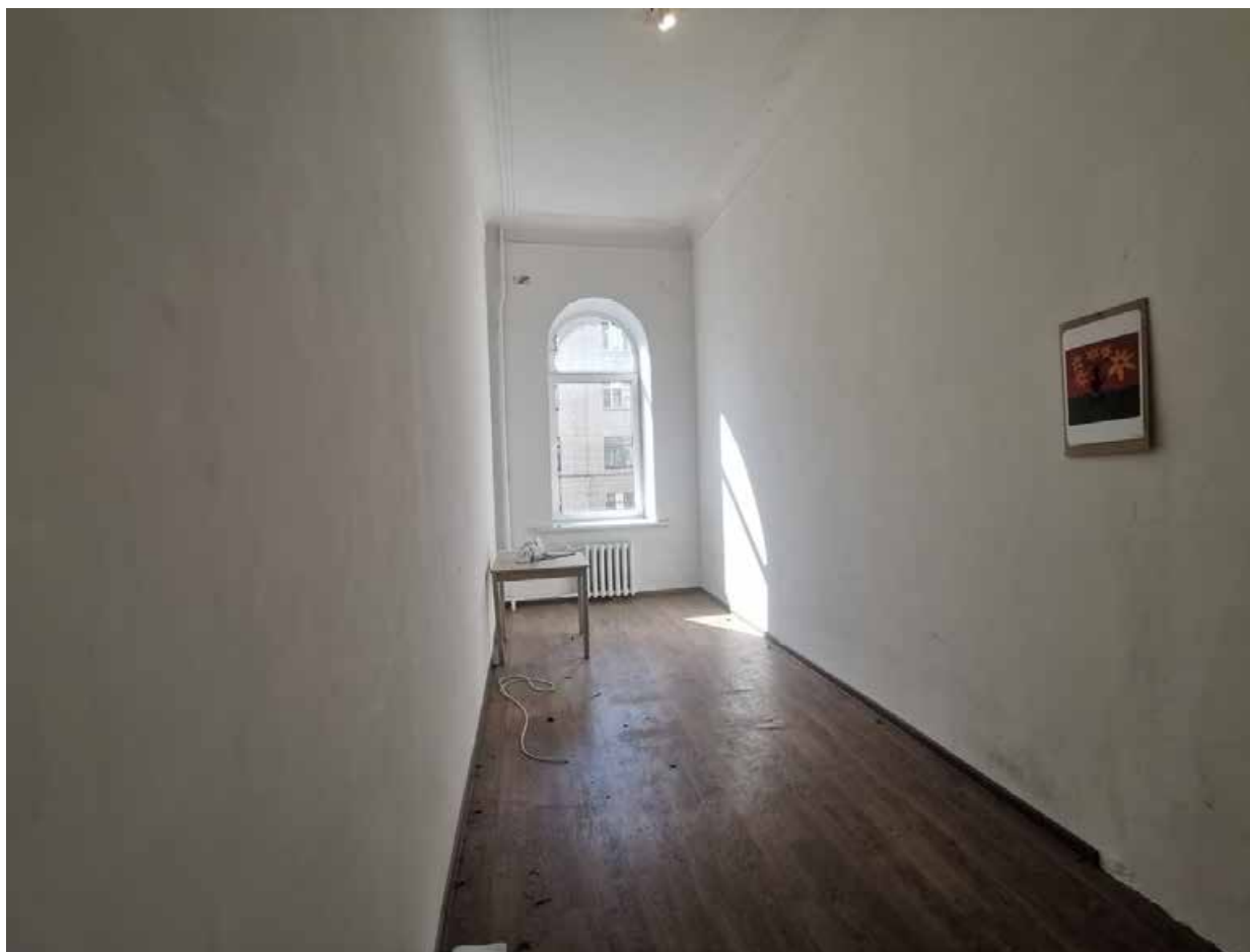
13. Фрагмент интерьера комнаты (помещение 8/16.1);
