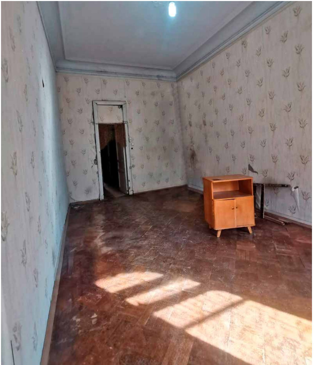
12.Фрагмент интерьера комнаты (помещение 7/27.2);
