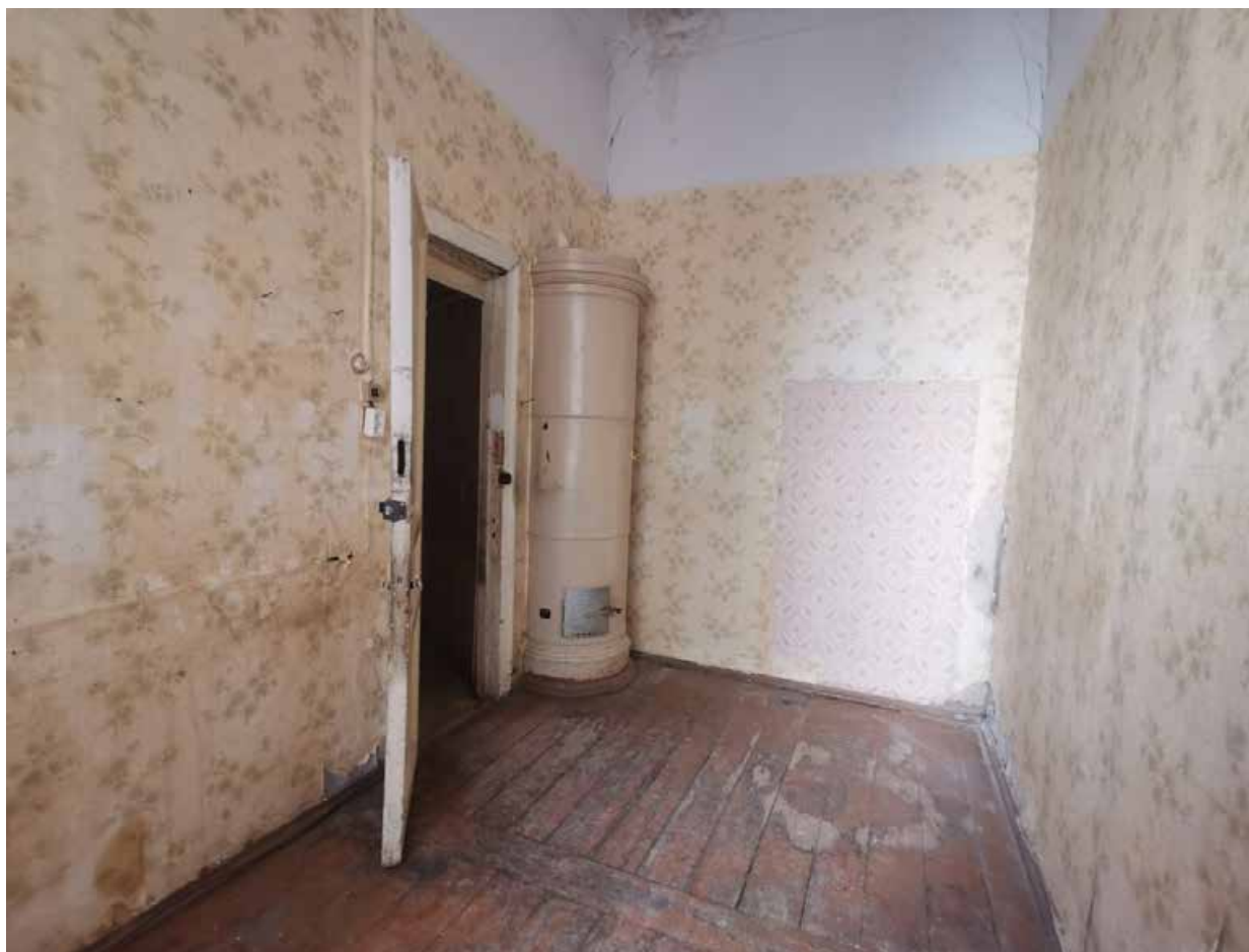
9. Фрагмент интерьера комнаты (помещение 4/10.8);
