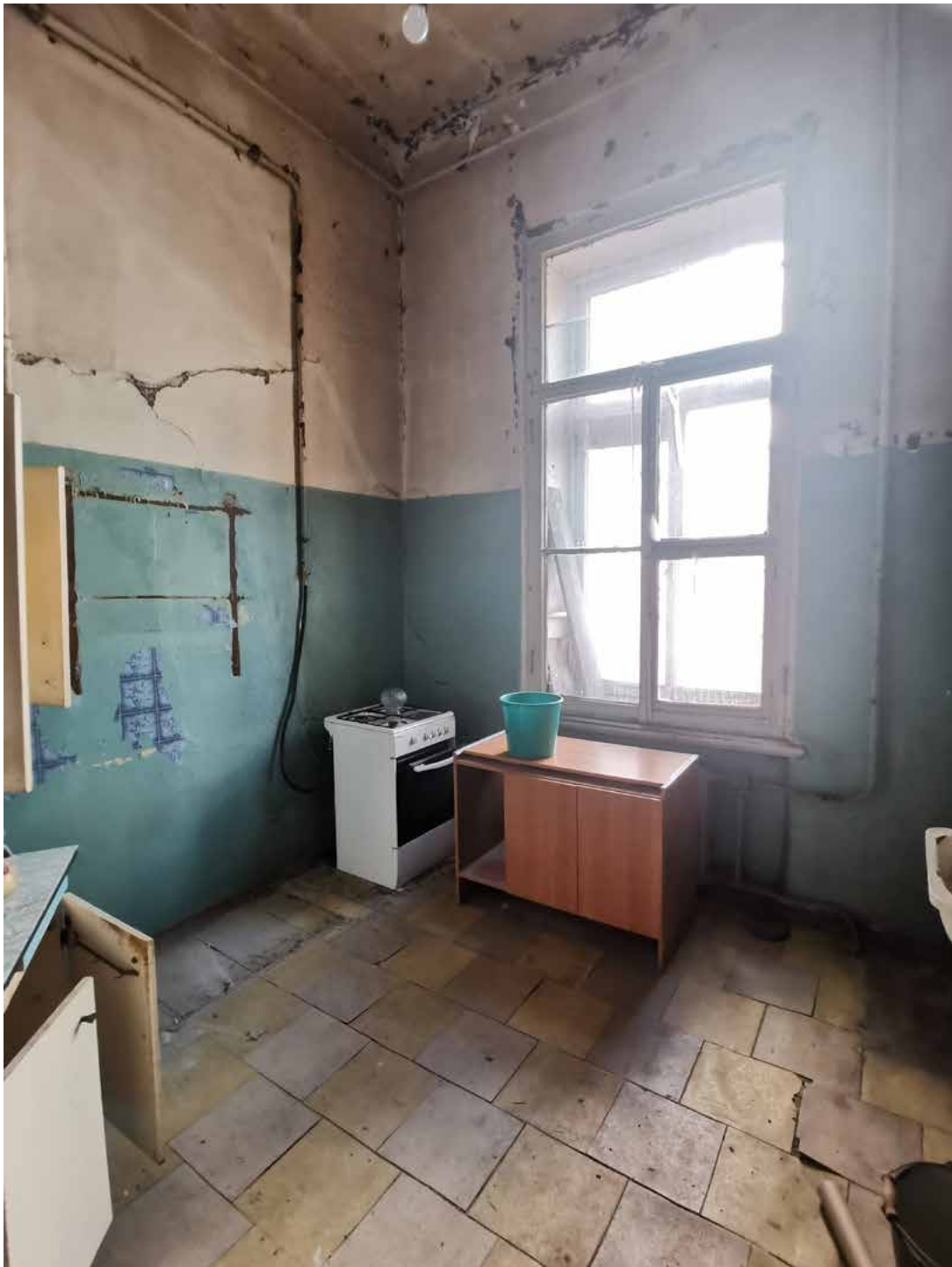
7. Фрагмент интерьера кухни (помещение 3/10.3);
