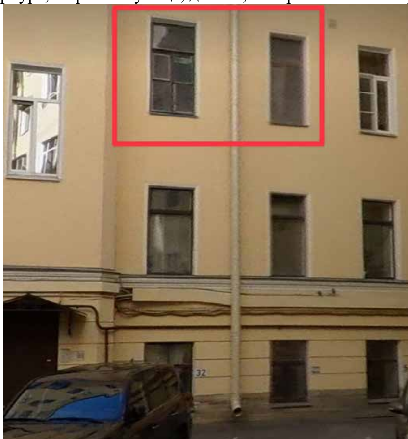
3. Фрагмент фасада объекта культурного наследия регионального значения «Дом А.И. Шульгина», расположенного по адресу: г. Санкт-Петербург, Кирочная улица, дом 45, литера А и окна квартиры №53;
