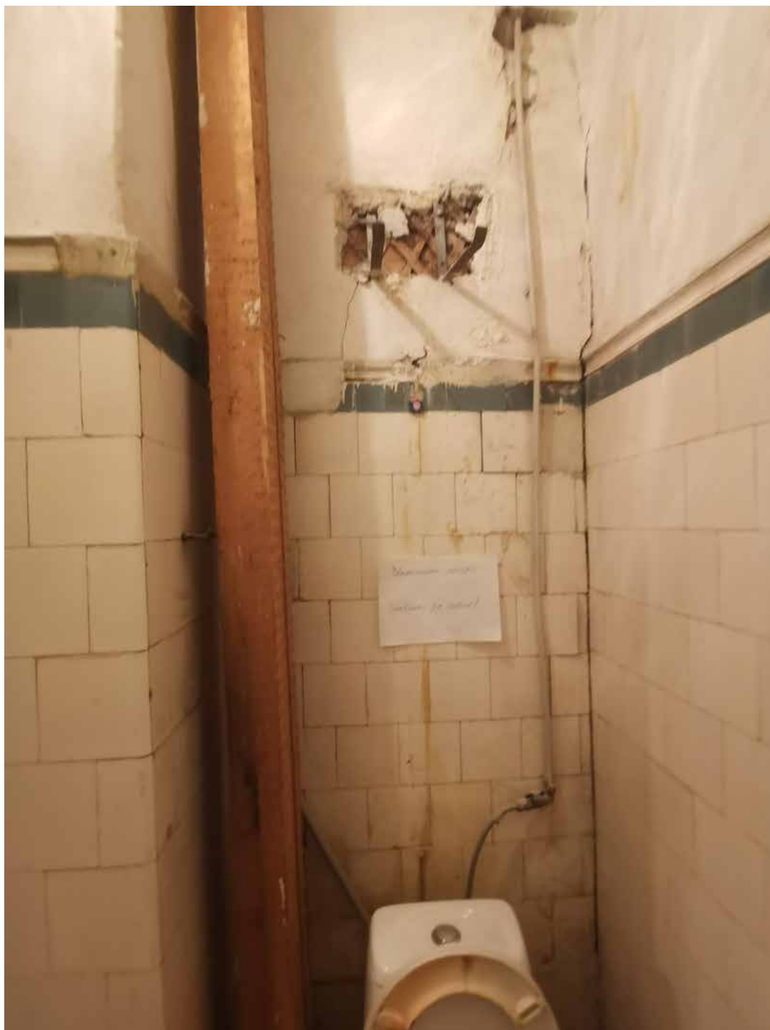
15. Фрагмент интеръера туалета (помещение 9/1.4);
