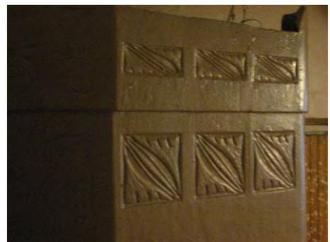
печь в помещении 9Н(2) (средистенная, облицована гладкими и рельефными изразцами; в плане прямоугольной формы, одноярусная, без цоколя, углы скруглены; в верхней части полоса растительного орнамента рельефных изразцов, завершенная стилизованным аттиком с акротериями);
