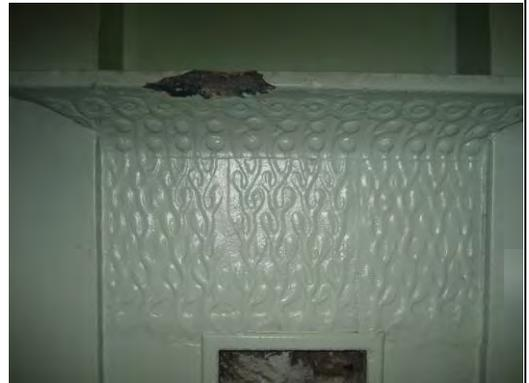
печь парадного вестибюля дворового корпуса (средистенная, облицована гладкими и рельефными изразцами, крашенная; в плане прямоугольной формы, одноярусная, без цоколя, углы скруглены; в верхней части полоса растительного орнамента рельефных изразцов, наверху с повышениями в угловых частях и с полосой растительного орнамента меньшего размера);
