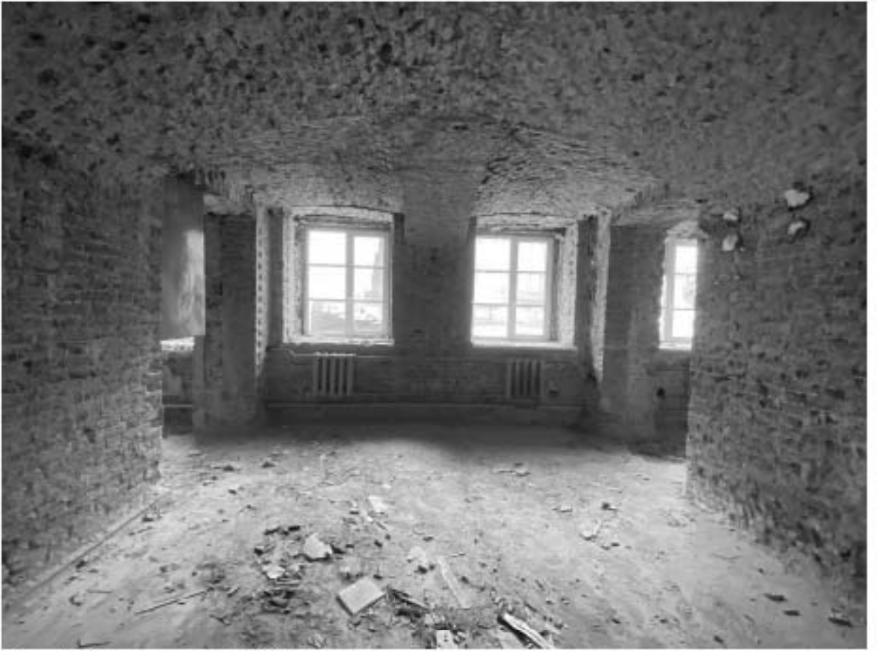
Фото 63. Помещение 1-Н(32). Общий вид.
