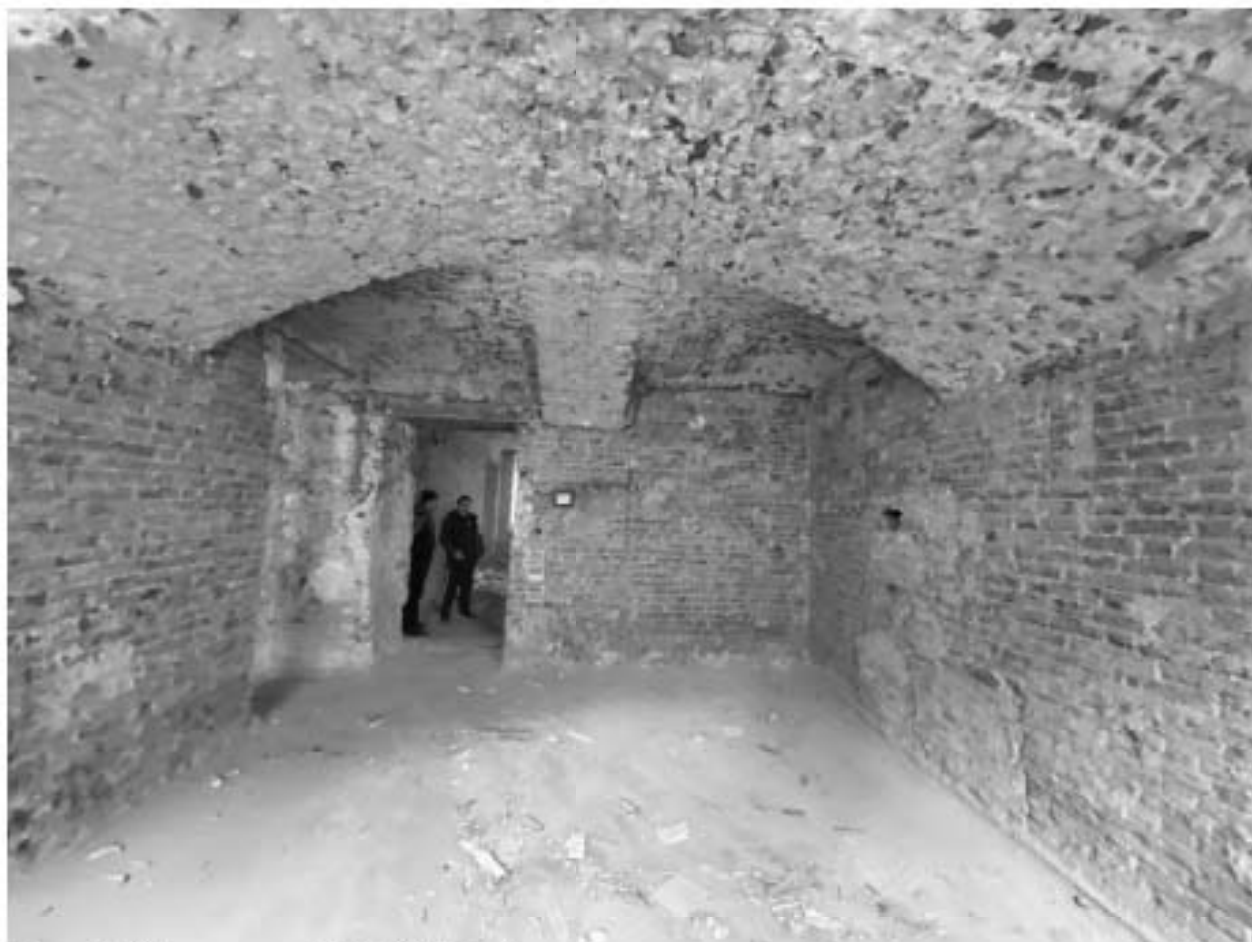
Фото 65. Помещение 1-Н(32). Общий вид.
