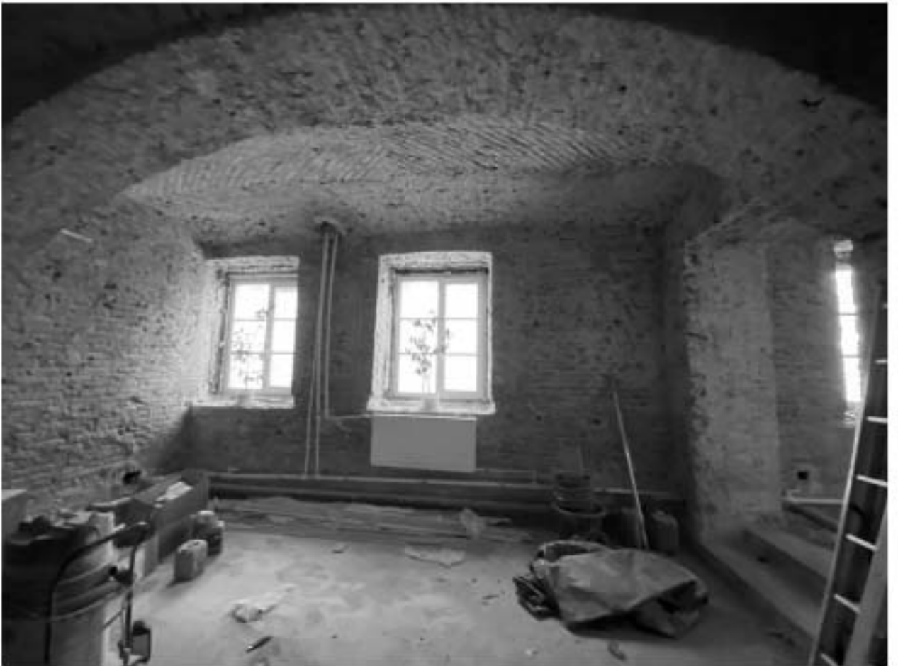
Фото 32. Помещение 1-Н(2). Общий вид.
