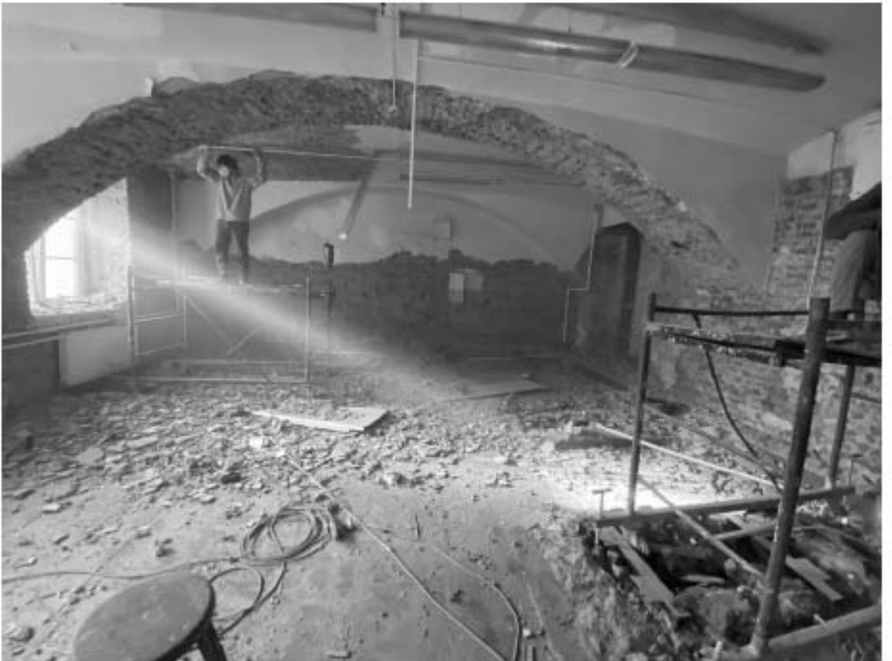
Фото 50. Помещение 1-Н(20). Общий вид.
