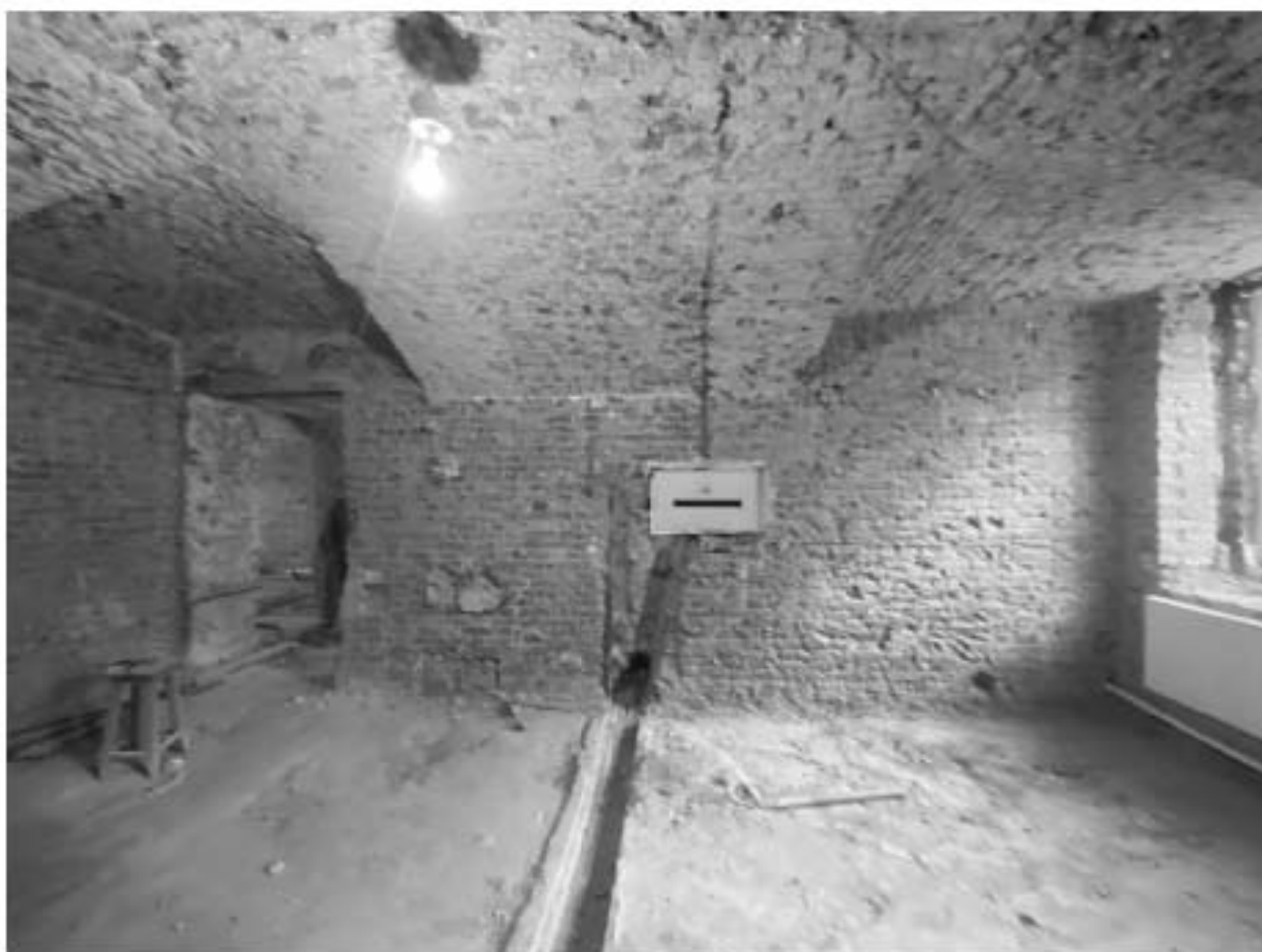
Фото 47. Помещение 1-Н(19). Общий вид.
