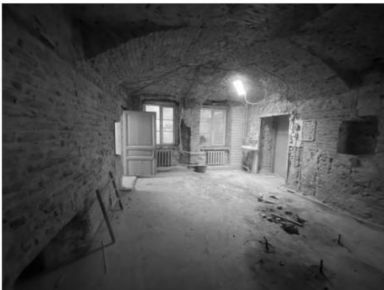
Фото 19. Помещение 1-Н(1,8). Общий вид.
