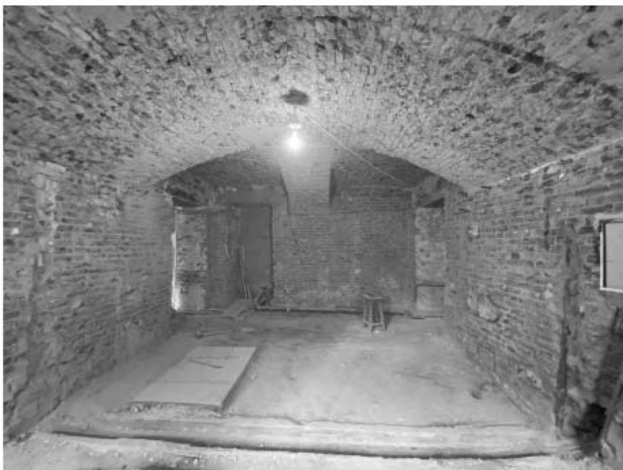
Фото 48. Помещение 1-Н(19). Общий вид.
