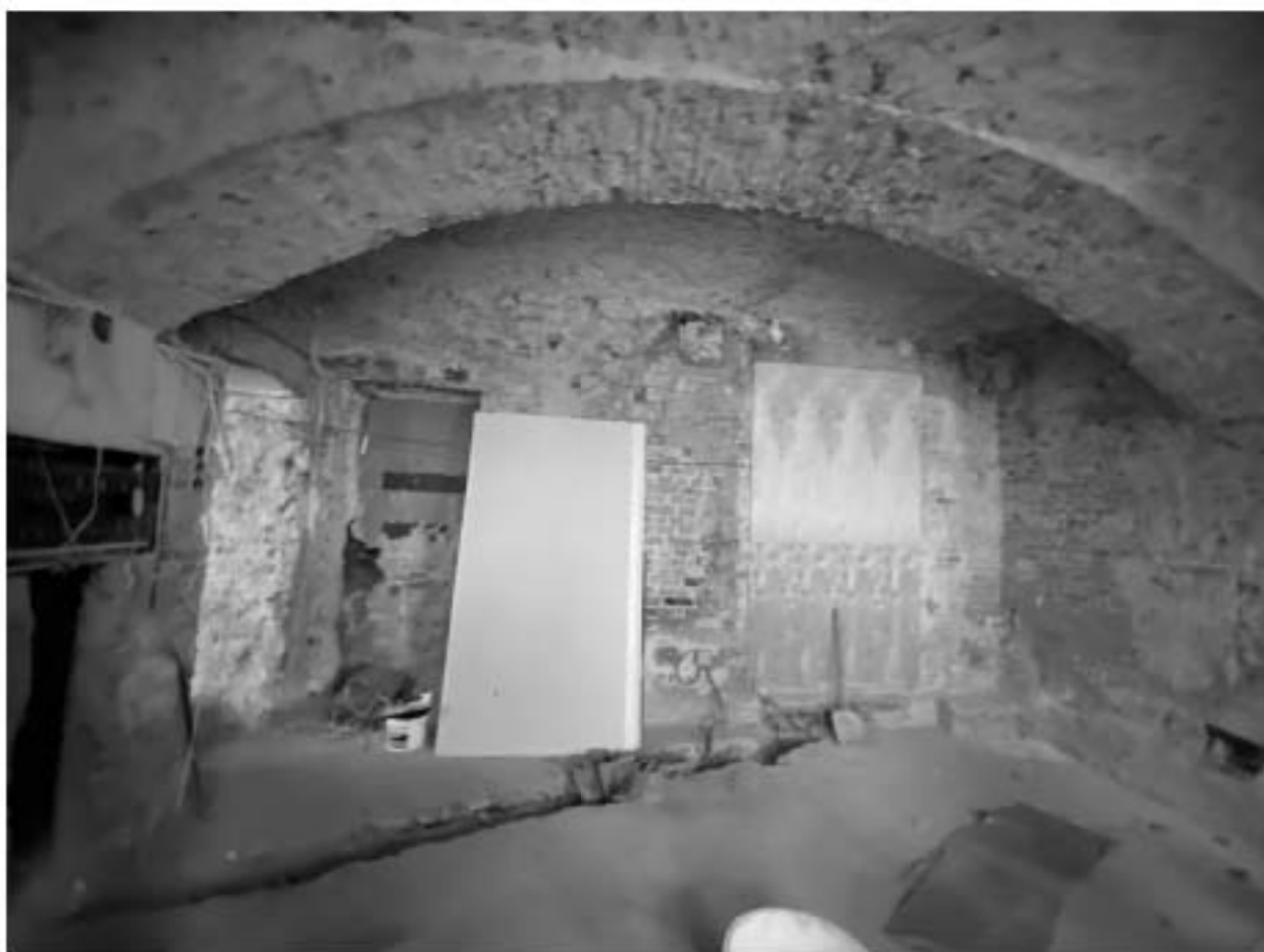
Фото 31. Помещение 1-Н(2). Общий вид.
