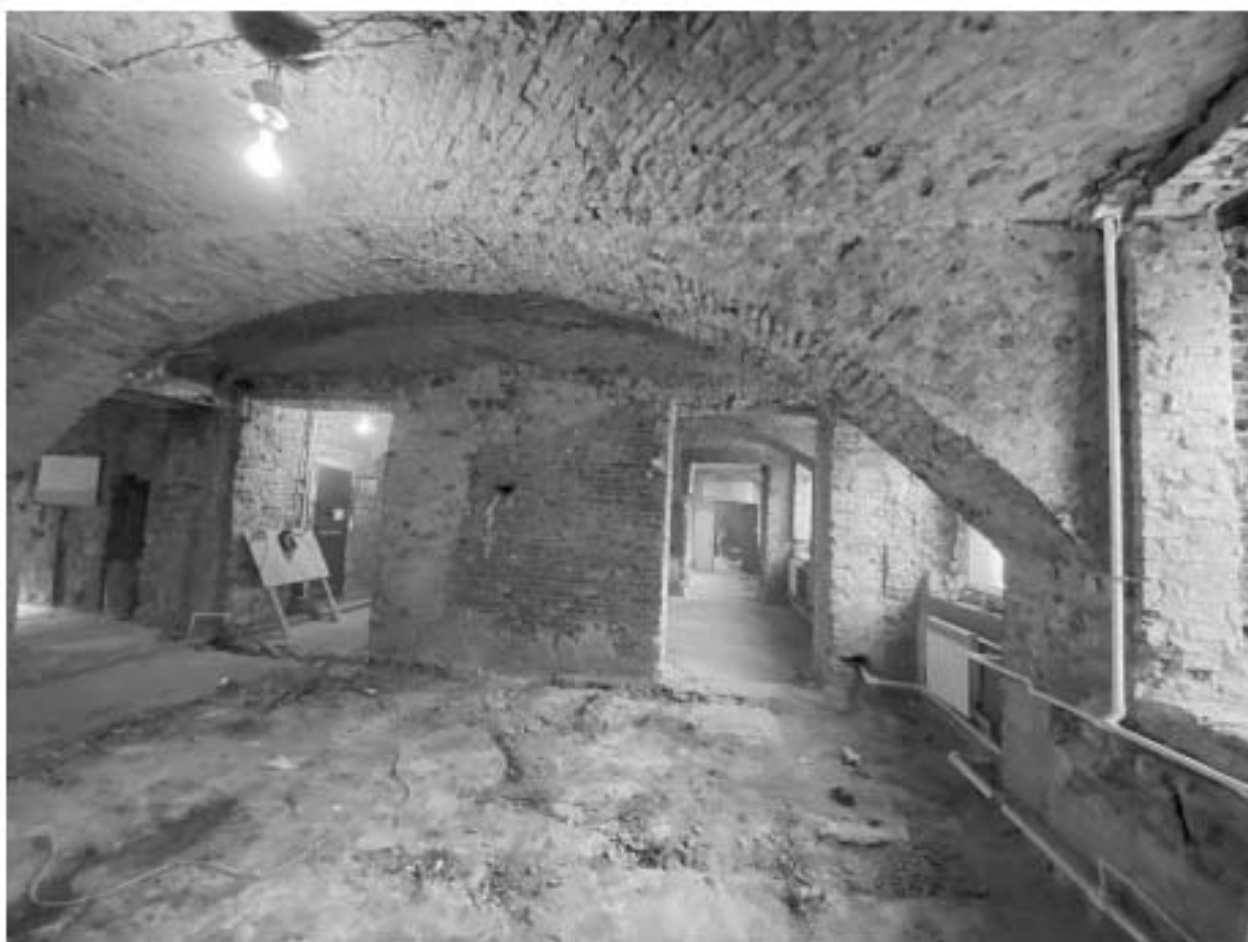
Фото 40. Помещение 1-Н(10-13). Общий вид.
