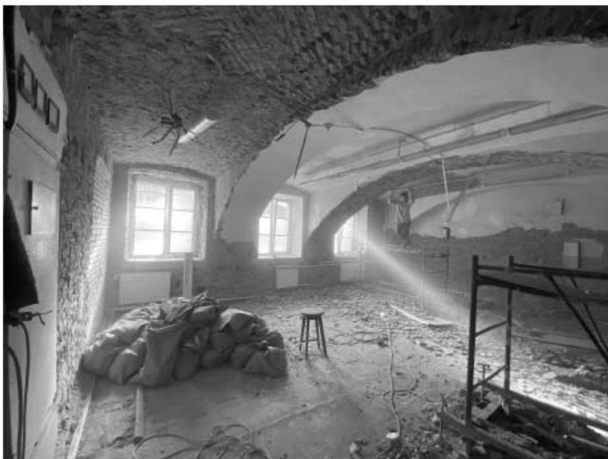
Фото 49. Помещение 1-Н(20). Общий вид.
