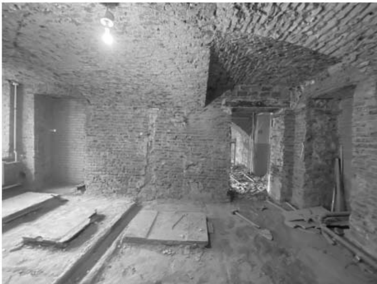
Фото 46. Помещение 1-Н(19). Общий вид.
