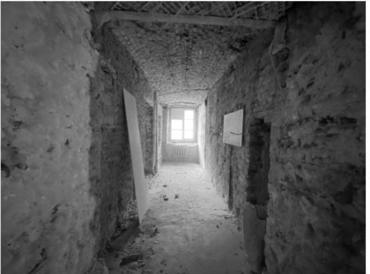
Фото 56. Помещение 1-Н(38,40). Общий вид.
