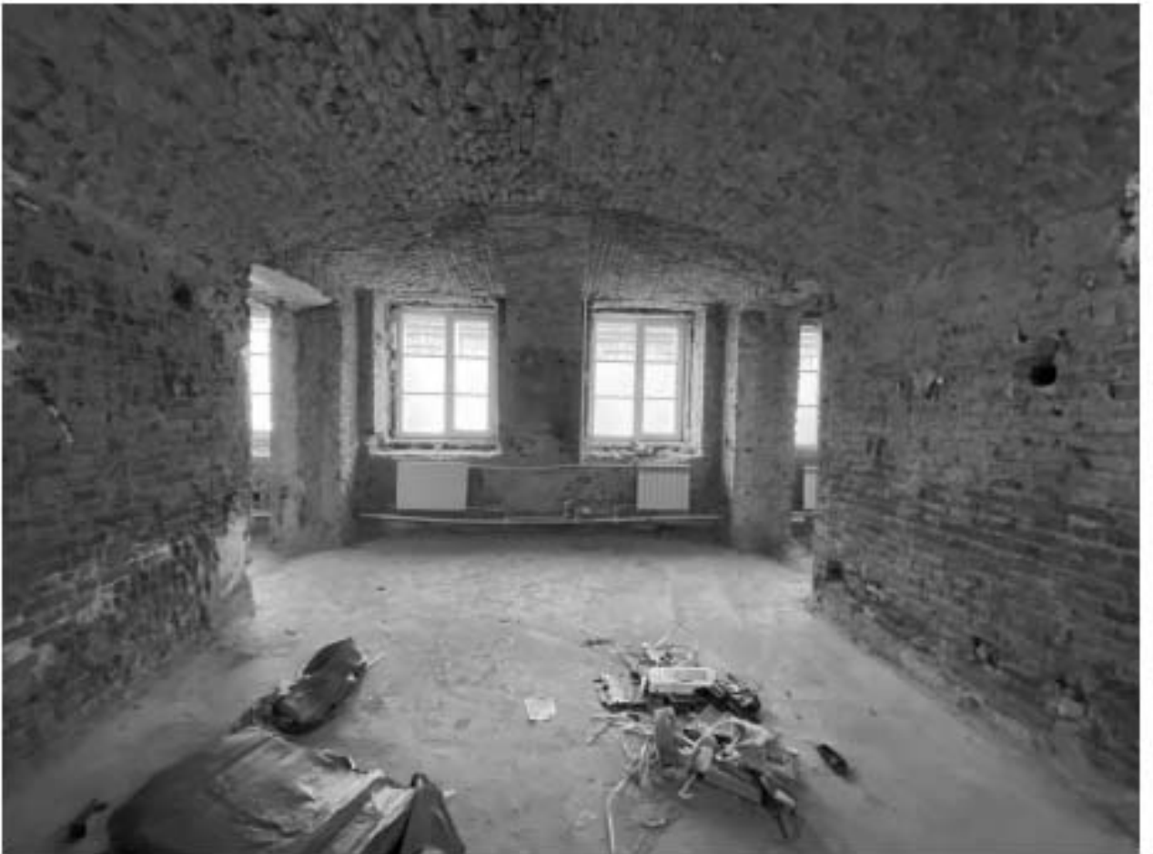
Фото 35. Помещение 1-Н(10,11). Общий вид.
