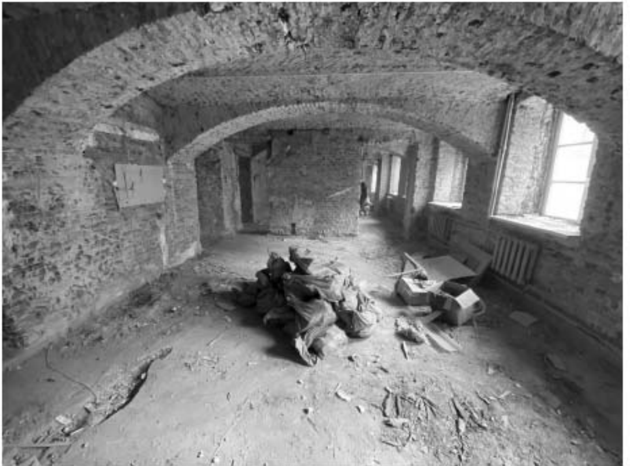
Фото 58. Помещение 1-Н(36,34). Общий вид.
