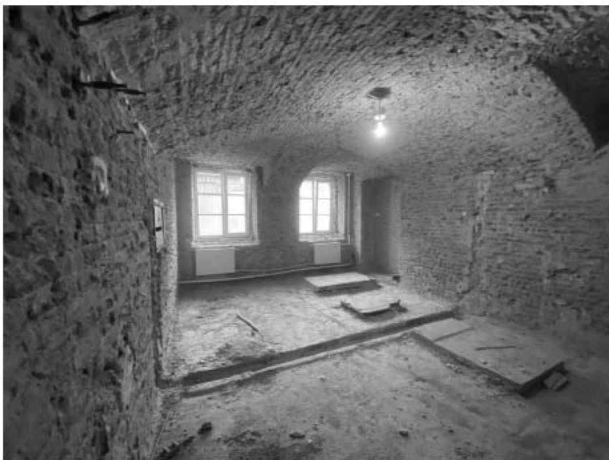
Фото 45. Помещение 1-Н(19). Общий вид.
