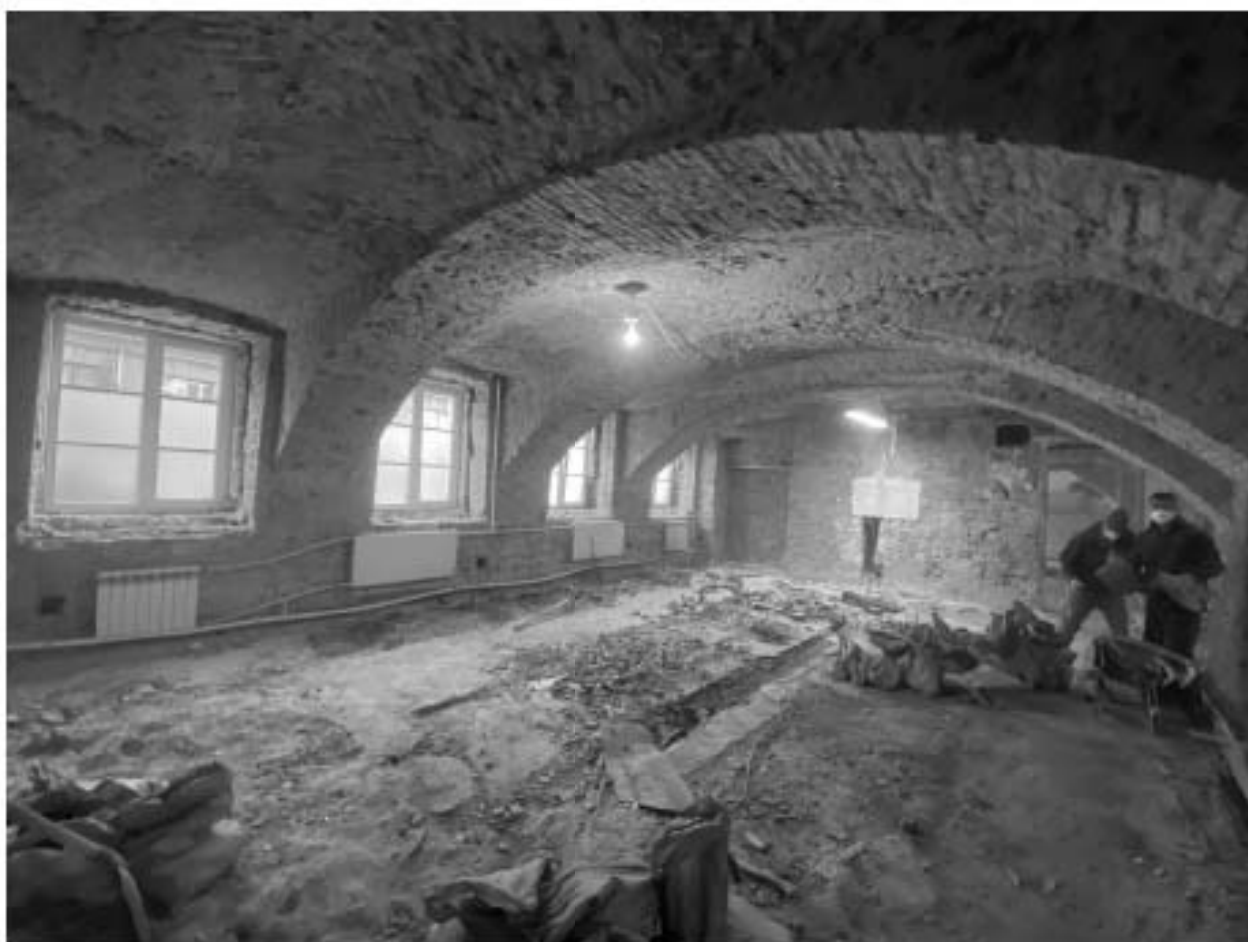
Фото 41. Помещение 1-Н(14,17). Общий вид.
