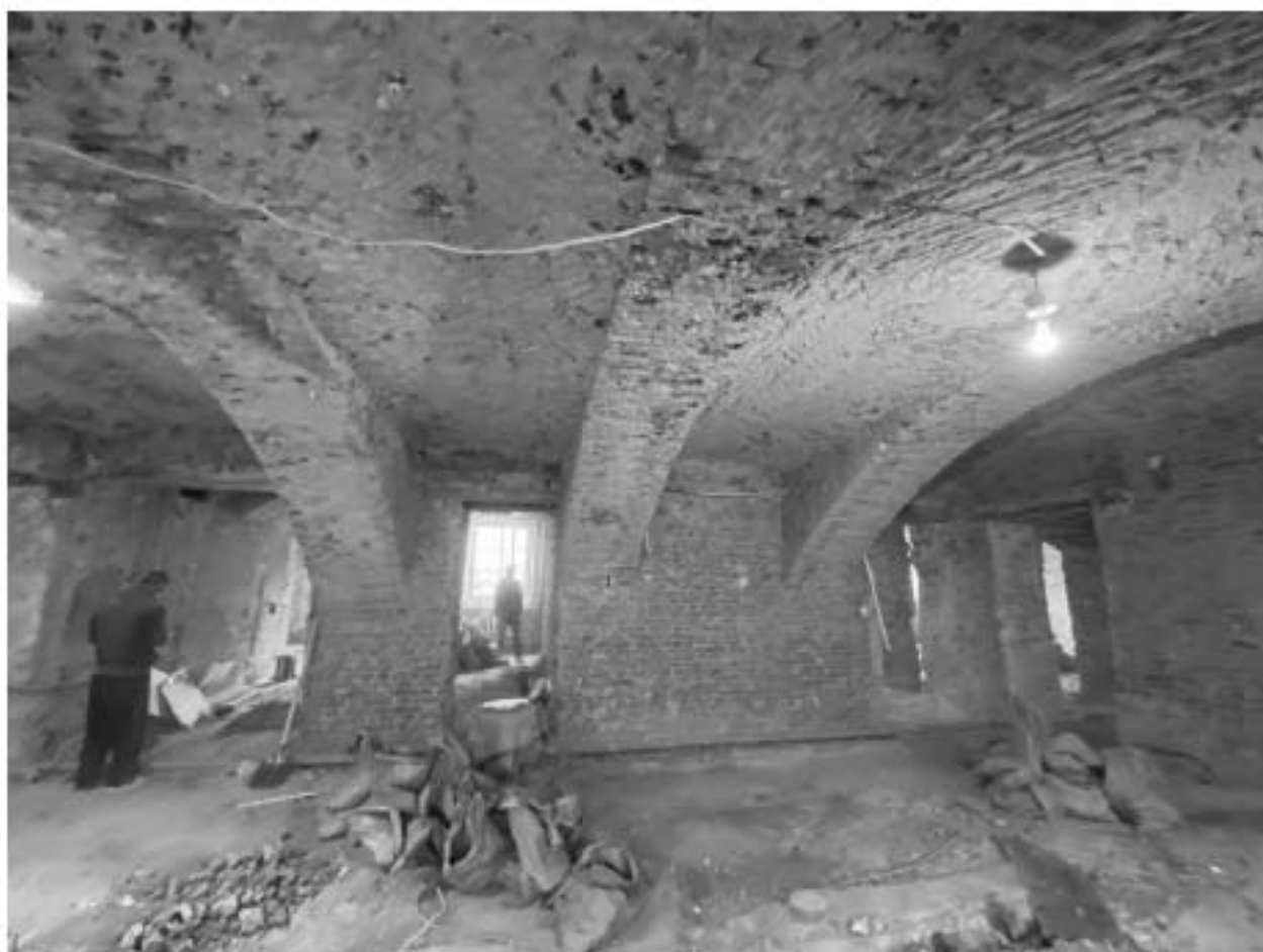
Фото 44. Помещение 1-Н(14,17,18). Общий вид.
