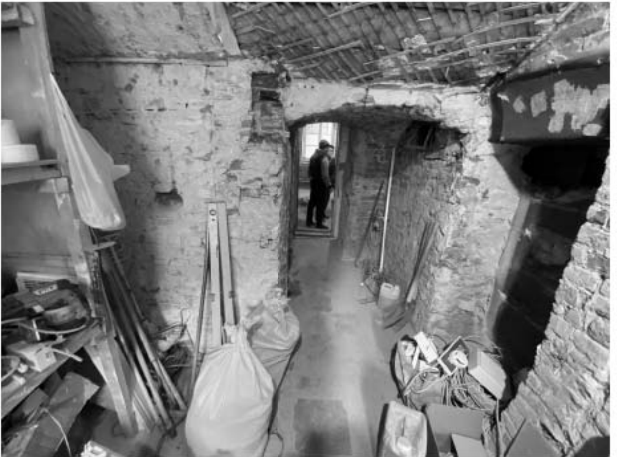
Фото 55. Помещение 1-Н(42,44). Общий вид.
