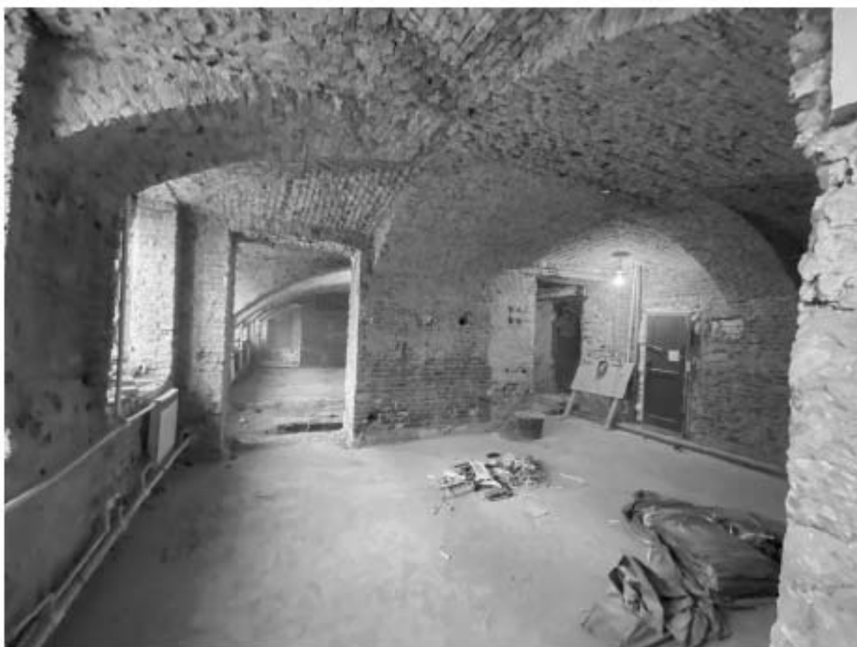
Фото 33. Помещение 1-Н(10,11). Общий вид.
