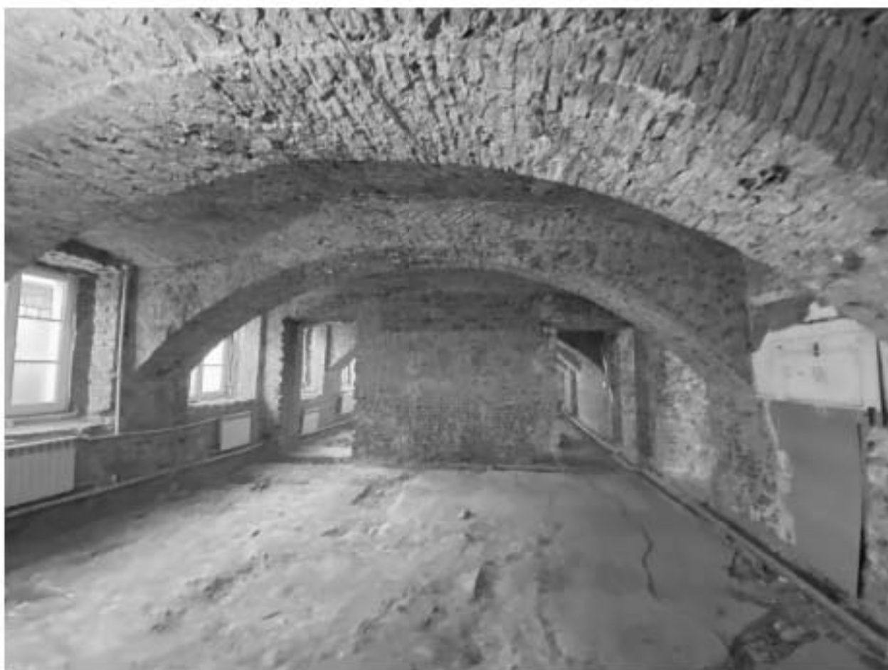
Фото 38. Помещение 1-Н(12,13). Общий вид.
