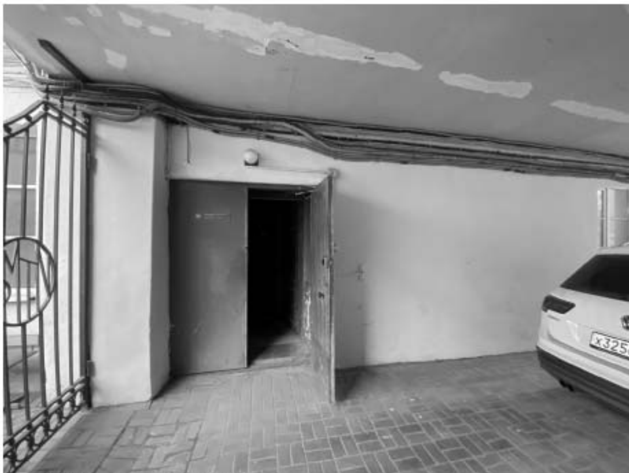
Фото 71. Вход в помещение 1-Н(26).
