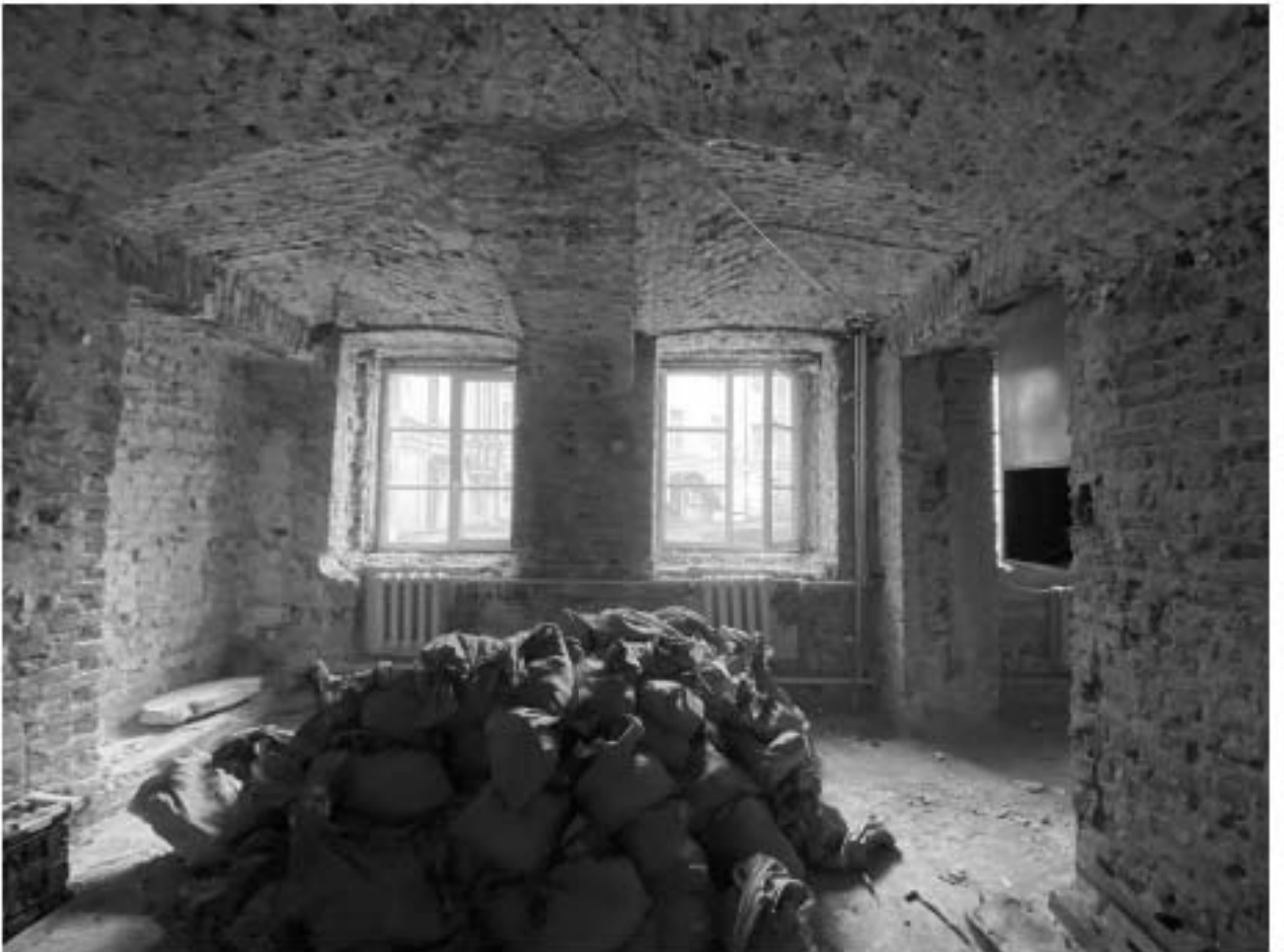
Фото 67. Помещение 1-Н(29). Общий вид.
