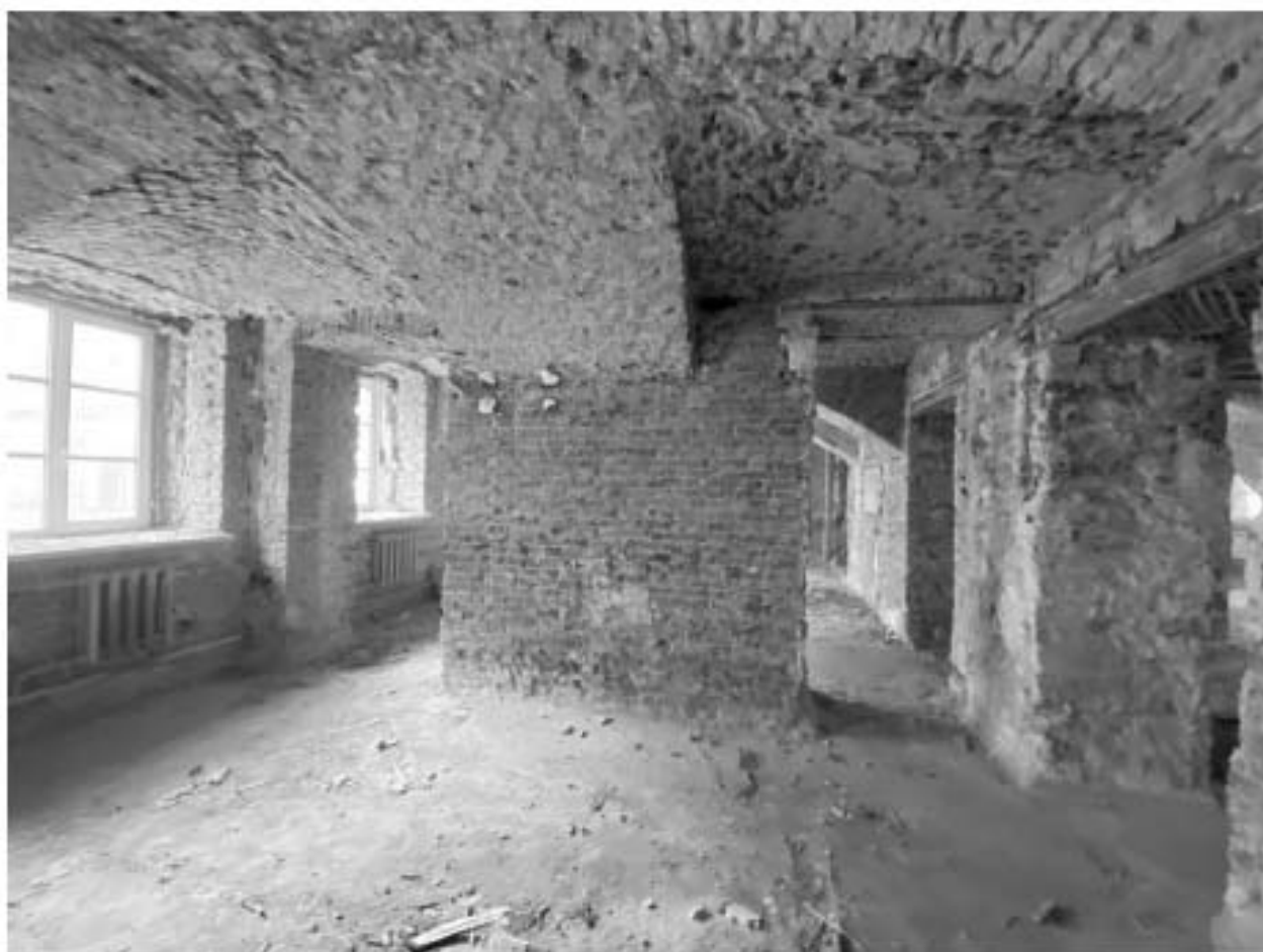
Фото 64. Помещение 1-Н(32). Общий вид.
