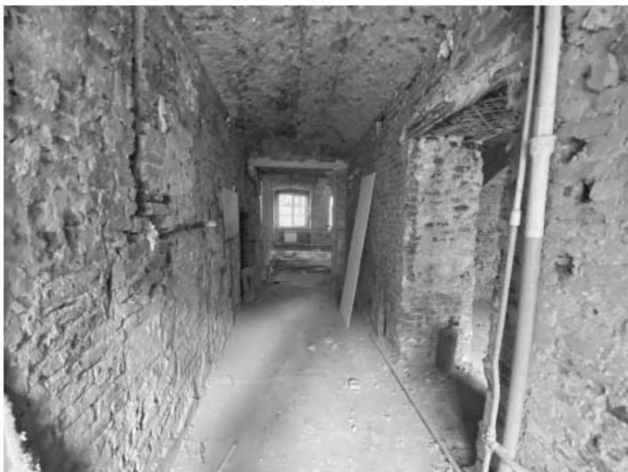
Фото 57. Помещение 1-Н(38,40). Общий вид.
