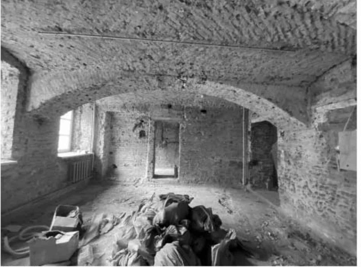
Фото 60. Помещение 1-Н(36,34). Общий вид.
