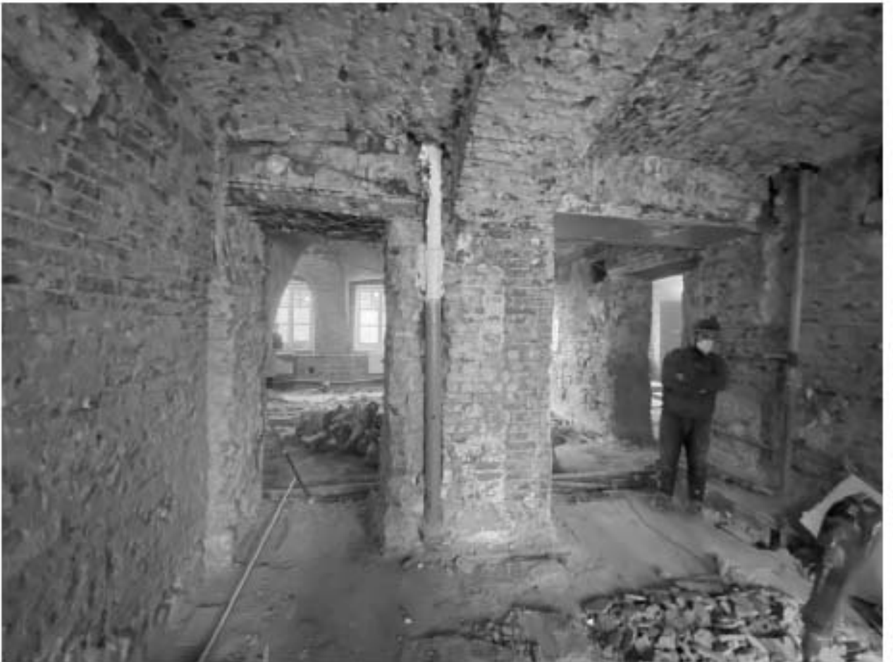
Фото 69. Помещение 1-Н(29). Общий вид.
