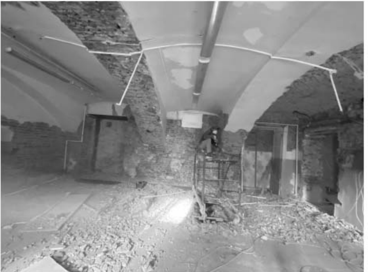
Фото 52. Помещение 1-Н(20). Общий вид.
