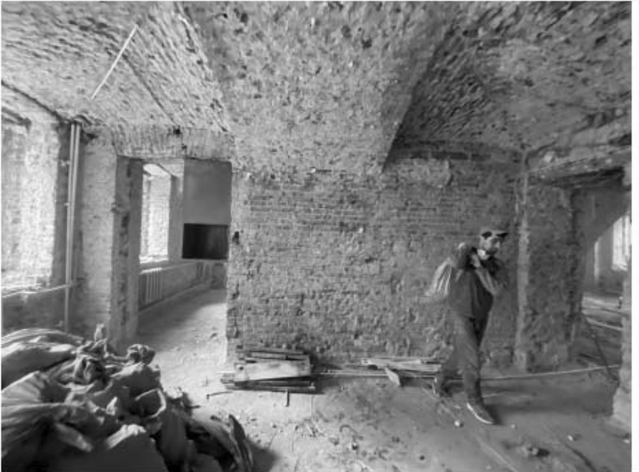
Фото 68. Помещение 1-Н(29). Общий вид.
