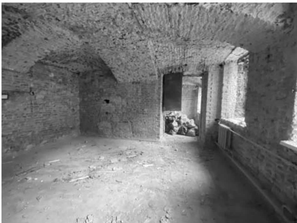
Фото 62. Помещение 1-Н(32). Общий вид.
