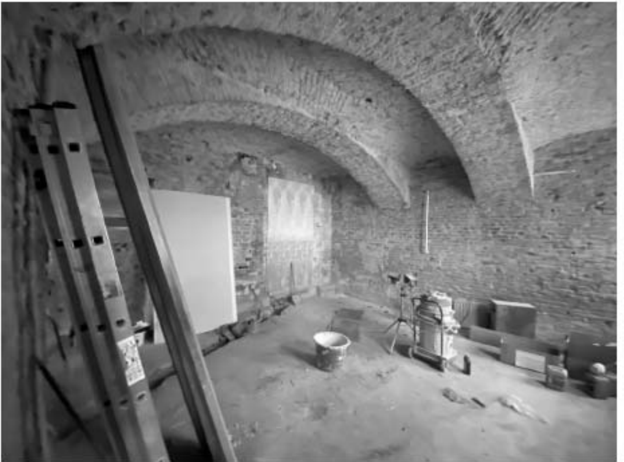
Фото 29. Помещение 1-Н(2). Общий вид.
