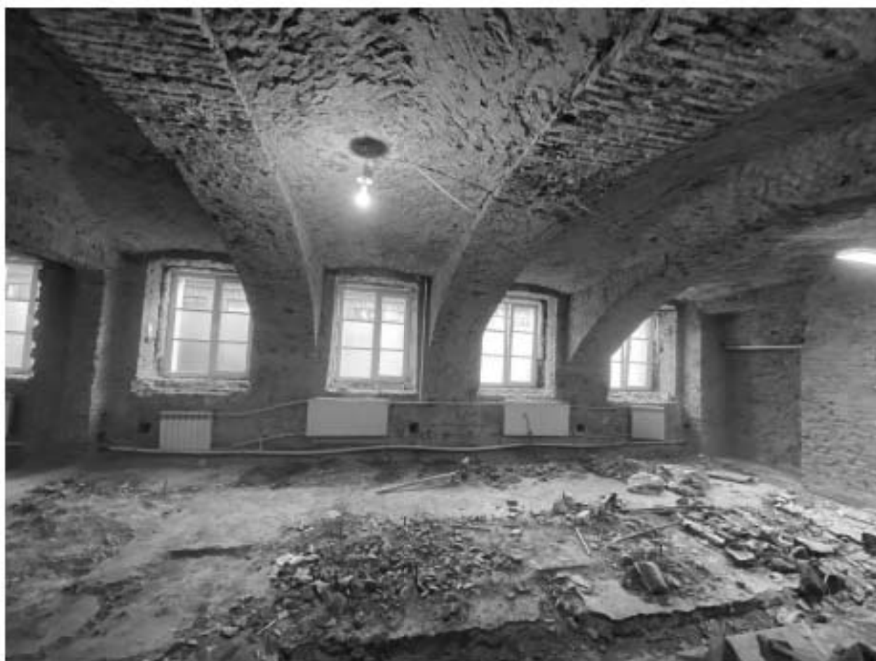
Фото 42. Помещение 1-Н(14,17). Общий вид.
