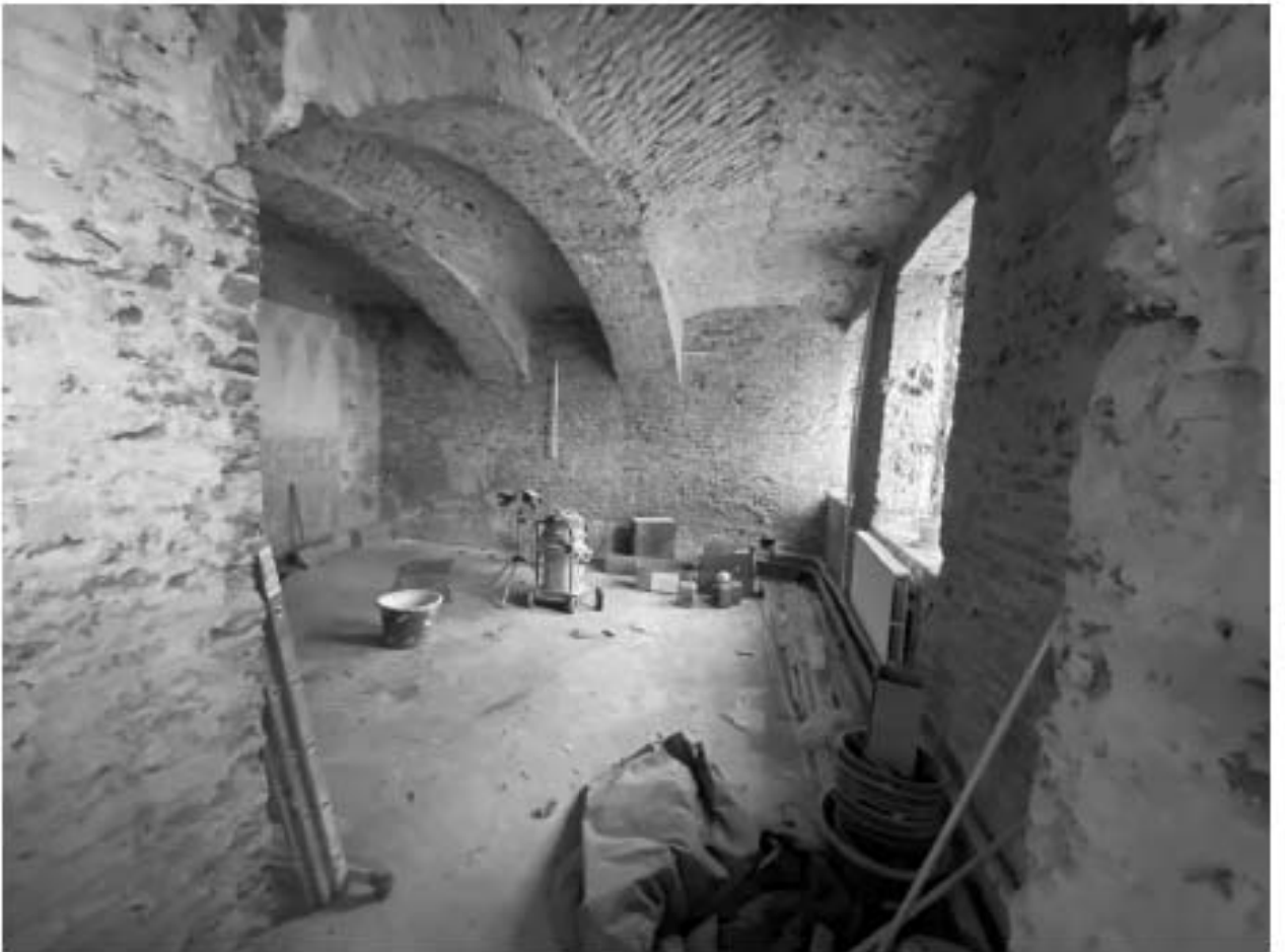
Фото 28. Помещение 1-Н(2). Общий вид.
