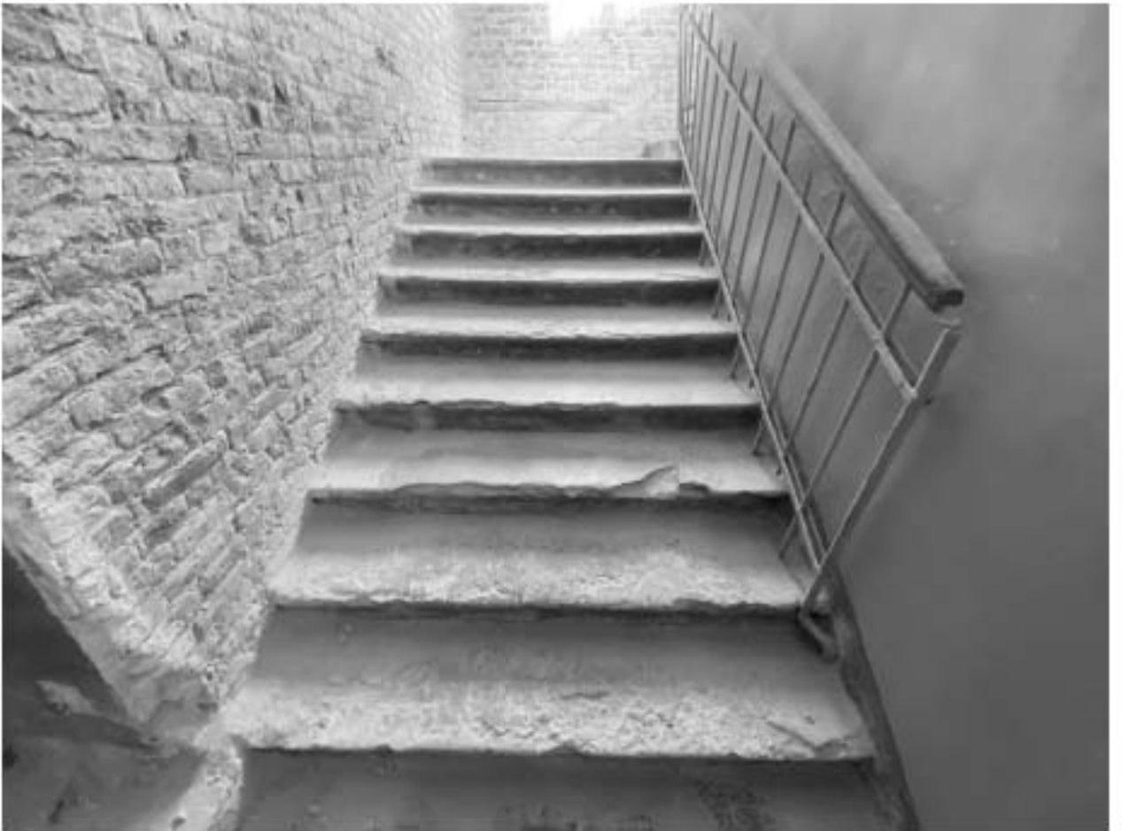
Фото 15. Вид на лестницу 2ЛК(1).
