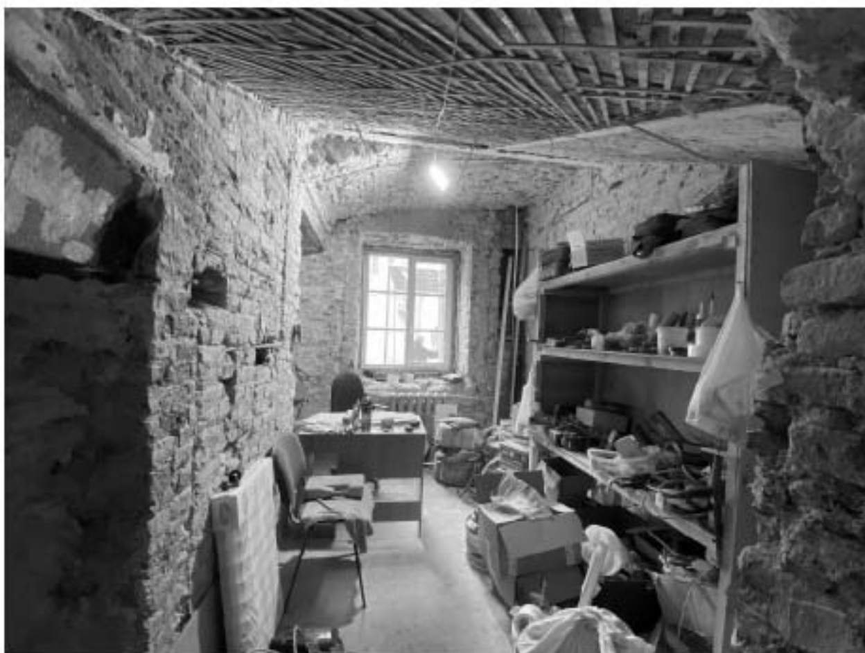
Фото 53. Помещение 1-Н(42,44). Общий вид.
