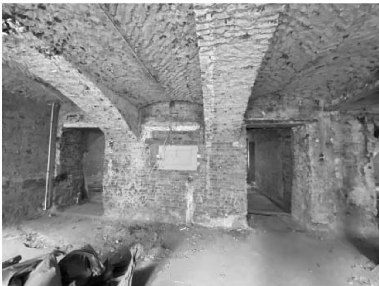
Фото 61. Помещение 1-Н(36,34). Общий вид.
