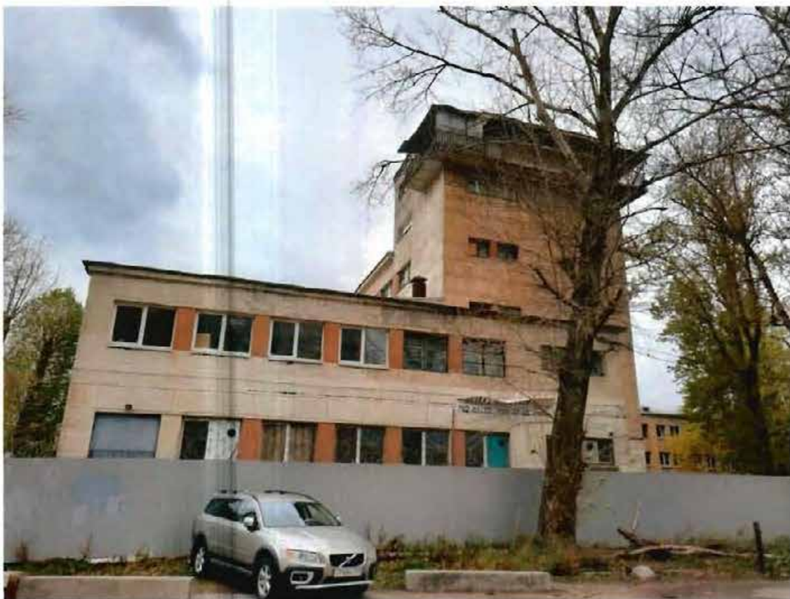
5. Вид на восточный фасад объекта культурного наследия
