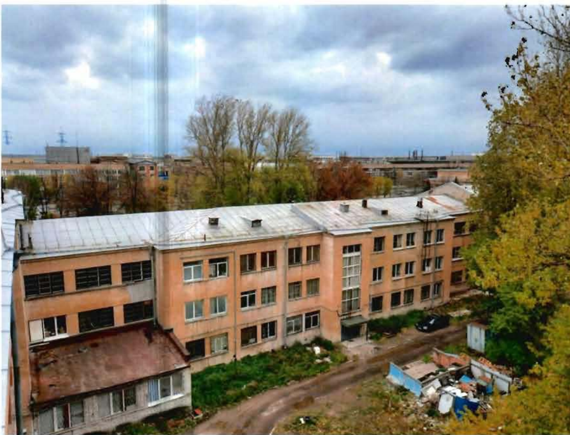
7. Вид на дворовой западный фасад объекта культурного наследия
