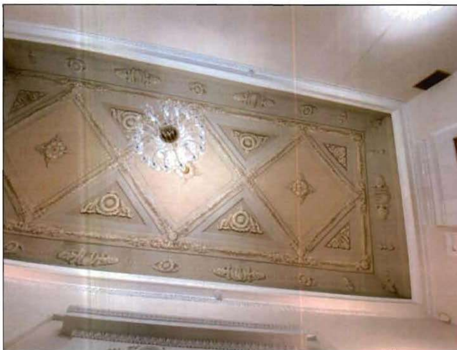
43. Декоративно художественная отделка помещений в уровне 3-го этажа (пом. 27-Н (12)). Живописный плафон. Фото от 19.11.2021 г.
