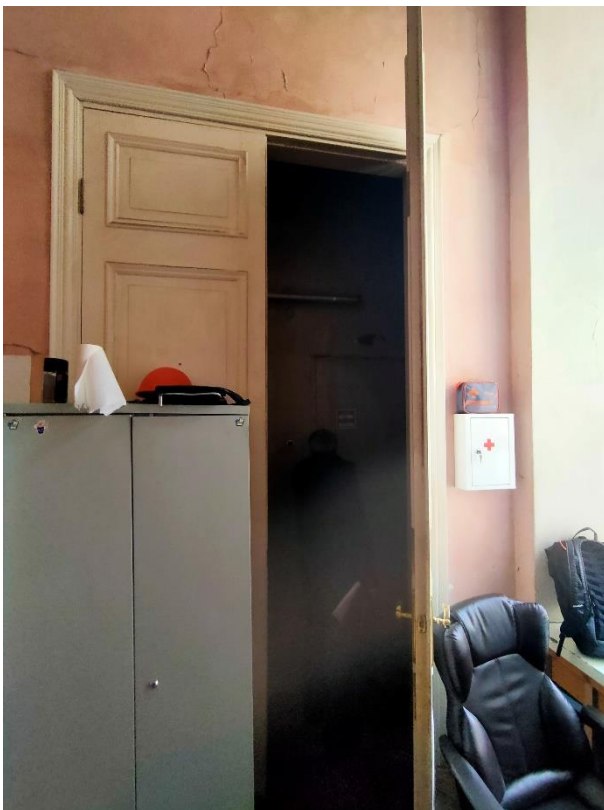
47. «Ансамбль улицы Зодчего Росси», ул. Зодчего Росси, д. 1-3, лит. А. 3 этаж. Помещение №12 (30-Н (12) по ПИБ). Фрагмент. Фото 12.10.2023г.
