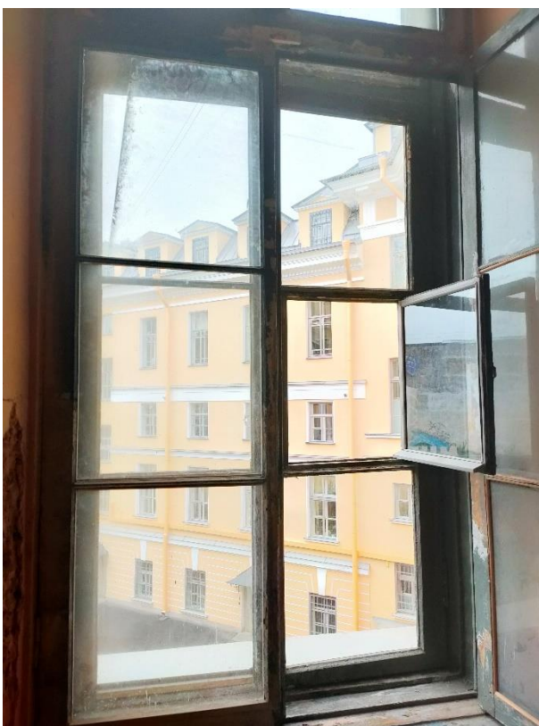
50. «Ансамбль улицы Зодчего Росси», ул. Зодчего Росси, д. 1-3, лит. А. 3 этаж. Помещение №14 (30-Н (14) по ПИБ). Фрагмент. Фото 12.10.2023г.
