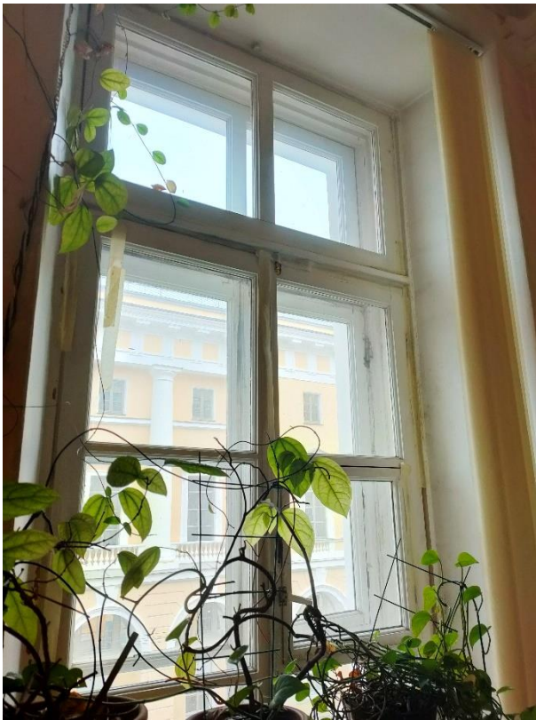
66. «Ансамбль улицы Зодчего Росси», ул. Зодчего Росси, д. 1-3, лит. А. 3 этаж. Помещение №19 (30-Н (19) по ПИБ). Фрагмент. Фото 12.10.2023г.
