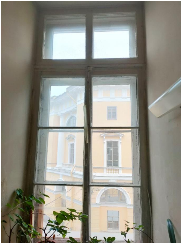
65. «Ансамбль улицы Зодчего Росси», ул. Зодчего Росси, д. 1-3, лит. А. 3 этаж. Помещение №19 (30-Н (19) по ПИБ). Фрагмент. Фото 12.10.2023г.
