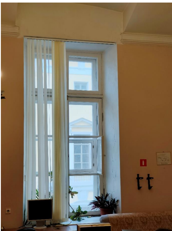
56. «Ансамбль улицы Зодчего Росси», ул. Зодчего Росси, д. 1-3, лит. А. 3 этаж. Помещение №17 (30-Н (17) по ПИБ). Фрагмент. Фото 12.10.2023г.
