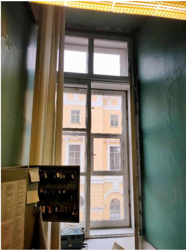
53. «Ансамбль улицы Зодчего Росси», ул. Зодчего Росси, д. 1-3, лит. А. 3 этаж. Помещение №16 (30-Н (16) по ПИБ). Фрагмент. Фото 12.10.2023г.
