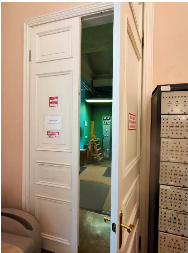
54. «Ансамбль улицы Зодчего Росси», ул. Зодчего Росси, д. 1-3, лит. А. 3 этаж. Помещение №17 (30-Н (17) по ПИБ). Фрагмент. Фото 12.10.2023г.
