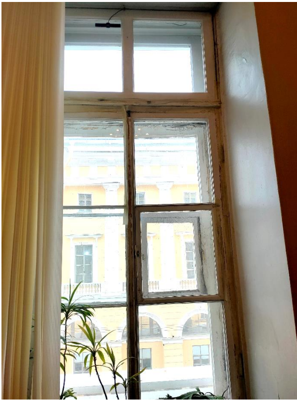
59. «Ансамбль улицы Зодчего Росси», ул. Зодчего Росси, д. 1-3, лит. А. 3 этаж. Помещение №18 (30-Н (18) по ПИБ). Фрагмент. Фото 12.10.2023г.
