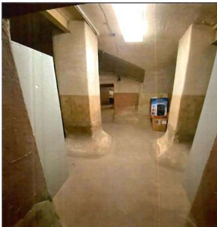
52. Пилоны подвальных помещений. Фото от 19.11.2021 г.
