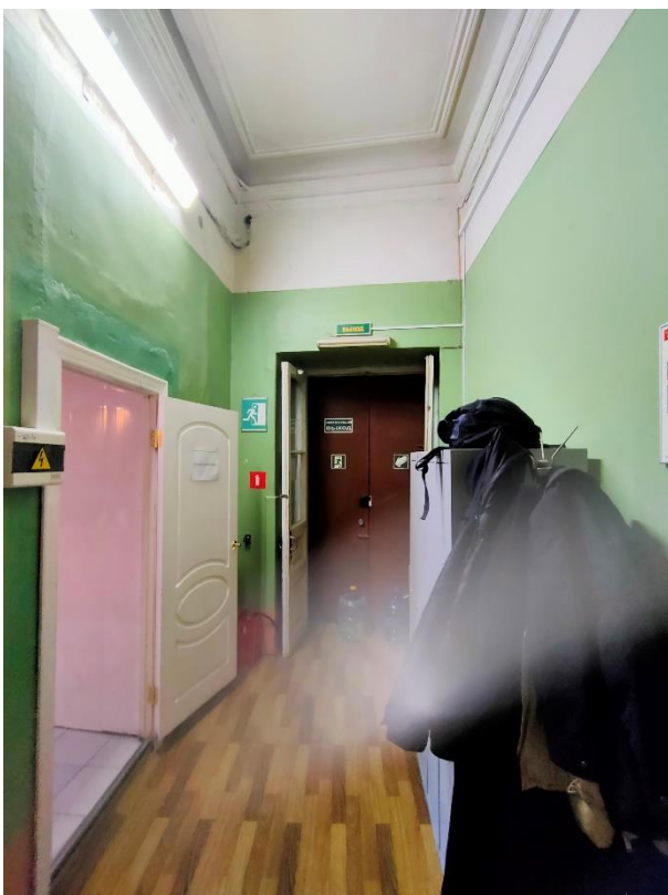
5. «Ансамбль улицы Зодчего Росси», ул. Зодчего Росси, д. 1-3, лит. А. 3 этаж. Помещение №2 (30-Н (2) по ПИБ). Общий вид. Фото 12.10.2023г.
