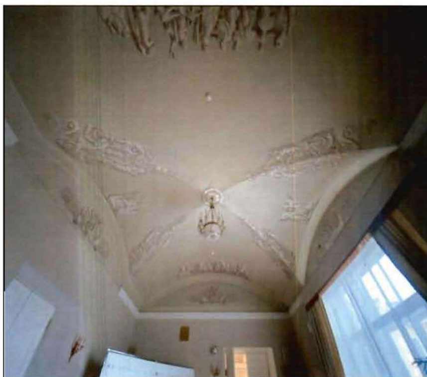
36. Декоративно художественная отделка помещений (пом. 30-Н (33)) в уровне 3-го этажа Живописный плафон. Фото от 16.11.2021 г.
