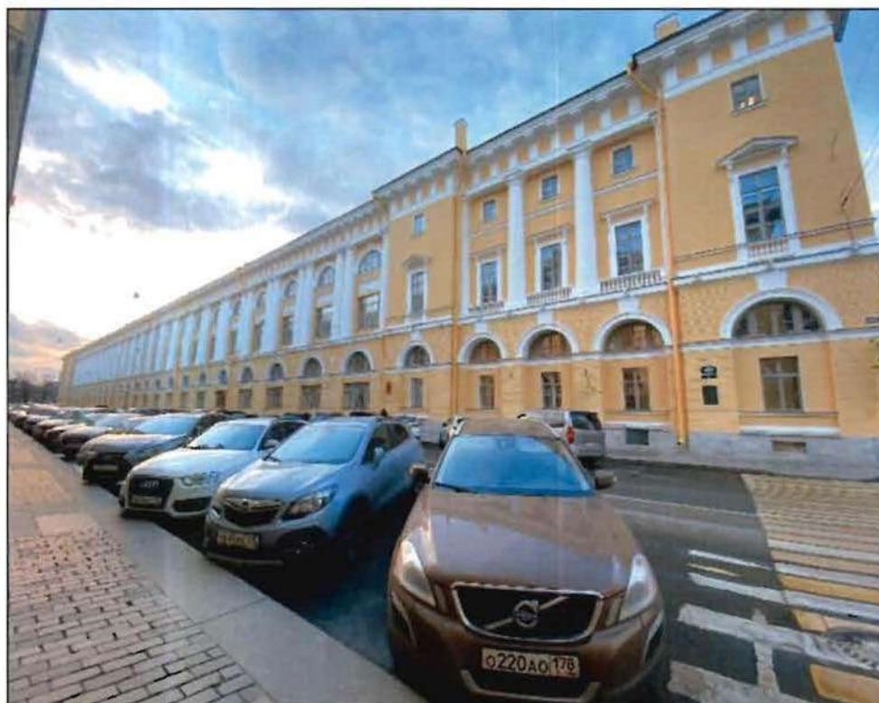
11. Лицевой фасад (ул. Зодчего Росси). Фото от 19.11.2021 г.
