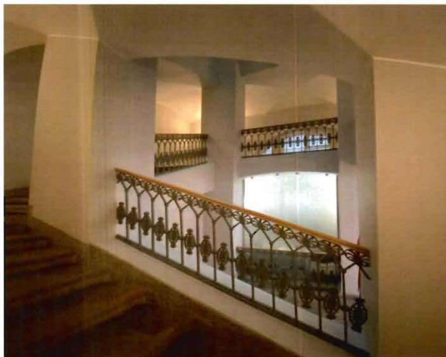
28. Парадная лестница (ЗЛК) со стороны пл. Ломоносова, многомаршевая, на пилонах по ползучим с распалубками и крестовым сводам на подпружных арках. Фото от 16.11.2021 г.
