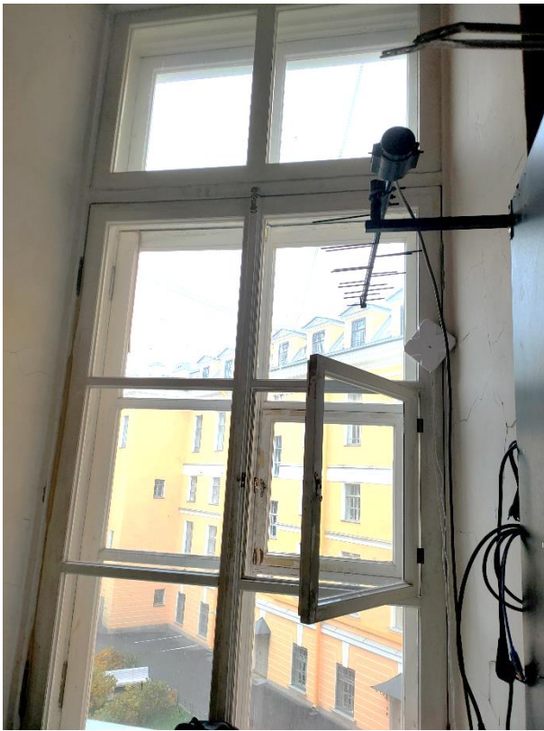
45. «Ансамбль улицы Зодчего Росси», ул. Зодчего Росси, д. 1-3, лит. А. 3 этаж. Помещение №12 (30-Н (12) по ПИБ). Фрагмент. Фото 12.10.2023г.
