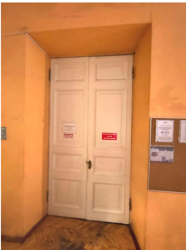
41. «Ансамбль улицы Зодчего Росси», ул. Зодчего Росси, д. 1-3, лит. А. 3 этаж. Помещение №11 (30-Н (11) по ПИБ). Фрагмент. Фото 12.10.2023г.
