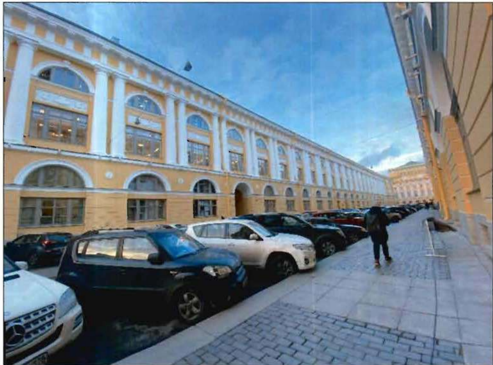
10. Лицевой фасад (ул. Зодчего Росси). Фото от 19.11.2021 г.
