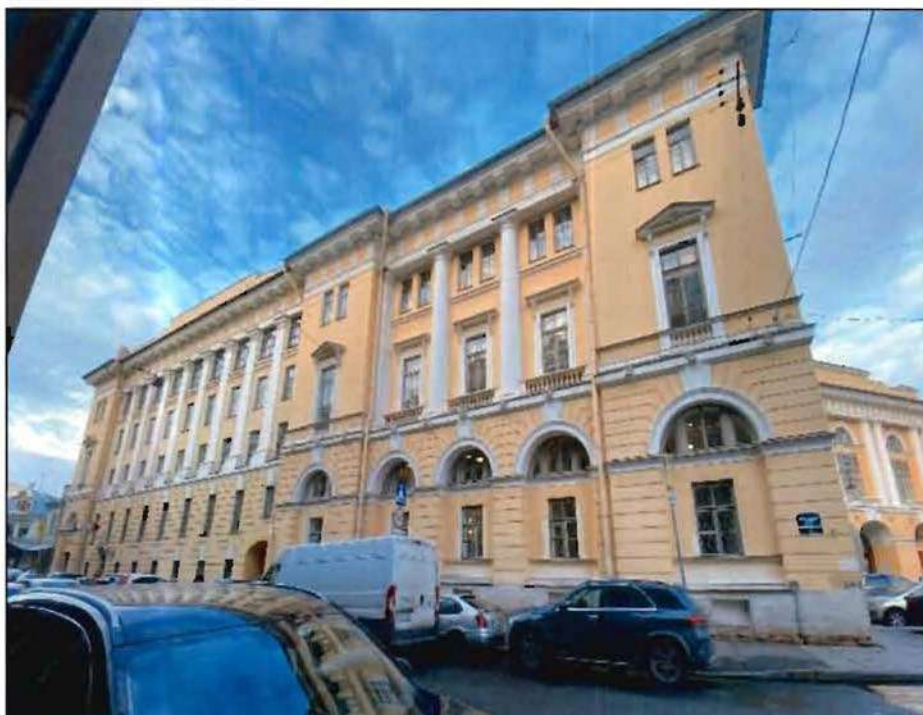
4. Общий вид на южный фасад со стороны Торгового переуллка. Фото от 19.11.2021 г.
