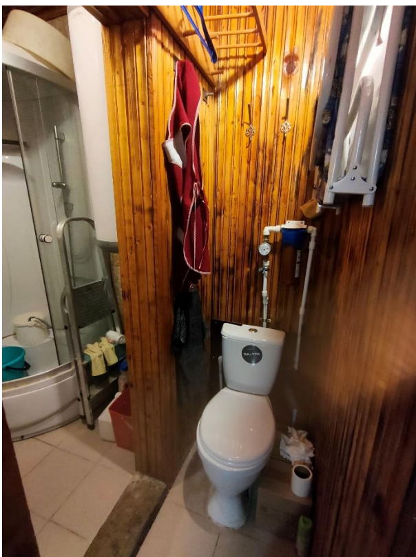
17. «Ансамбль улицы Зодчего Росси», ул. Зодчего Росси, д. 1-3, лит. А. 3 этаж. Помещение №6 (30-Н (6) по ПИБ). Общий вид. Фото 12.10.2023г.
