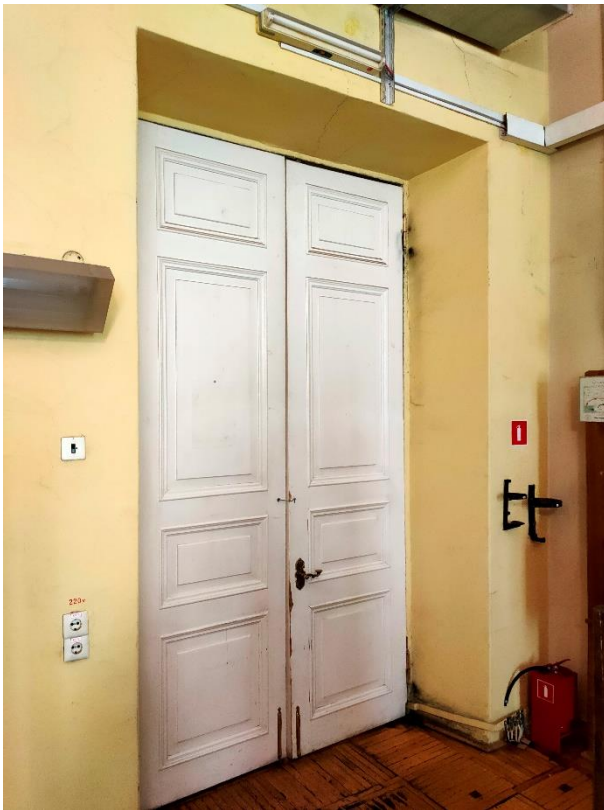
63. «Ансамбль улицы Зодчего Росси», ул. Зодчего Росси, д. 1-3, лит. А. 3 этаж. Помещение №19 (30-Н (19) по ПИБ). Фрагмент. Фото 12.10.2023г.
