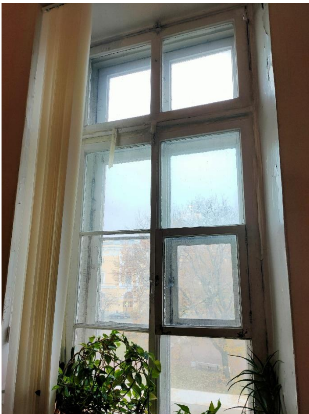
64. «Ансамбль улицы Зодчего Росси», ул. Зодчего Росси, д. 1-3, лит. А. 3 этаж. Помещение №19 (30-Н (19) по ПИБ). Фрагмент. Фото 12.10.2023г.
