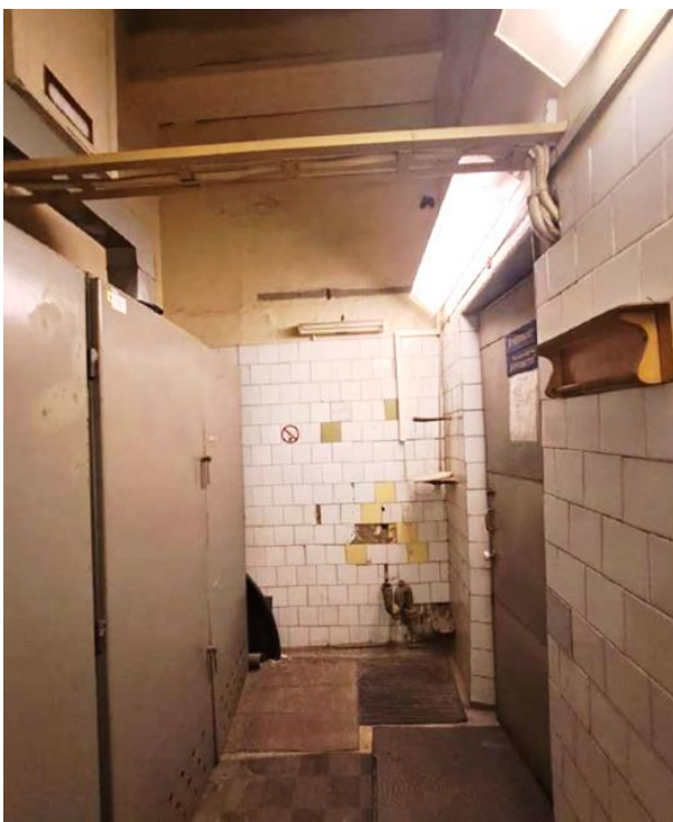
51. «Ансамбль улицы Зодчего Росси», ул. Зодчего Росси, д. 1-3, лит. А. 3 этаж. Помещение №13 (30-Н (13) по ПИБ). Общий вид. Фото 12.10.2023г.
