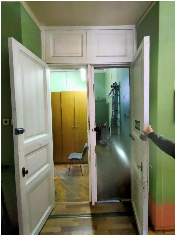
7. «Ансамбль улицы Зодчего Росси», ул. Зодчего Росси, д. 1-3, лит. А. 3 этаж. Помещение №2 (30-Н (2) по ПИБ). Фрагмент. Фото 12.10.2023г.
