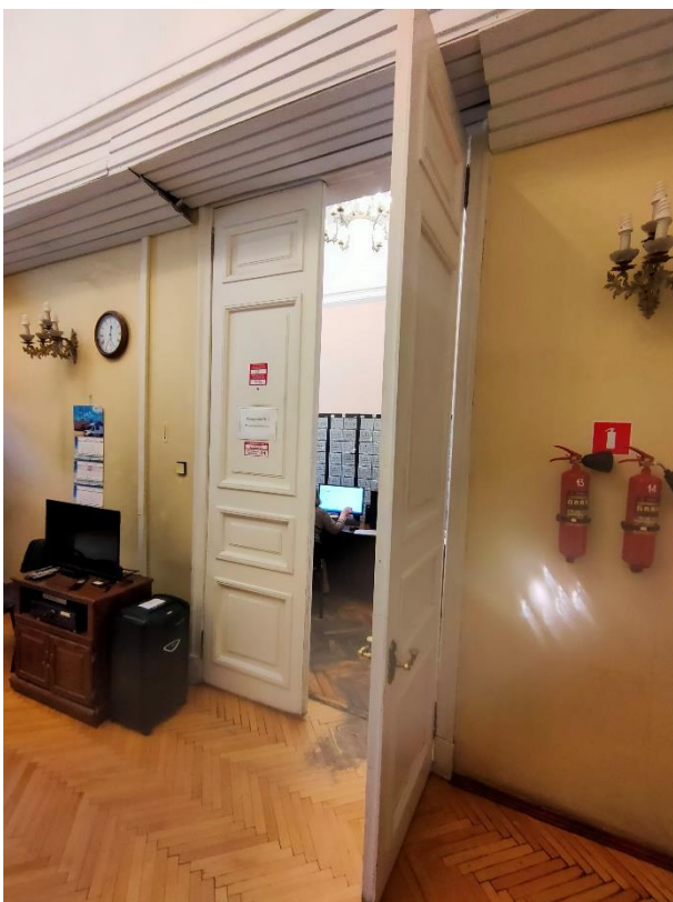
57. «Ансамбль улицы Зодчего Росси», ул. Зодчего Росси, д. 1-3, лит. А. 3 этаж. Помещение №18 (30-Н (18) по ПИБ). Фрагмент. Фото 12.10.2023г.
