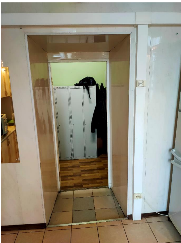
15. «Ансамбль улицы Зодчего Росси», ул. Зодчего Росси, д. 1-3, лит. А. 3 этаж. Помещение №4 (30-Н (4) по ПИБ). Фрагмент. Фото 12.10.2023г.
