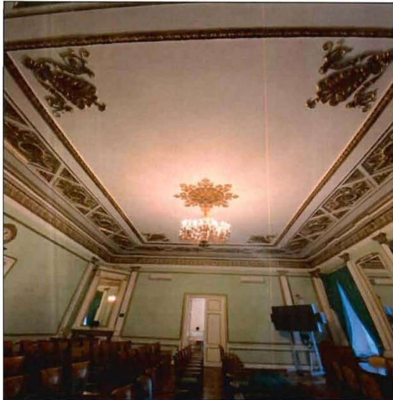
47. Декоративно художественная отделка помещений в уровне 3-го этажа (пом 27-Н (6)). Живописный плафон. Фото от 16.11.2021 г.
