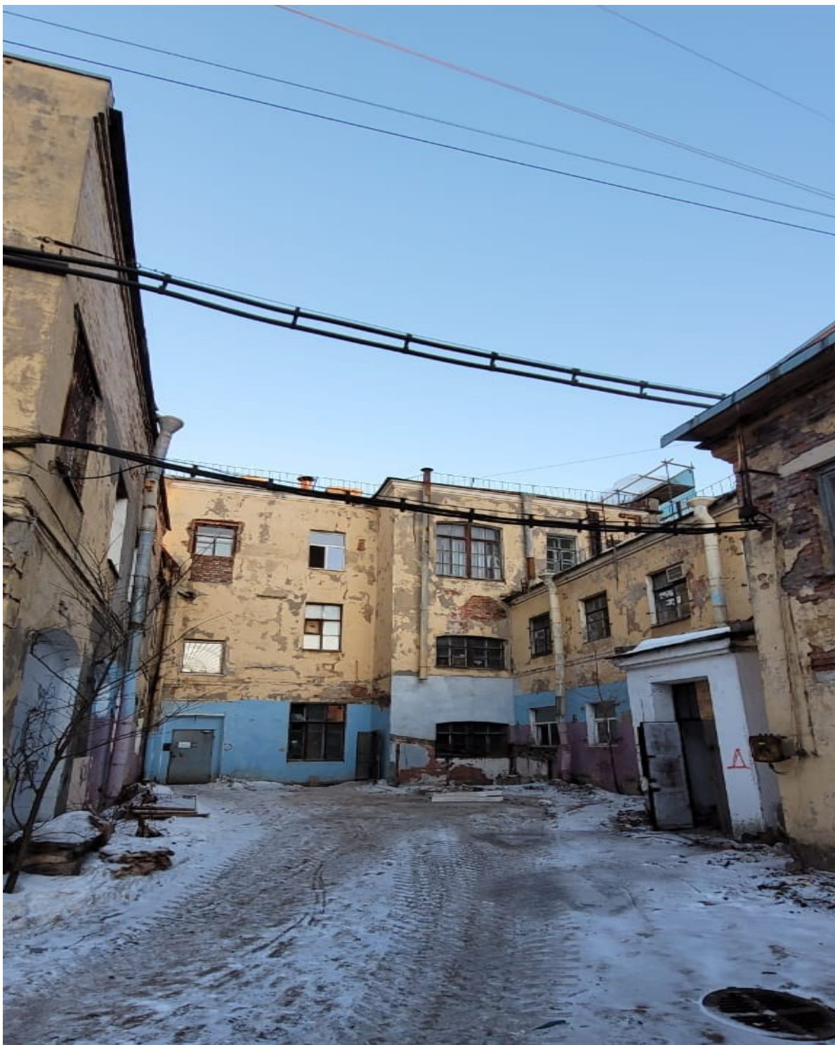
Фото 7. Общий вид со стороны двора на реконструируемое здание 1 (Биржевая линия, д. 8-10, лит. А)
