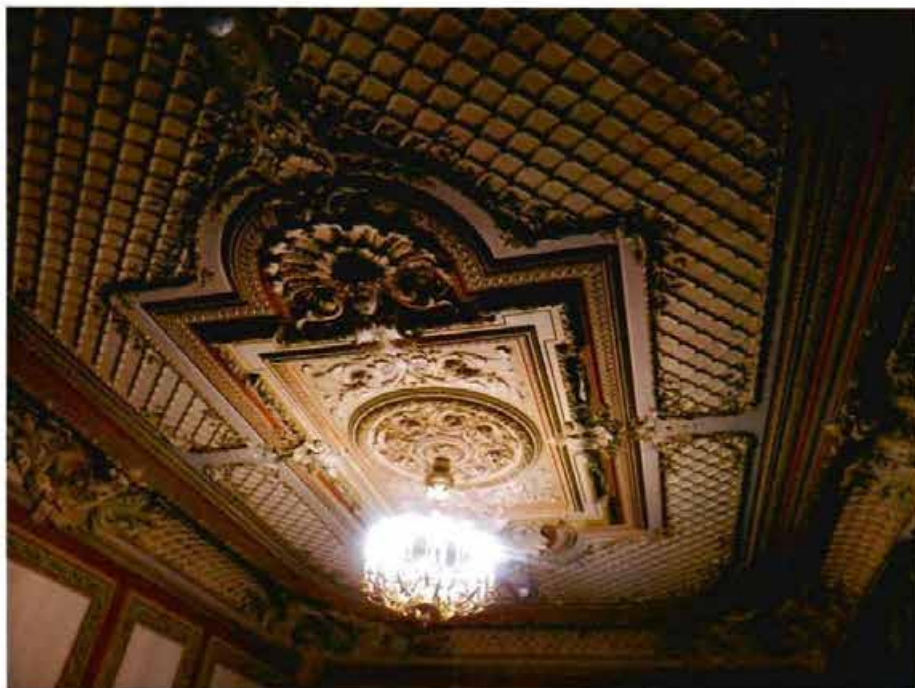
11. Интерьеры 2-го этажа (лепной плафон Гостиной)
