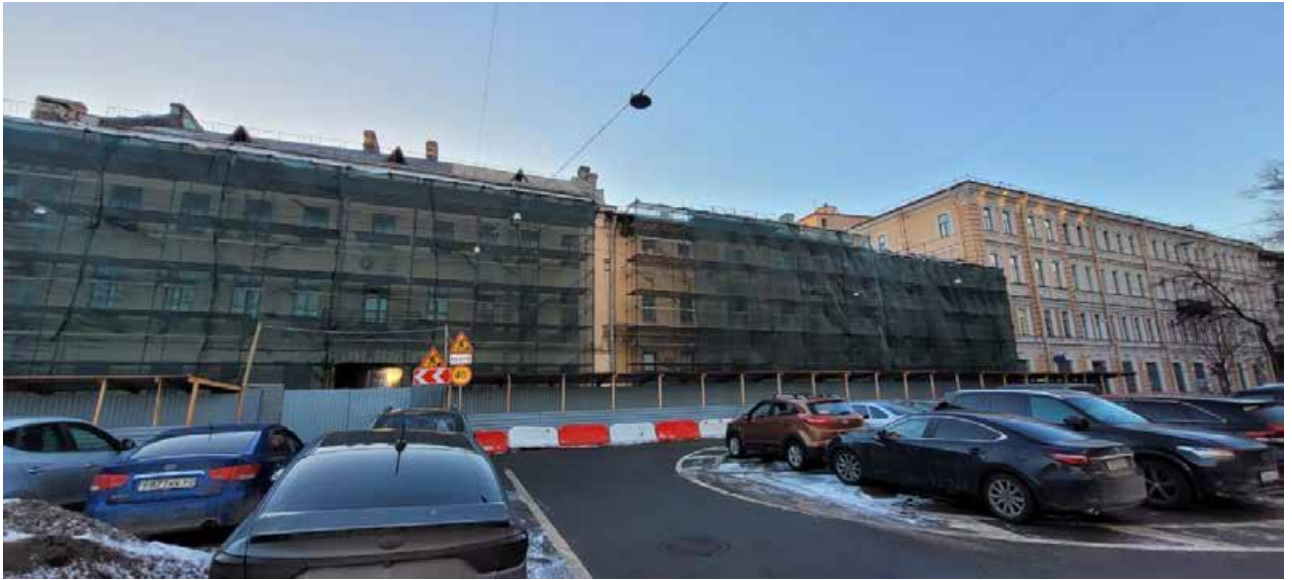
Фото 5. Общий вид со стороны площади Академика Сахарова на лицевые фасады: слева и по центру - реконструируемое здание 1 (Биржевая линия, д. 8-10, лит. А); справа - здания 6 и 7 - объект культурного наследия регионального значения «Дом Елисеевых с флигелями» (Биржевая линия, д. 12-14, лит. А)
