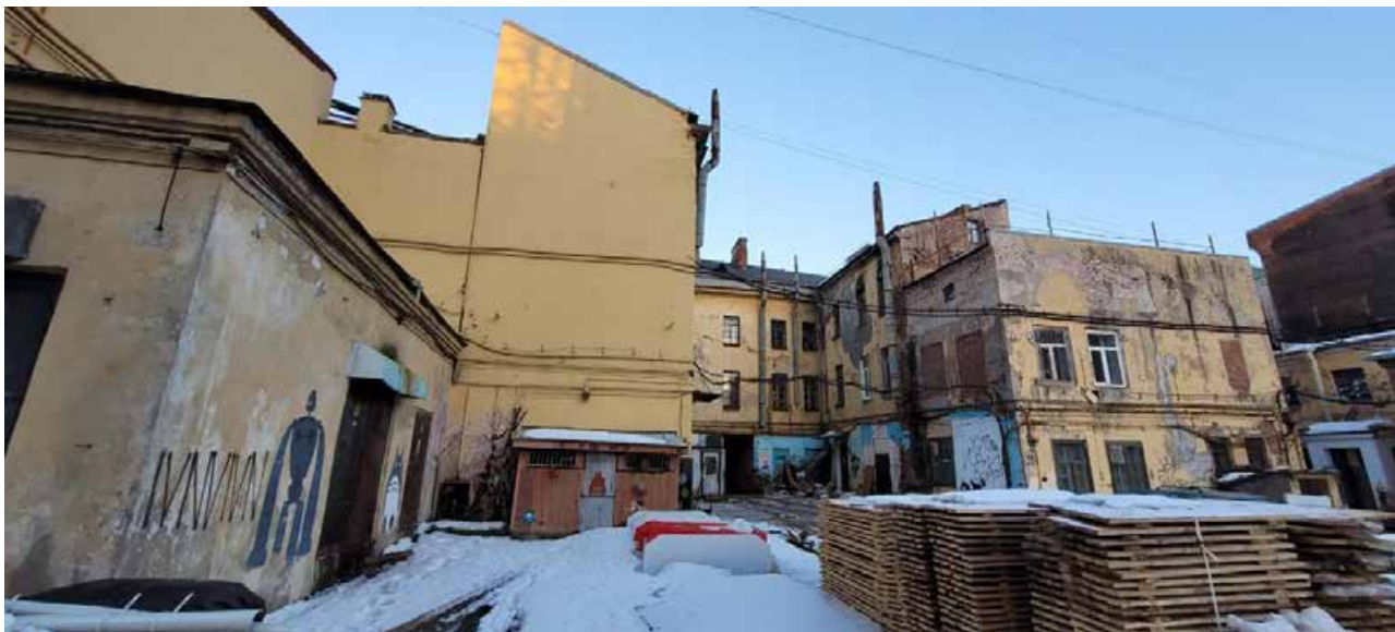
Фото 12. Вид со стороны двора: слева - на здание 6 - объект культурного наследия регионального значения «Дом Елисеевых с флигелями» (Биржевая линия, д. 12, лит. А); справа - на реконструируемое здание 1 (Биржевая линия, д. 8-10, лит. А)
