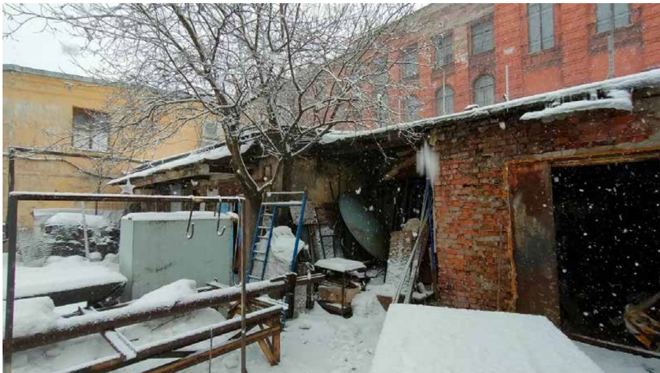
Фото 14. Вид со стороны двора: слева - реконструируемое здание 2 (Биржевая линия, д. 12, лит. Е); по центру на переднем плане - реконструируемое здание 3 (Биржевая линия, д. 12, лит. О); на заднем плане – здание 4 - объект культурного наследия регионального значения «Здание Химической лаборатории» (Университетская наб., д. 7-9-11, лит. Ц)
