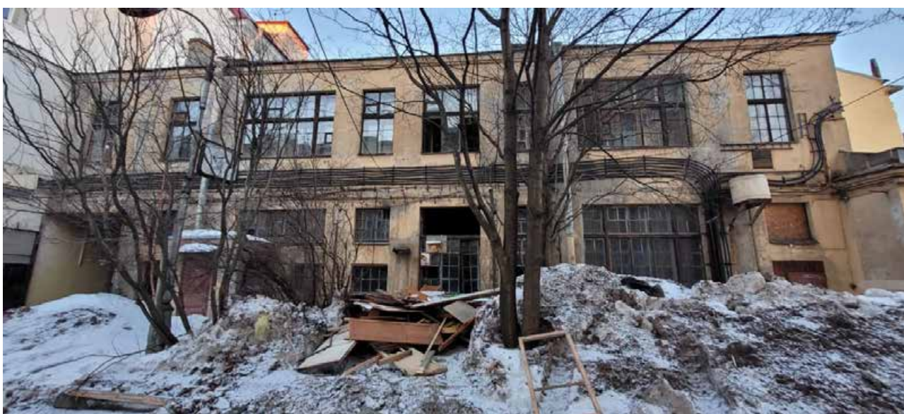
Фото 11. Вид со стороны двора: слева – здание 7 - объект культурного наследия регионального значения «Дом Елисеевых с флигелями» (Биржевая линия, д. 14, лит. А); по центру - здание 6 - объект культурного наследия регионального значения «Дом Елисеевых с флигелями» (Биржевая линия, д. 12, лит. А)
