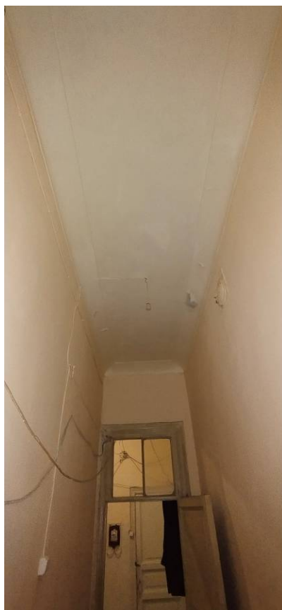
Фото 11. Интерьер квартиры № 28 выявленного объекта культурного наследия «Дом А.В. Дехтеринского»
