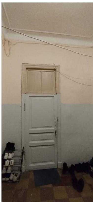
Фото 8. Интерьер квартиры № 28 выявленного объекта культурного наследия «Дом А.В. Дехтеринского»
