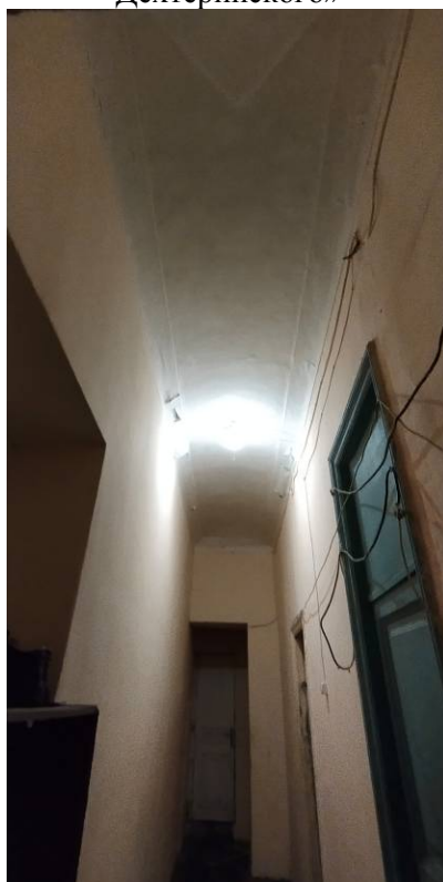
Фото 10. Интерьер квартиры № 28 выявленного объекта культурного наследия «Дом А.В. Дехтеринского»
