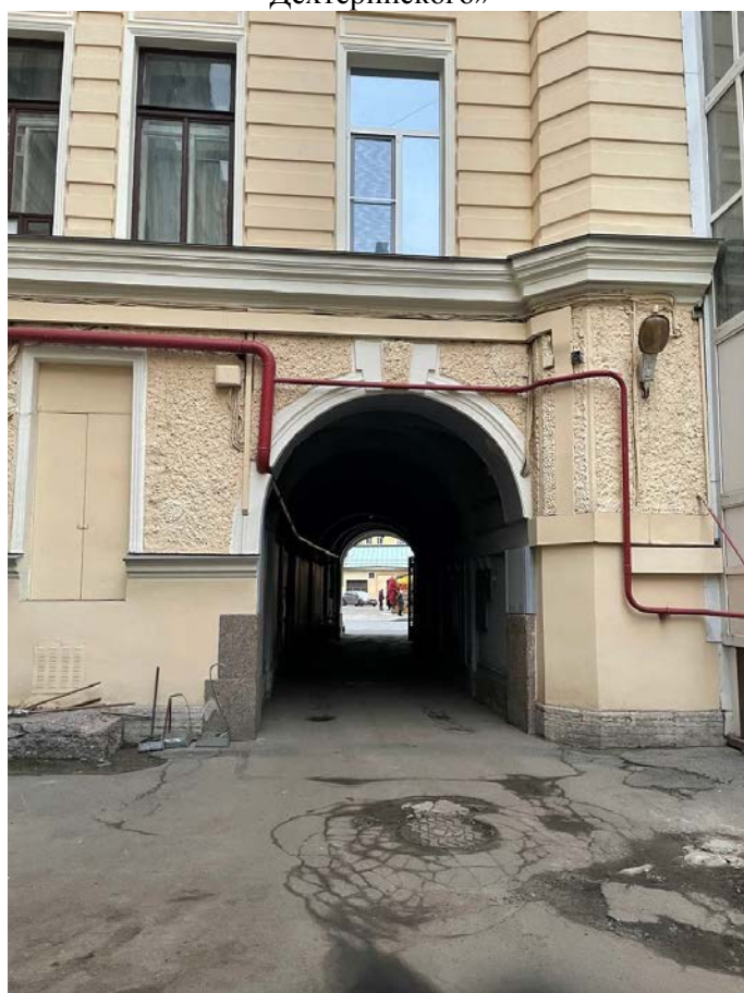
Фото 6. Фрагмент дворового фасада выявленного объекта культурного наследия «Дом А.В. Дехтеринского», воротный проезд
