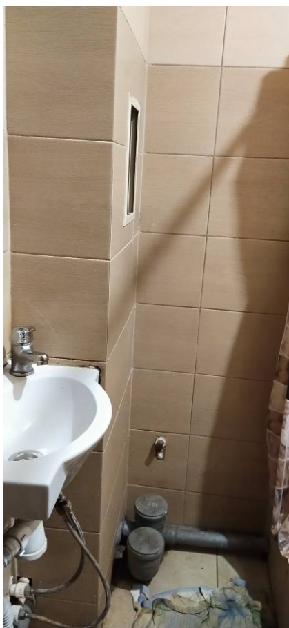
Фото 13. Интерьер квартиры № 28 выявленного объекта культурного наследия «Дом А.В. Дехтеринского»
