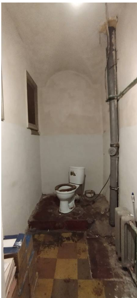
Фото 9. Интерьер квартиры № 28 выявленного объекта культурного наследия «Дом А.В. Дехтеринского»
