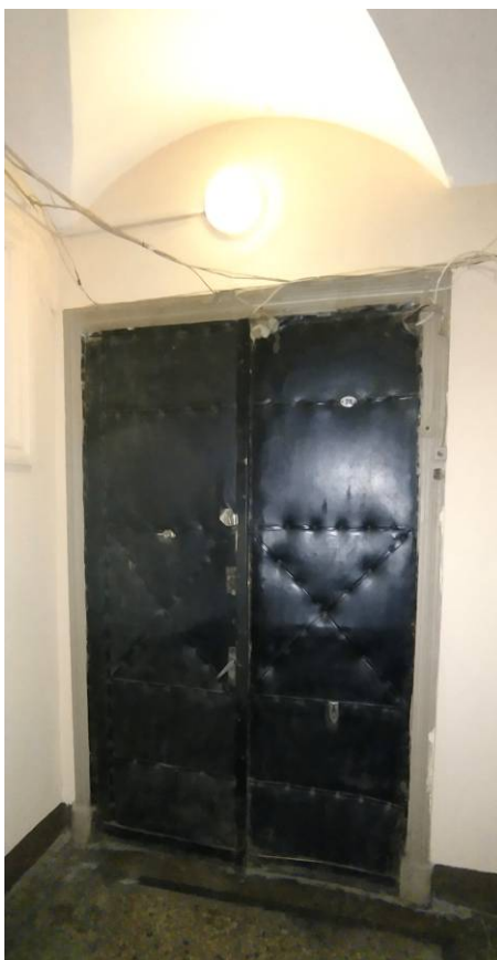
Фото 7. Интерьер квартиры № 28 выявленного объекта культурного наследия «Дом А.В. Дехтеринского»
