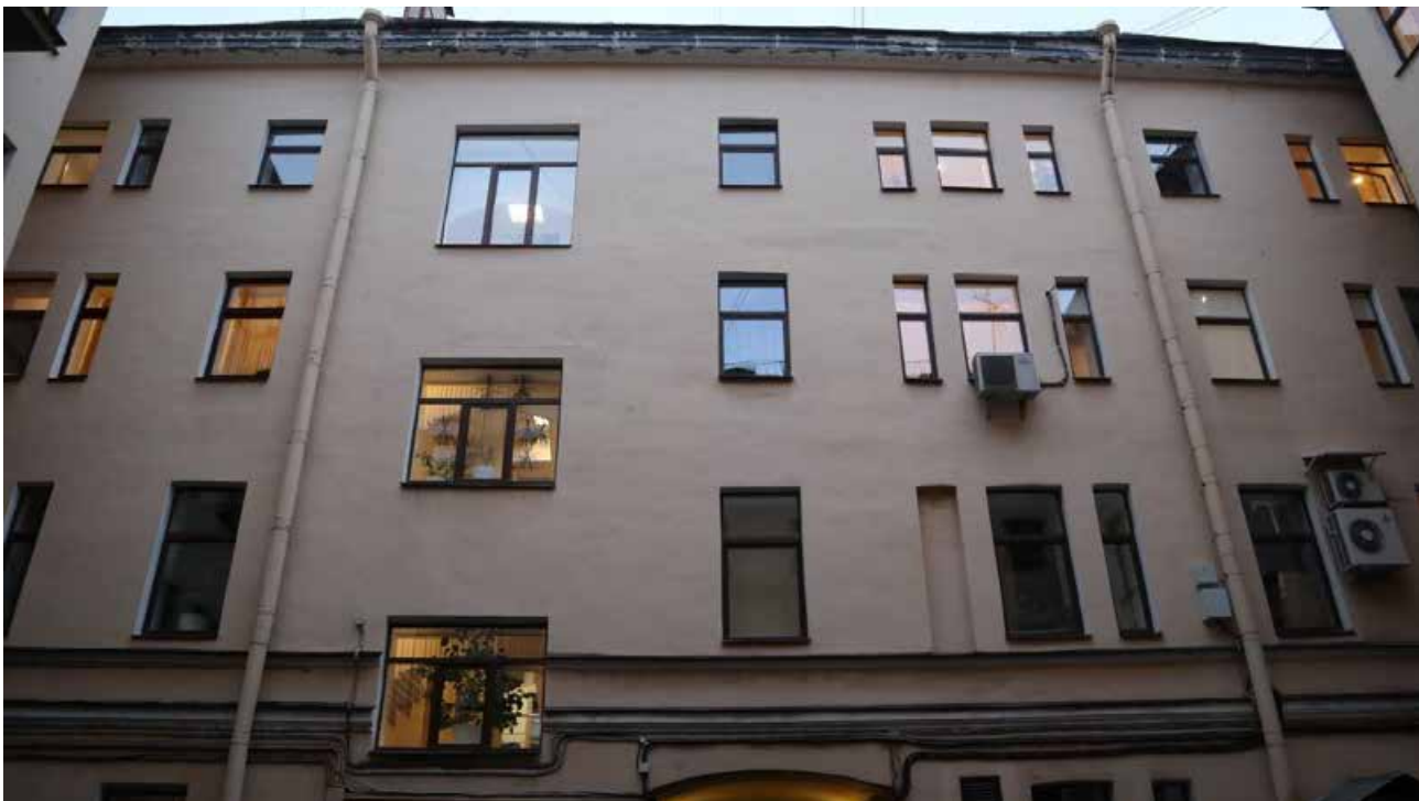
Фото 17. Дворовый фасад здания, фрагмент, вид на юго-запад.
