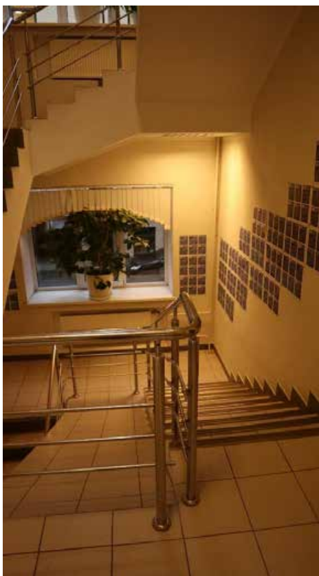
Фото 2.3. 2 этаж, лестница, помещение 1Н (63).
