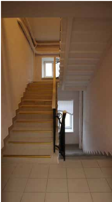
Фото 5.23. 5 этаж, лестница, помещение 1Н (226).
