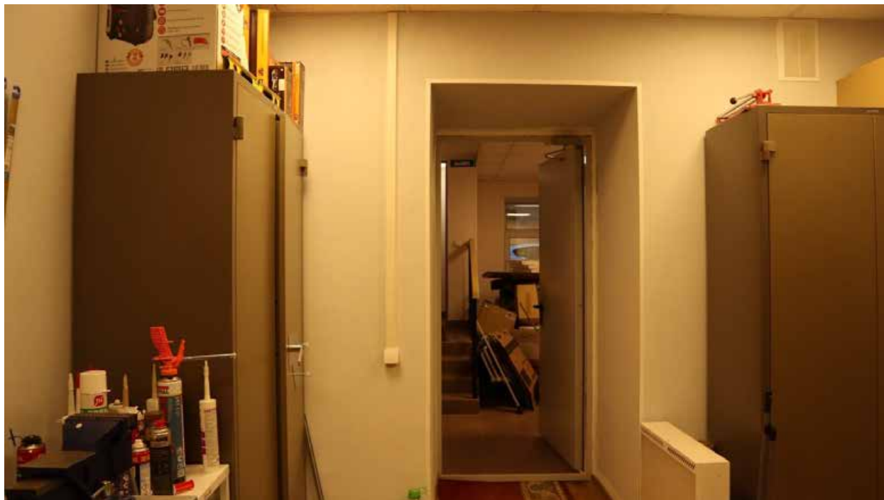
Фото 1.27. 1 этаж, помещение 1Н (30).
