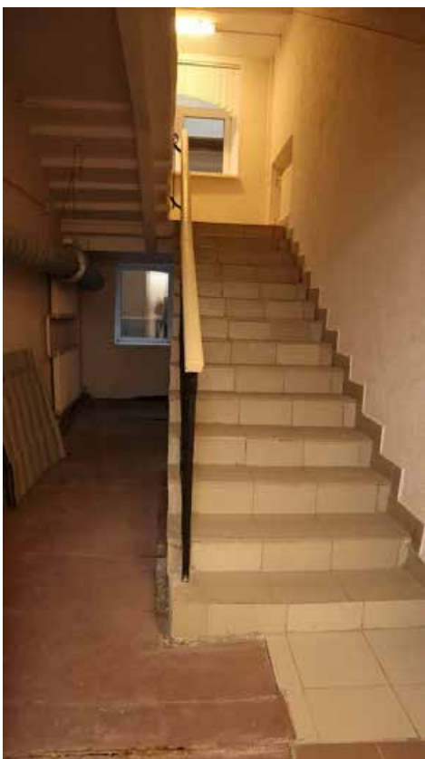
Фото 1.31. 1 этаж, помещение 1Н (33).
