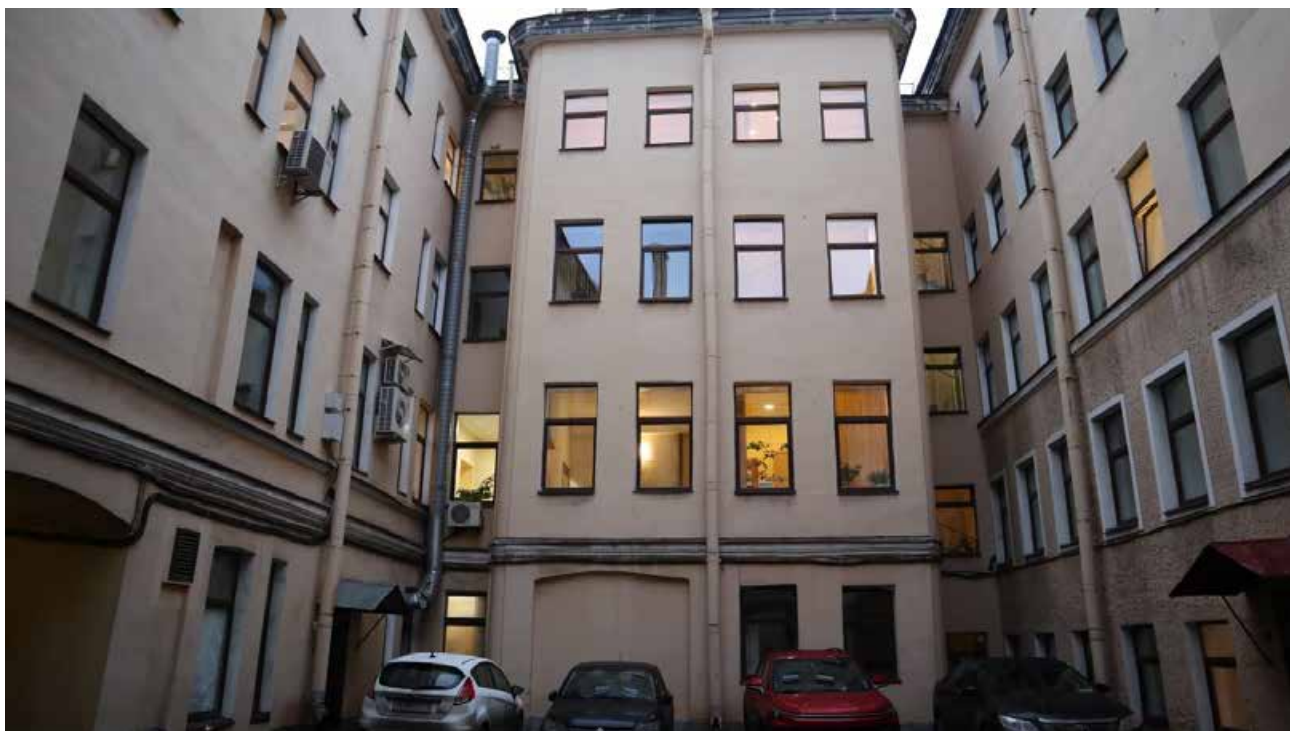
Фото 14. Дворовый фасад здания, фрагмент, вид на северо-запад.
