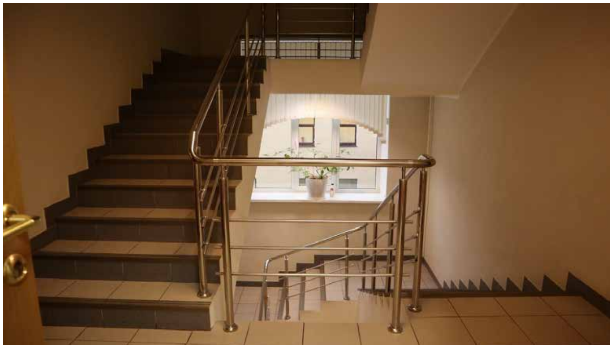
Фото 4.49. 4 этаж, лестница, помещение 1Н (177).
