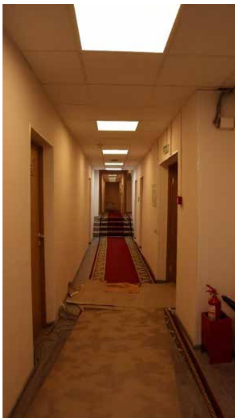
Фото 2.58. 2 этаж, помещение 1Н (98).
