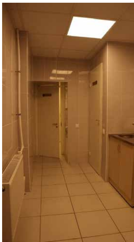
Фото 5.2. 5 этаж, помещение 1Н (236).
