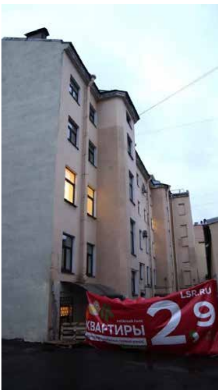
Фото 11. Восточный (дворовый) фасад здания, фрагмент.
