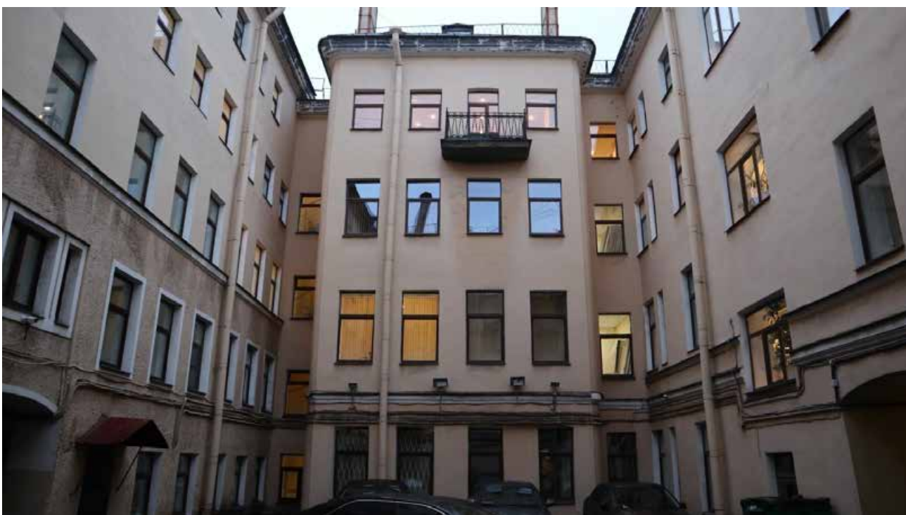
Фото 16. Дворовый фасад здания, фрагмент, вид на юго-восток.
