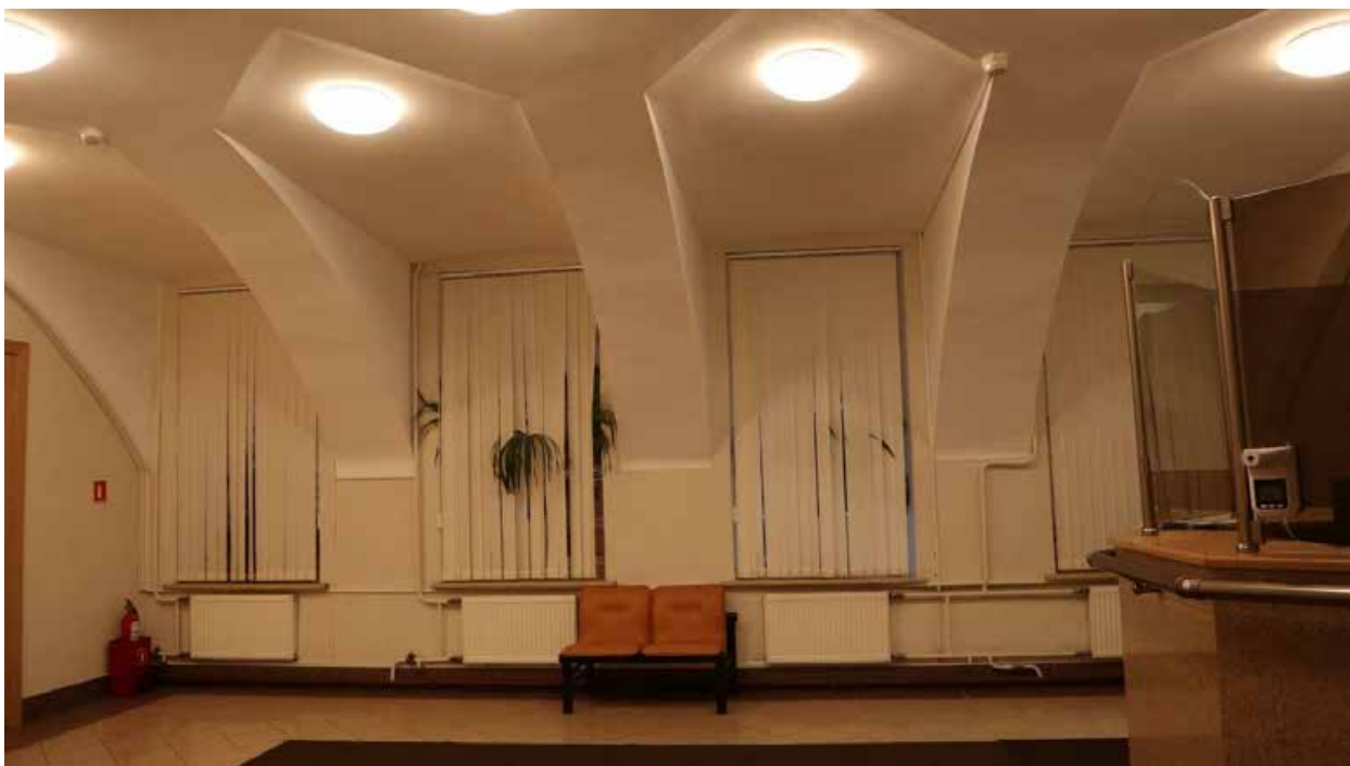
Фото 1.7. 1 этаж, помещение 1Н (6).
