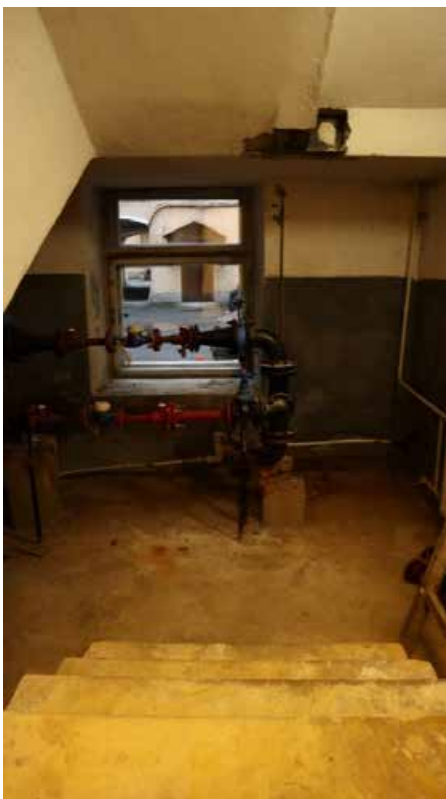
Фото 1.4. 1 этаж, помещение 1Н (9).
