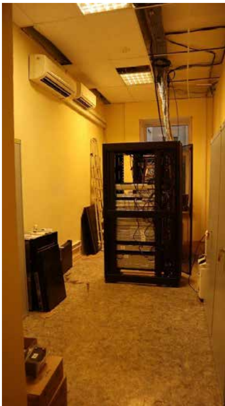
Фото 2.25. 2 этаж, помещение 1Н (73).
