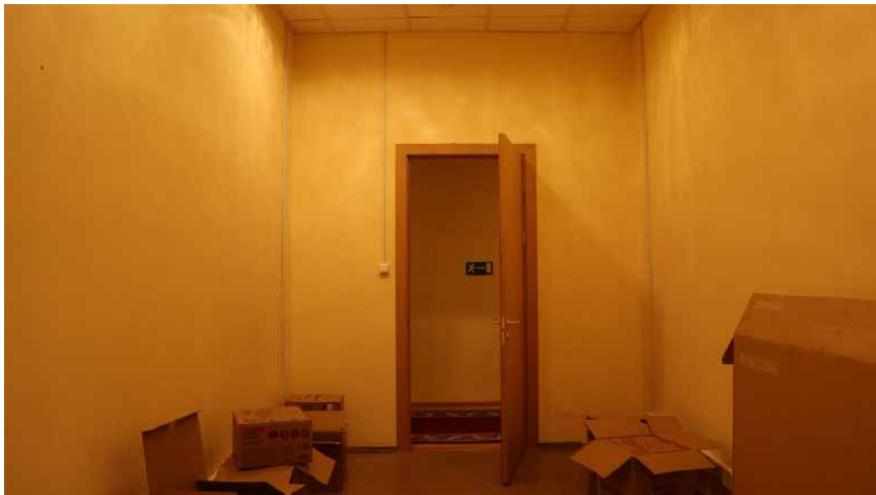
Фото 2.20. 2 этаж, помещение 1Н (67).
