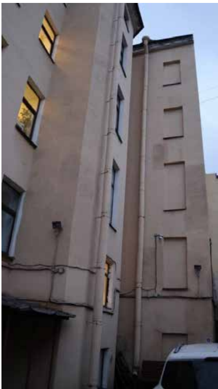
Фото 9. Восточный (дворовый) фасад здания, фрагмент.
