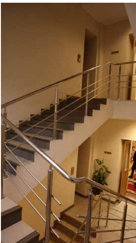
Фото 3.1. 3 этаж, лестница, помещение 1Н (122).
