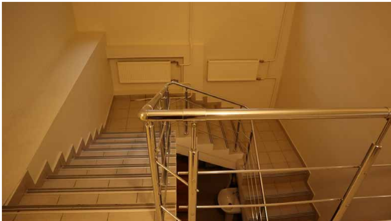
Фото 2.33. 2 этаж, лестница, помещение 1Н (78).
