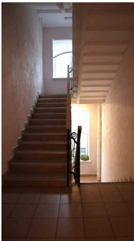
Фото 4.18. 4 этаж, лестница, помещение 1Н (201).
