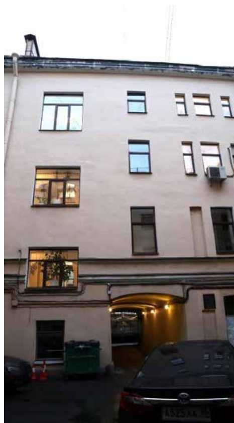
Фото 19. Дворовый фасад здания, фрагмент, вид на запад.
