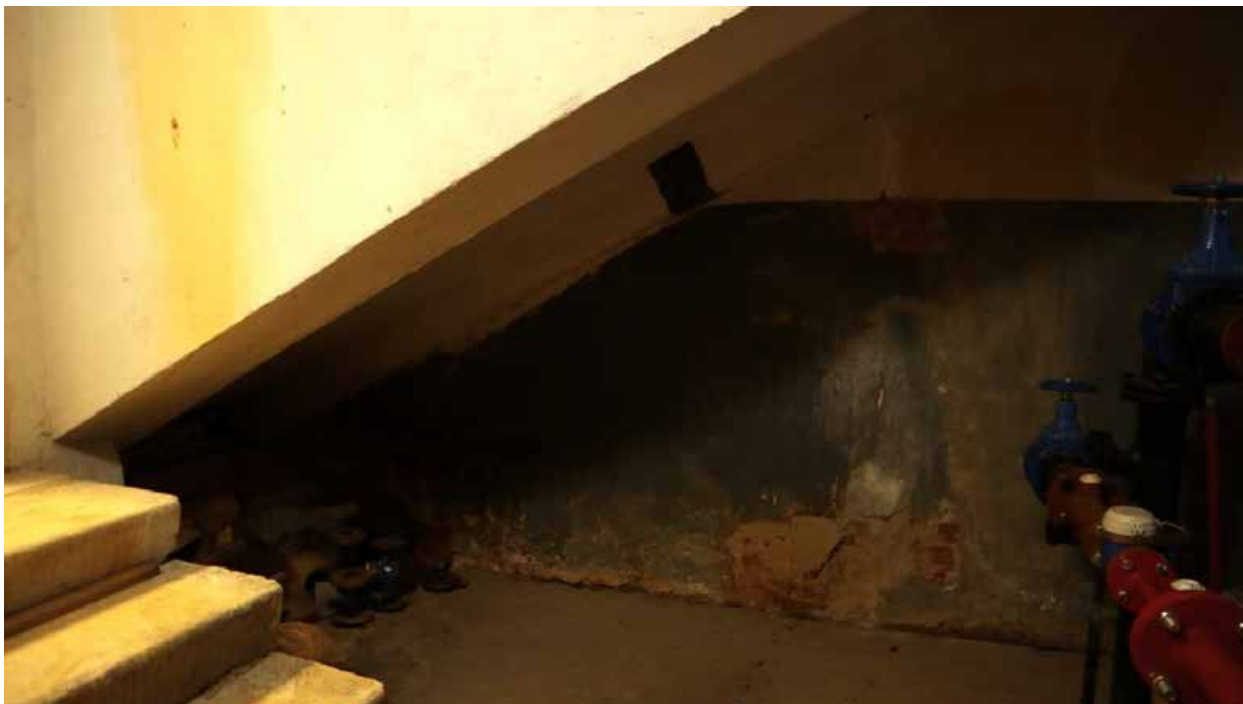
Фото 1.6. 1 этаж, помещение 1Н (9).
