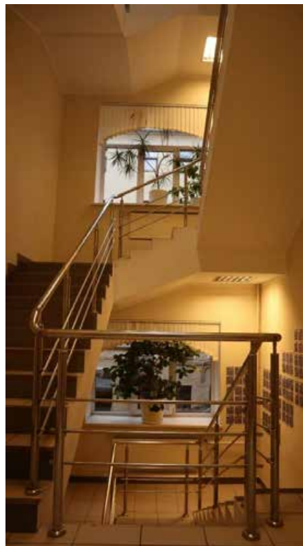
Фото 2.2. 2 этаж, лестница, помещение 1Н (63).
