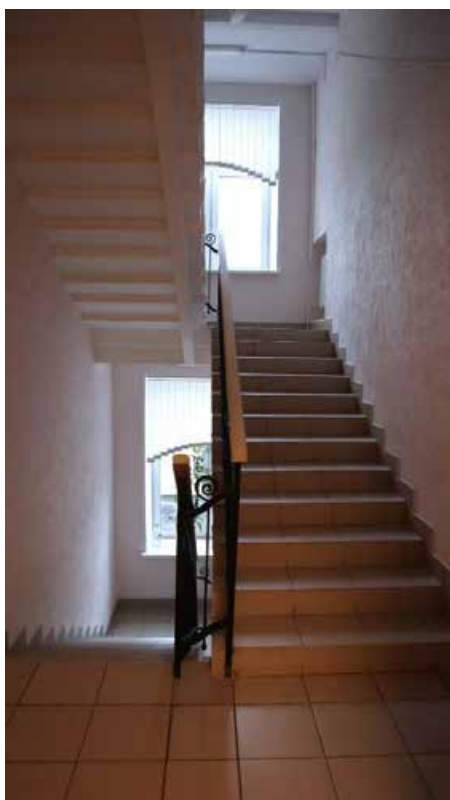
Фото 4.1. 4 этаж, лестница, помещение 1Н (197).
