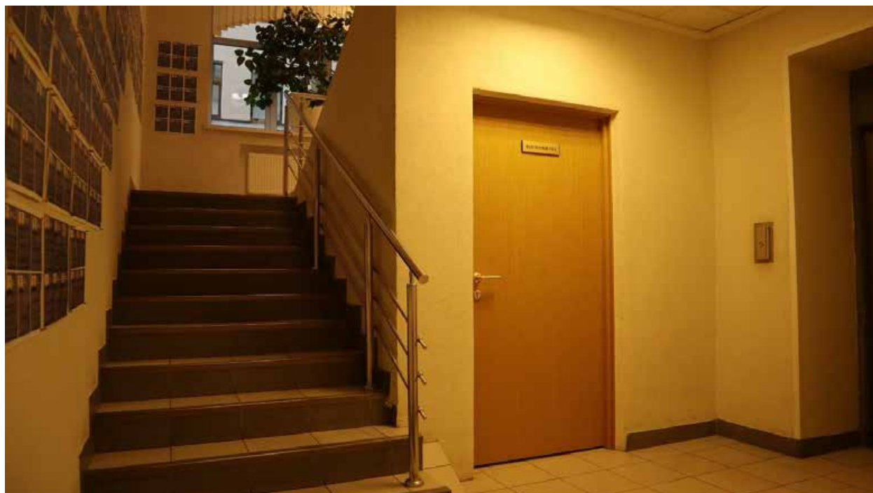
Фото 1.1. 1 этаж, лестница, помещение 1Н (4).
