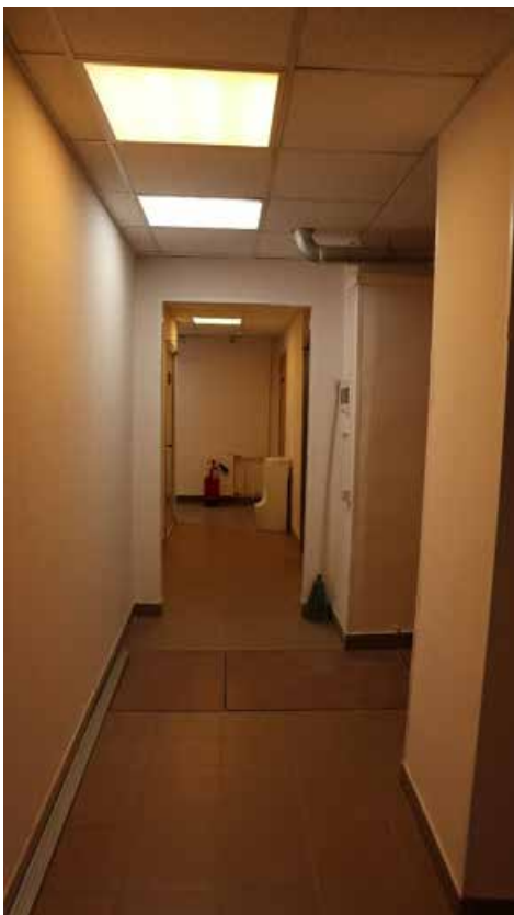
Фото 1.29. 1 этаж, помещение 1Н (32).
