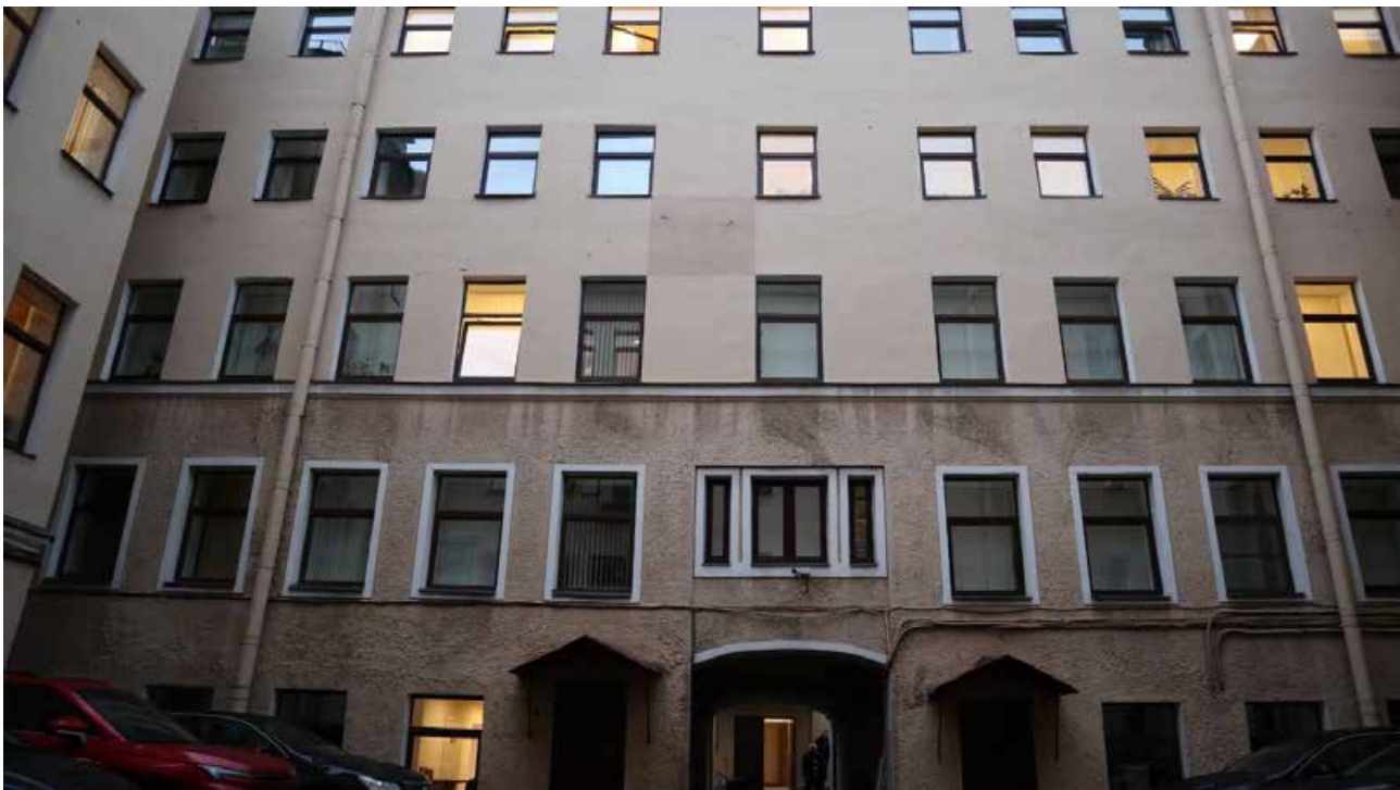
Фото 15. Дворовый фасад здания, фрагмент, вид на северо-восток.
