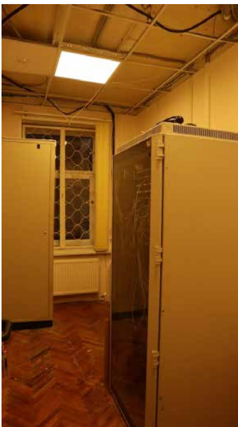
Фото 2.40. 2 этаж, помещение 1Н (88).
