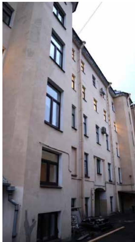
Фото 10. Восточный (дворовый) фасад здания, фрагмент.
