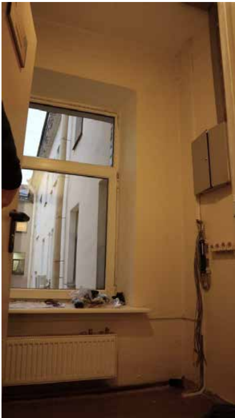
Фото 3.25. 3 этаж, помещение 1Н (138).
