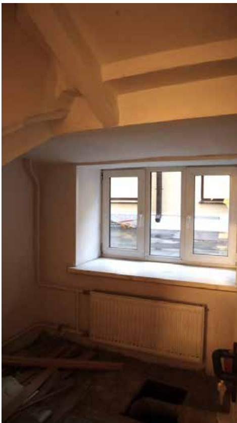
Фото 1.21. 1 этаж, помещение 1Н (22). (22).
