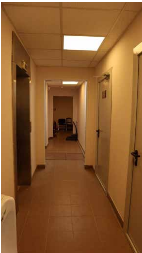
Фото 1.33. 1 этаж, помещение 1Н (40).
