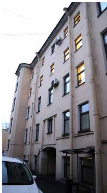
Фото 8. Восточный (дворовой) фасад здания, фрагмент.
