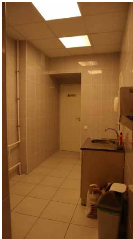
Фото 2.41. 2 этаж, помещение 1Н (83).
