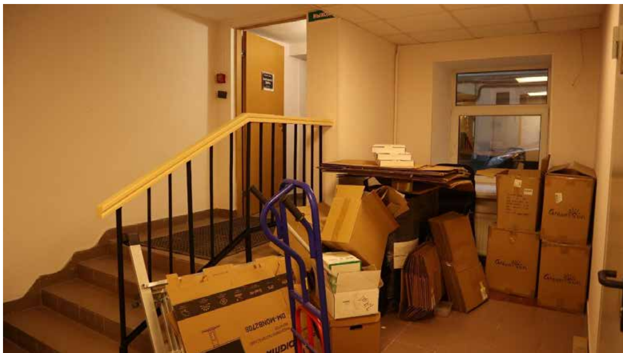
Фото 1.28. 1 этаж, помещение 1Н (29).
