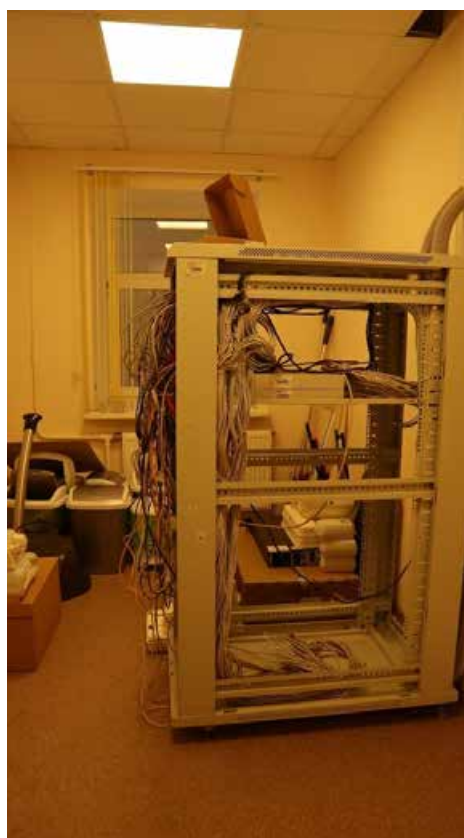
Фото 4.4. 4 этаж, помещение 1Н (204).
