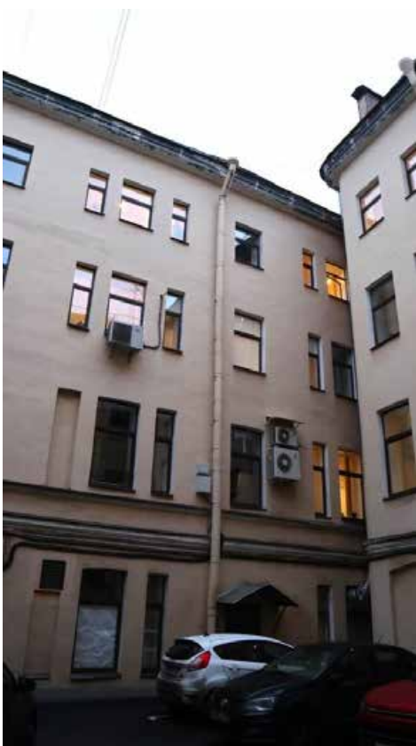
Фото 18. Дворовый фасад здания, фрагмент, вид на запад.
