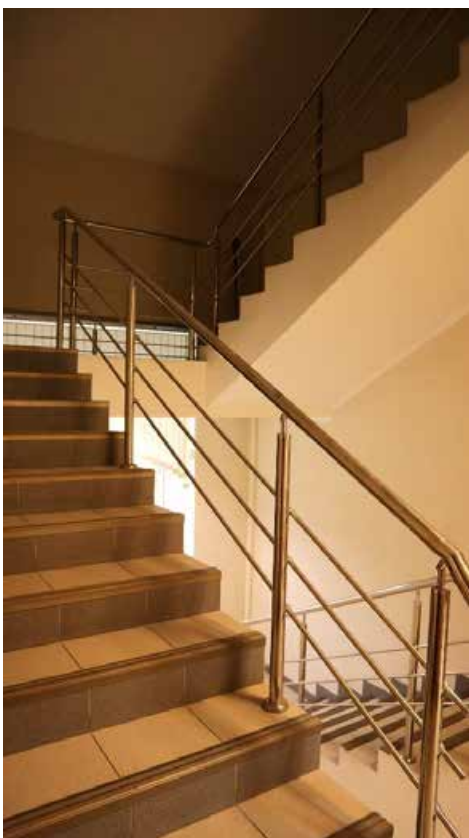
Фото 4.47. 4 этаж, лестница, помещение 1Н (177).
