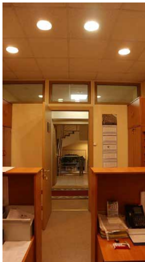
Фото 2.14. 2 этаж, помещение 1Н (121).
