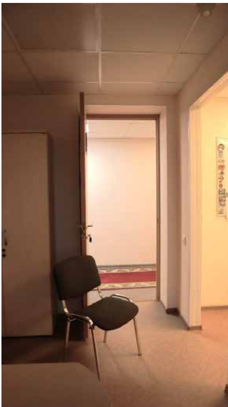
Фото 5.12. 5 этаж, помещение 1Н (241).
