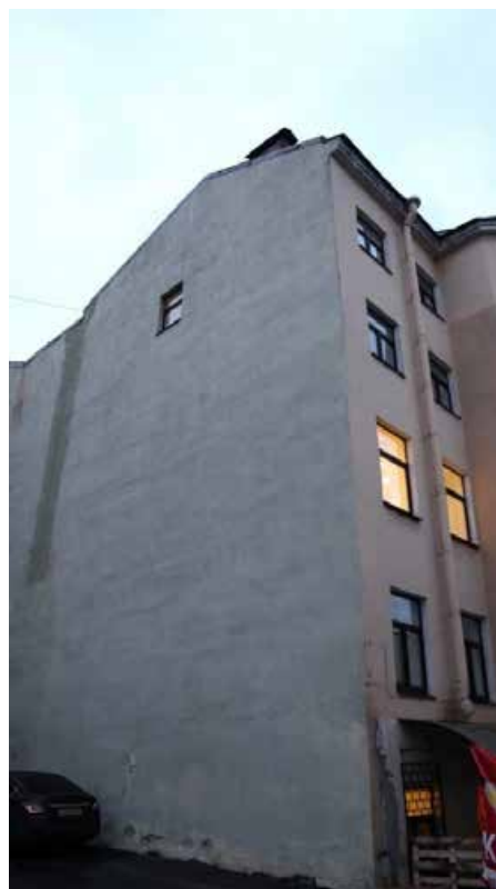
Фото 12. Южный фасад здания (брандмауэр), фрагмент.
