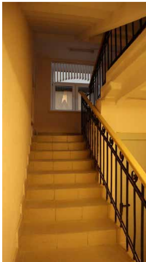
Фото 1.22. 1 этаж, лестница, помещение 1Н
