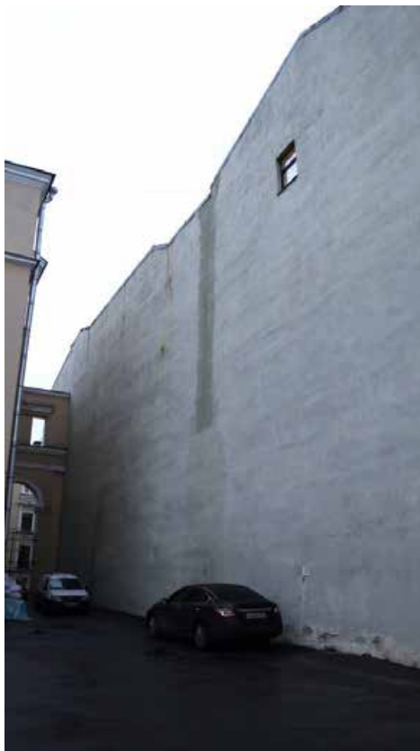
Фото 13. Южный фасад здания (брандмауэр), фрагмент.
