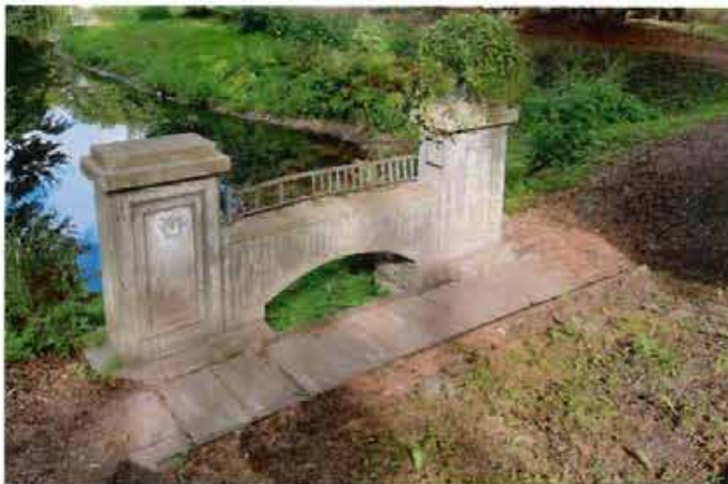
Фото 11: фрагмент объекта культурного наследия: мост.
