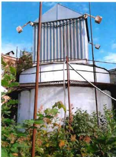
Фото 19: фрагмент объекта культурного наследия: Башня Глазнапа. (северо-западная часть объекта).
