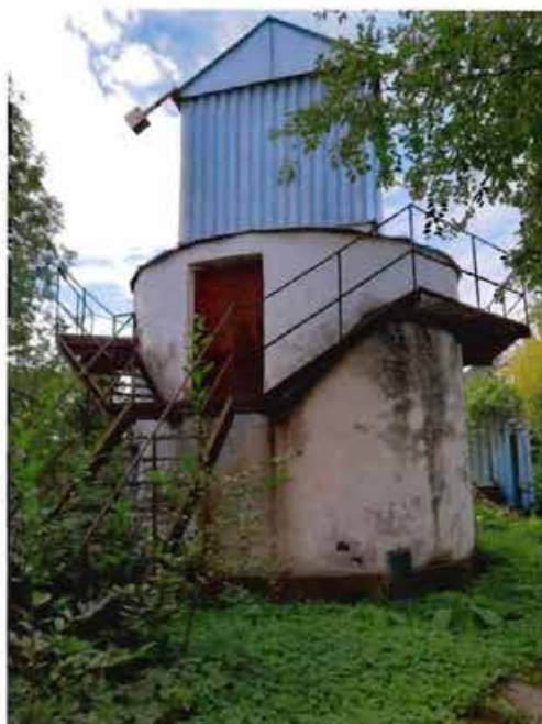
Фото 17: фрагмент объекта культурного наследия: Башня Глазнапа (северо-западная часть объекта).
