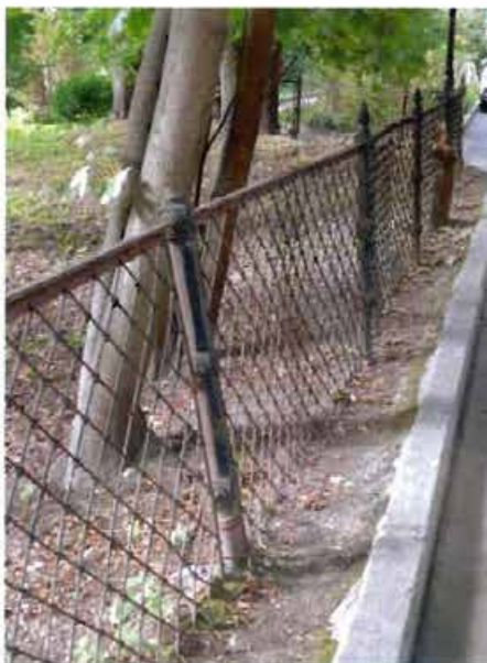
Фото 15: фрагмент объекта культурного наследия: фрагмент исторической чугуной ограды (опорные стойки круглые в сечении с прямоугольными перехватами, контрфорсами и конусообразным навершием).
