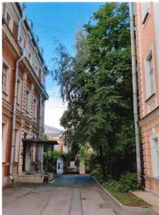
Фото 3: главный вход на территорию объекта культурного наследия.
