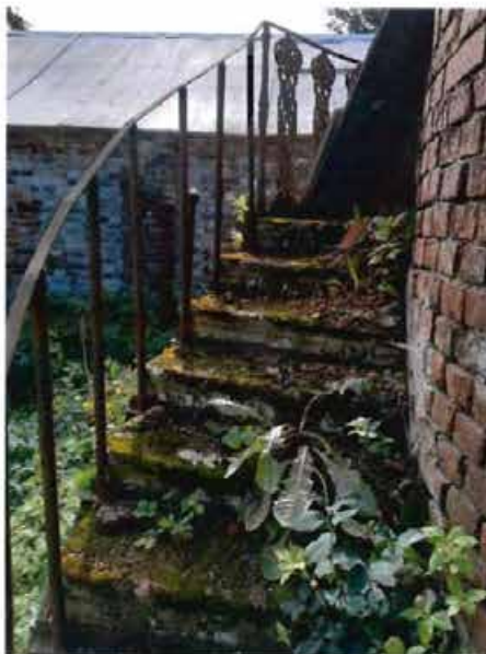
Фото 21: фрагмент объекта культурного наследия: наружная лестница, пристроенная к стене башни (павильон для астрономических наблюдений, северо-западная часть объекта).
