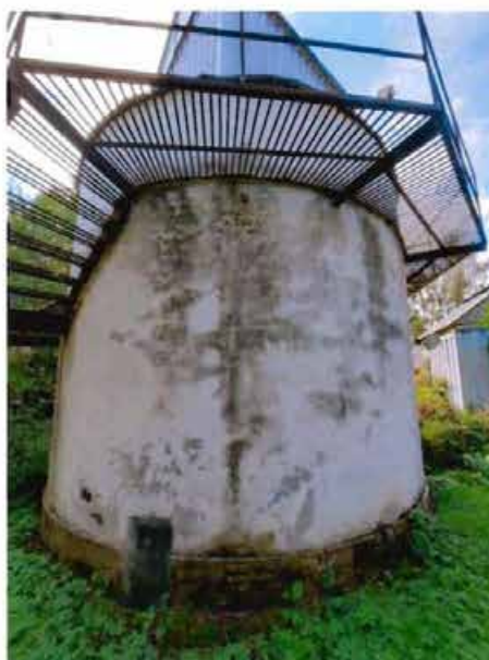
Фото 18: фрагмент объекта культурного наследия: Башня Глазнапа. (северо-западная часть объекта).
