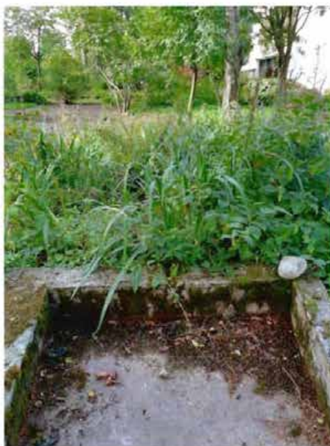
Фото 10: фрагмент объекта культурного наследия: каскад (северная часть объекта).
