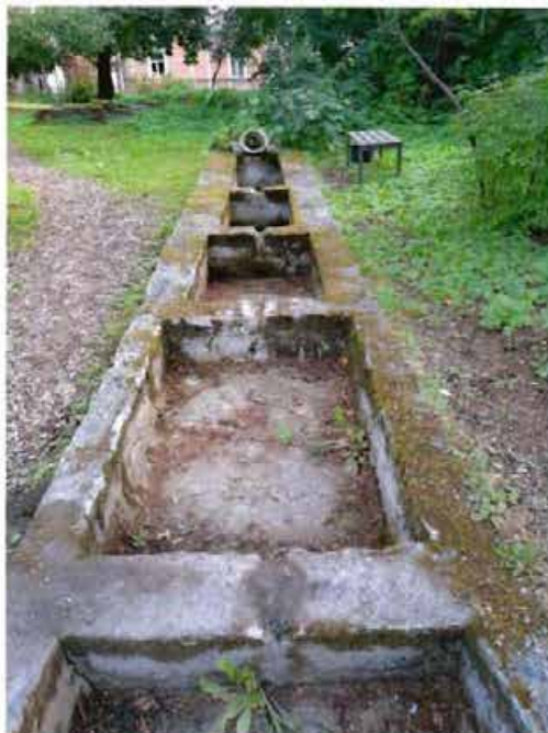
Фото 9: фрагмент объекта культурного наследия: каскад (северная часть объекта).
