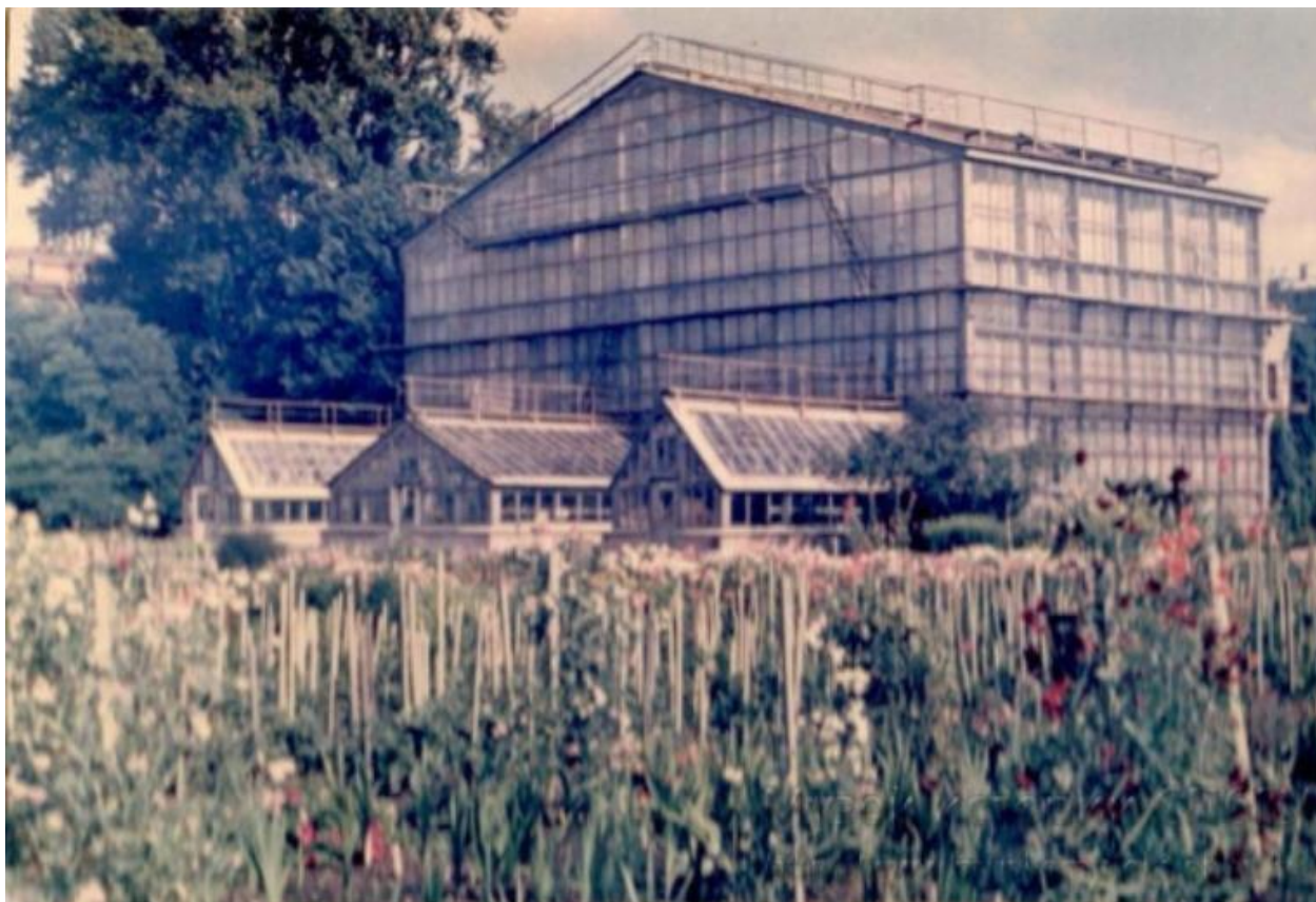
35. Оранжерея. 1974-1975 гг. Все работы завершены. Материалы директора ботанического сада Д.М. Залесского Музей истории СПбГУ.
