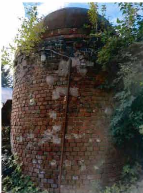
Фото 20: фрагмент объекта культурного наследия: павильон для астрономических наблюдений (северо-западная часть объекта).
