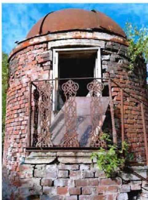
Фото 22: фрагмент объекта культурного наследия: павильон для астрономических наблюдений (северо-западная часть объекта).
