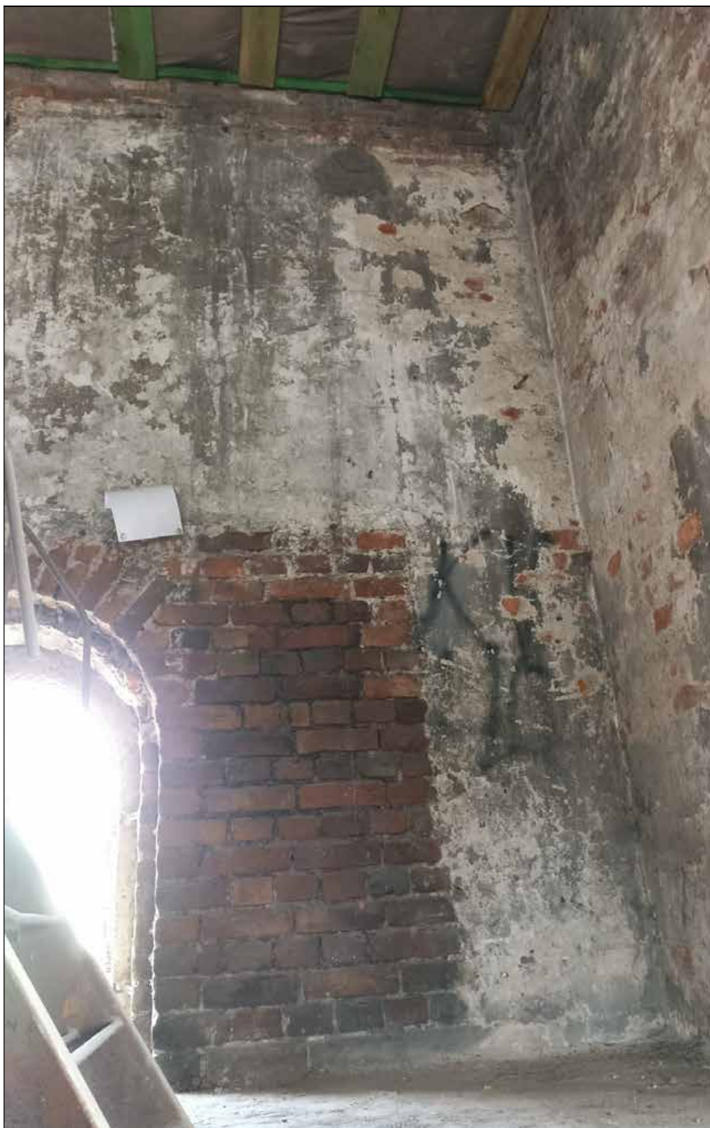
16. Выявленный объект культурного наследия «Фильтрационное отделение с ректификационной башней» в составе выявленного объекта культурного наследия «Казенный очистной винный склад № 4». Северо-западная часть помещения в верхнем уровне ректификационной башни. 06.10.2023 г.
