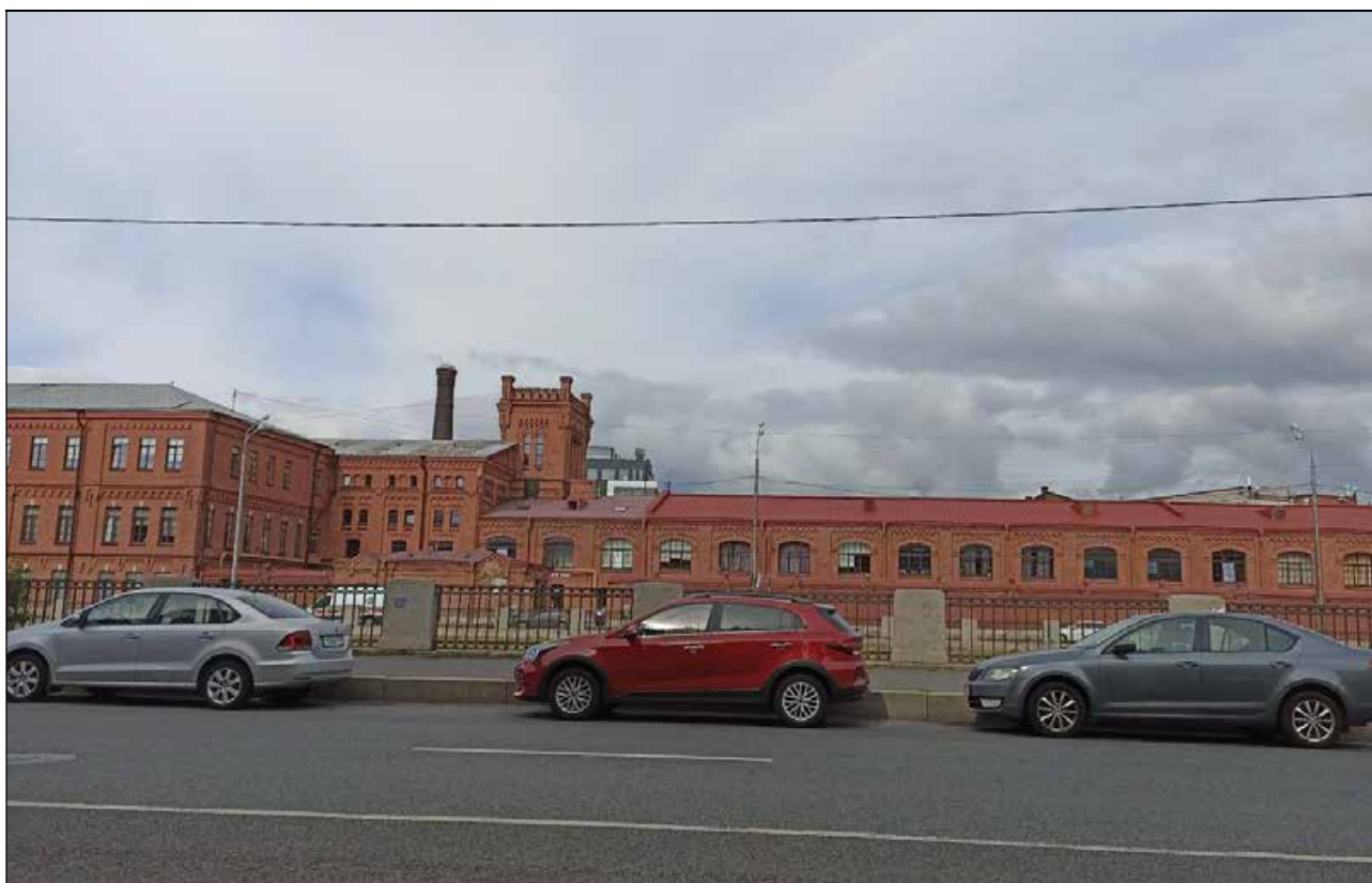
1. Выявленный объект культурного наследия «Казенный очистной винный склад № 4». Общий вид от нечетной стороны набережной Обводного канала. 06.10.2023 г.
