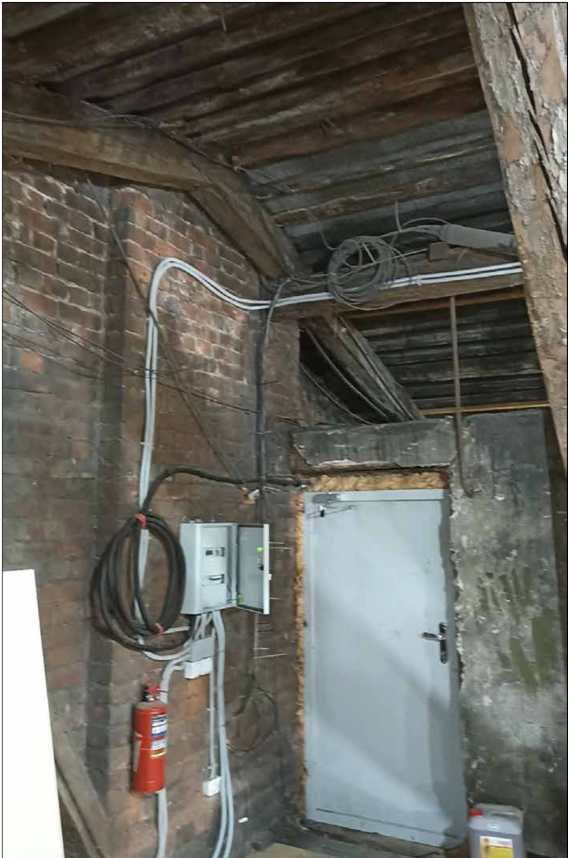
6. Выявленный объект культурного наследия «Фильтрационное отделение с ректификационной башней» в составе выявленного объекта культурного наследия «Казенный очистной винный склад № 4». Фрагмент внутренней стены в восточной части чердачного помещения. Вход в чердачное помещение. 06.10.2023 г.
