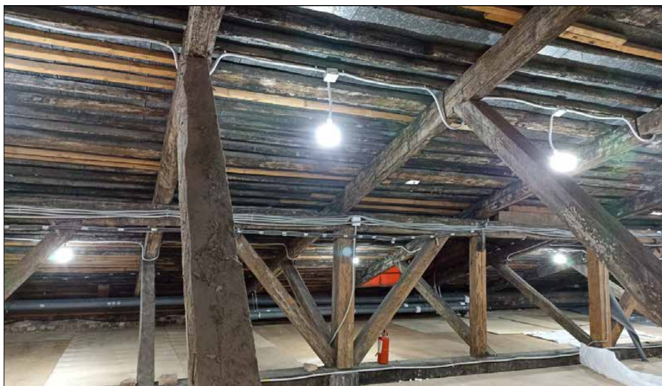
2. Выявленный объект культурного наследия «Фильтрационное отделение с ректификационной башней» в составе выявленного объекта культурного наследия «Казенный очистной винный склад № 4». Деревянные конструкции крыши в северной части чердачного помещения. 06.10.2023 г.
