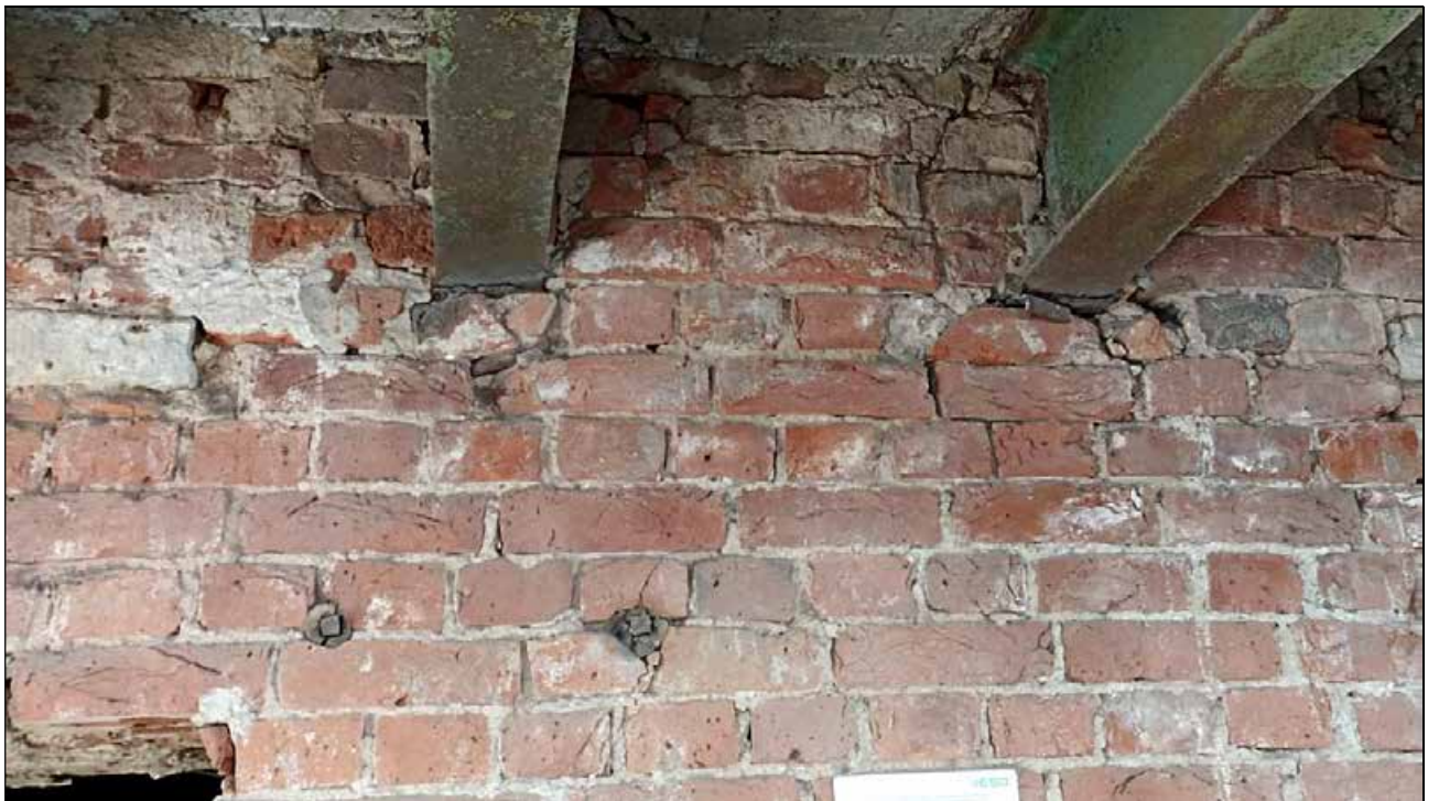
14. Выявленный объект культурного наследия «Фильтрационное отделение с ректификационной башней» в составе выявленного объекта культурного наследия «Казенный очистной винный склад № 4». Фрагмент внутренней кирпичной стены в ректификационной башне в уровне чердачного помещения. 06.10.2023 г.
