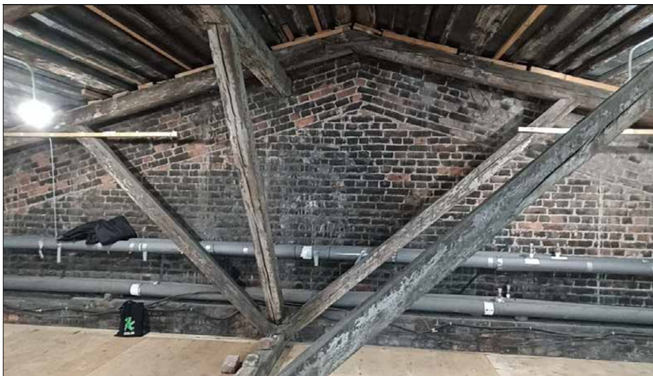
1. Выявленный объект культурного наследия «Фильтрационное отделение с ректификационной башней» в составе выявленного объекта культурного наследия «Казенный очистной винный склад № 4». Наружная западная стена чердачного помещения. 06.10.2023 г.
