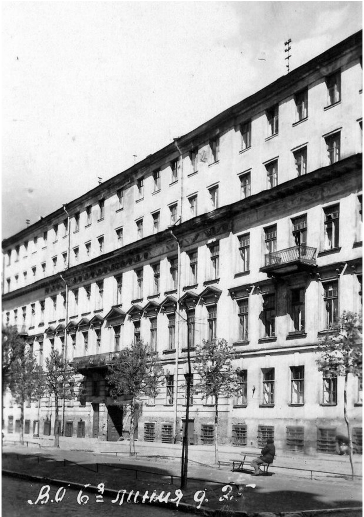
Илл. 5. Фасад здания по 6-й линии, д. 25.
