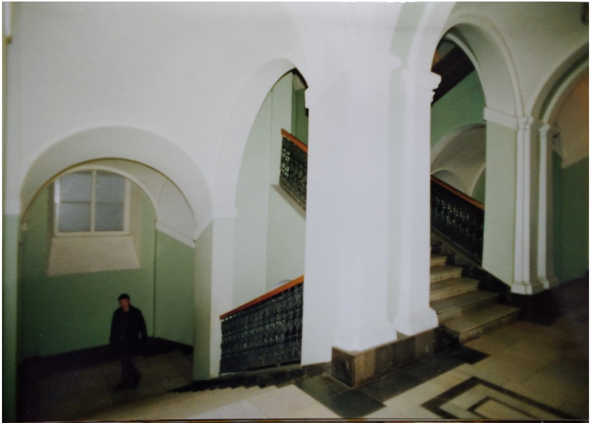
32. Парадная лестница, 2-й этаж, вид с юго-востока. Фото 2000 г. Архив КГИОП. Паспорт объекта культурного наследия «Институт инженеров путей сообщения. Главное здание».
