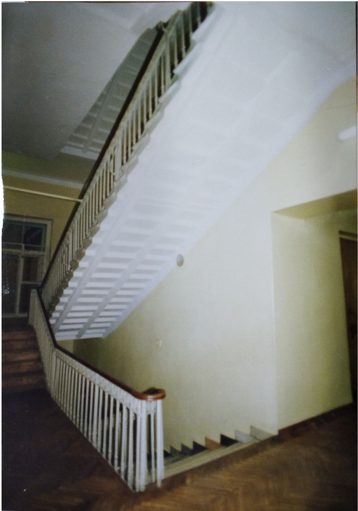
34. Южное крыло, лестница, 2-й этаж, вид с северо-востока. Фото 2000 г. Архив КГИОП. Паспорт объекта культурного наследия «Институт инженеров путей сообщения. Главное здание».
