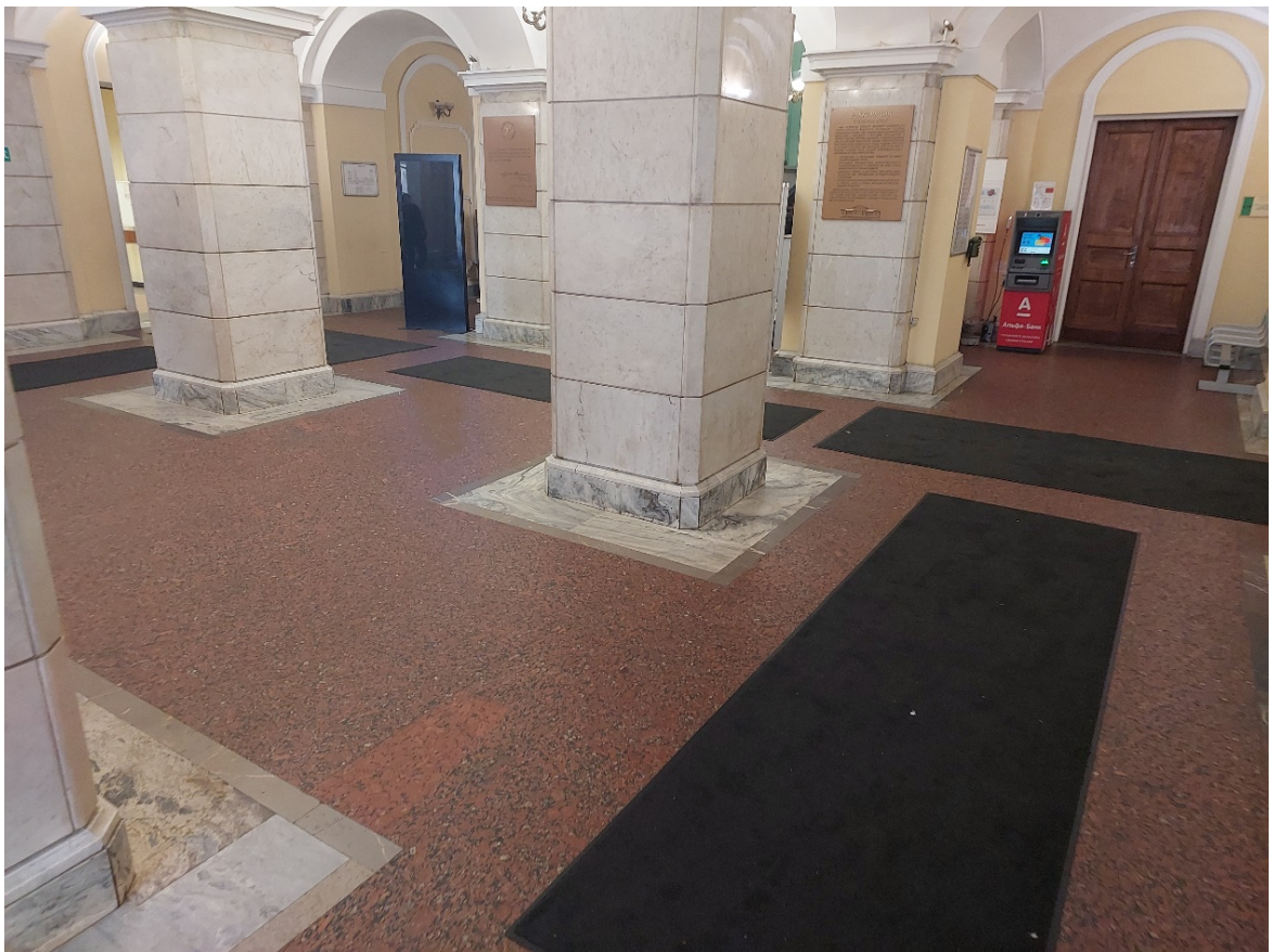
5. Вид на западную часть вестибюля с северо-востока.
