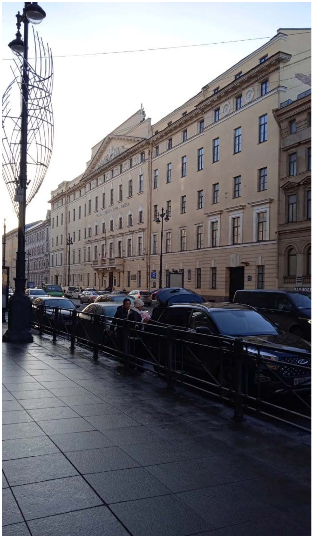
1. Вид на лицевой фасад здания с северо-востока.
