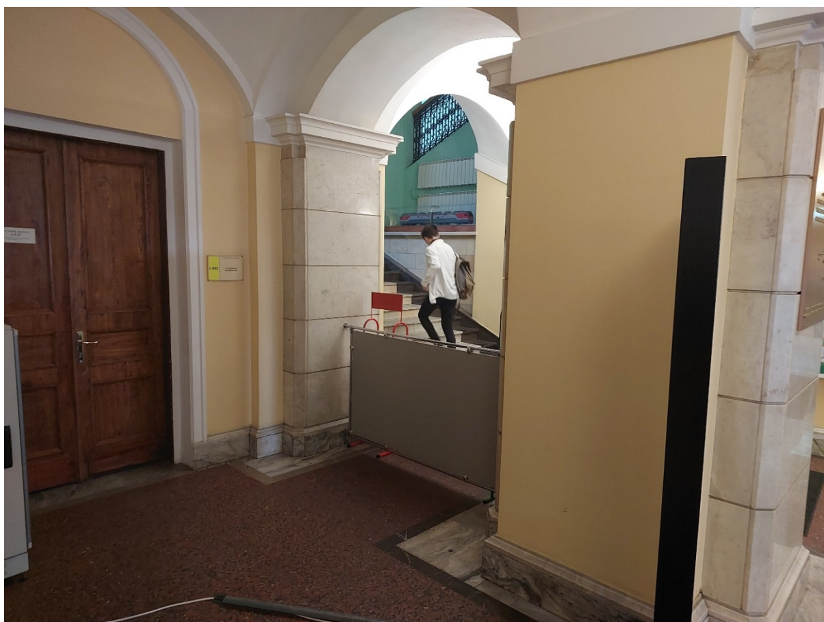
13. Юго-западная часть вестибюля и фрагмент лестницы, вид с юго-востока.
