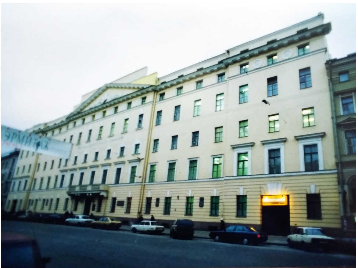
13. Лицевой фасад, вид с северо-востока. Фото 2000 г. Архив КГИОП. Паспорт объекта культурного наследия «Институт инженеров путей сообщения. Главное здание».
