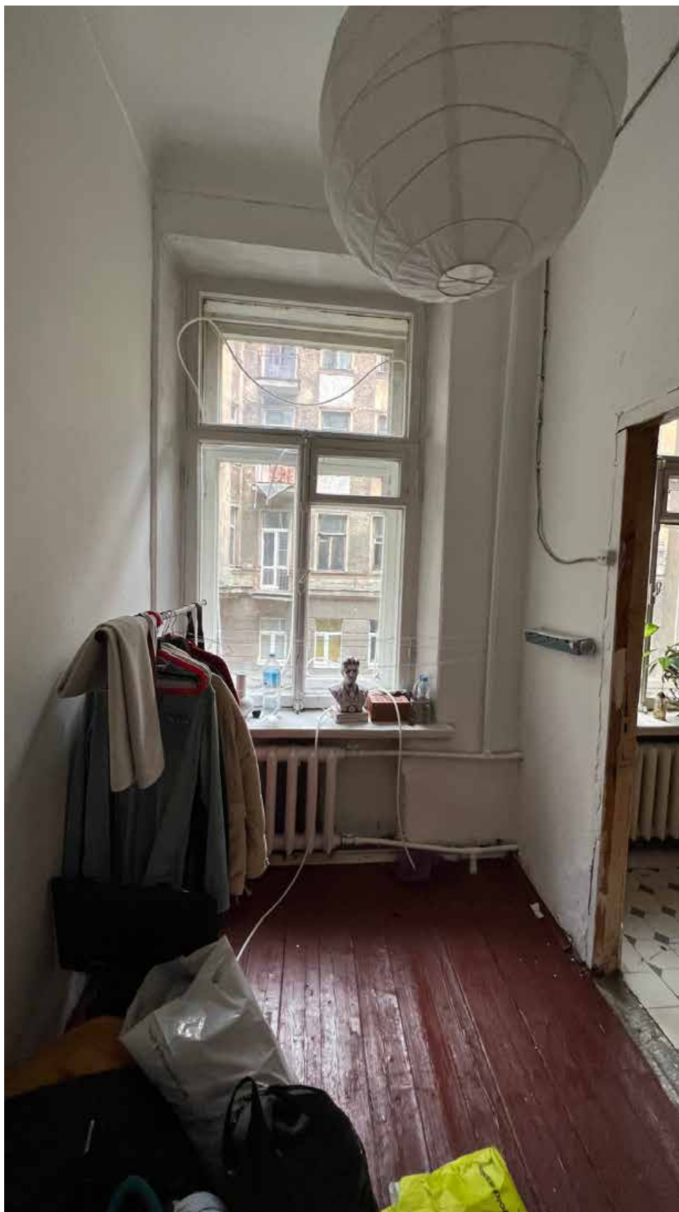
8. Фрагмент интерьера комнаты (помещение 5/8.7);
