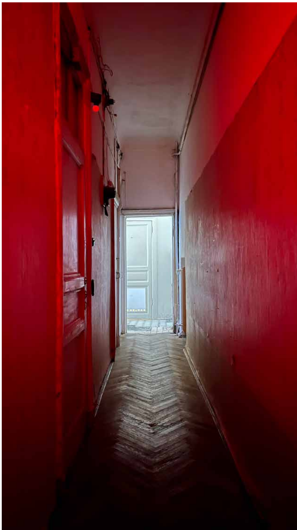
15. Фрагмент интерьера коридора (помещение 2/14.8);
