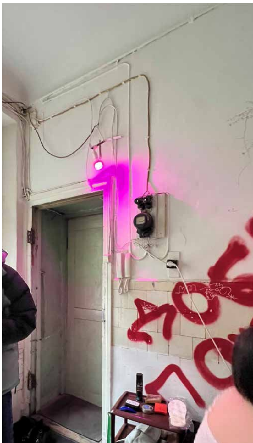
4. Вид на входную дверь в квартире;
