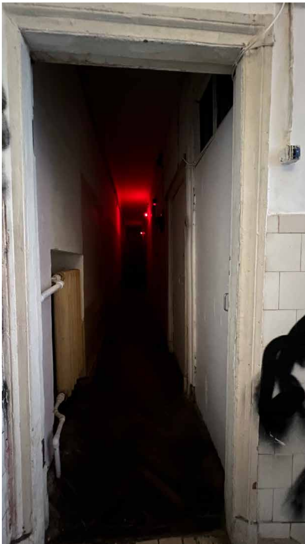
12.Фрагмент интерьера коридора (помещение 2/14.8);
