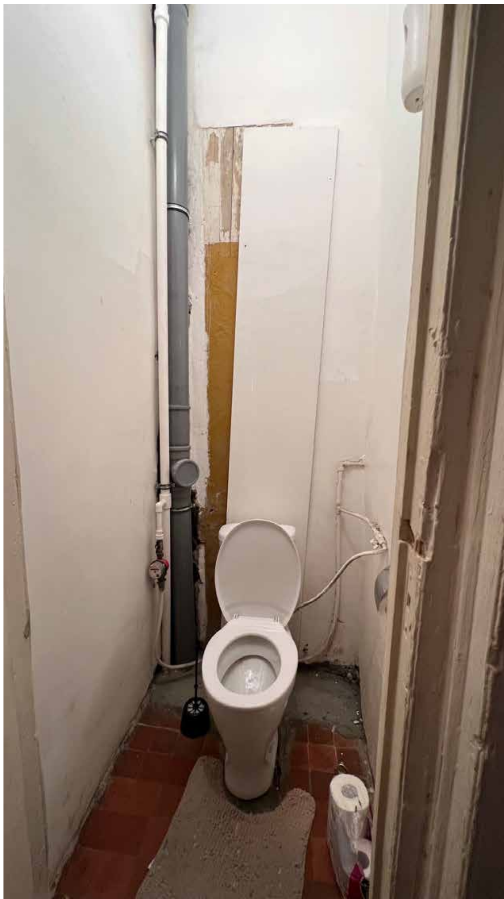
10.Фрагмент интерьера туалета (помещение 3/1);
