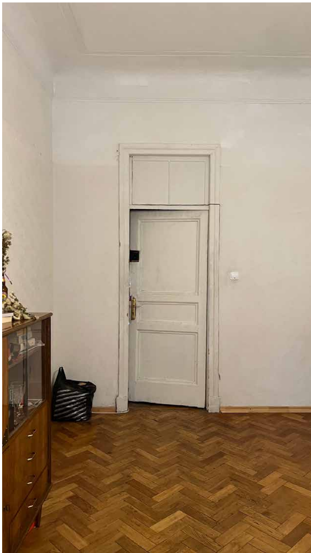
17.Фрагмент интерьера комнаты (помещение 7/21).
