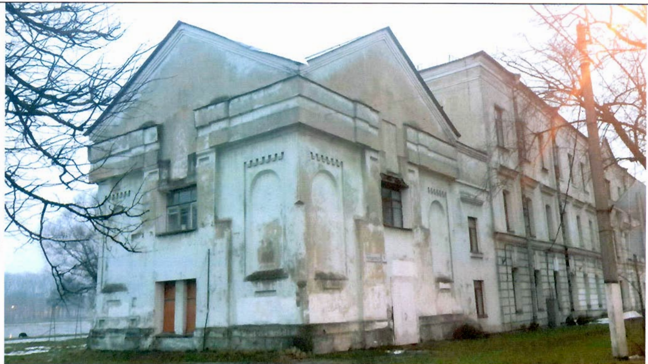
Фото 1. Западный, северный фасады. Общий вид. 22.12.2016.
