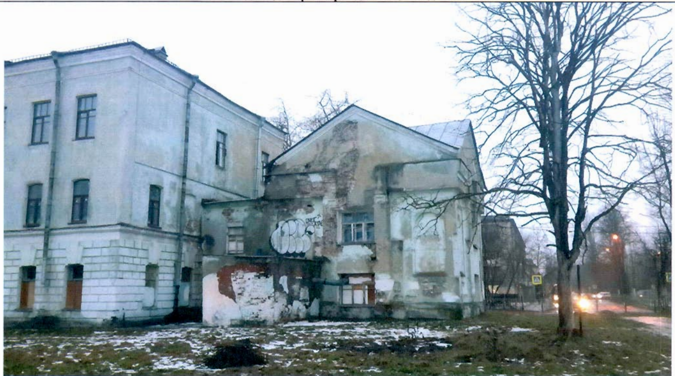
Фото 2. Восточный фасад. Общий вид. 22.12.2016.
