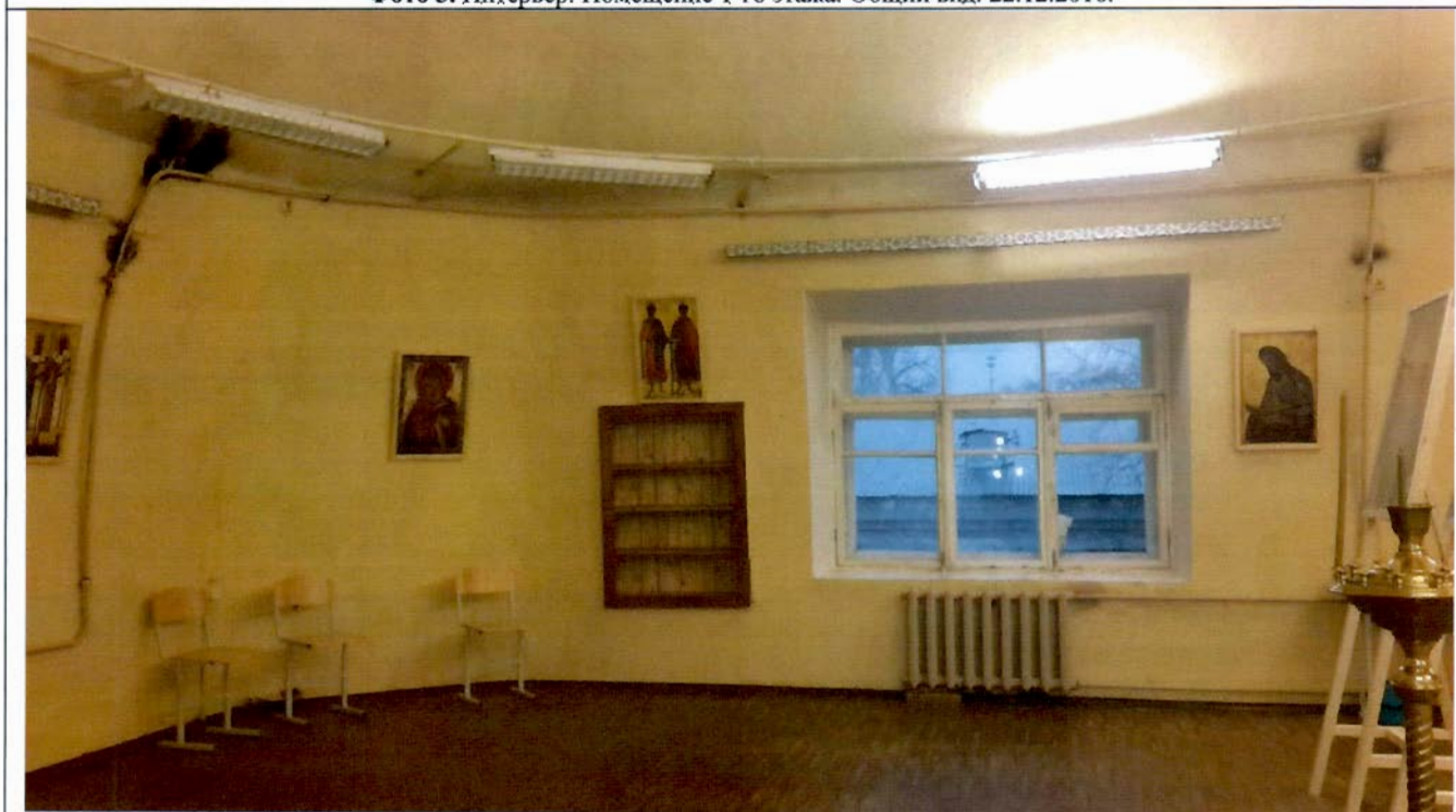
Фото 4. Интерьер. Помещение 2-го этажа. Общий вид. 22.12.2016.
