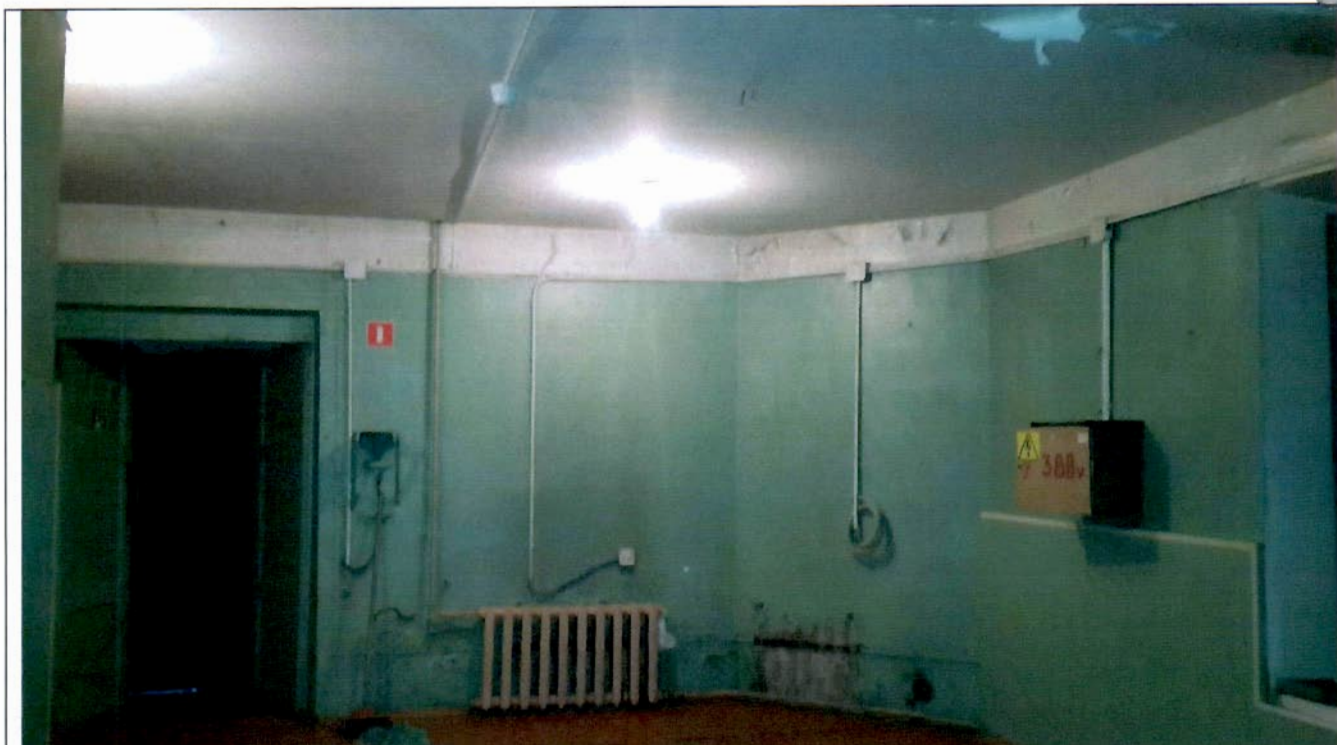
Фото 3. Интерьер. Помещение 1-го этажа. Общий вид. 22.12.2016.
