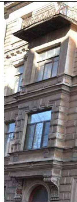
балконы – количество (четыре), местоположение (в завершении эркеров), конфигурация (прямоугольные в плане, трапециевидный - в завершении углового эркера), конструкция, габариты; ограждение балконов – материал (металл), техника исполнения (ковка, литье), рисунок (секции с волютообразными завитками, верхний горизонтальный пояс с геометрическим орнаментом и трилистниками);
