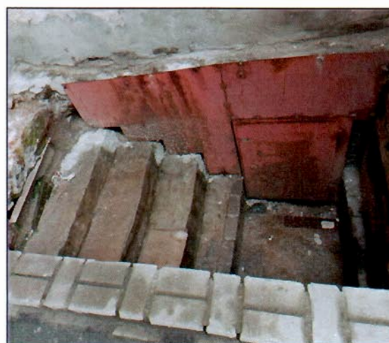
Фото 19. Вход с южного фасада через приямок.
