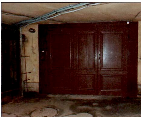
Фото 18. Вход в пом. 10-Н с воротного проезда между дворами.
