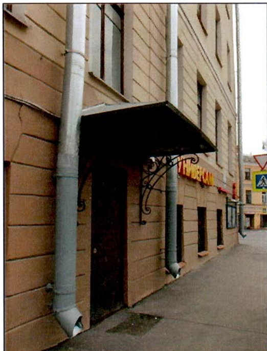
Фото 10. Вход со стороны юго-западного фасада (пом. 4-Н).
