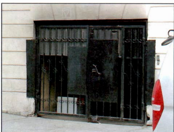
Фото 6. Воротный проезд юго-западного фасада
