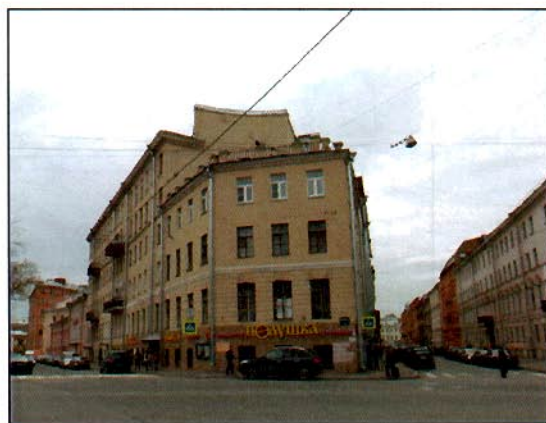
Фото 3. Южный фасад со стороны пр. Римского-Корсакова.
