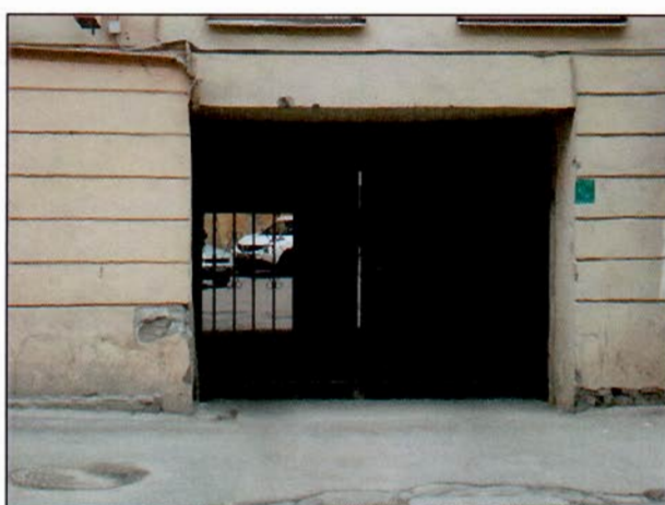
Фото 7. Воротный проезд восточного фасада.
