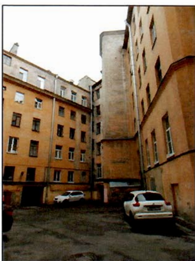
Фото 16. Западный дворовый фасад.
