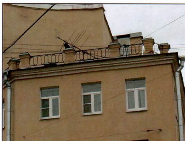
Фото 5. Фрагмент южного фасада.
