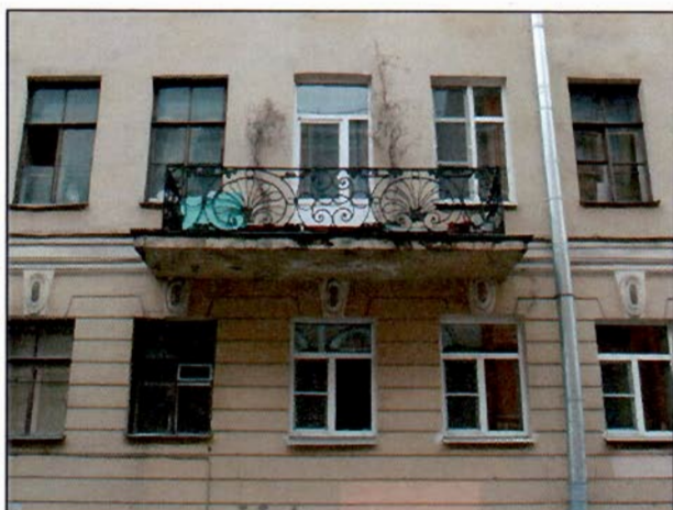
Фото 4. Фрагмент восточного фасада.
