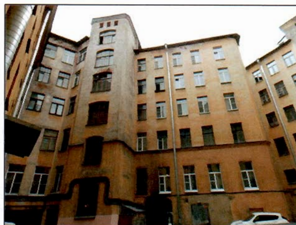
Фото 15. Восточный дворовый фасад.
