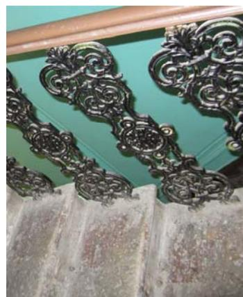
исторические служебные лестницы – конфигурация, габариты, местоположение, тип (двухмаршевые), конструкция (по косоурам, площадки по плоским перекрытиям и прусским сводам), вид материала ступеней (известняк);
