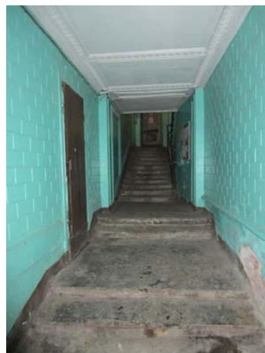
парадная лестница со стороны Загородного пр. – конфигурация, габариты, местоположение, тип (двухмаршевая), конструкция (по косоурам), вид материала ступеней (известняк); ограждение – вид материала (черный металл), техника исполнения (литье), рисунок; поручни – конфигурация, габариты, вид материала (дерево);
