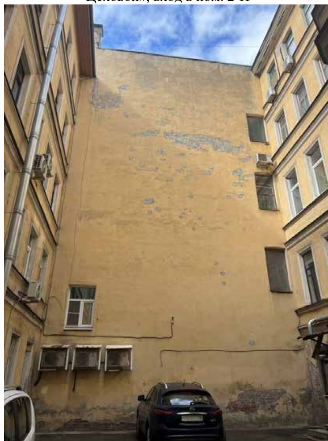
Фото 4. Фрагмент дворового фасада выявленного объекта культурного наследия «Дом А.И. Цеховой»
