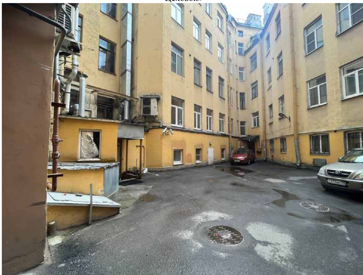
Фото 6. Фрагмент дворового фасада выявленного объекта культурного наследия «Дом А.И. Цеховой»
