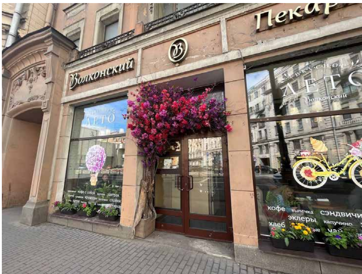
Фото 3. Фрагмент лицевого фасада выявленного объекта культурного наследия «Дом А.И. Цеховой», вход в пом. 2-Н
