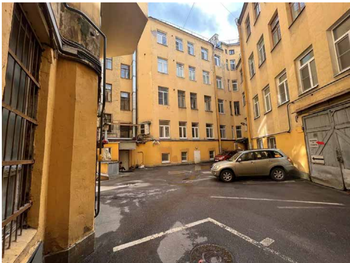
Фото 5. Фрагмент дворового фасада выявленного объекта культурного наследия «Дом А.И. Цеховой»
