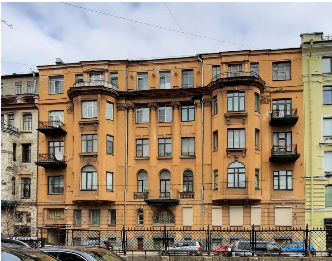
Илл. 22. Таврическая ул., 3. 2022 г. Citywalls: Архитектурный сайт Санкт-Петербурга [Электронный ресурс] URL: https://www.citywalls.ru/photo560178.html
