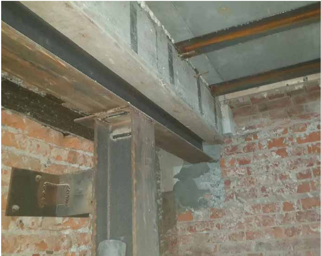
Фото 19 – Фрагмент колонны в помещении подвала в осях А-Б/10-11
