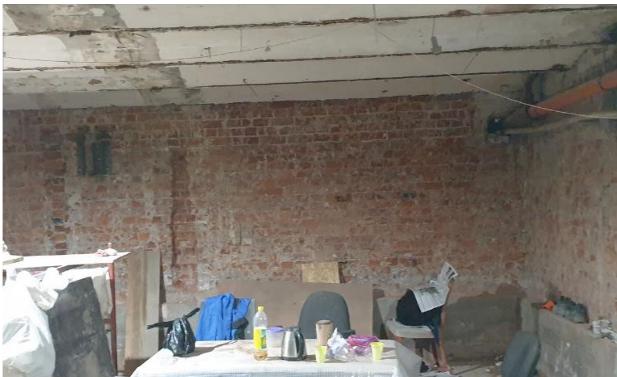
Фото 11 – Помещение подвала в осях В-Г/10
