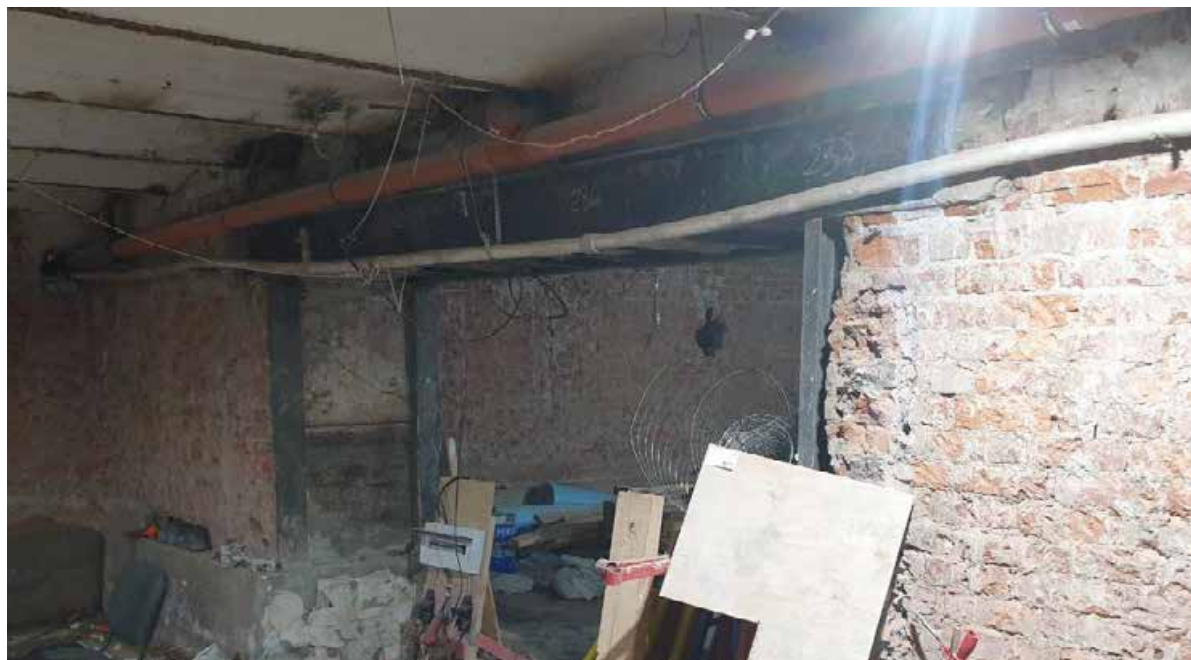
Фото 12 – Помещение подвала в осях В/10-11
