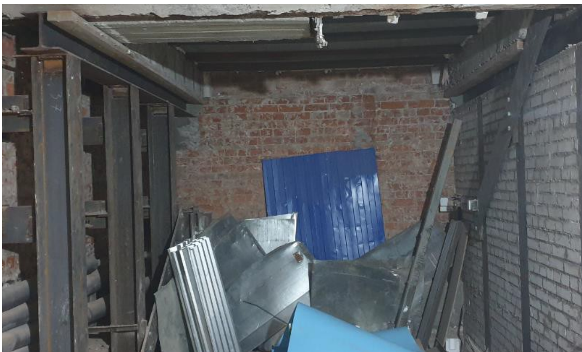
Фото 18 – Помещение подвала в осях А-Б/10-11
