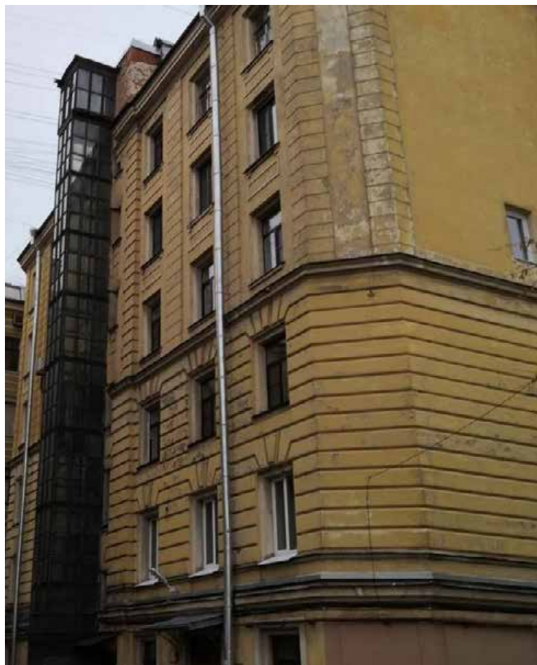
Фото 3 – Фрагмент дворового фасада здания
