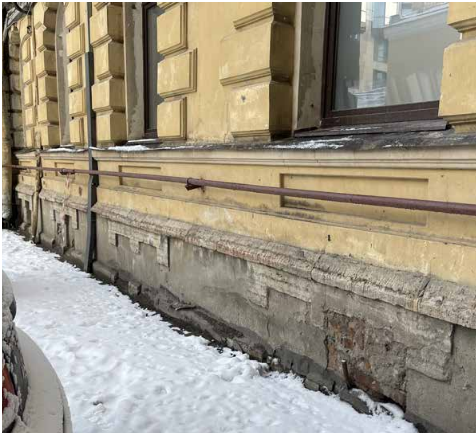
Фото 5 – Фрагмент дворового фасада здания
