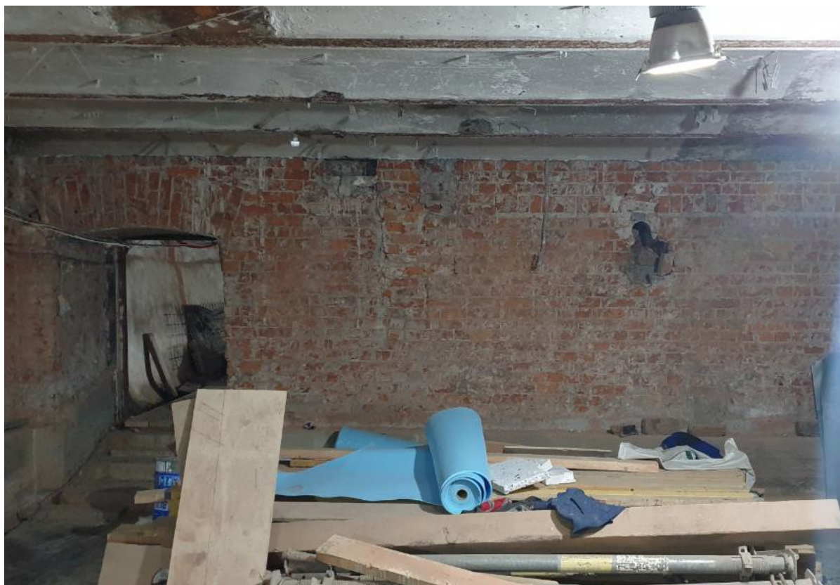
Фото 7 – Помещение подвала в осях А-В/10-11
