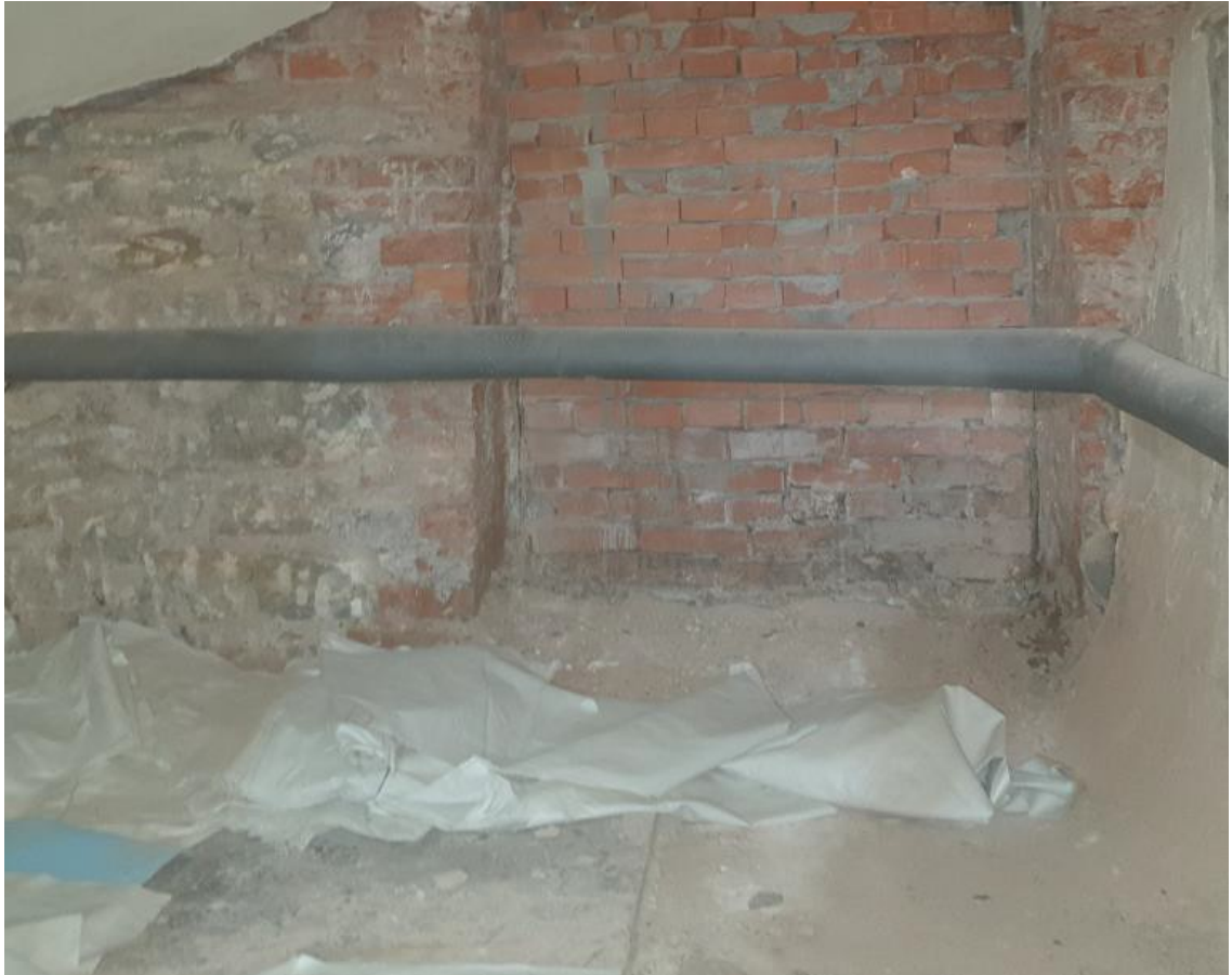
Фото 20 – Помещение подвала в осях Г/10-11
