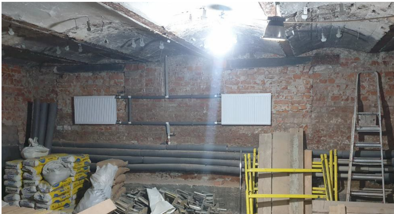
Фото 13 – Помещение подвала в осях Г/10-11
