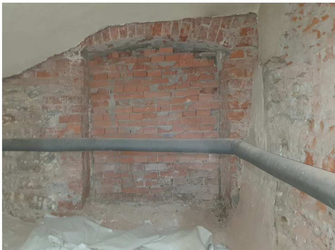
Фото 10 – Помещение подвала в осях Г/10-11
