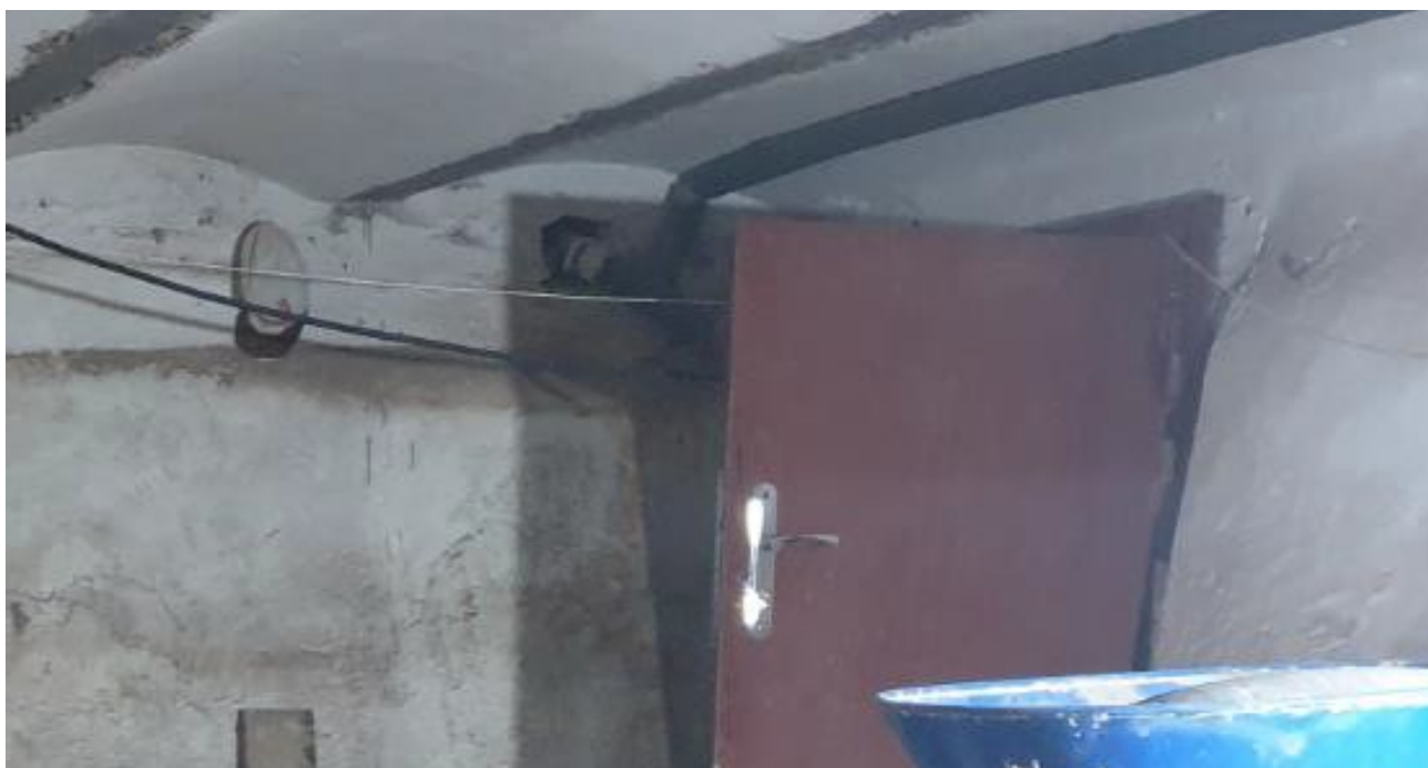
Фото 14 – Помещение подвала в осях А-В/12
