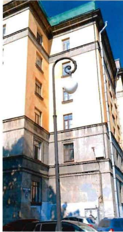
7. Фрагмент. Северный фасад южного флигеля.
