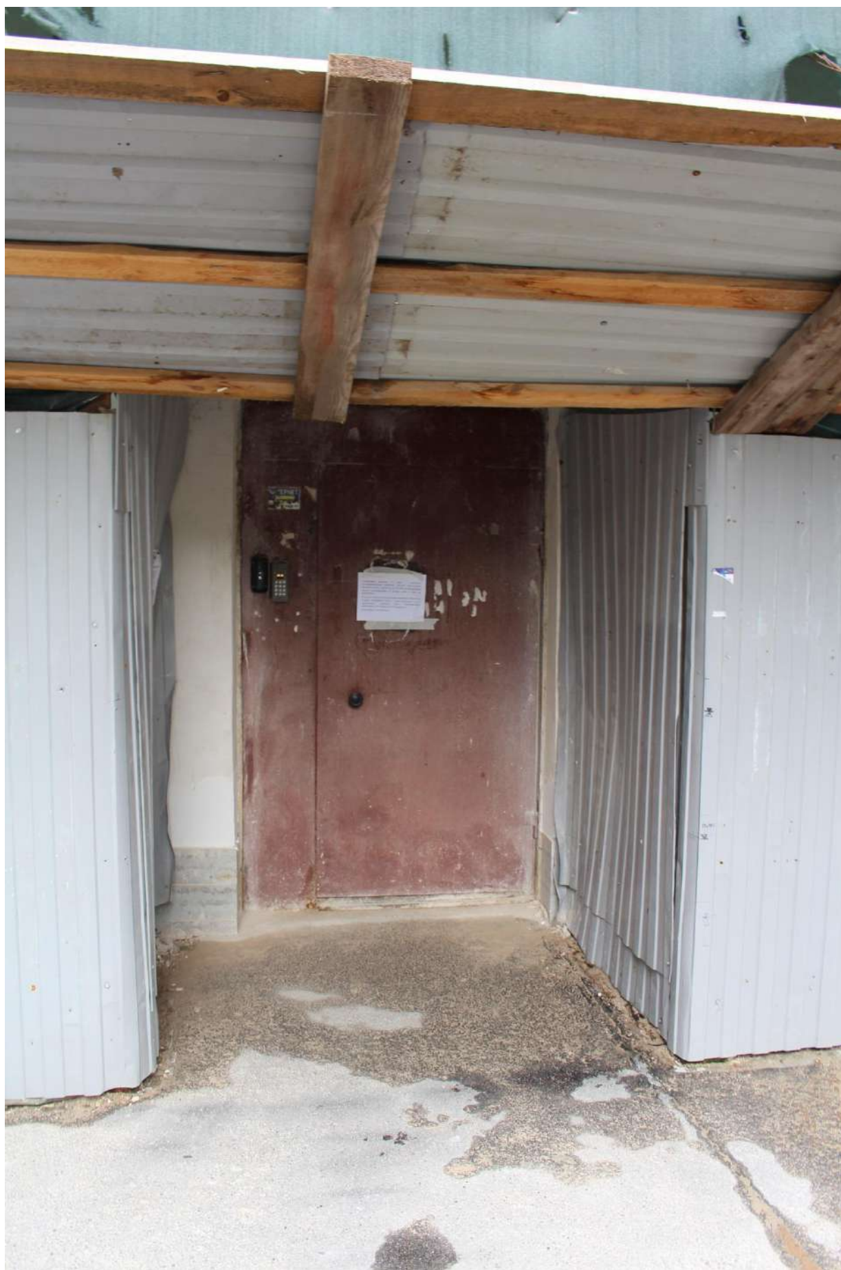
Фото 11. Вид на вход в парадную, ведущую в квартиру объекта культурного наследия.
