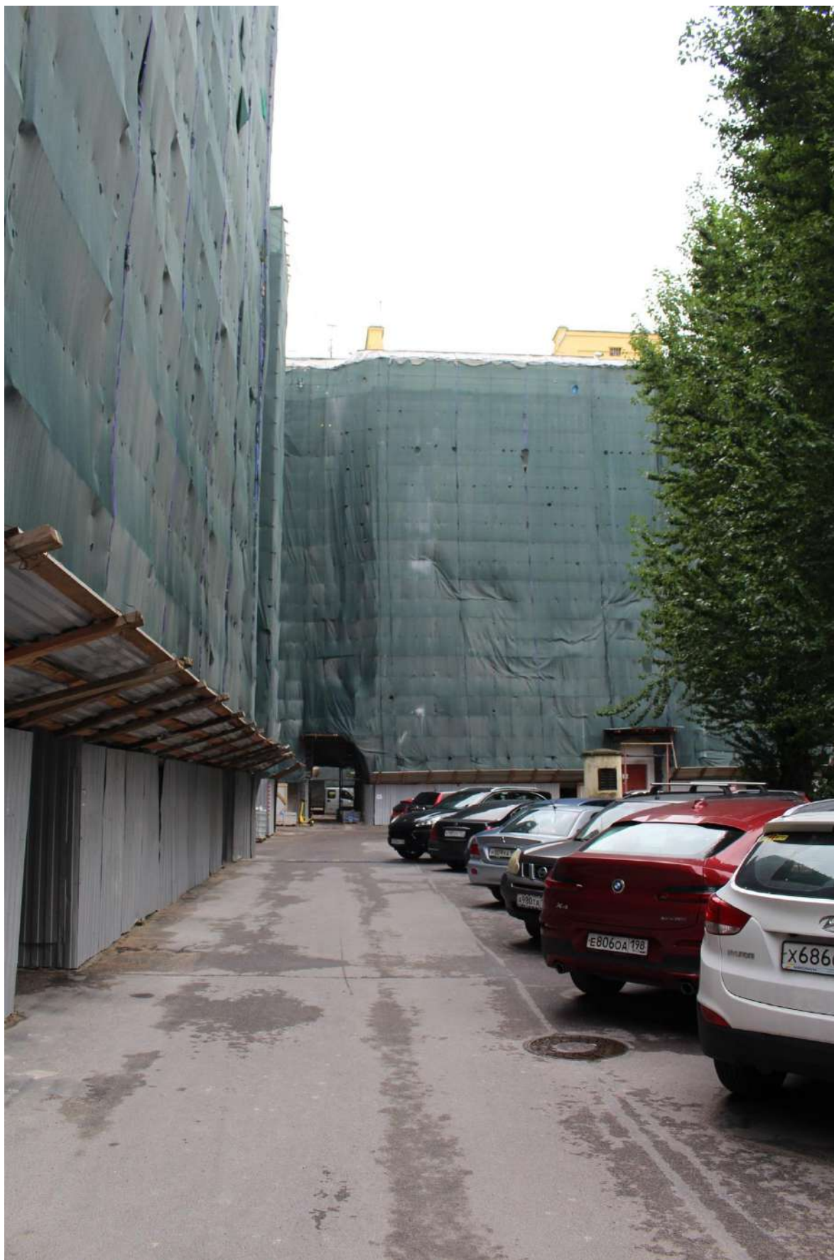
Фото 7. Фрагмент фасада курдонера объекта культурного наследия по Московскому проспекту.
