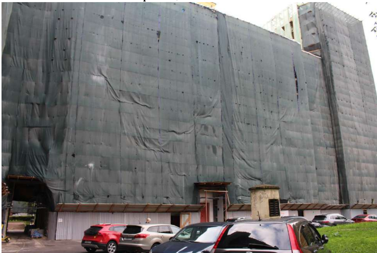
Фото 1. Фрагмент фасада объекта культурного наследия со стороны двора.
