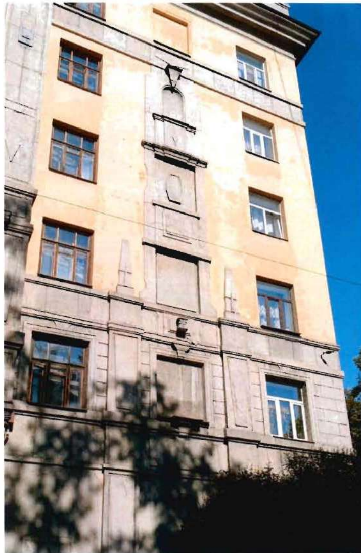
13. Фрагмент. Северный фасад северного флигеля.
