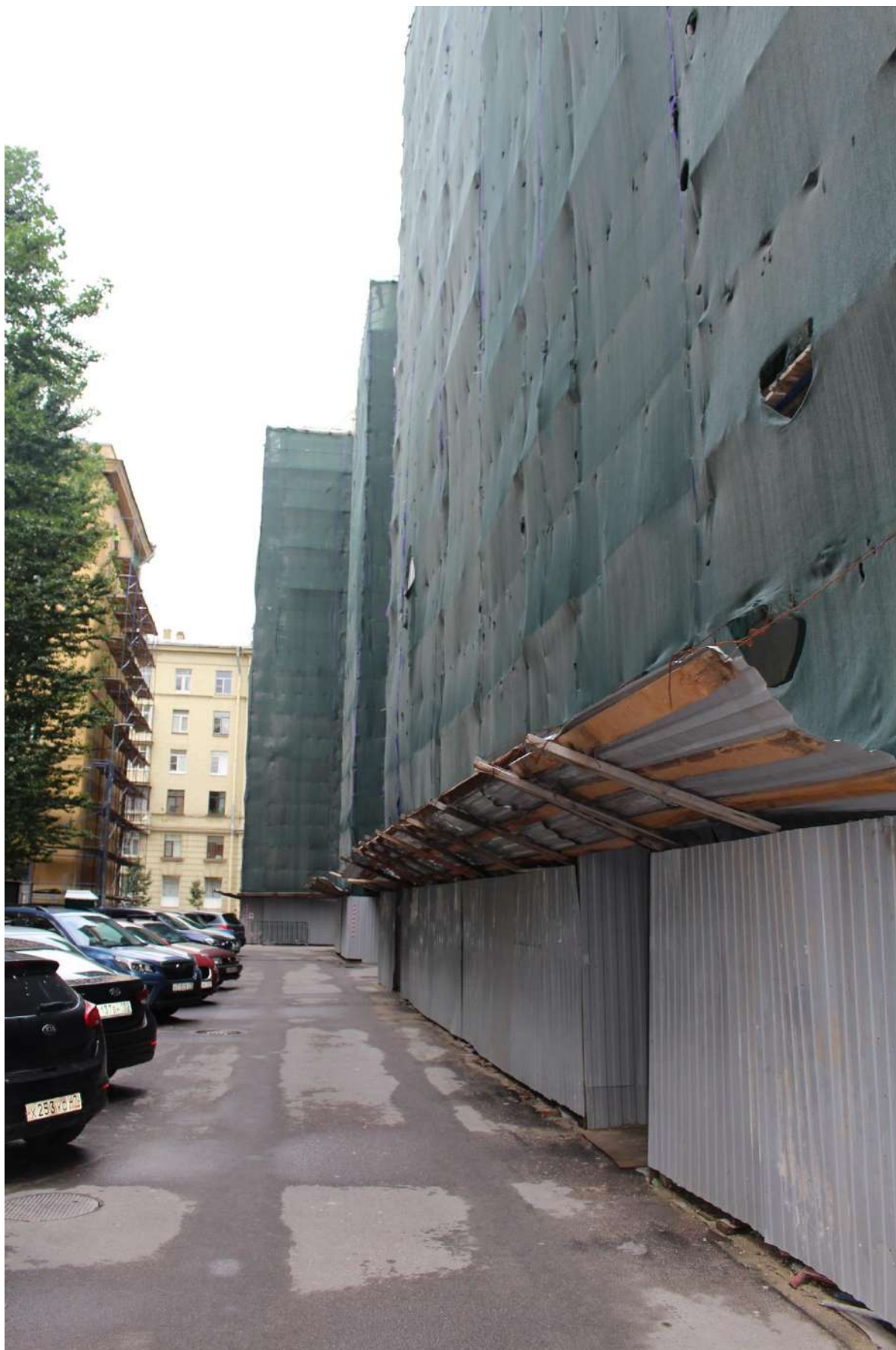
Фото 8. Фрагмент фасада курдонера объекта культурного наследия по Московскому проспекту.
