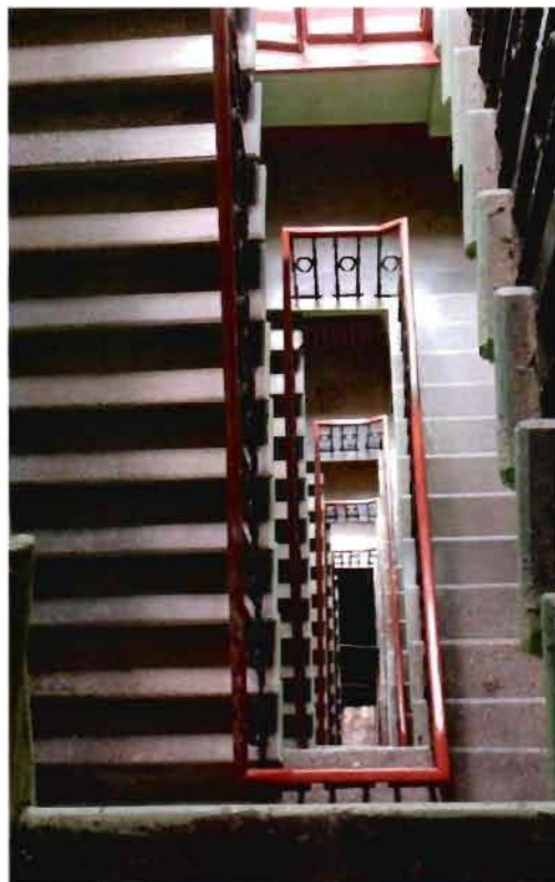
16. Интерьер. Пространство ЛК-9.
