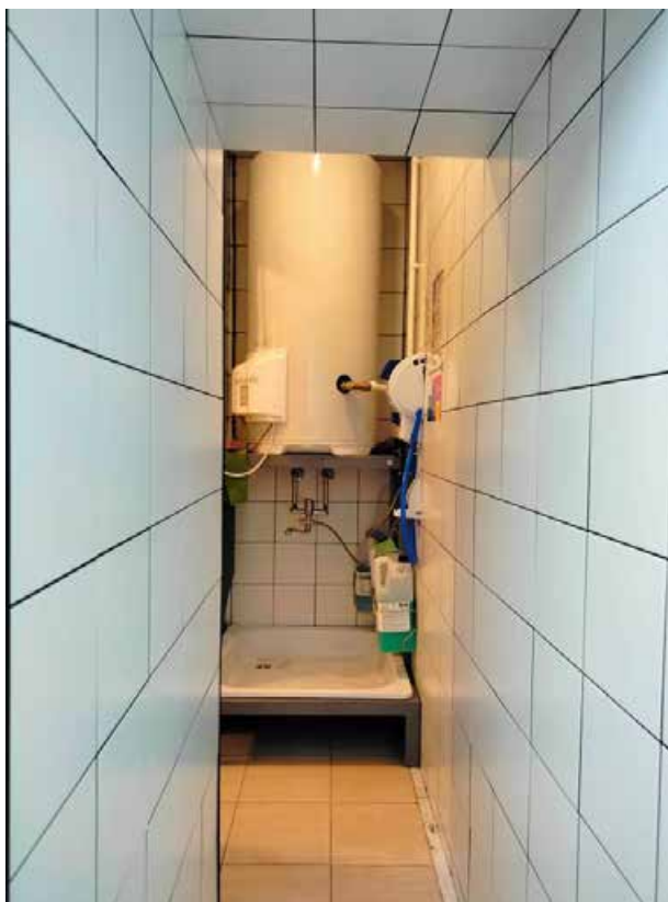
Фото 26. Интерьер пом. 35-Н объекта культурного наследия регионального значения «Дом Страхового Общества «Россия»
