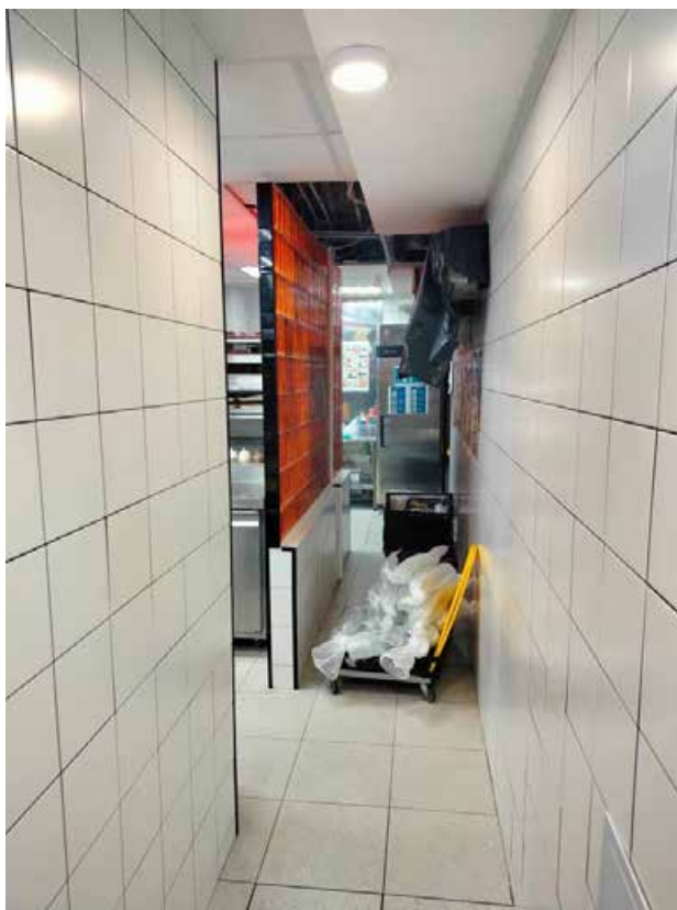
Фото 22. Интерьер пом. 35-Н объекта культурного наследия регионального значения «Дом Страхового Общества «Россия»
