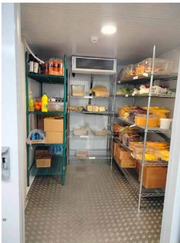
Фото 24. Интерьер пом. 35-Н объекта культурного наследия регионального значения «Дом Страхового Общества «Россия»
