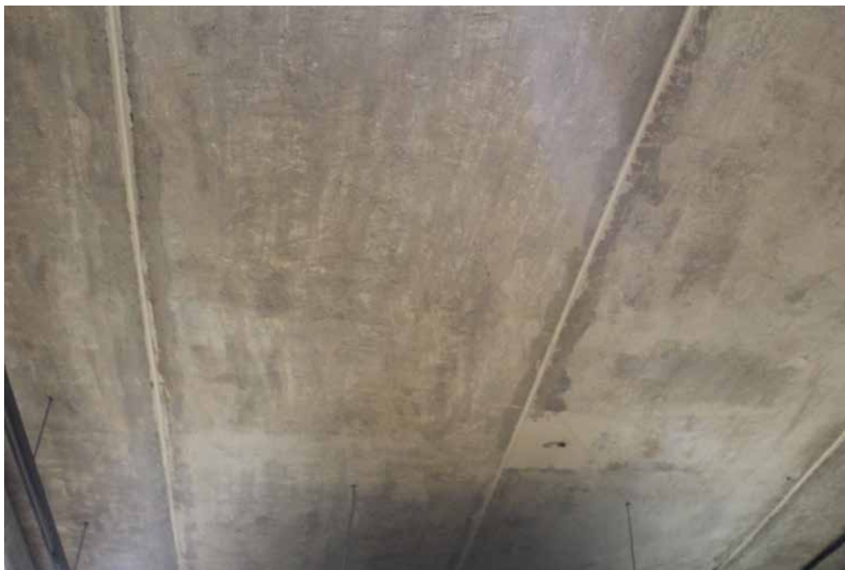
Фото 26. Квартира № 41, вид на потолок в помещении № 8.
