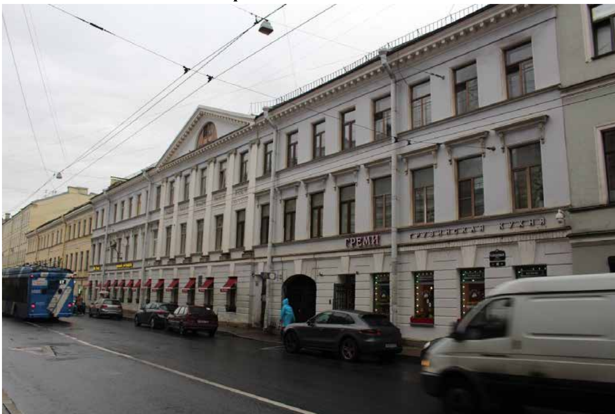
Фото 1. Вид на фасад лицевого корпуса объекта культурного наследия регионального значения «Дом Васильевых» по Гороховой улице.
