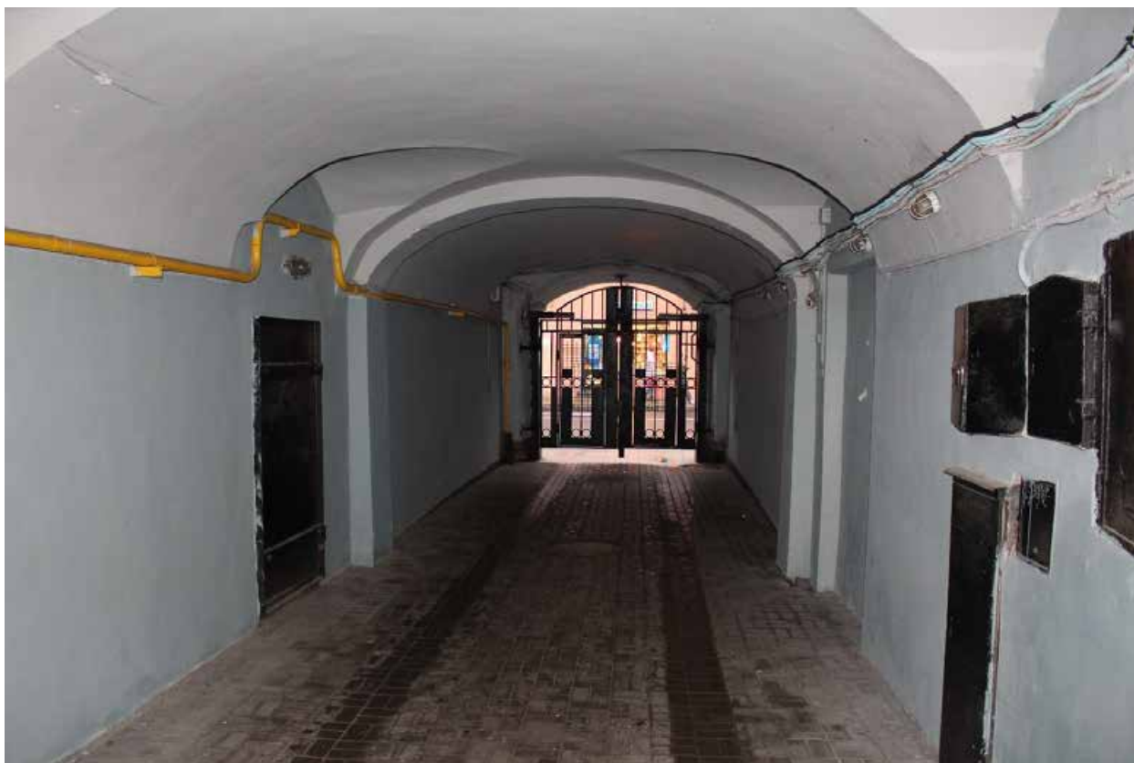
Фото 5. Вид на арку воротного проезда объекта культурного наследия регионального значения «Дом Васильевых».
