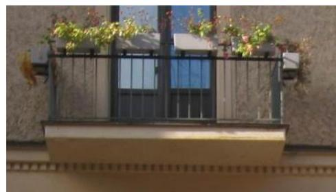
ограждение – вид материала (металл), техника исполнения (ковка), рисунок (вертикальные стойки, в том числе с геометрическим орнаментом);
