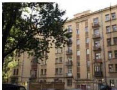
балконы тип и местоположение (прямоугольные – на всех фасадах со второго по шестой этажи), лоджии (юго-восточный и северо-западный фасады), ограждения – материал (металл), техника исполнения (сварка), рисунок (вертикальные прутья, вставка в центре в виде стилизованных колосьев); профилированный край балконной плиты, штукатурная подшивка плиты в виде квадратных кессонов;
