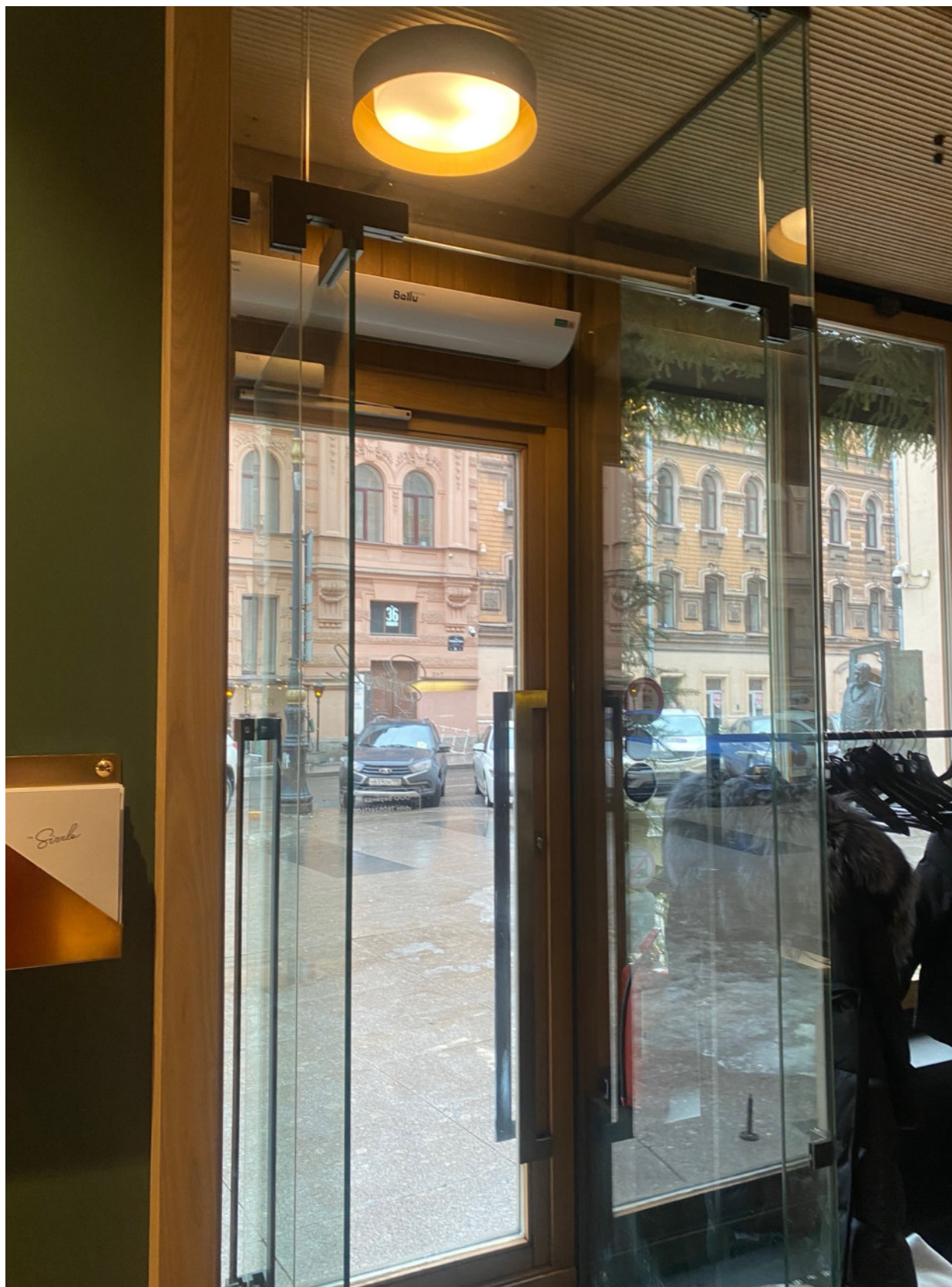
3. Вид на входную дверь в помещение 3-Н;
