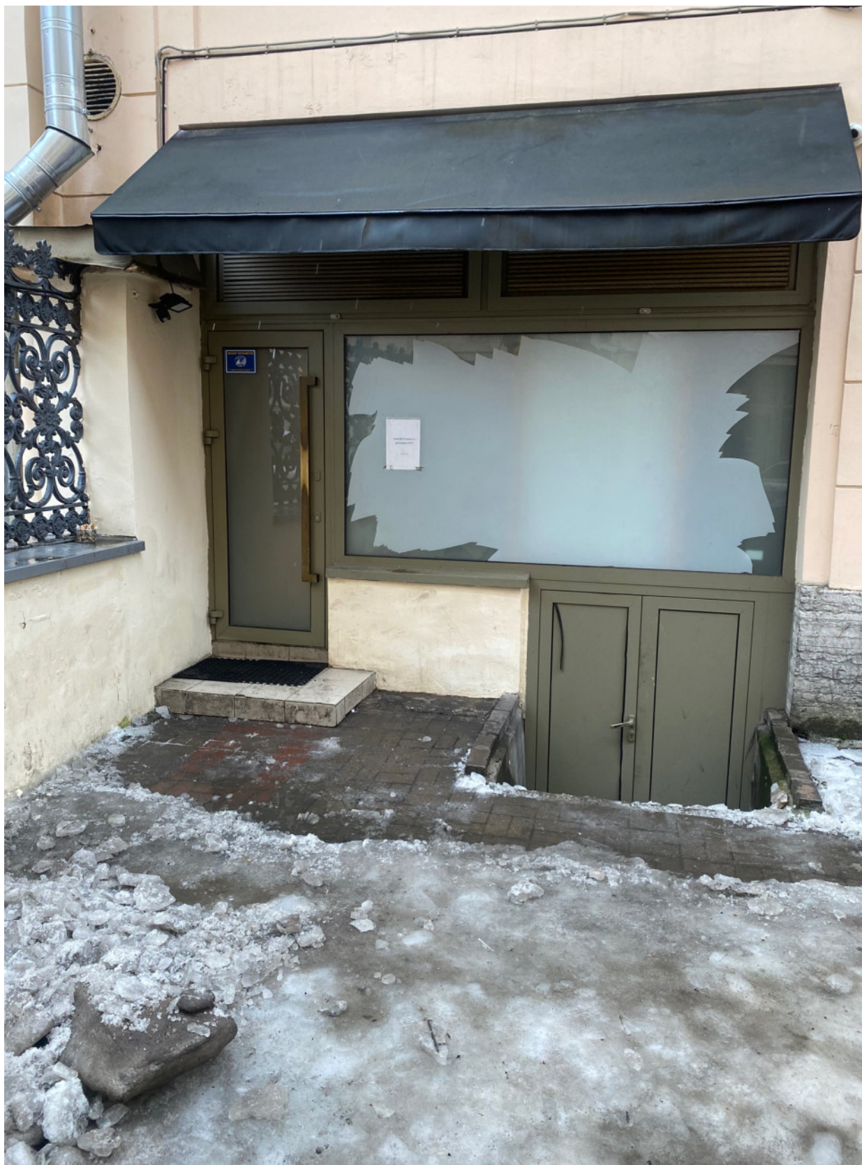
13. Фрагмент дворового фасада.
