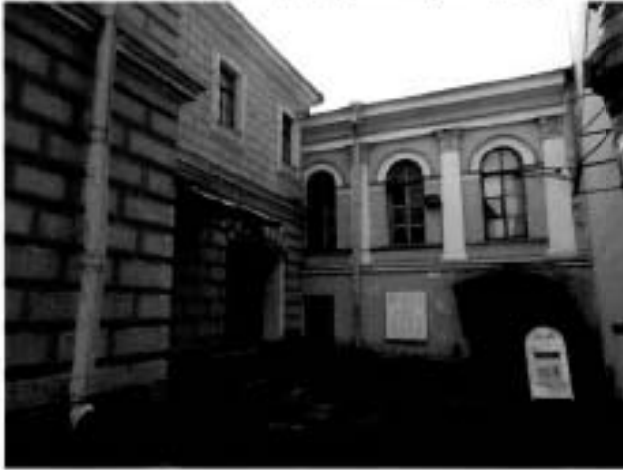
3. Юго-восточный дворовый фасад (флигели)
