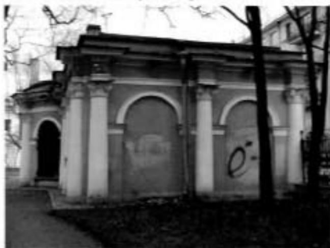
42. Западный дворовый фасад
