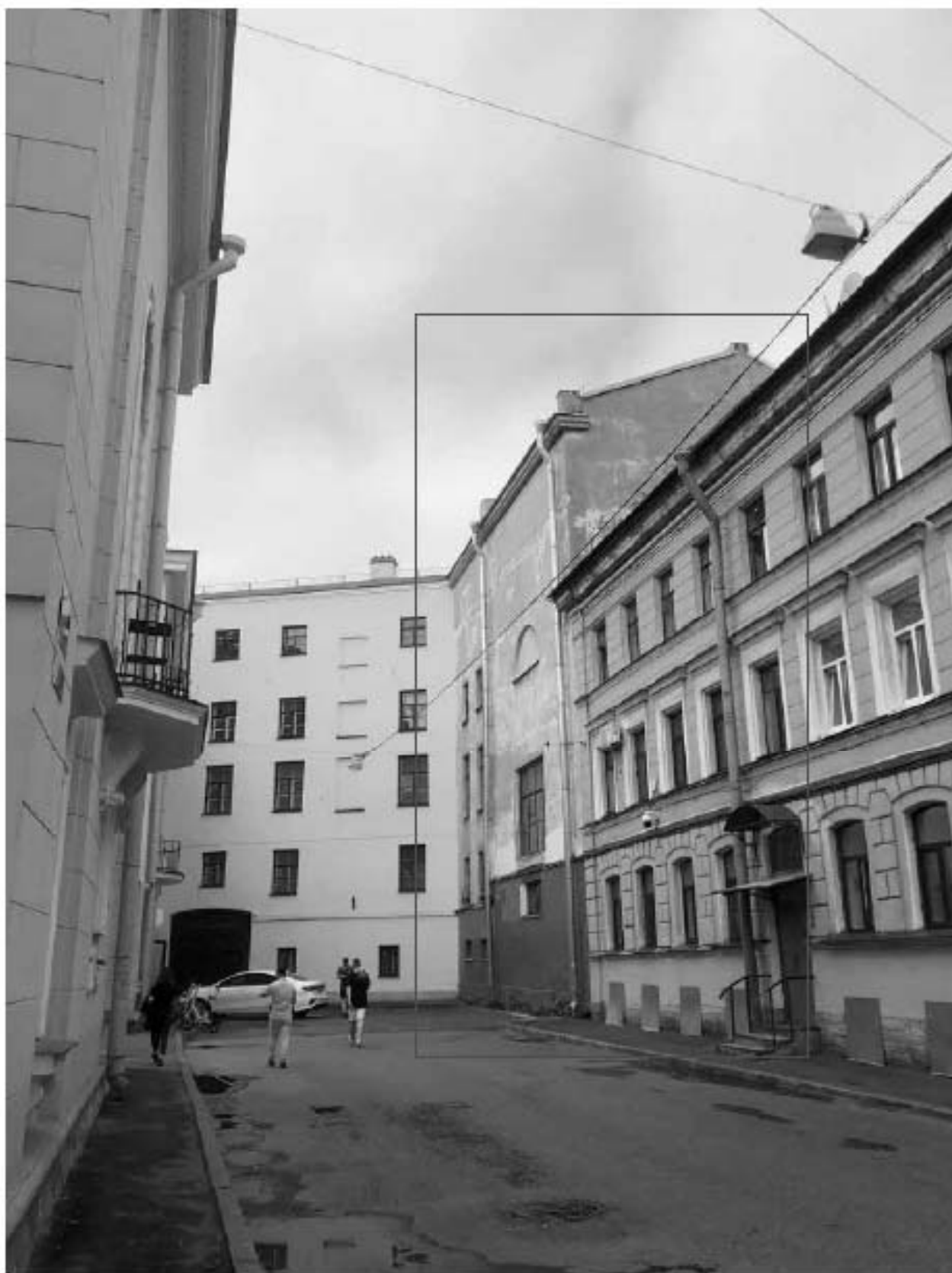
Фото 2. Перспективный вид переулка Пирогова, вид на фасад объекта культурного наследия.
