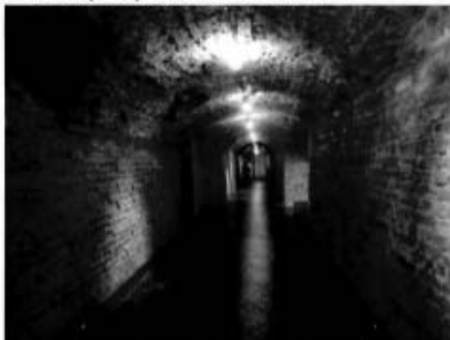
15. Коридор цокольного этажа
