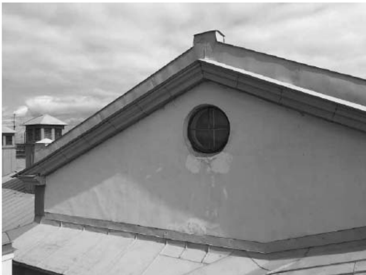
Фото 4. Брандмауэрная стена объекта культурного наследия.
