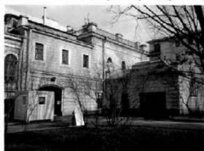
11. Юго-восточный дворовый фасад (флигели)
