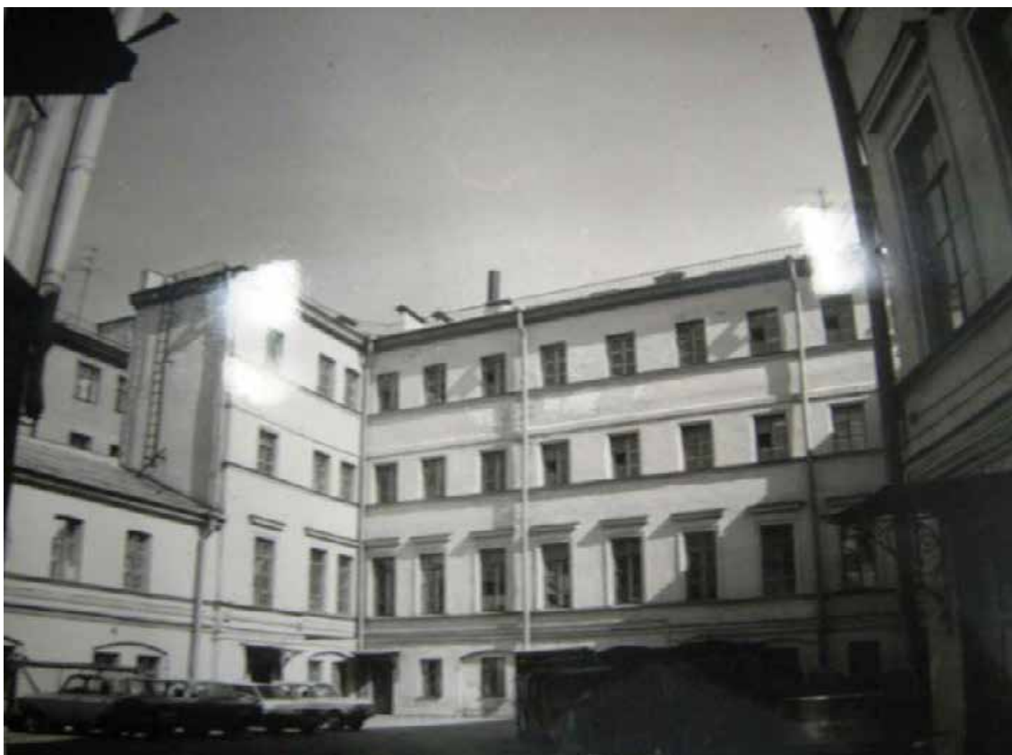
55. -й хозяйственный двор. Вид поперечного флигеля. Фото 1990-х гг. Архив КГИОП.
