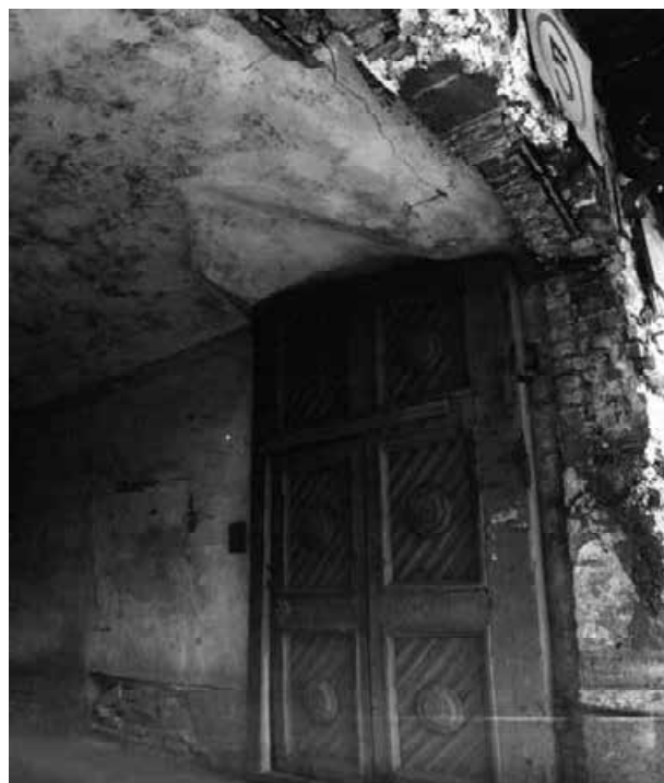
62. Вид на воротную арку. Фото 1991. Архив КГИОП.
