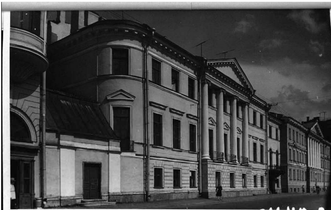
51. Главный (Юго-западный фасад). Фото 1992 г. Архив КГИОП
