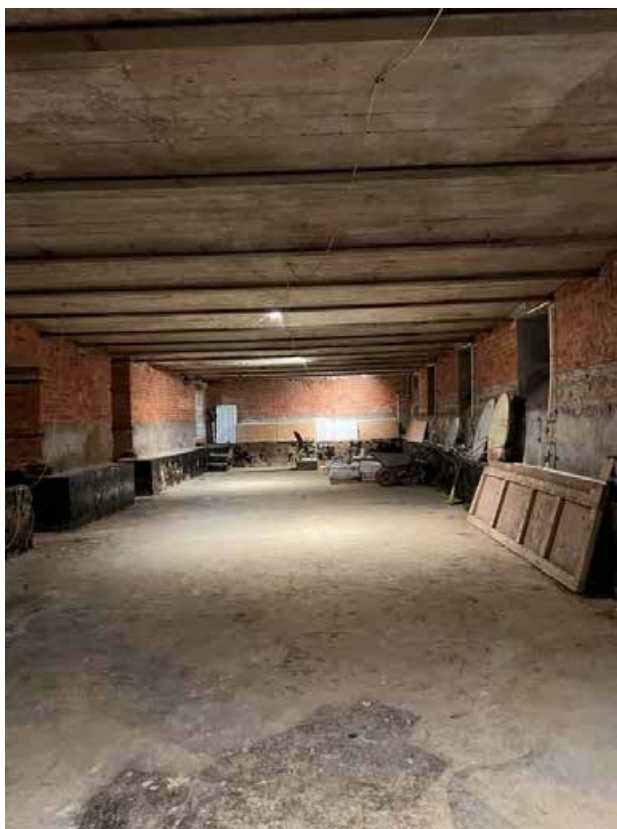
Фото 11. Интерьер пом. 11-Н объекта культурного наследия регионального значения «Дом М.М. Горбова»
