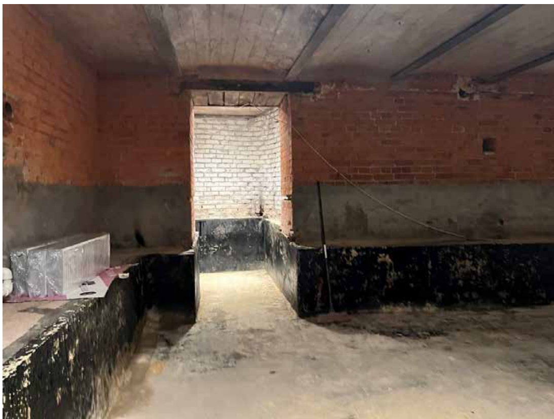
Фото 9. Интерьер пом. 11-Н объекта культурного наследия регионального значения «Дом М.М. Горбова»
