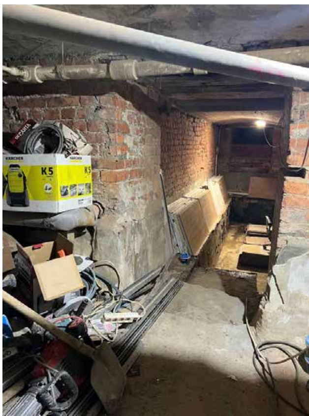
Фото 17. Интерьер пом. 11-Н объекта культурного наследия регионального значения «Дом М.М. Горбова»
