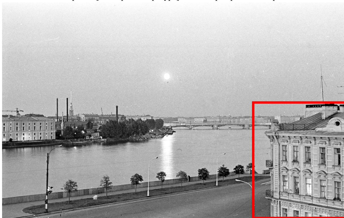
22. Вид на мост Строителей. 1970 - 1975 г. г. — «PastVu» – ретро-фотографии стран и городов [Электронный ресурс]. URL: https://pastvu.com/p/1622143 .
