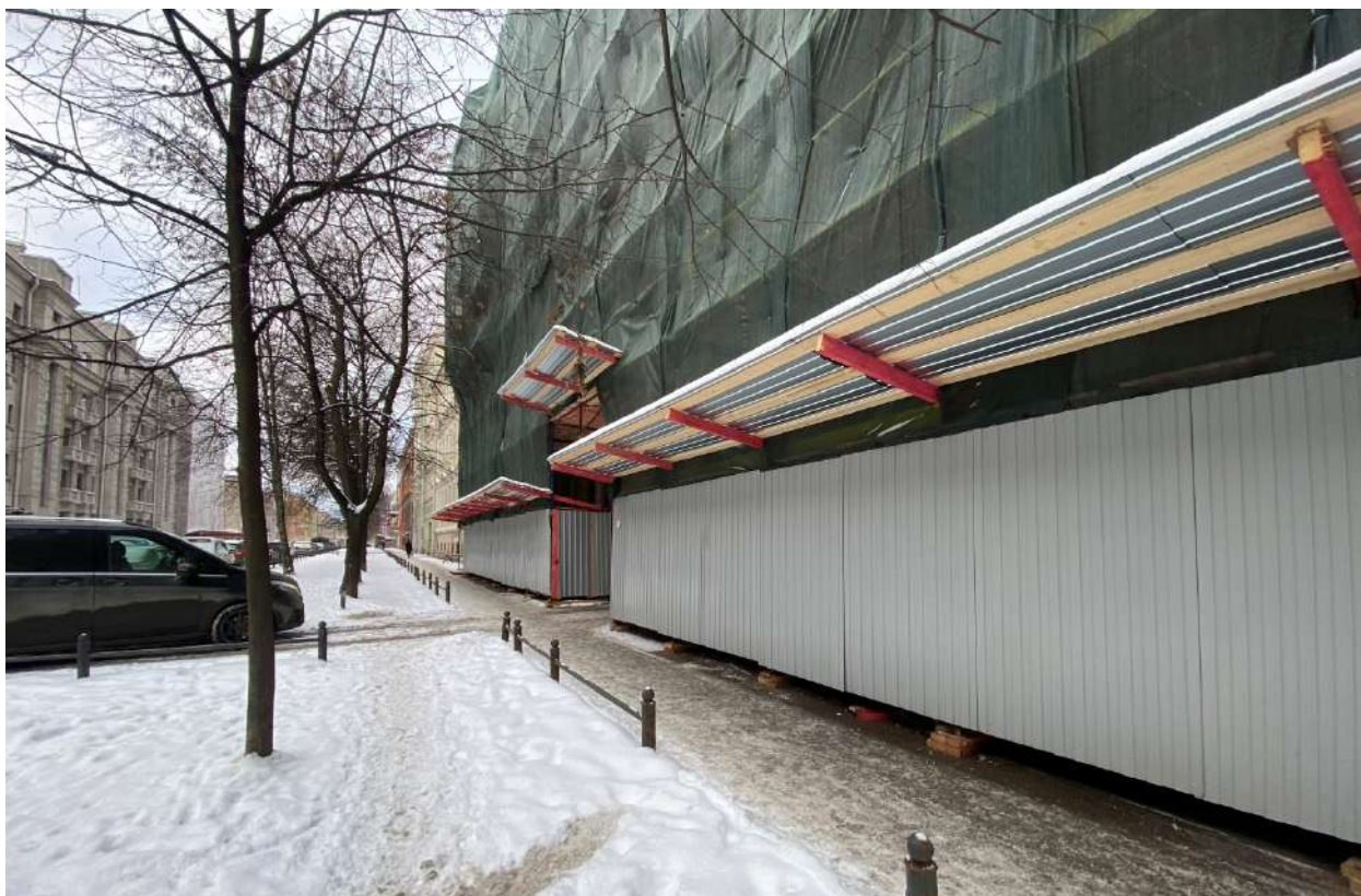
Фото 7. Фрагмент лицевого фасада объекта культурного наследия по 12-й линии В.О.
