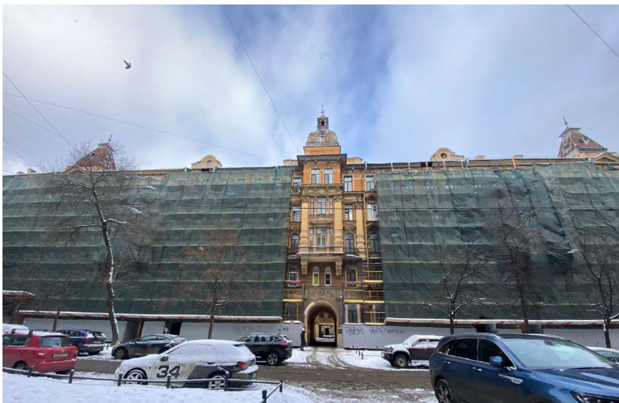
Фото 4. Фрагмент лицевого фасада объекта культурного наследия по 12-й линии В.О.
