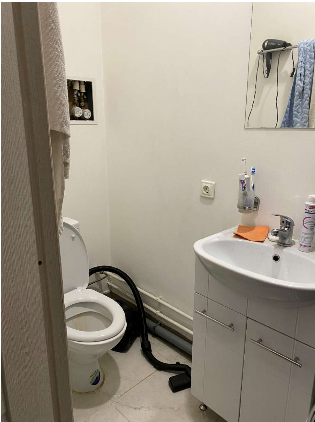
Фото 39. Вид на помещение квартиры № 21 объекта культурного наследия
