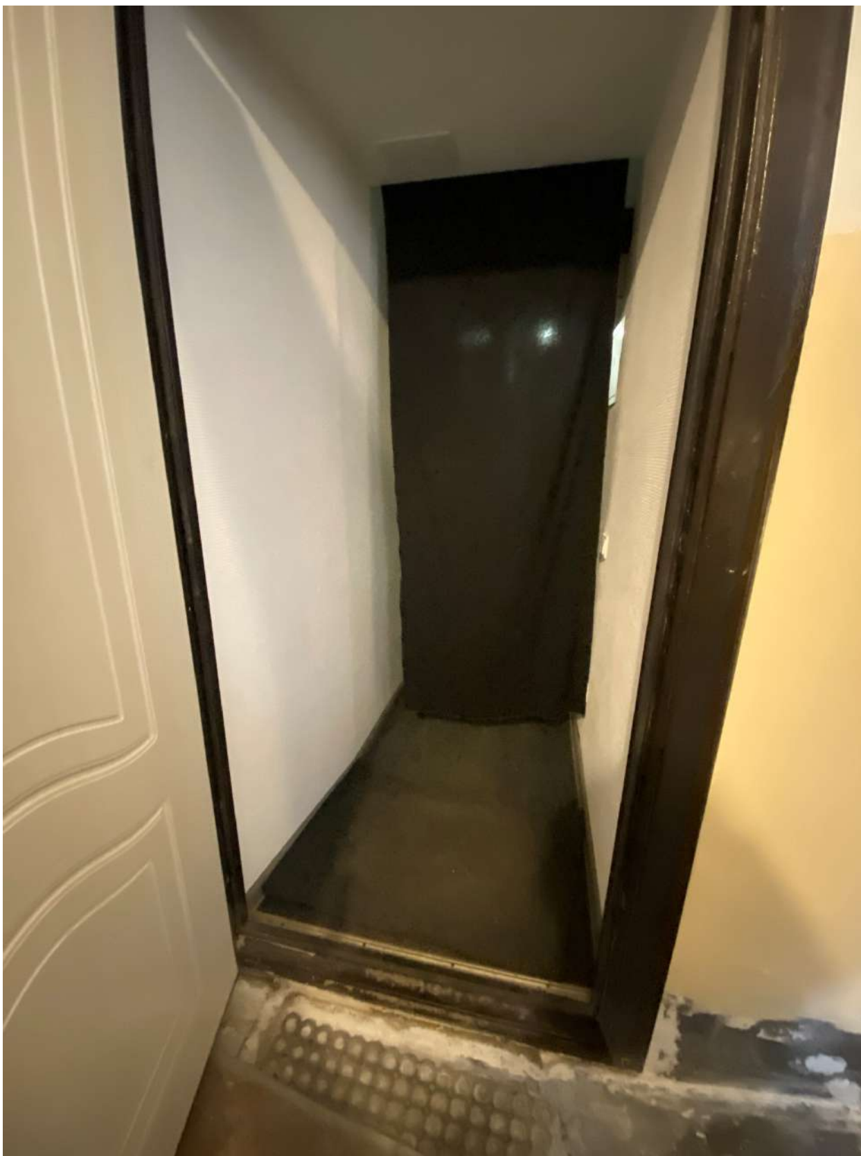
Фото 25. Вид на помещение квартиры № 21 объекта культурного наследия
