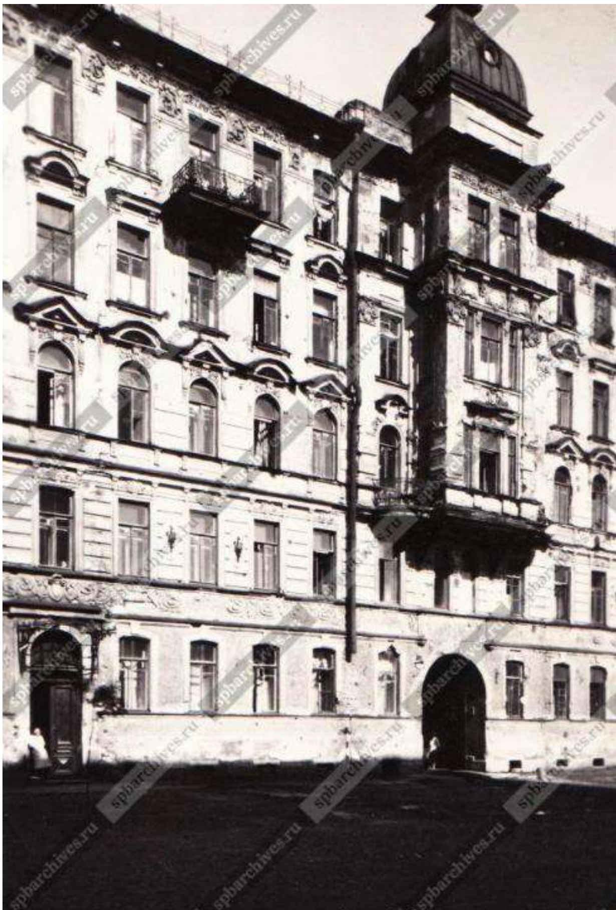
47. Фасад дома на 12-ой линии В.О. № 31 б, 1960 г. – ЦГАКФФД СПб – Фотодокумент Гр 74777
