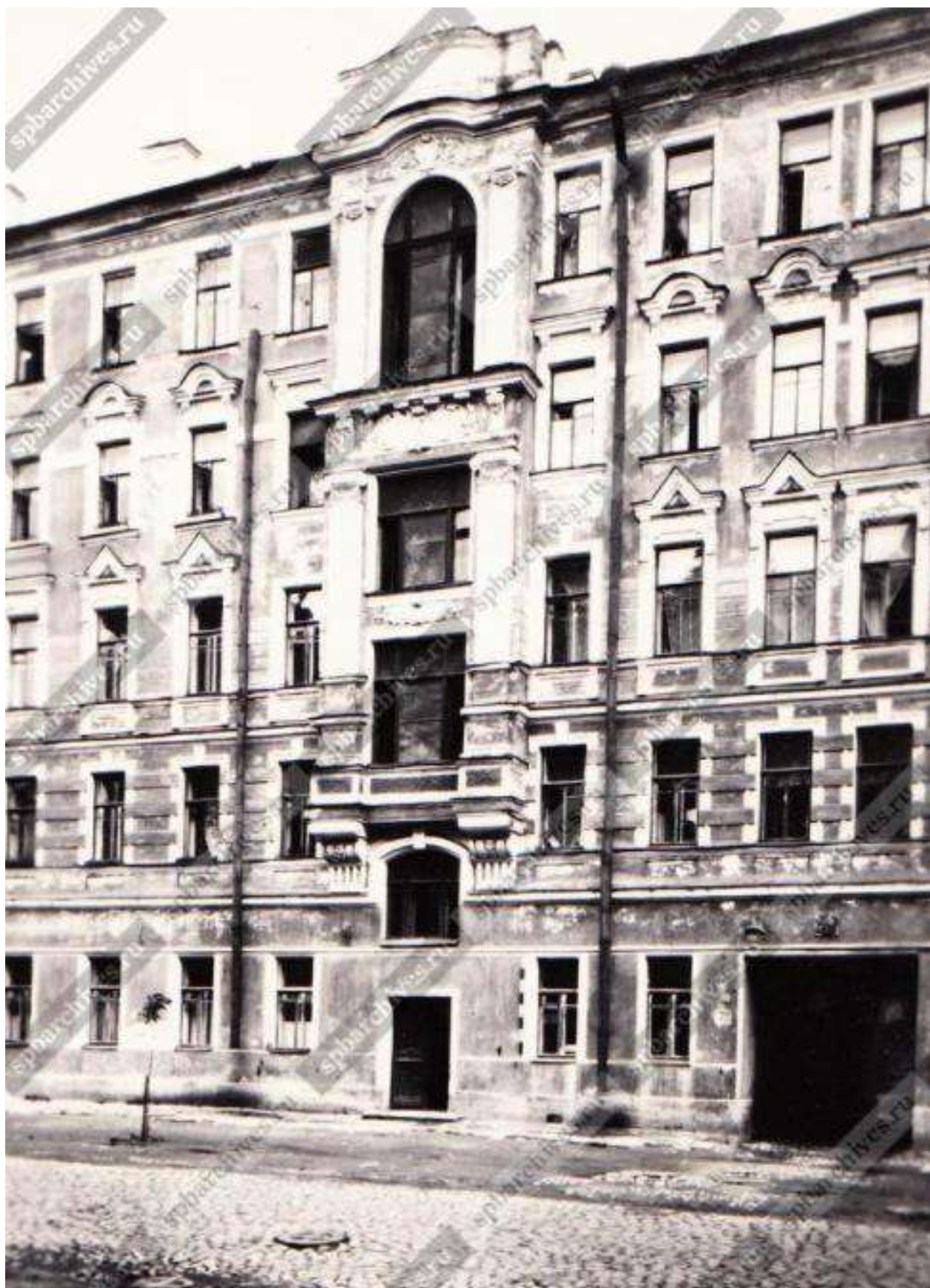
49. Фасад дома на 12-ой линии В.О. № 33, 1960 г. – ЦГАКФФД СПб – Фотодокумент Гр 74779
