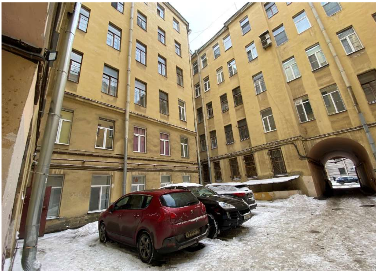
Фото 13. Вид на часть дворовых фасадов объекта культурного наследия
