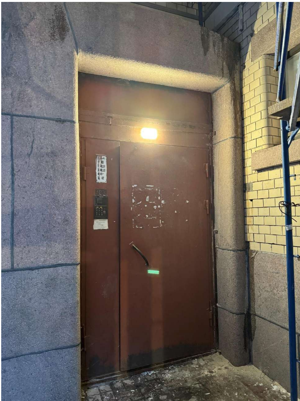
Фото 10. Вид на вход в парадную, ведущую в квартиру 63, объекта культурного наследия.
