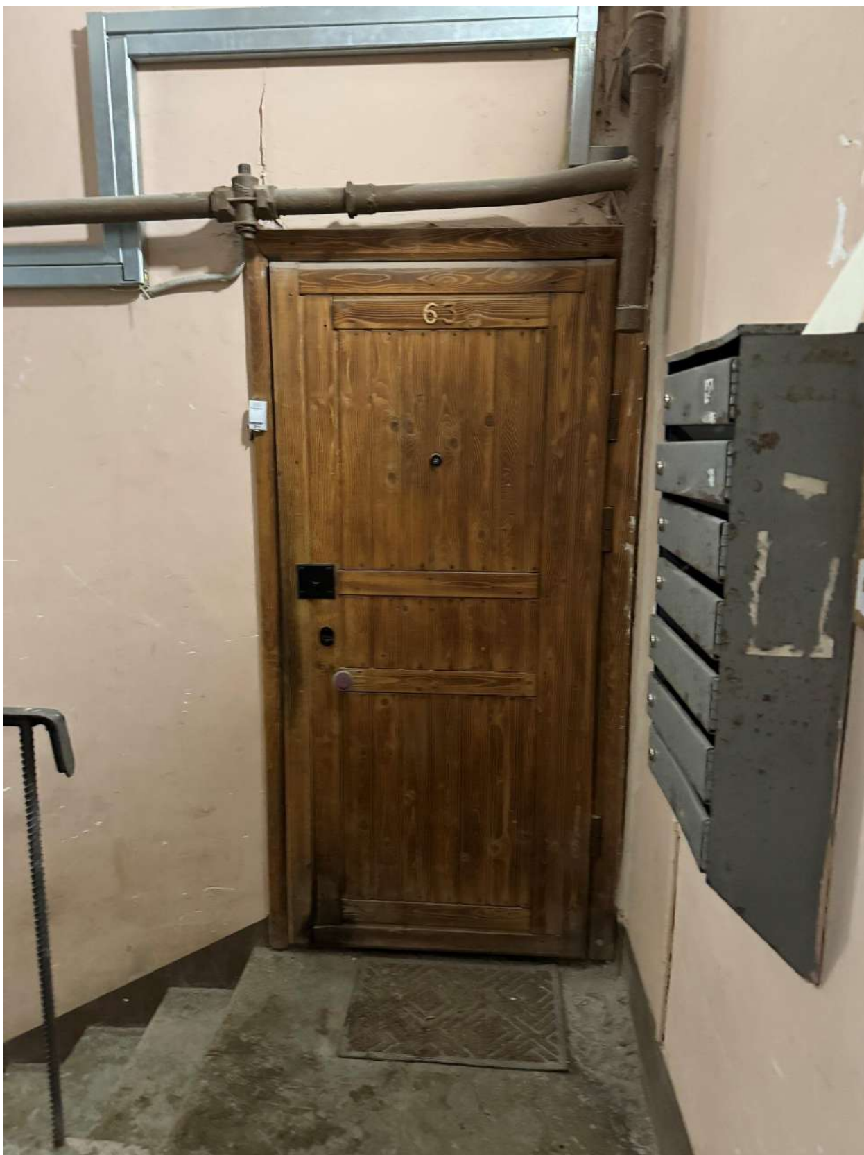
Фото 14. Дверное заполнение, ведущее в квартиру 63, объекта культурного наследия.
