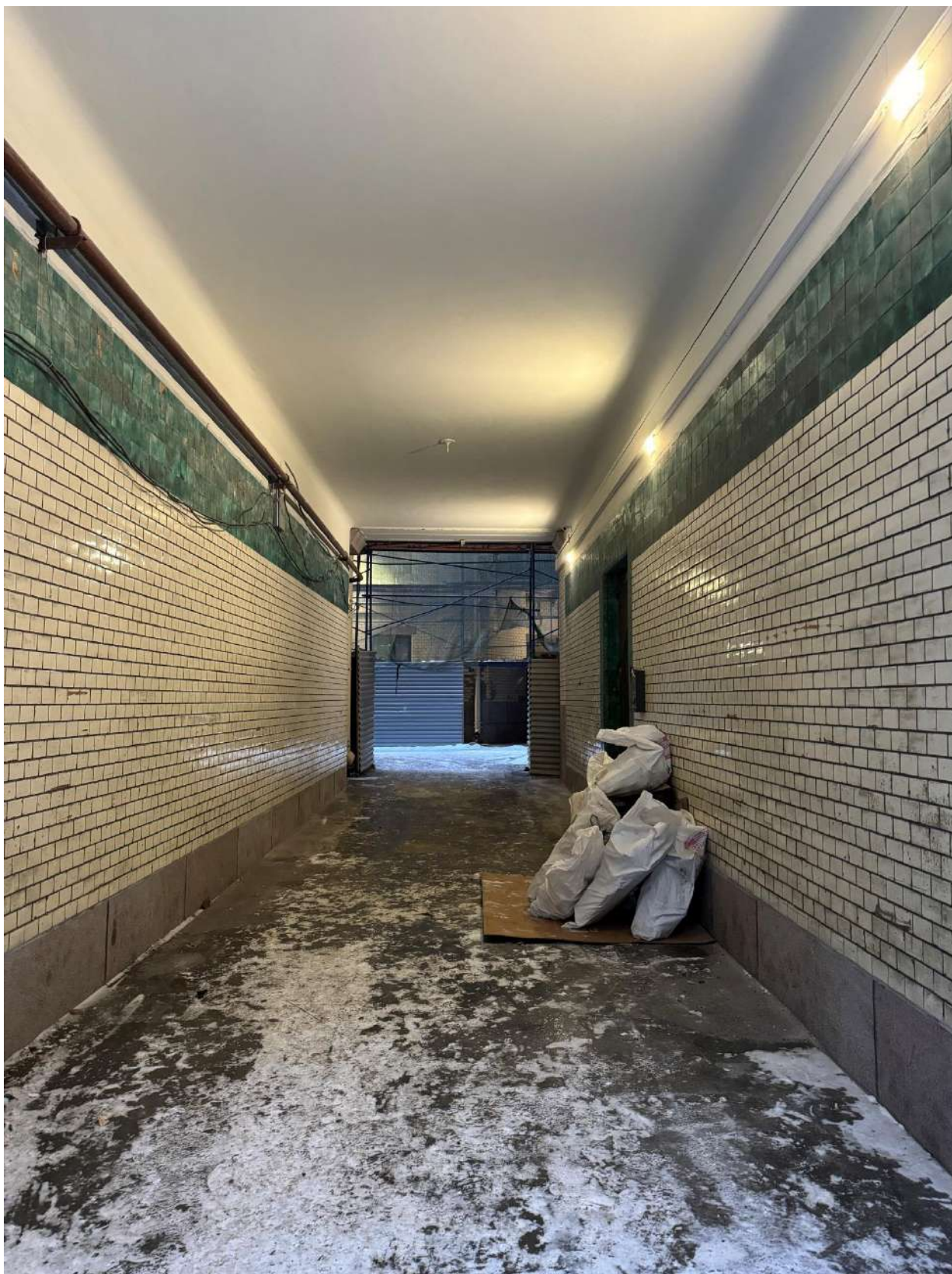
Фото 7. Арка проезда между вторым и третьим дворами объекта культурного наследия.
