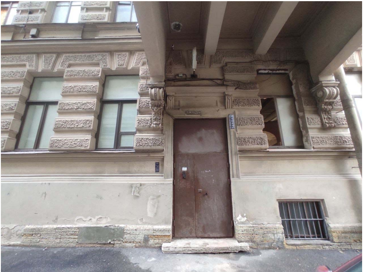
Фото 8. Восточный фасад, вход.
