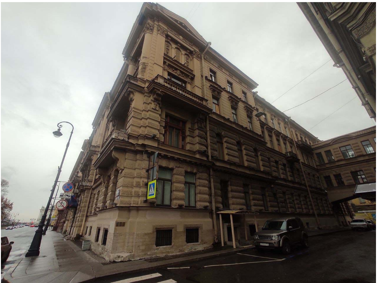
Фото 3. Восточный фасад, общий вид.
