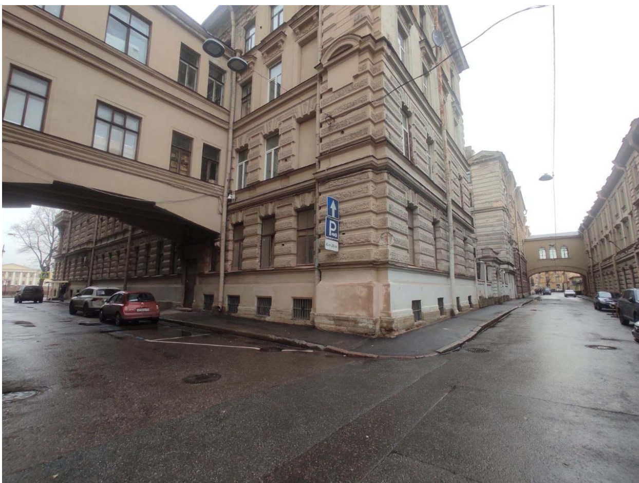
Фото 5. Угол северного и восточного фасадов.
