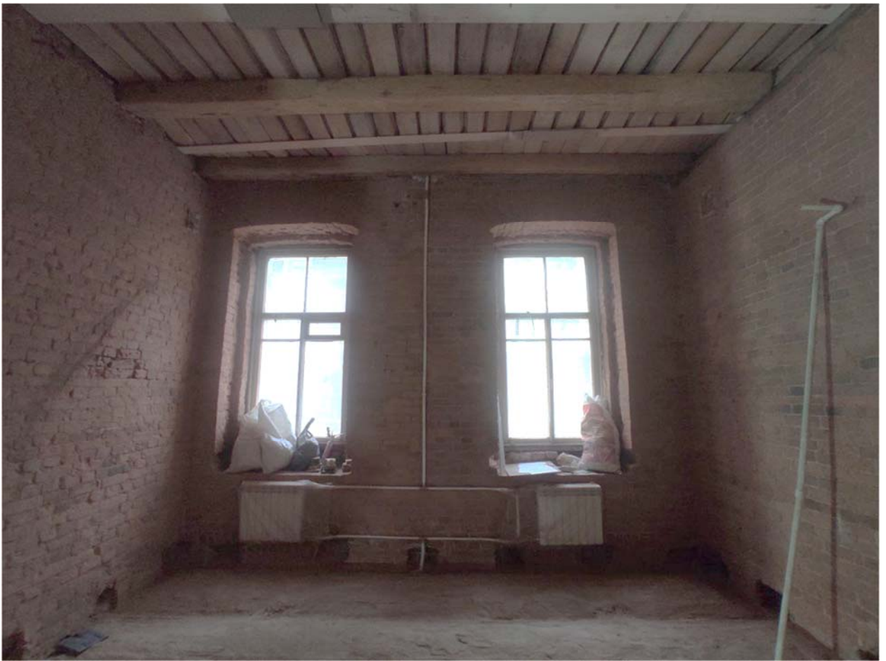
Фото 17. Квартира №13, помещение 5 (по ПИБ), перегородки демонтированы.
