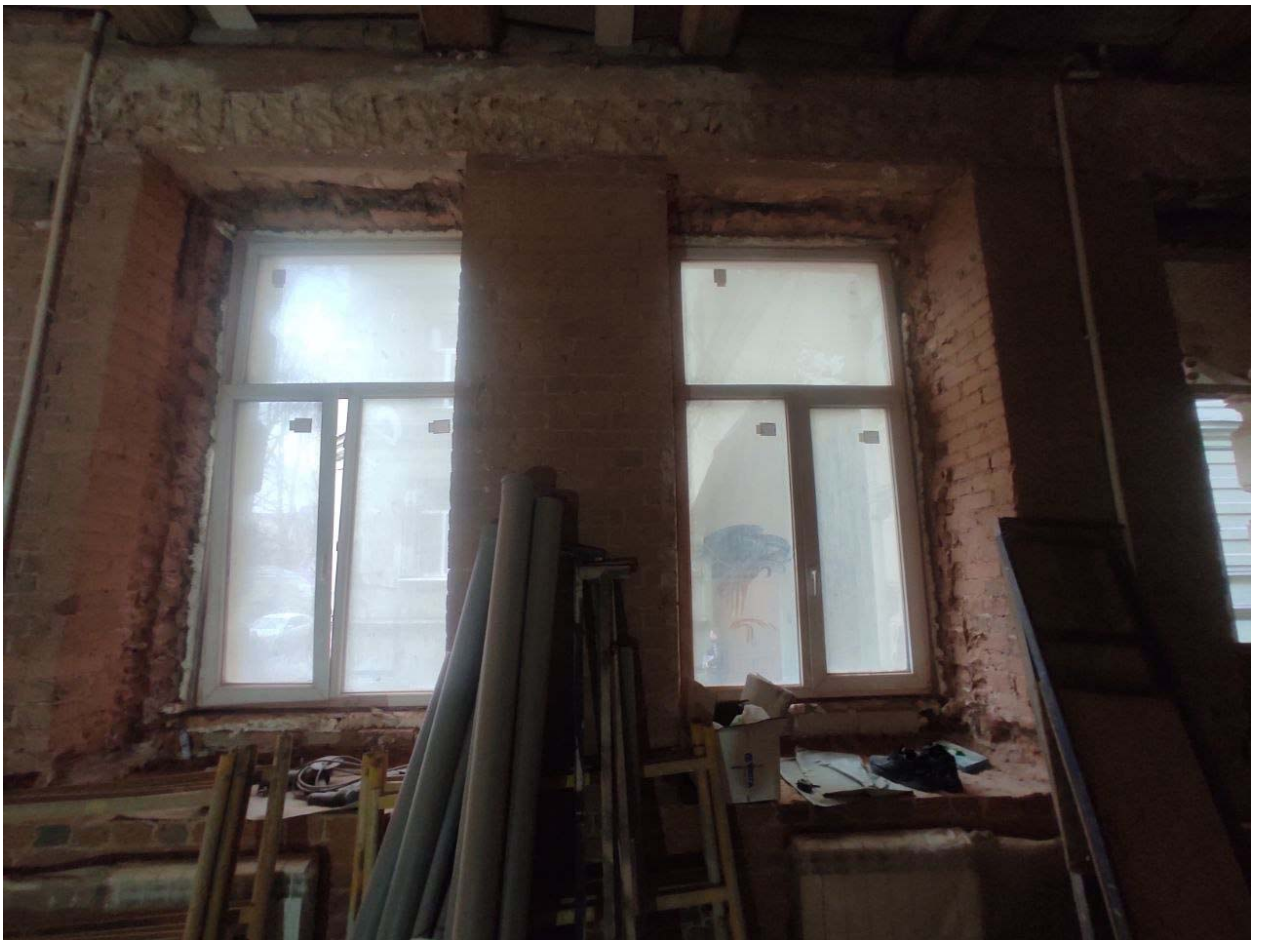
Фото 20. Квартира №13, помещение 6 (по ПИБ), перегородки демонтированы.
