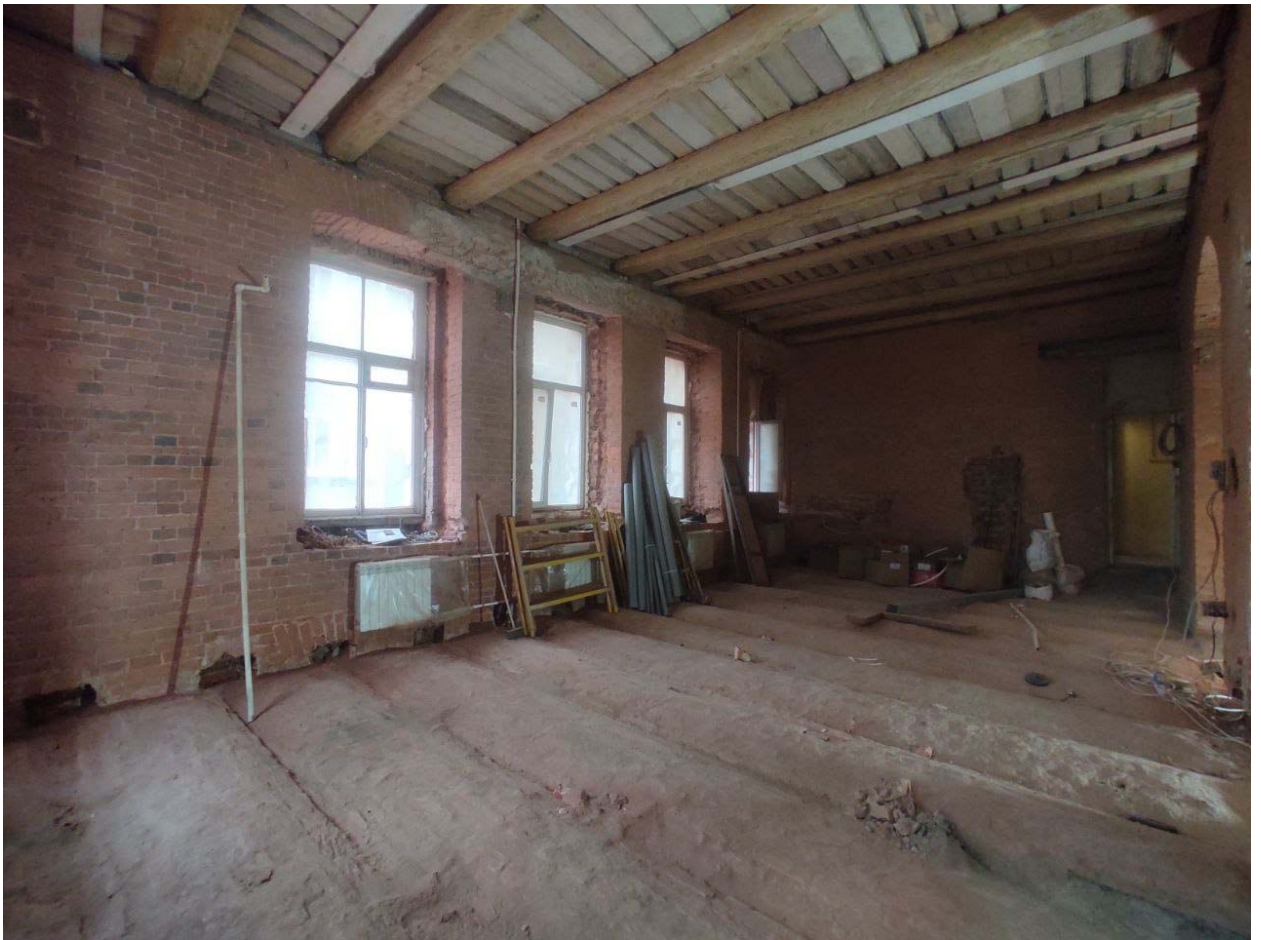
Фото 15. Квартира №13, помещения 1, 5, 6, 7 (по ПИБ), перегородки демонтированы.
