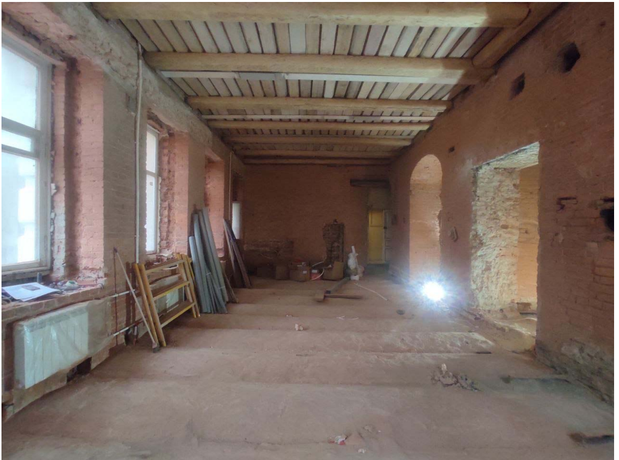
Фото 12. Квартира №13, помещения 1, 5, 6, 7 (по ПИБ), перегородки демонтированы.
