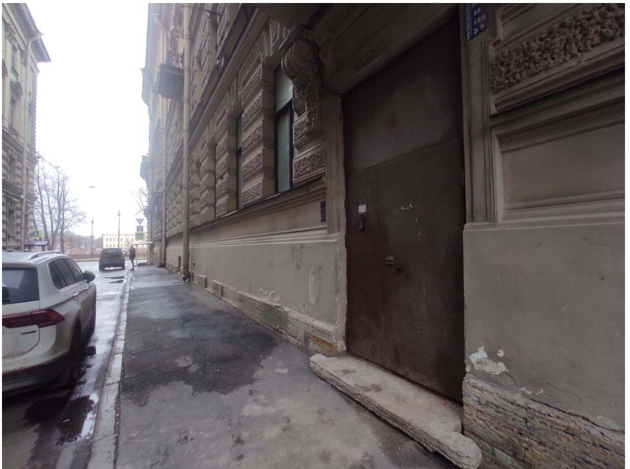
Фото 7. Восточный фасад, вход.
