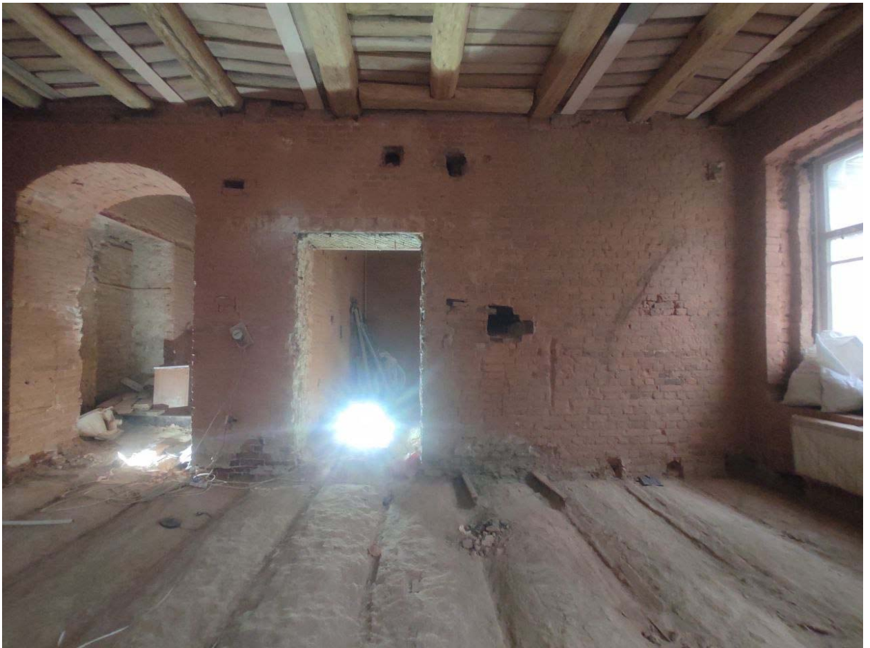
Фото 14. Квартира №13, помещения 1, 5, 6, 7 (по ПИБ), перегородки демонтированы.
