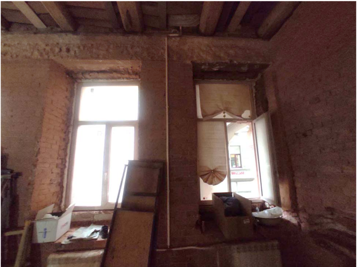
Фото 21. Квартира №13, помещение 6, 7 (по ПИБ), перегородки демонтированы.
