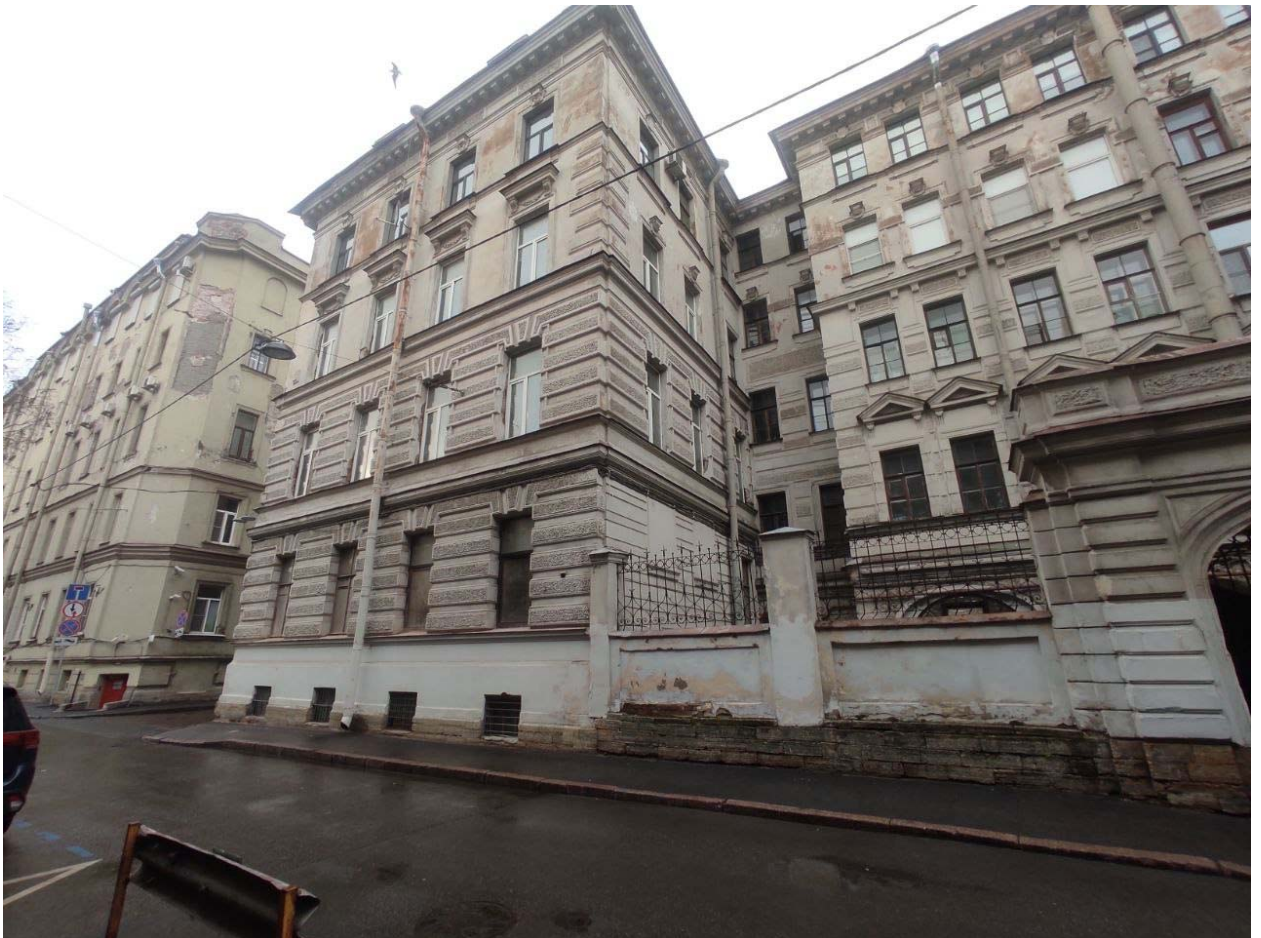
Фото 4. Северный фасад, фрагмент.
