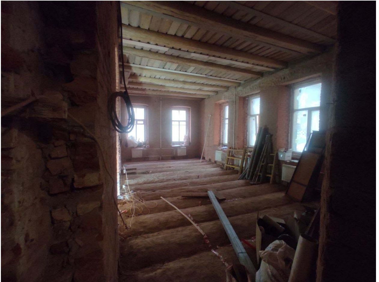
Фото 11. Квартира №13, помещения 1, 5, 6, 7 (по ПИБ), перегородки демонтированы.
