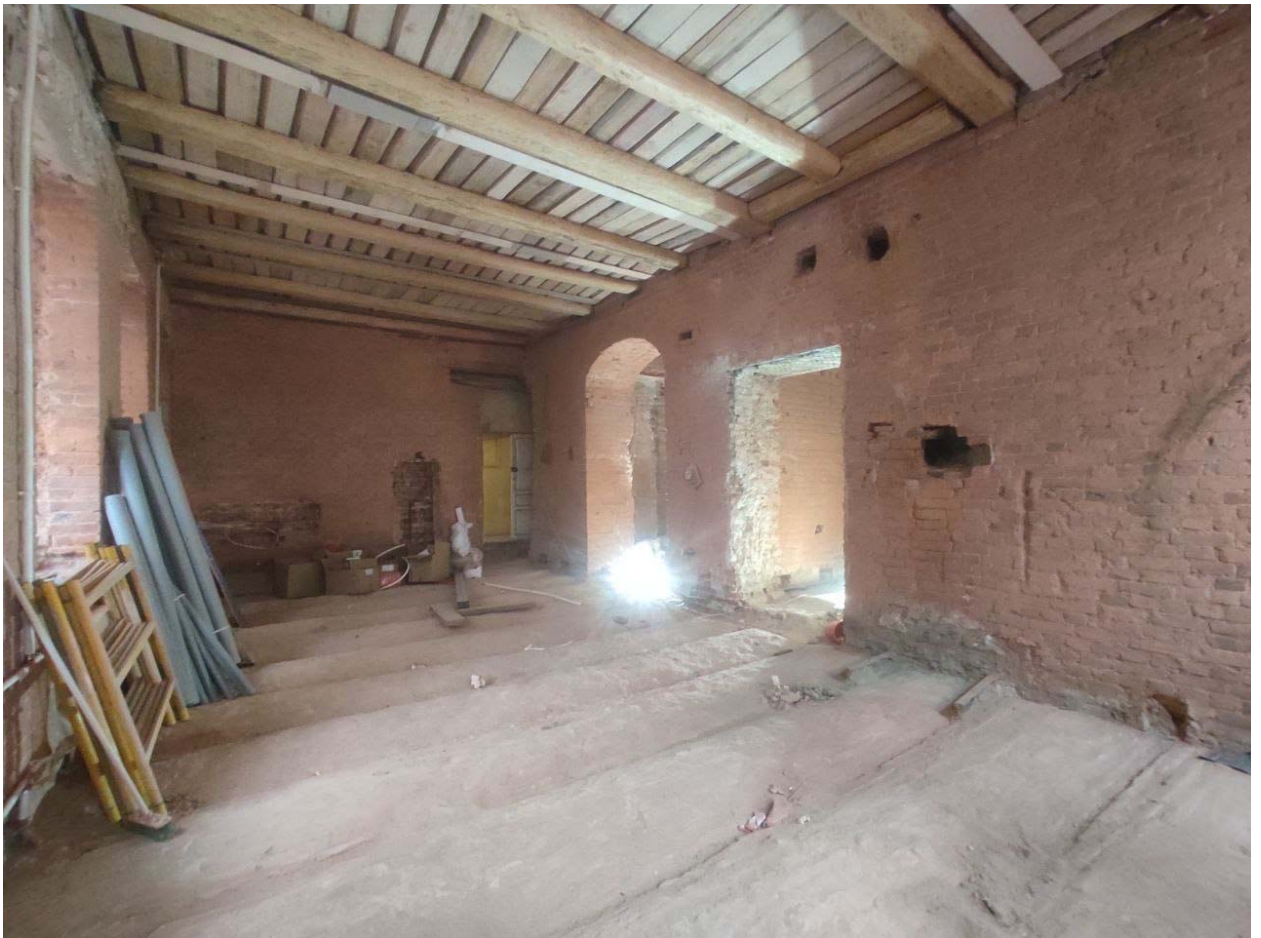
Фото 16. Квартира №13, помещения 1, 5, 6, 7 (по ПИБ), перегородки демонтированы.
