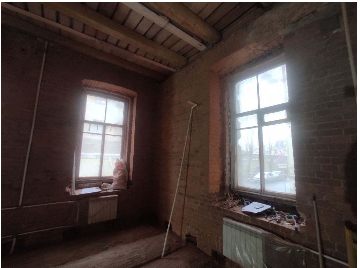
Фото 18. Квартира №13, помещение 5 (по ПИБ), перегородки демонтированы.
