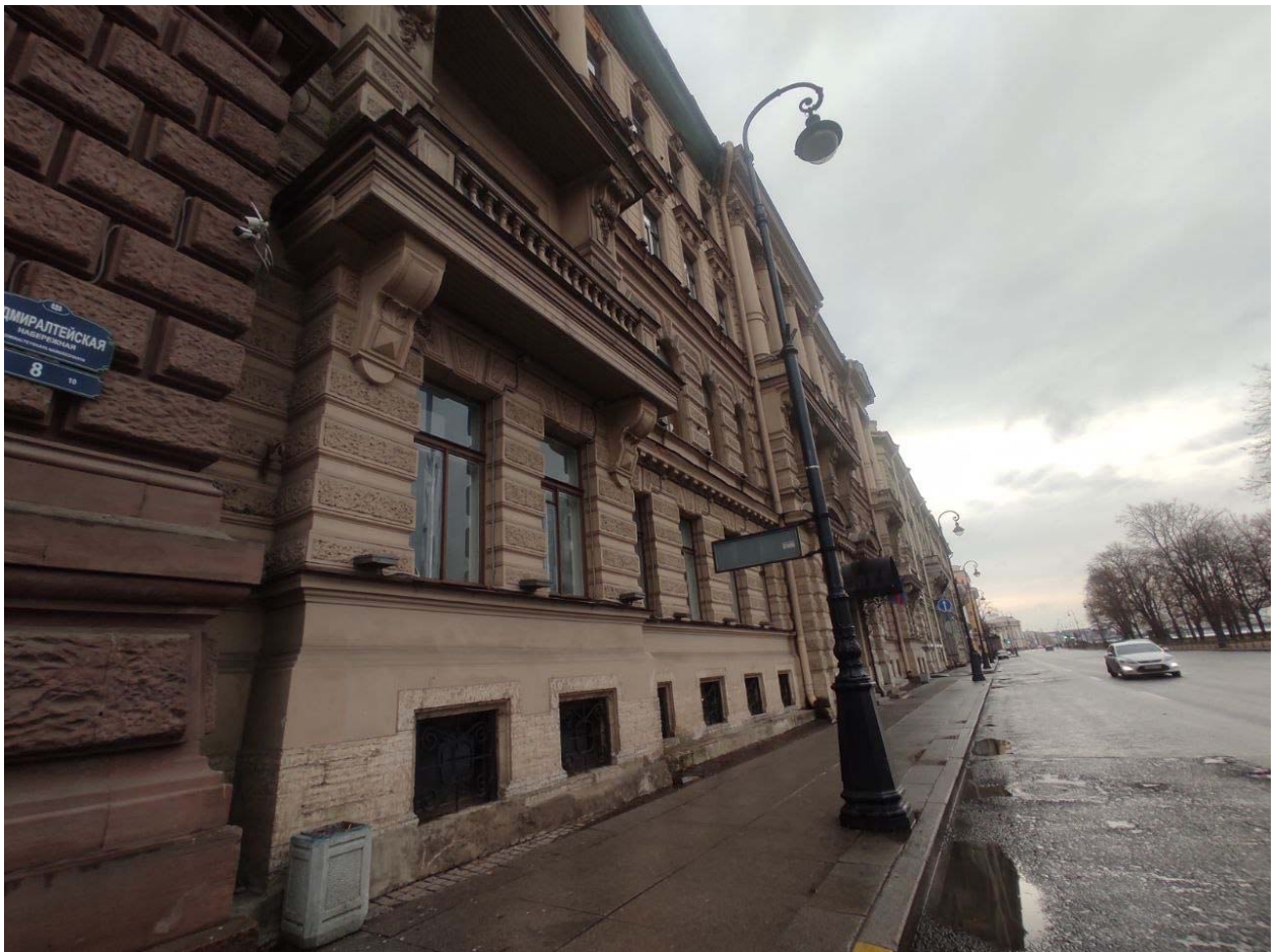
Фото 6. Южный фасад, общий вид.
