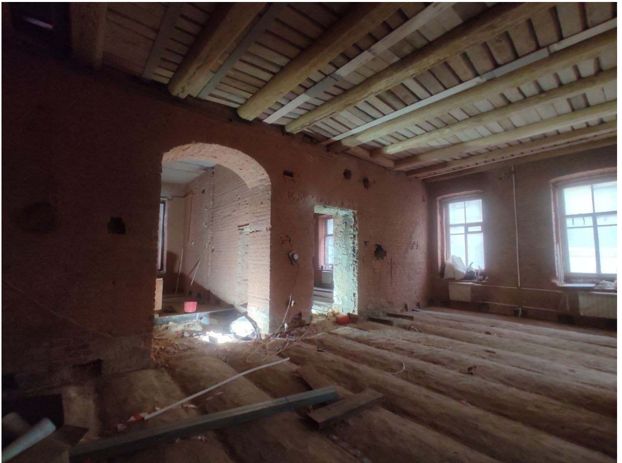
Фото 13. Квартира №13, помещения 1, 5, 6, 7 (по ПИБ), перегородки демонтированы.
