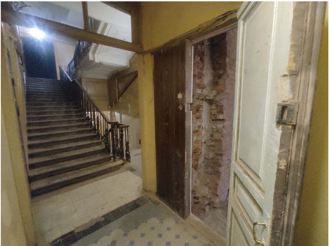
Фото 10. 1 этаж, лестница 4-ЛК, вход в квартиру №13.
