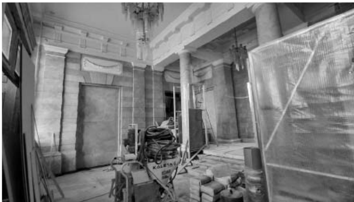
5. Фрагмент интерьера вестибюля (помещение №1.2);
