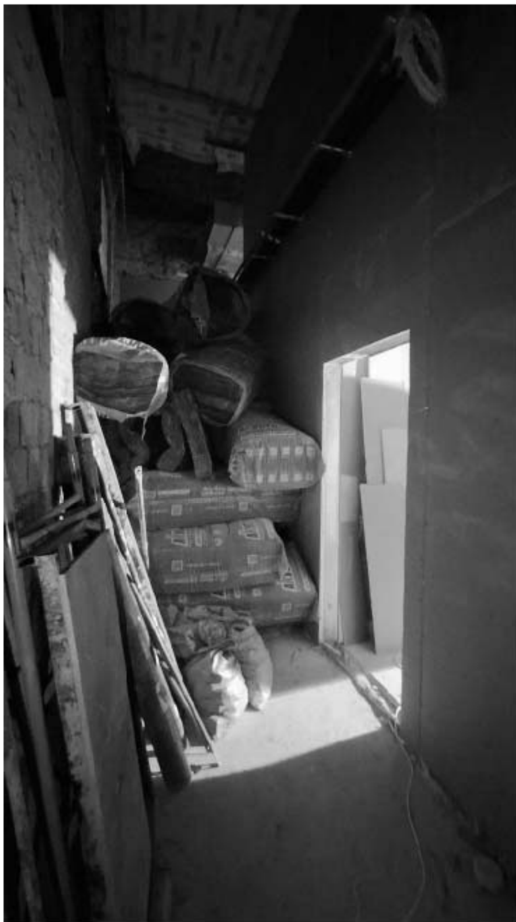
16. Фрагмент интерьера коридора (помещение 1.13);
