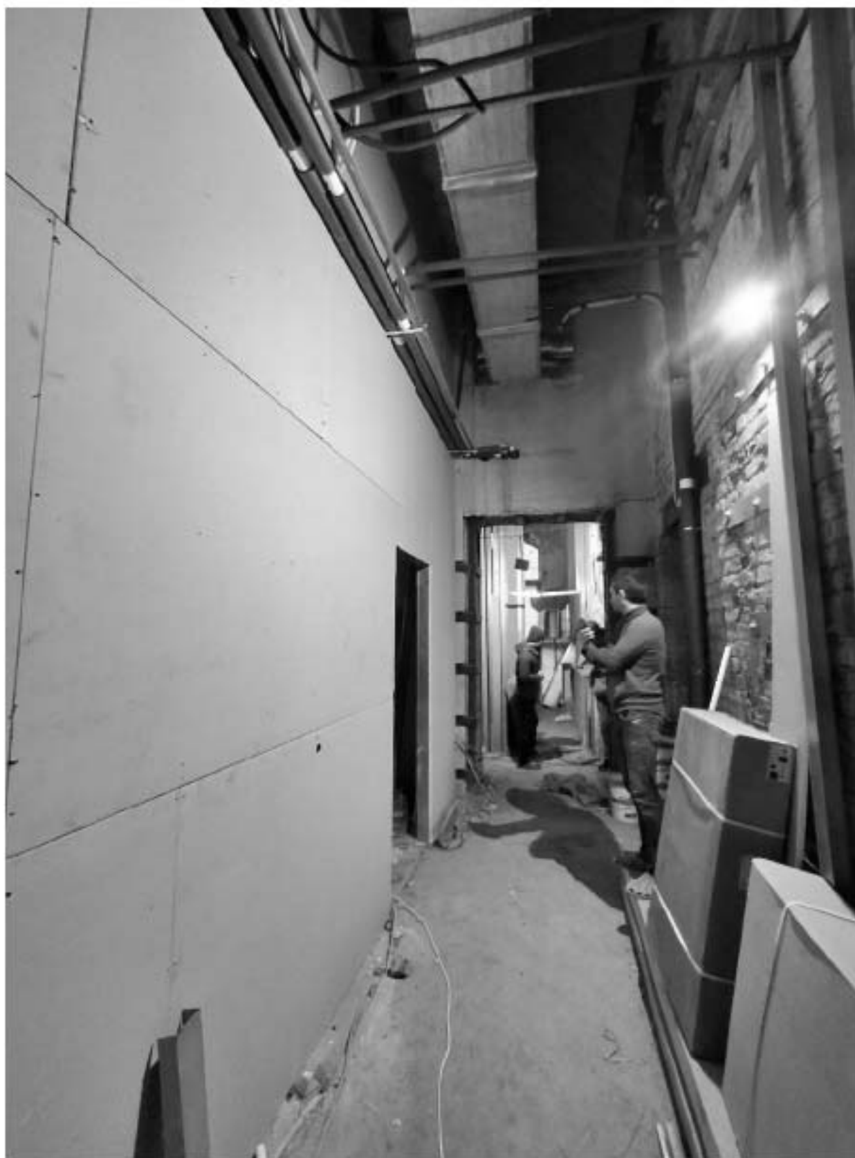
25. Фрагмент интеръера коридора (помещение 1.17);
