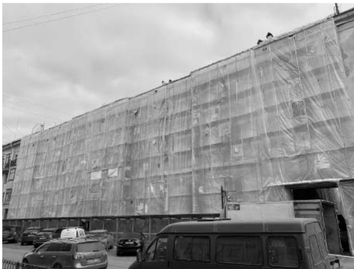
2. Вид на главный фасад объекта культурного наследия регионального значения «Особняк А.П. Шувалова (Е.А. Воронцовой-Дашковой)»;
