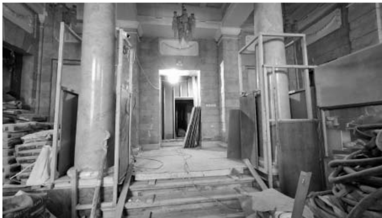
7. Фрагмент интерьера вестибюля (помещение №1.2);
