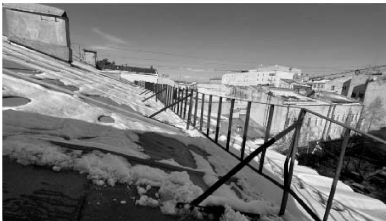
6. Вид на крышу
