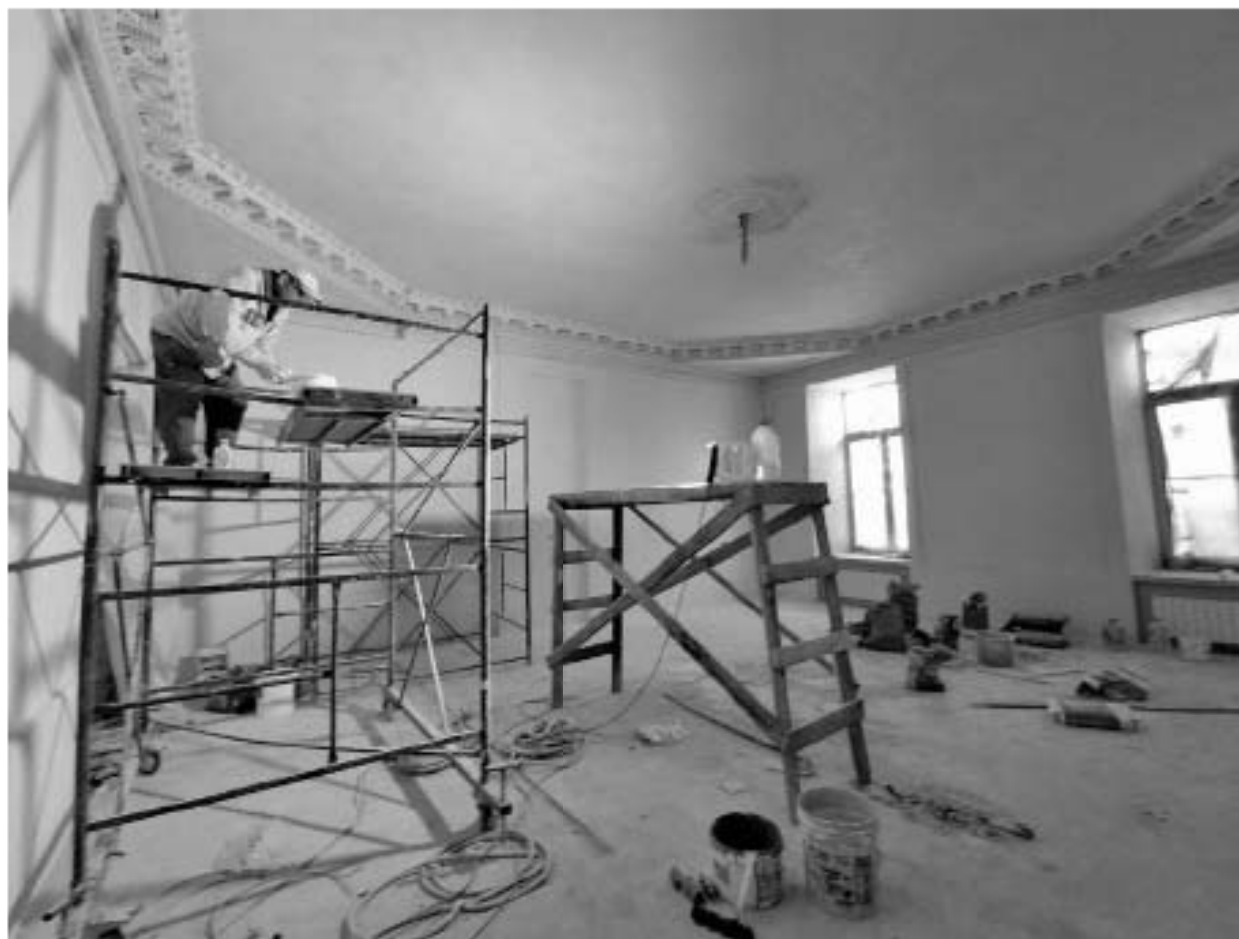
40. Фрагмент интерьера помещения 2.б;
