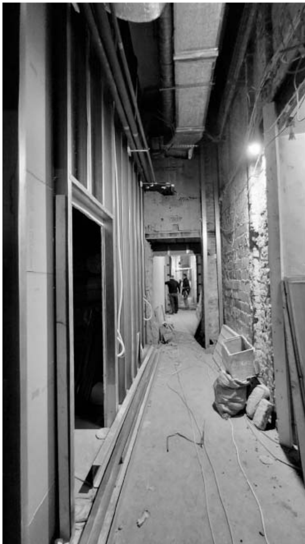
12. Фрагмент интеръера коридора (помещение 1.15);
