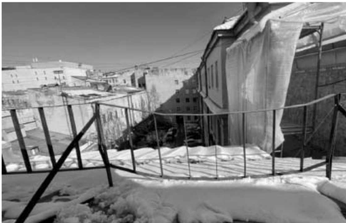
5. Вид на крышу
