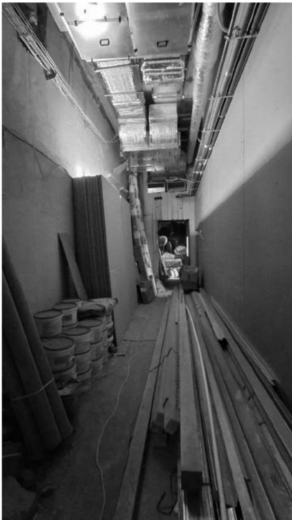
14. Фрагмент интеръера коридора (помещение 1.13);
