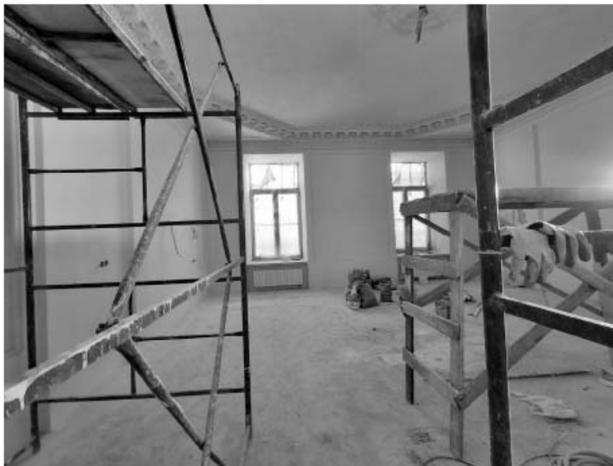
39. Фрагмент интерьера помещения 2.б;
