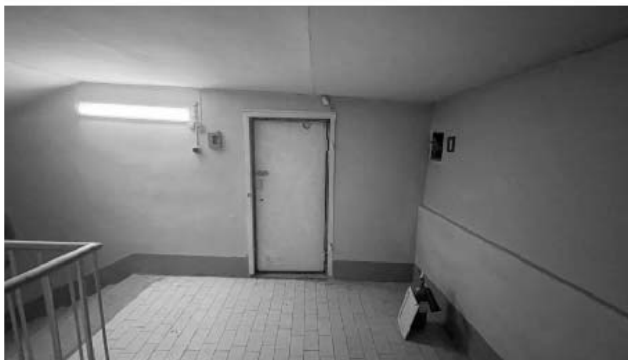
8. Вход на технический этаж;
