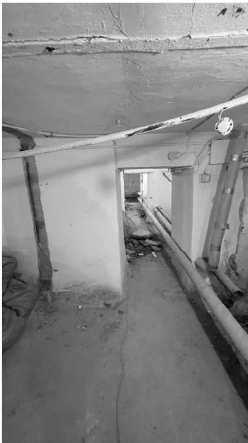
5. Фрагмент интерьера коридора (помещение 0.6);
