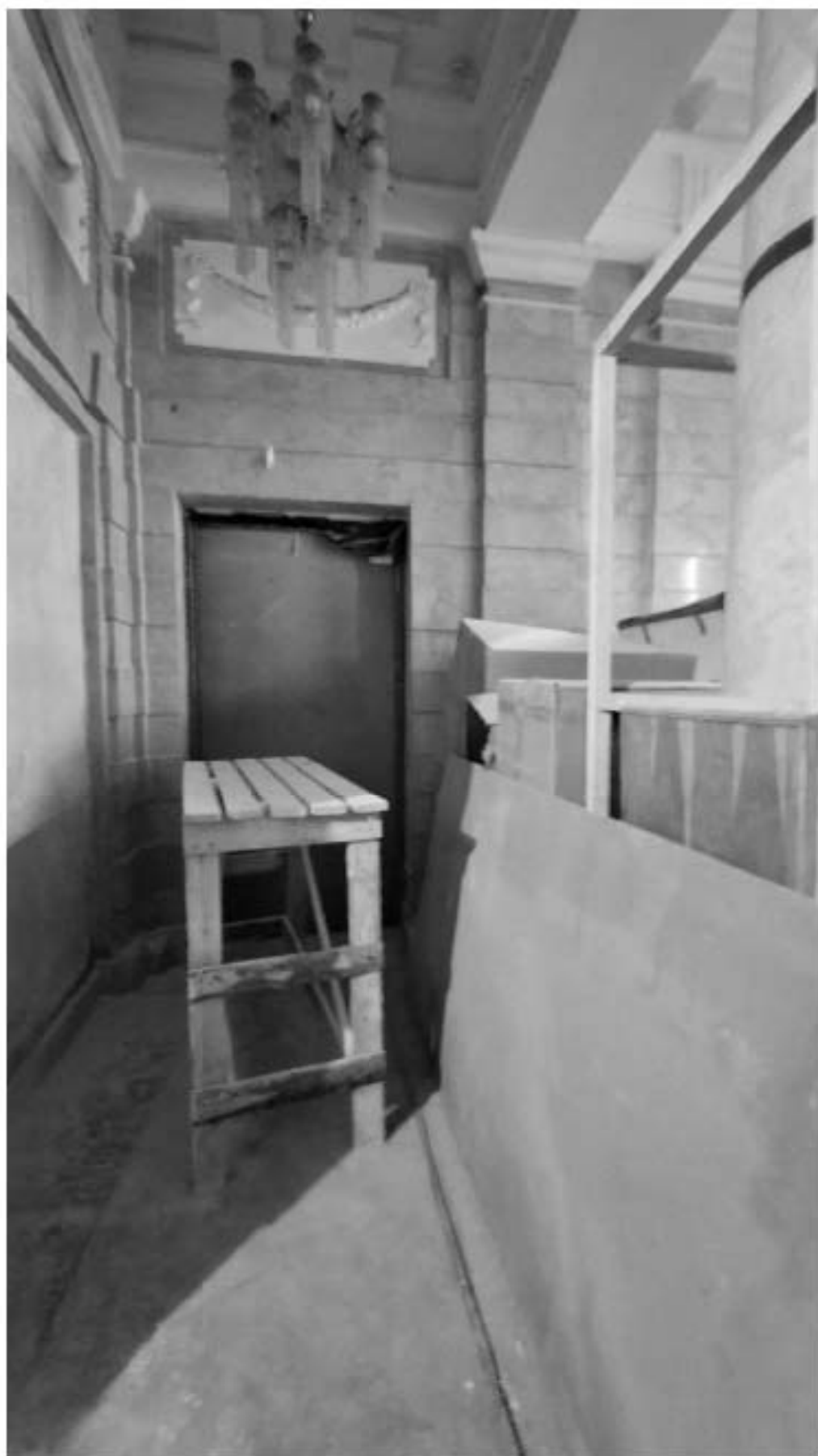
10. Фрагмент интерьера вестибюля (помещение №1.2);
