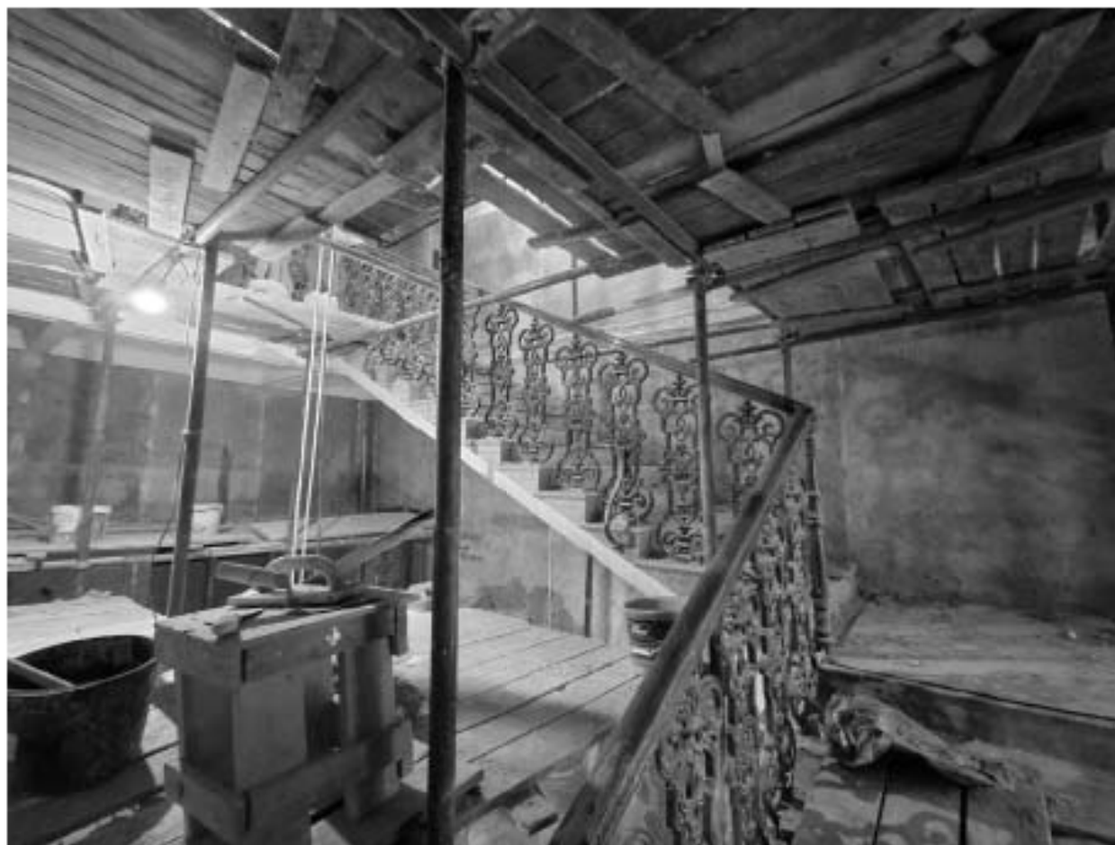
41. Вид парадной лестницы Л-1 (помещение 2.1).
