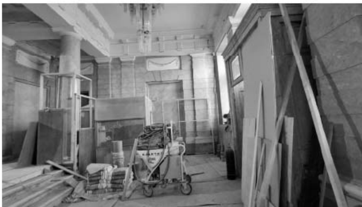
6. Фрагмент интерьера вестибюля (помещение №1.2);
