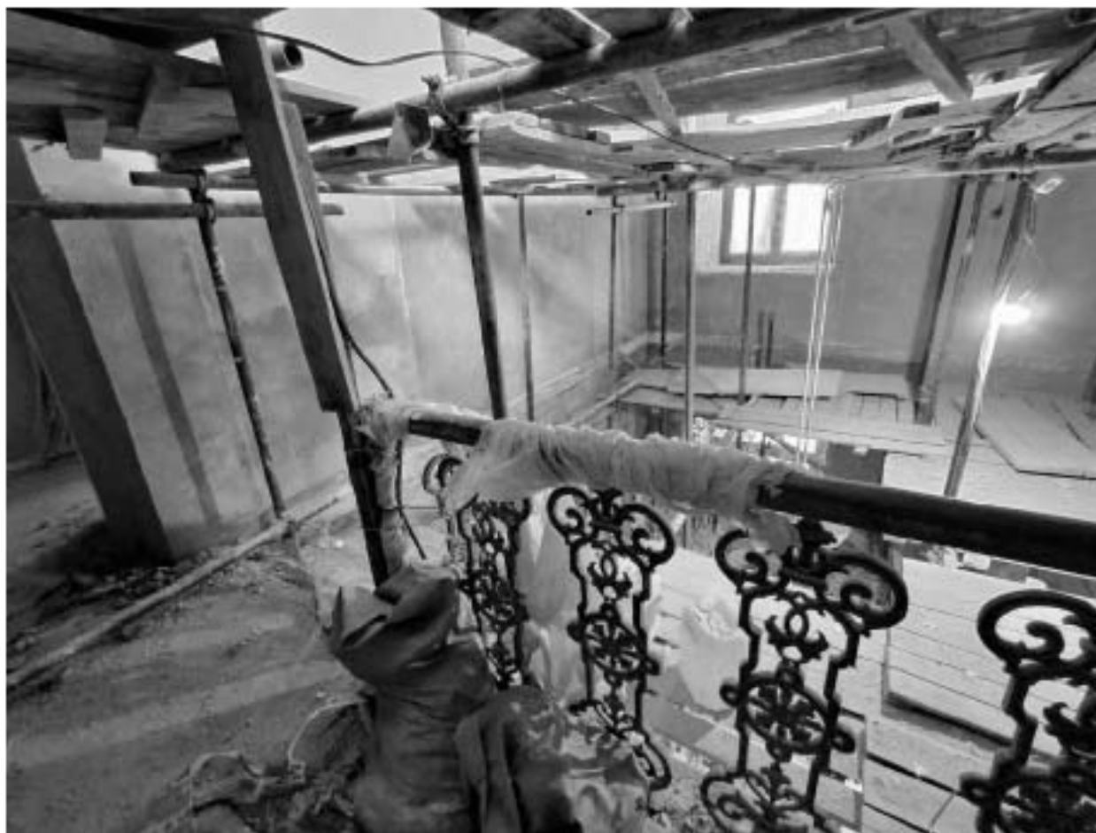
45. Вид парадной лестницы Л-1.
