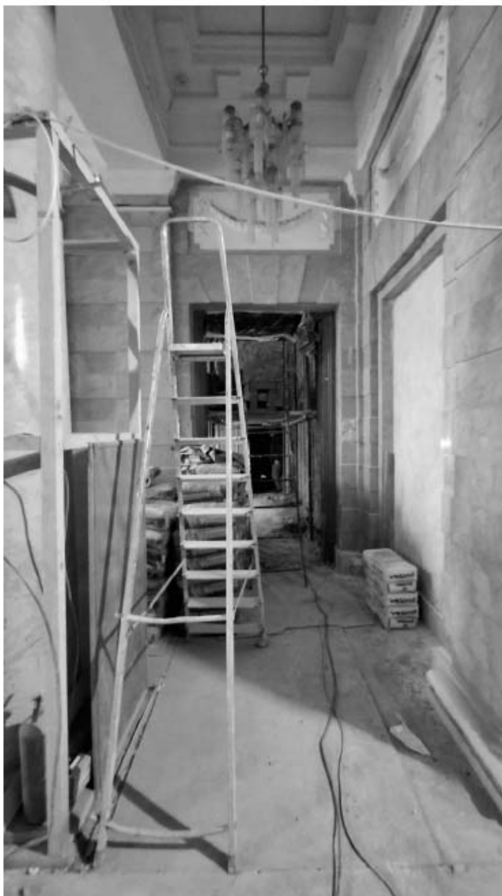
9. Фрагмент интерьера вестибюля (помещение №1.2);
