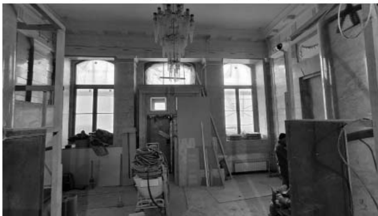
8. Фрагмент интерьера вестибюля (помещение №1.2);
