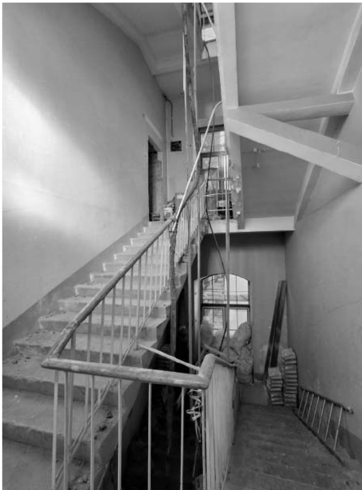
1. Фрагмент интерьера лестницы Л-2 (помещение 2.17);
