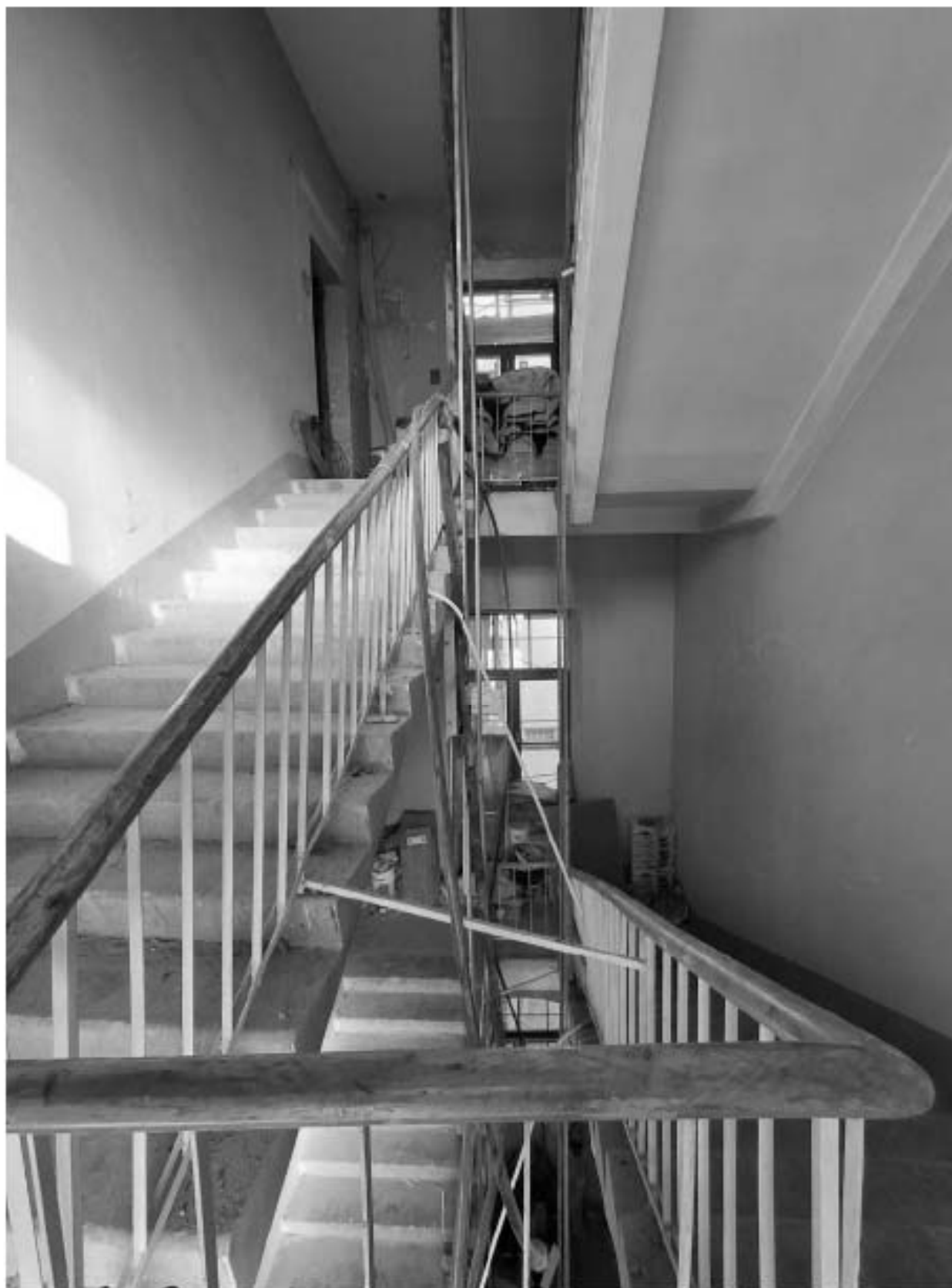
1. Вид лестницы Л-2;
