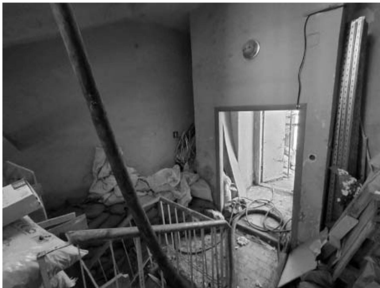
34. Фрагмент интерьера лестницы ЛІ-2 (помещение 1.19).
