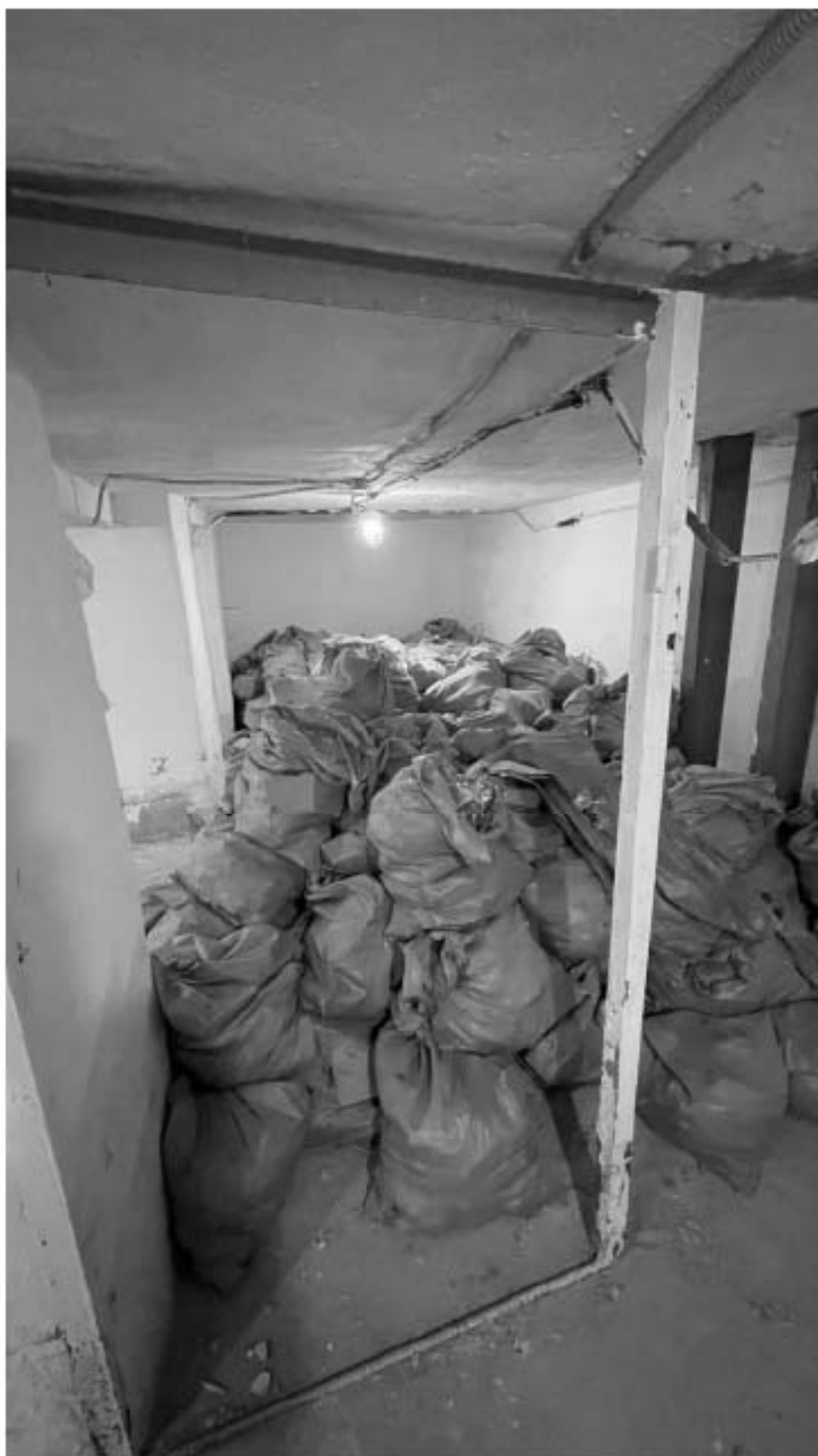
4. Фрагмент інтер'єра приміщення 0.4;
