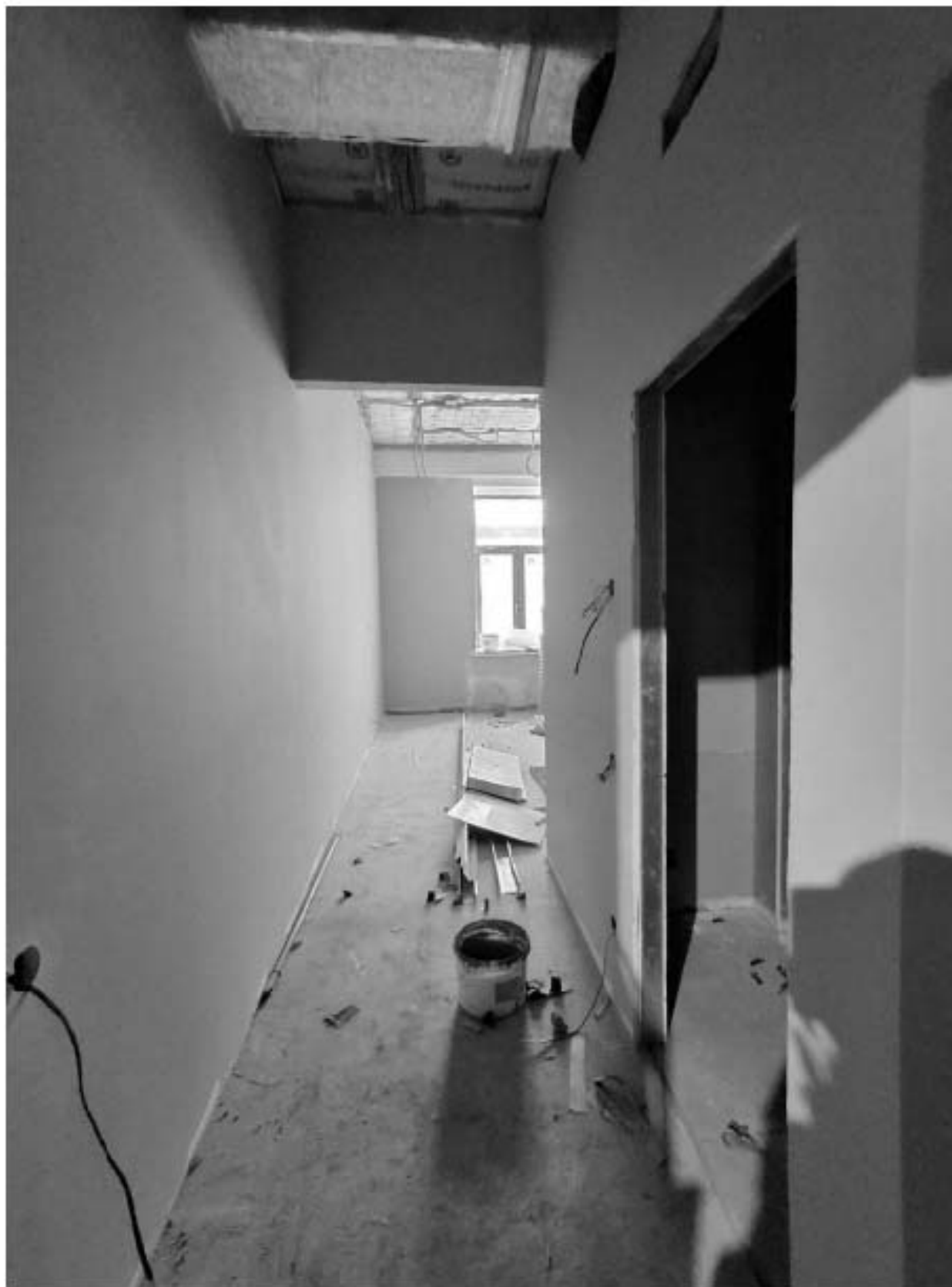
30. Фрагмент інтер'єра помещення 3.11;
