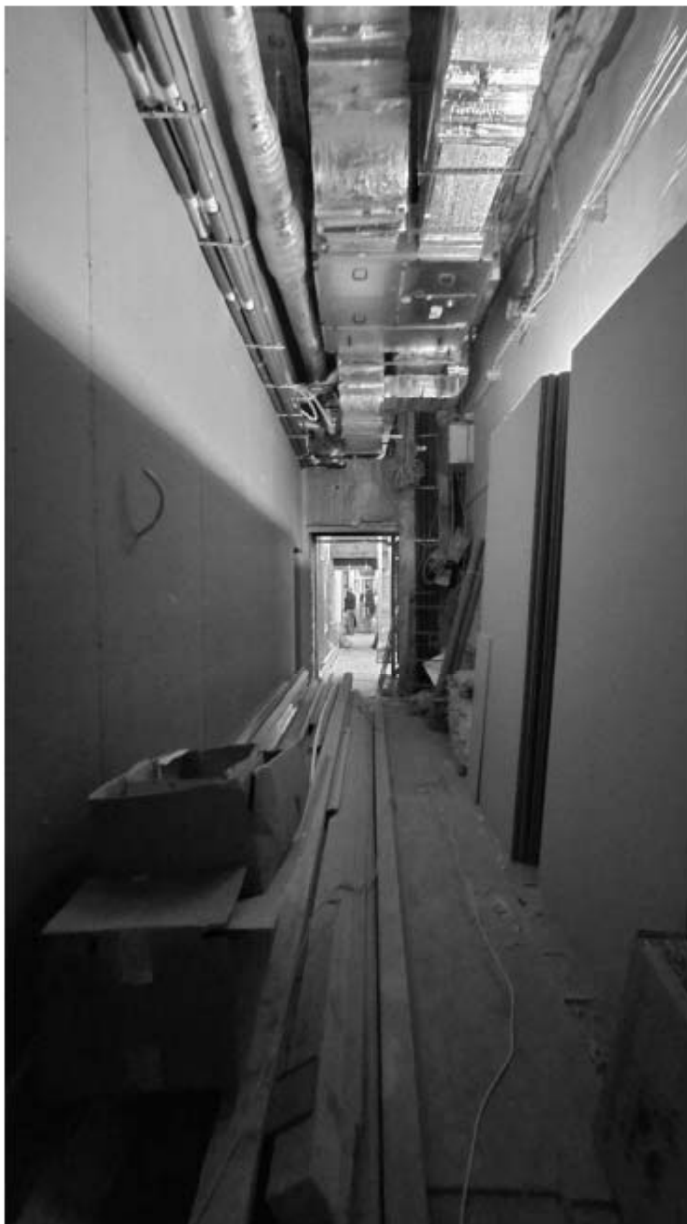
15. Фрагмент интерьера коридора (помещение 1.13);
