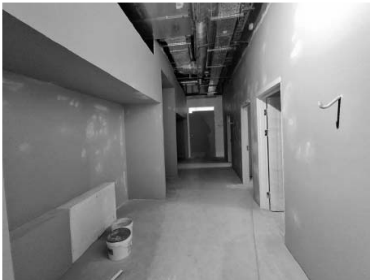
31. Фрагмент интерьера коридора (помещение 2.7);
