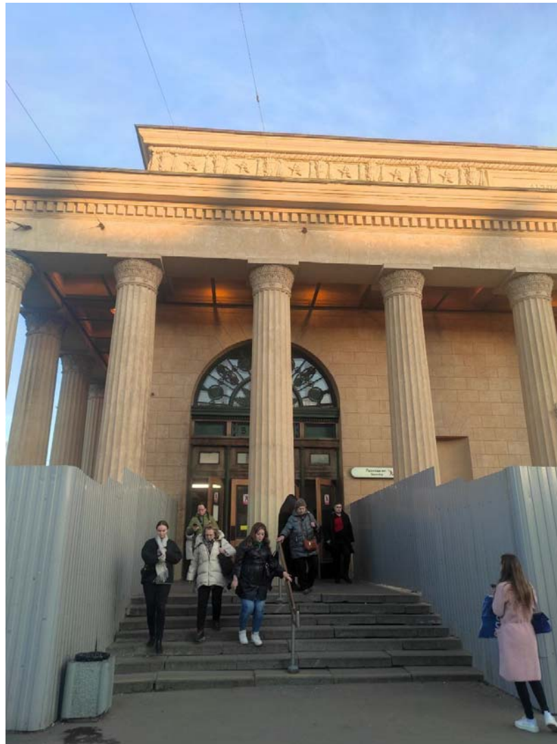
Фото №2. Северо-западный фасад, выход.
