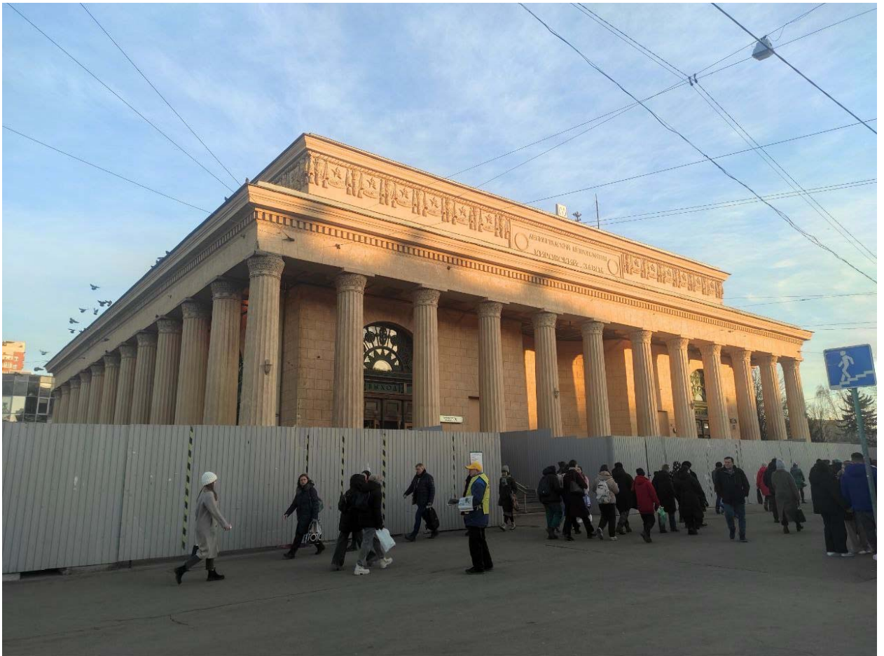
Фото №1. Северо-западный фасад, общий вид.
