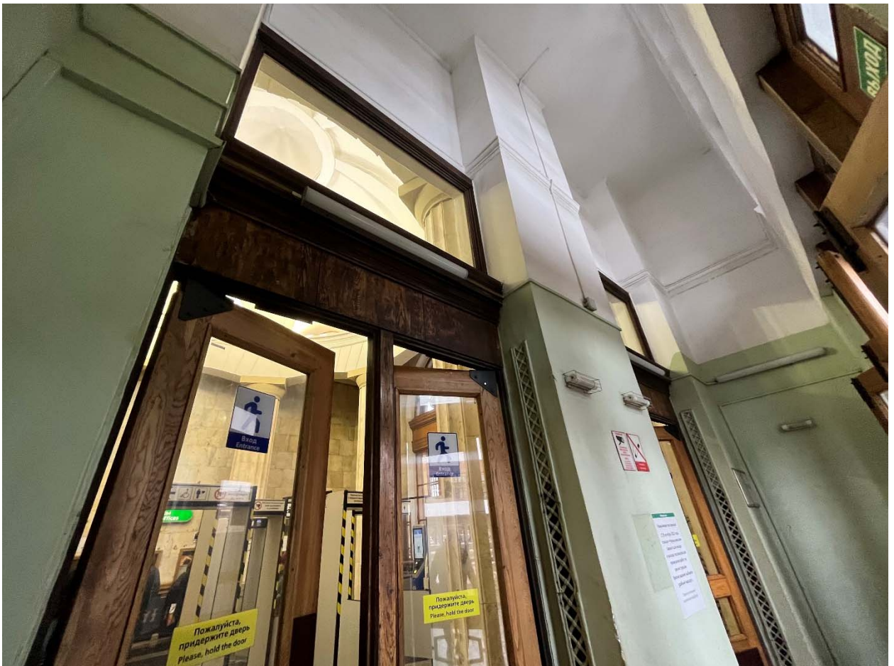
Фото №8. Тамбур входа (пом. 1-Н).
