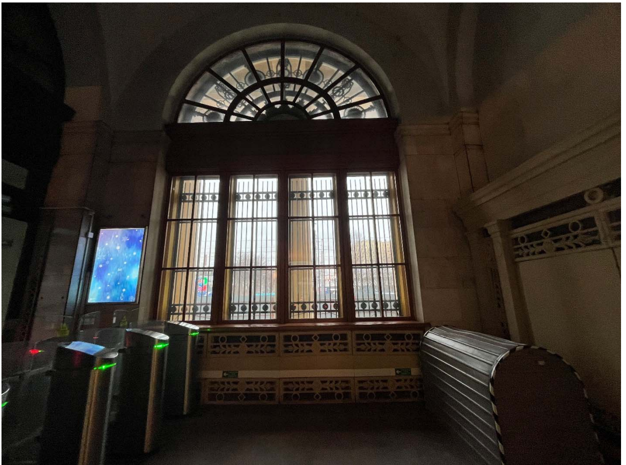
Фото №20. Вестибюль наземной части, пом. 1-Н (121).
