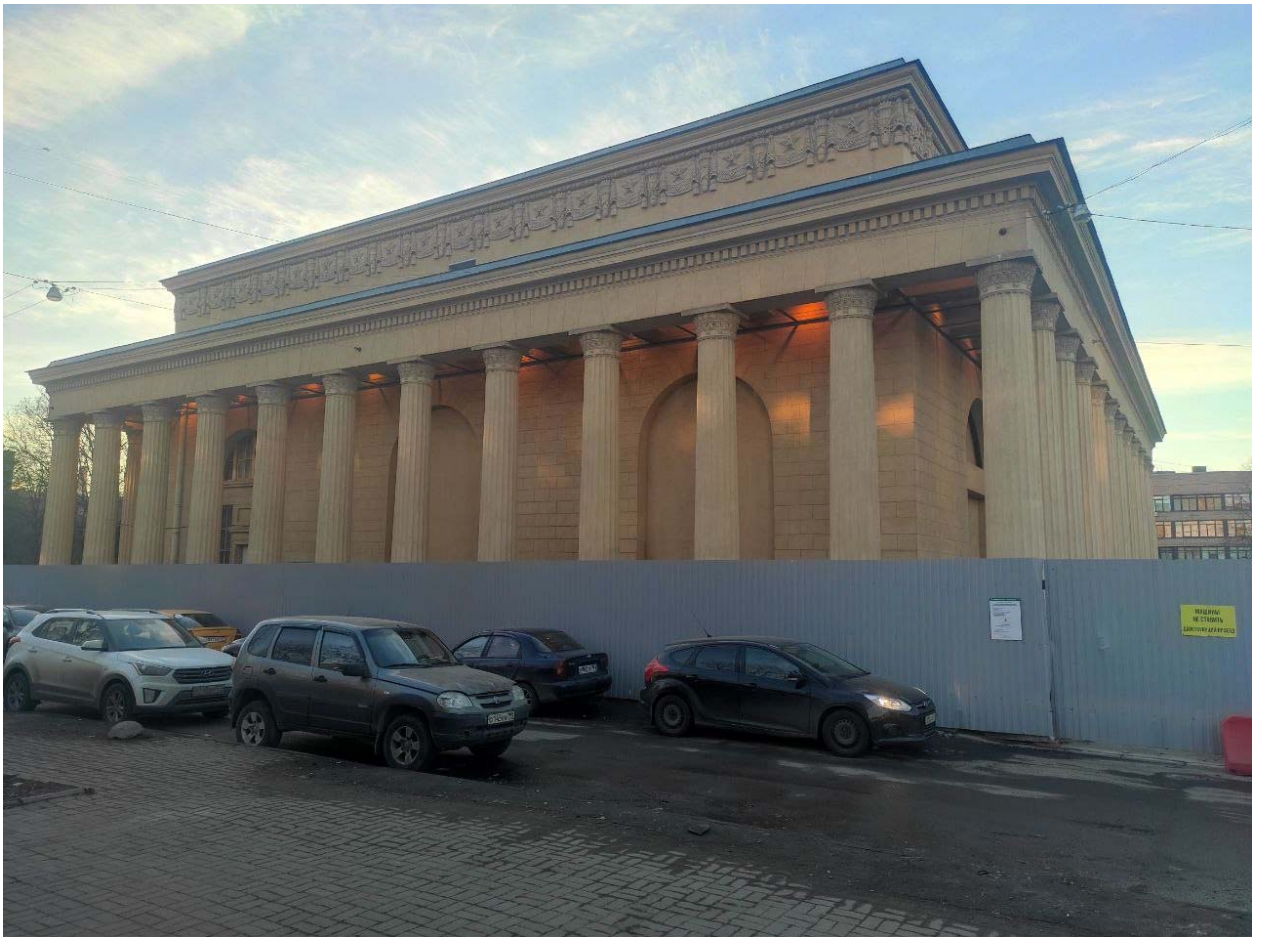
Фото №5. Юго-восточный фасад, общий вид.
