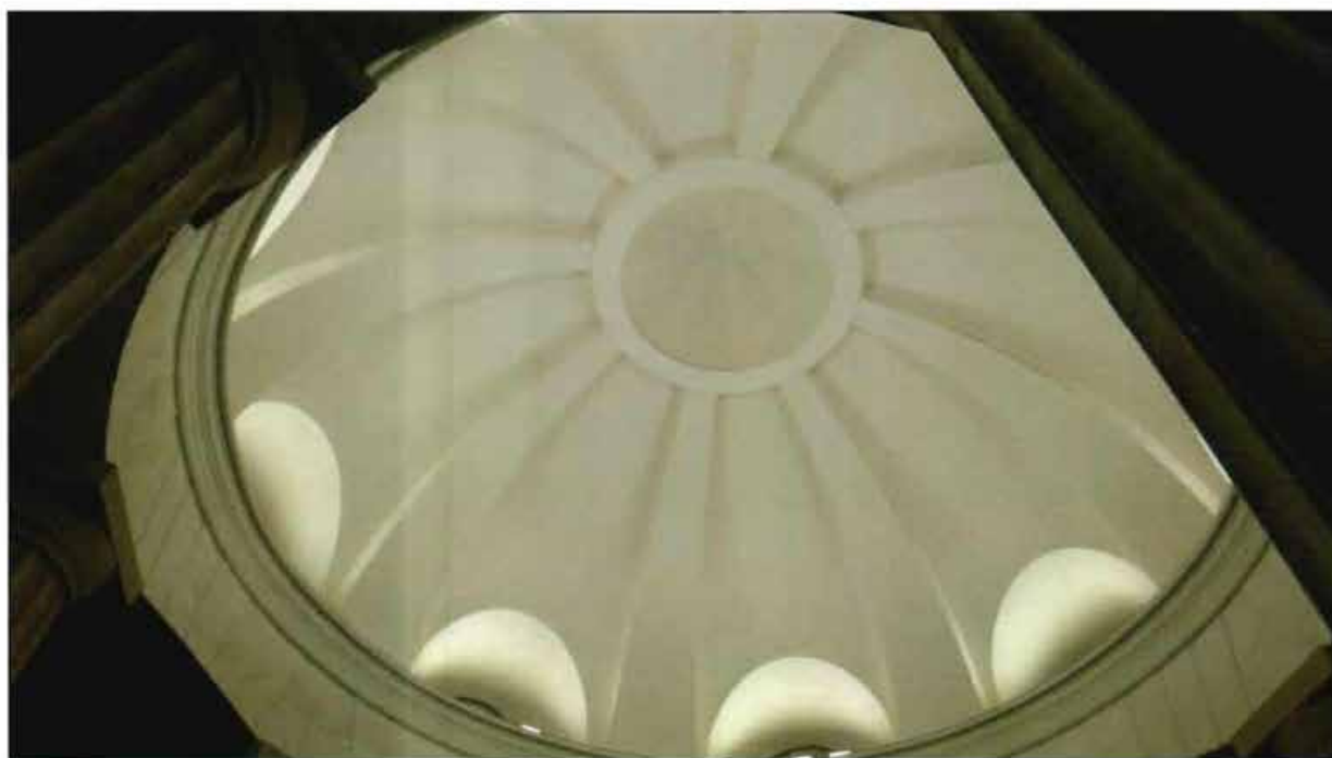
7. Купол над двусветным кассовым залом (пом. 1-Н (2)). Фотофиксация от 23.07.2021.
