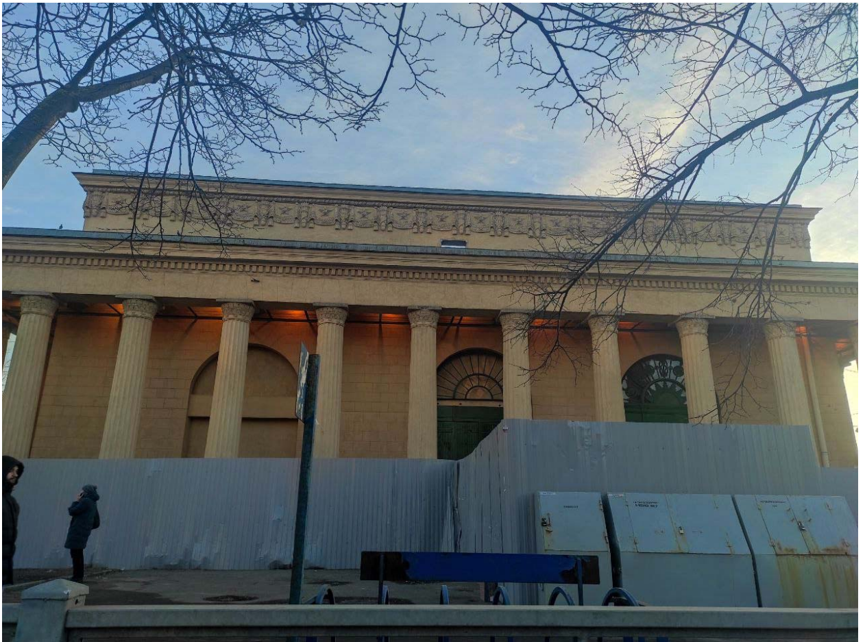
Фото №6. Северо-восточный фасад, общий вид.
