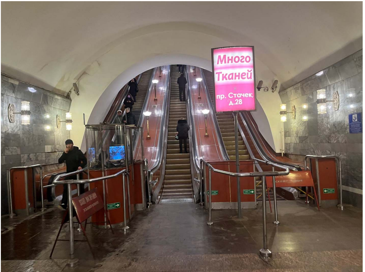
Фото №25. Вестибюль перронного зала, пом. 52, эскалаторы.
