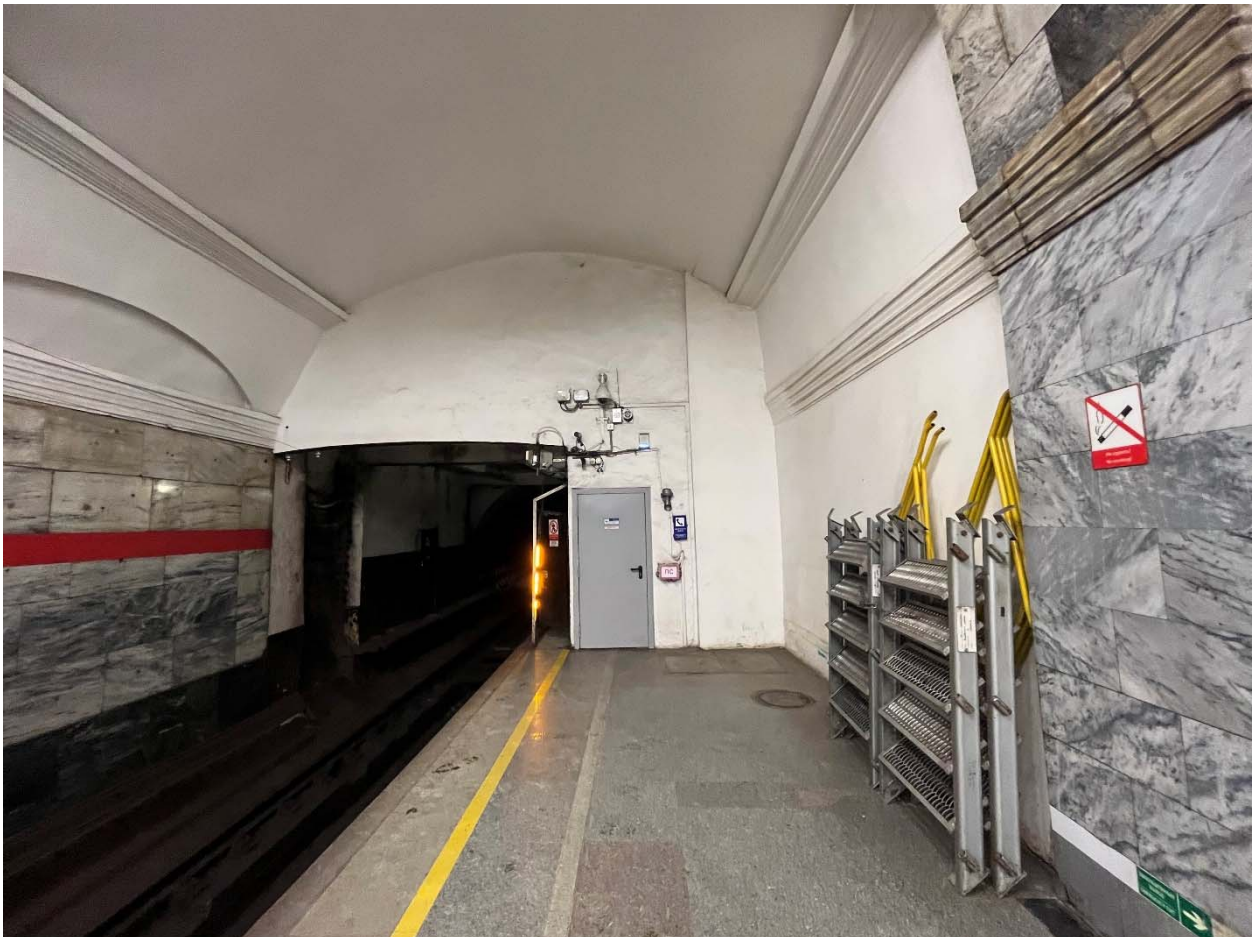
Фото №39. Вестибюль перронного зала, боковой неф, пом. 52.
