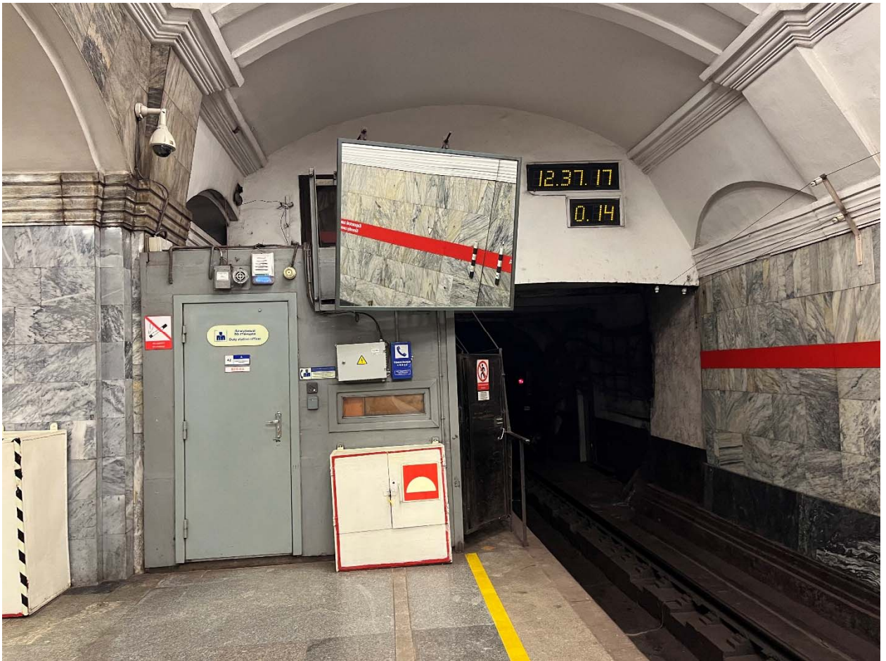
Фото №36. Вестибюль перронного зала, боковой неф, пом. 52.
