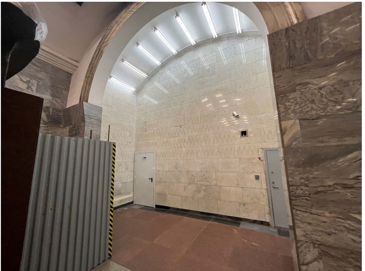
Фото №29. Вестибюль перронного зала, пом. 52.
