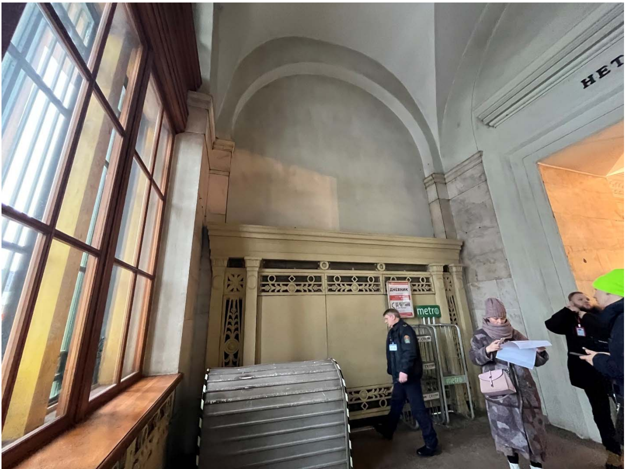
Фото №22. Вестибюль наземной части, пом. 1-Н (121).
