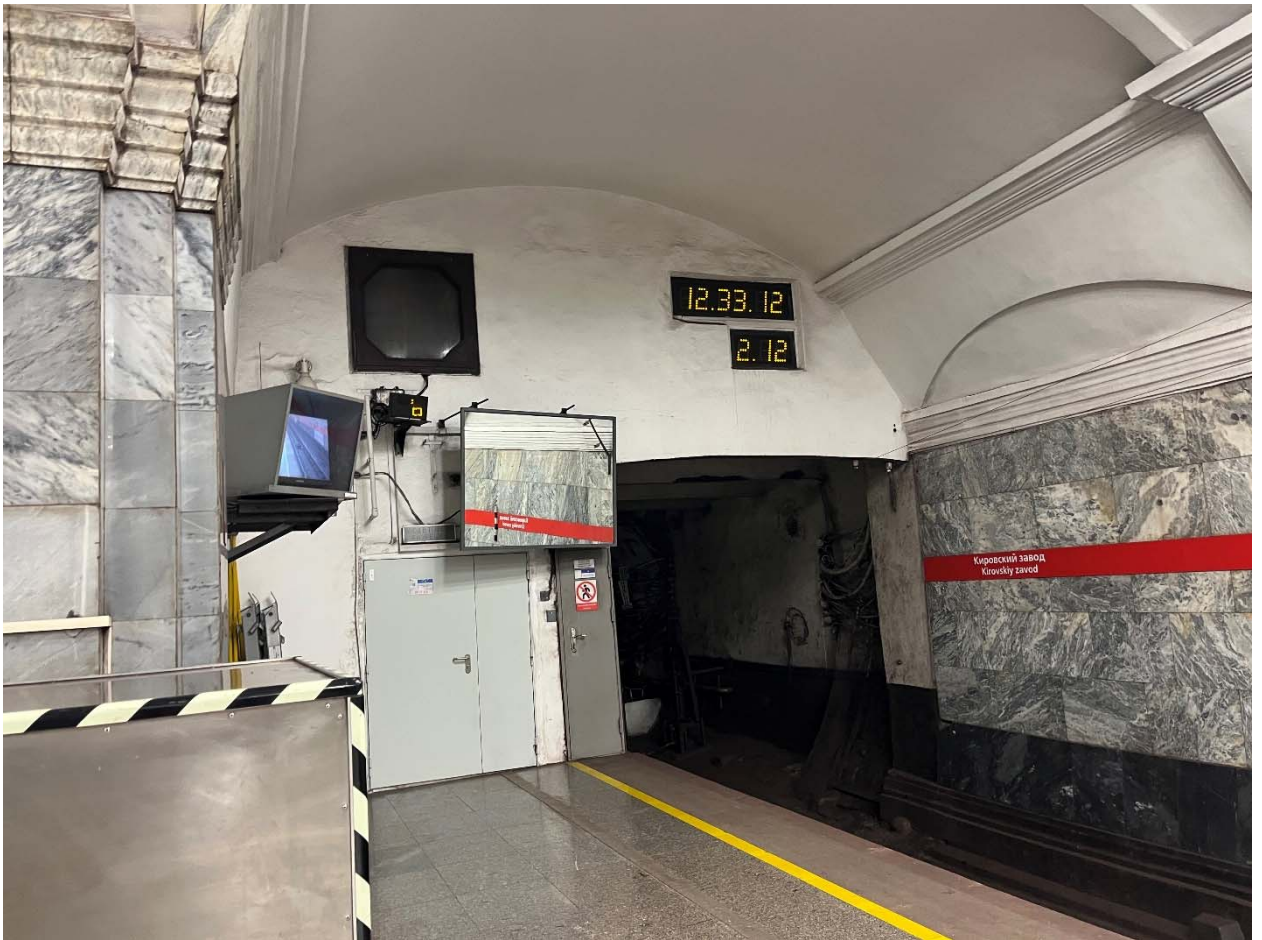
Фото №30. Вестибюль перронного зала, боковой неф, пом. 52.
