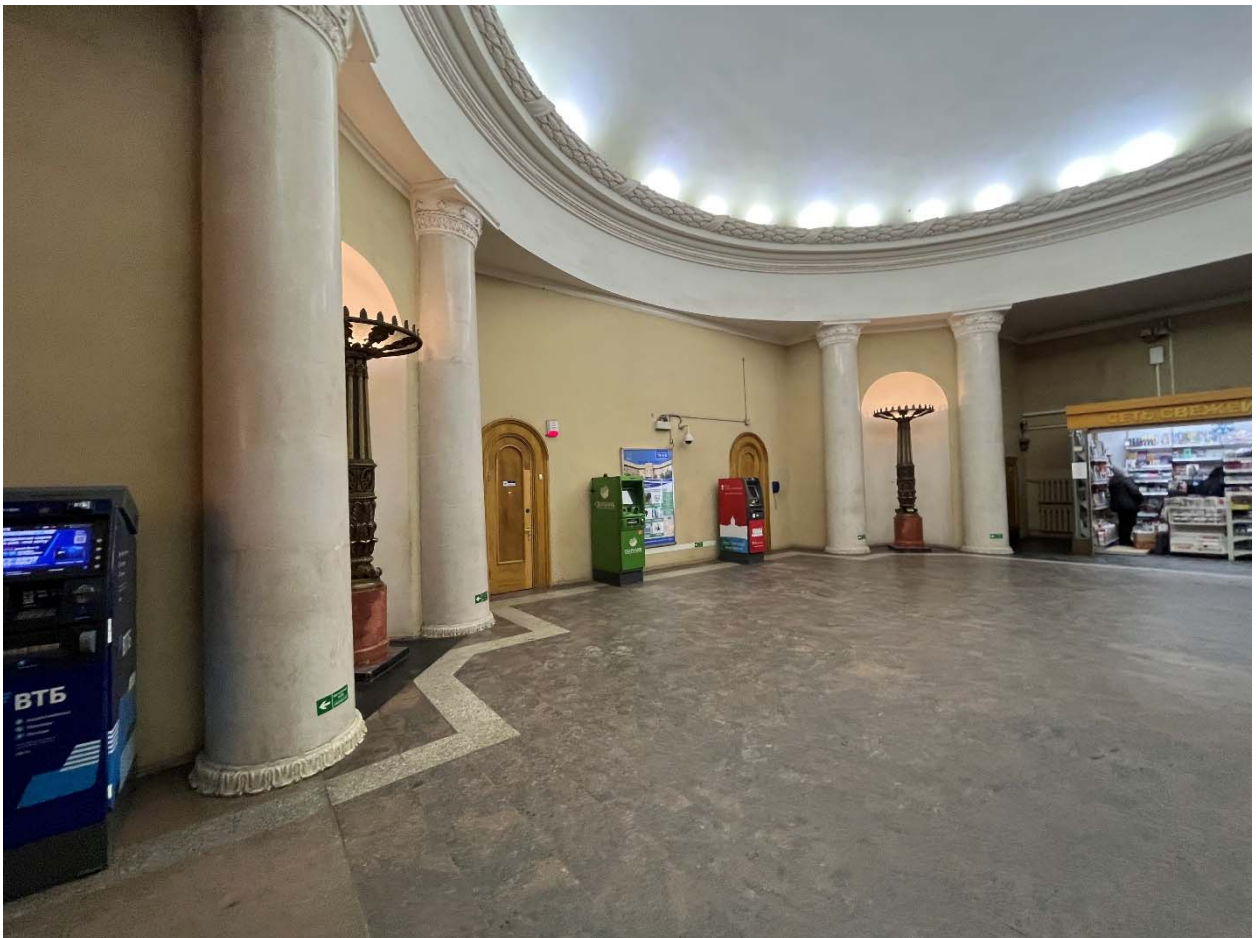
Фото №14. Вестибюль наземной части, пом. 1-Н (121).
