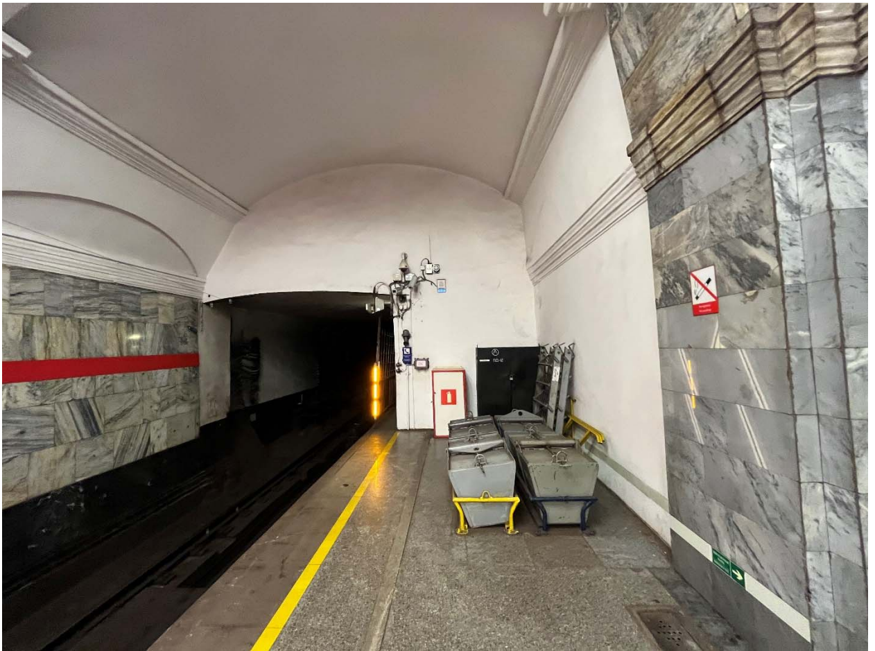
Фото №32. Вестибюль перронного зала, боковой неф, пом. 52.
