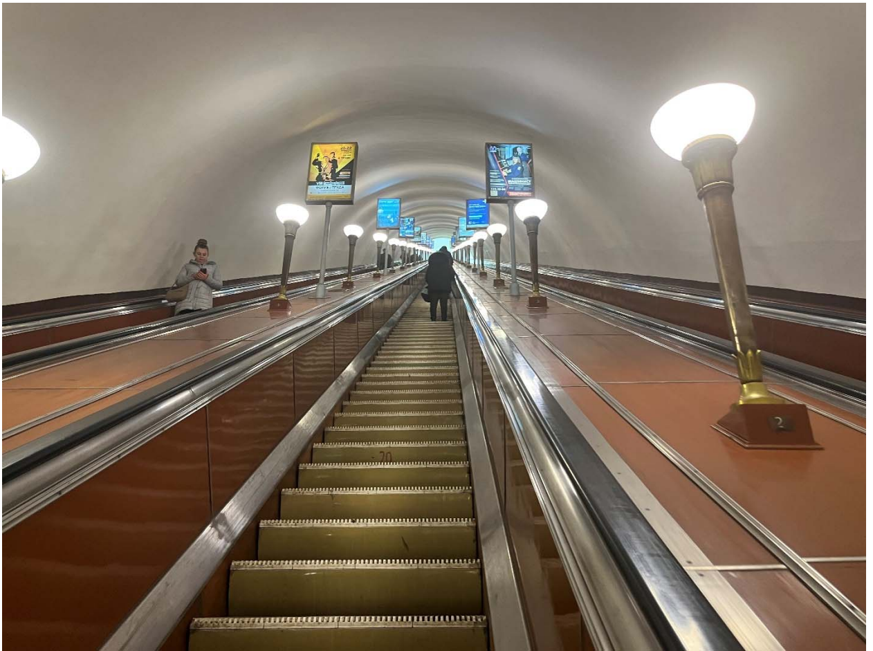
Фото №24. Наклонный ход.
