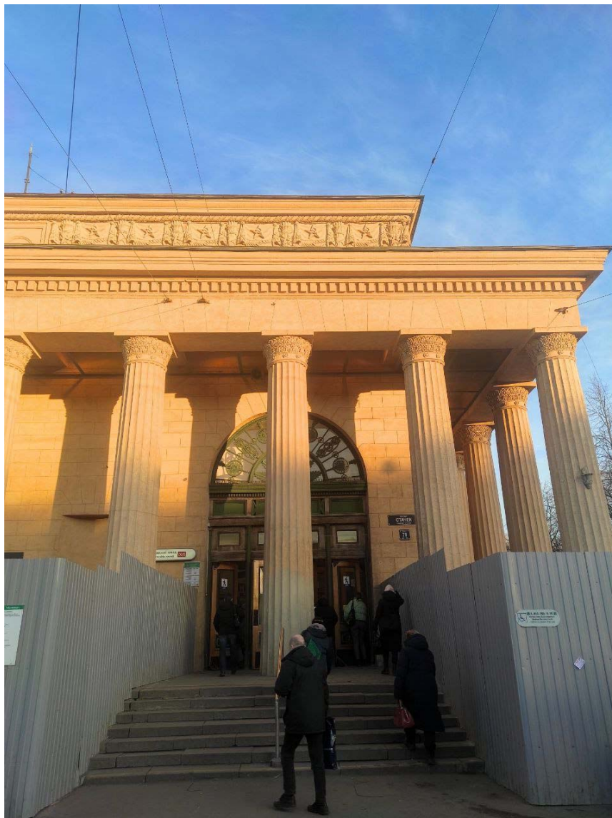
Фото №3. Северо-западный фасад, вход.
