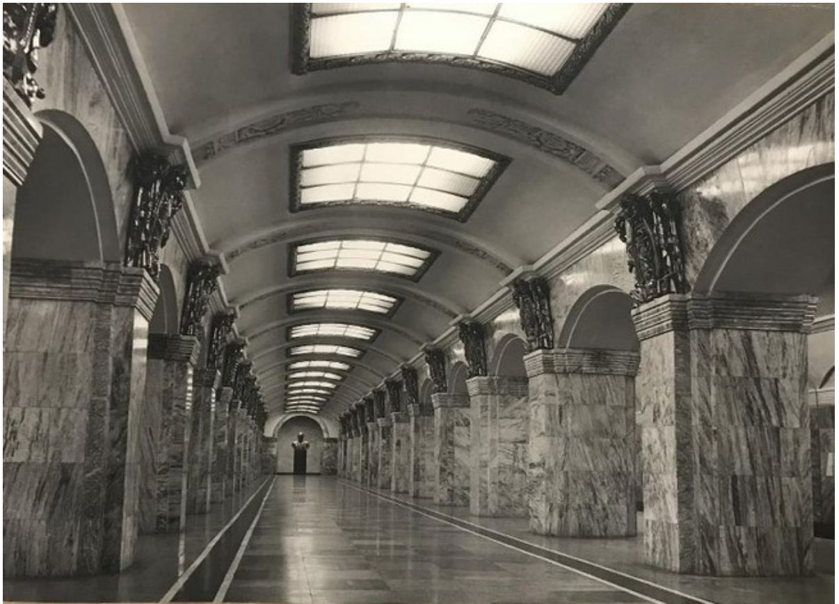
Илл. 12. Перронный зал станции метро «Кировский завод». Вид центрального зала. 1950-е гг. ФГБУК «Государственный научно-исследовательский музей архитектуры имени А.В. Щусева». ГНИМА ОФ-1478/15384.
