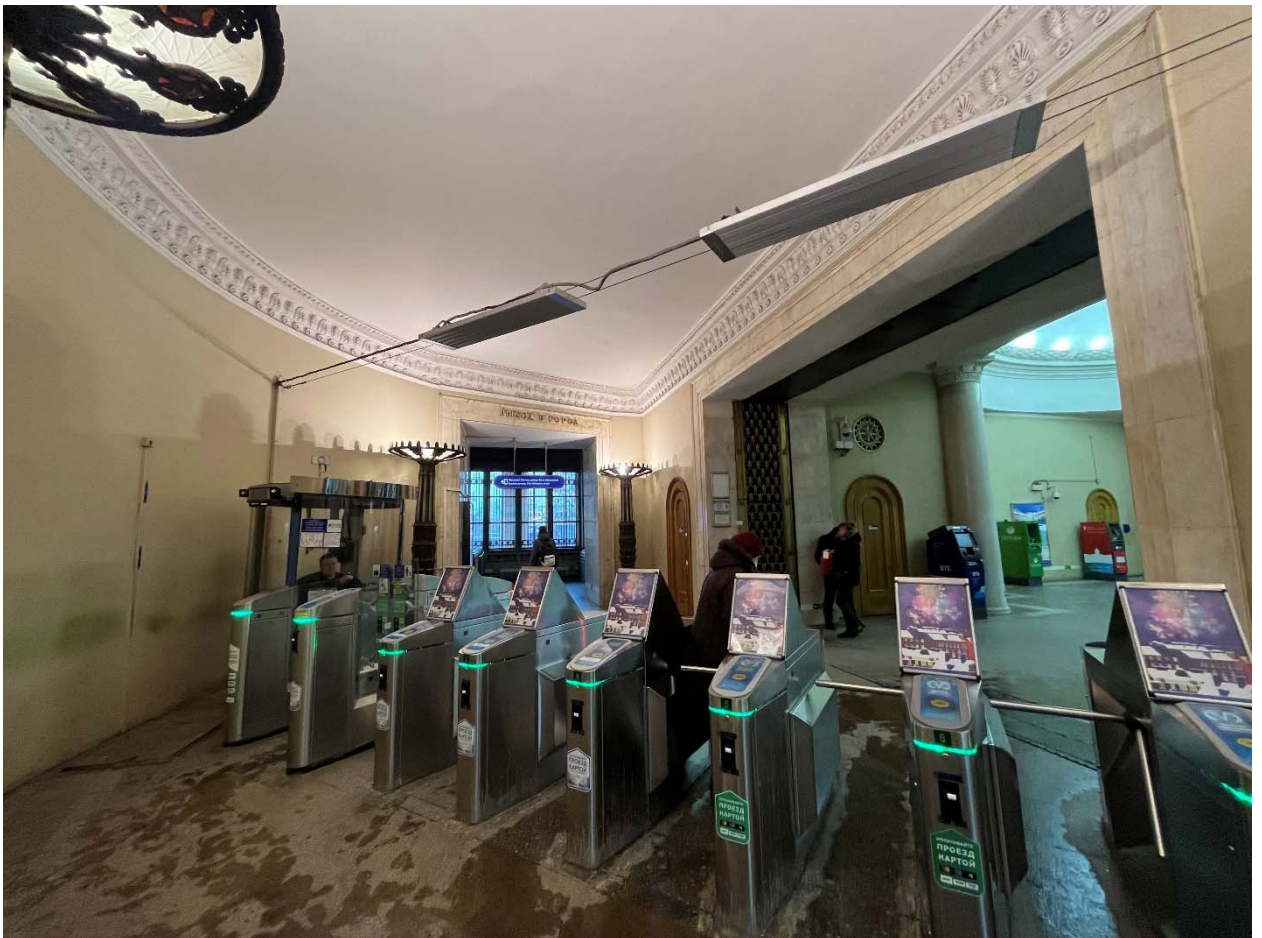
Фото №12. Вестибюль наземной части, пом. 1-Н (121).
