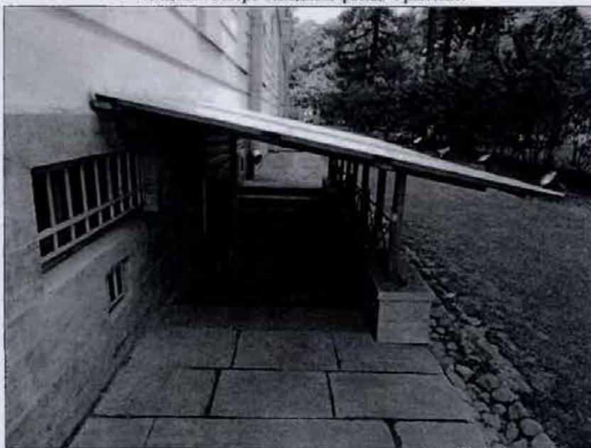
7. «Лицей». Северный фасад. Фрагмент. Приямок.
