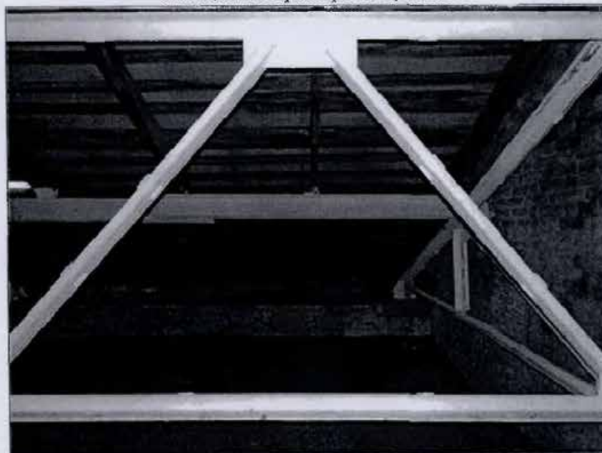
9. «Лицей». Стропильная система. Фрагмент.
