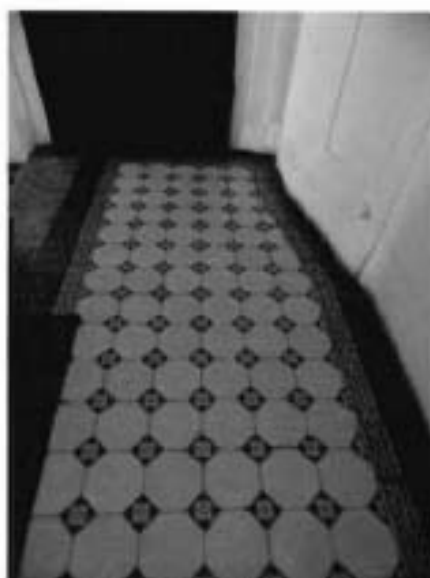
57. Западная парадная. Плиточное напольное покрытие лестничной площадки.
