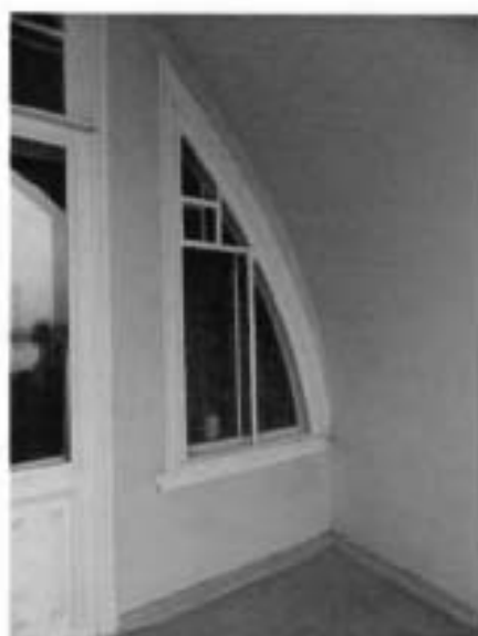
81. Шестой этаж. Балкон. Столярное заполнение оконного проема.
