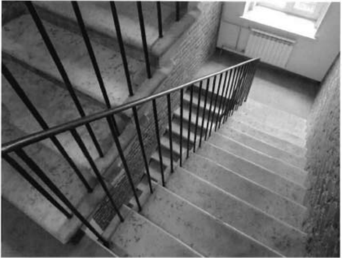
4. Лестница Л-1 объекта культурного наследия
