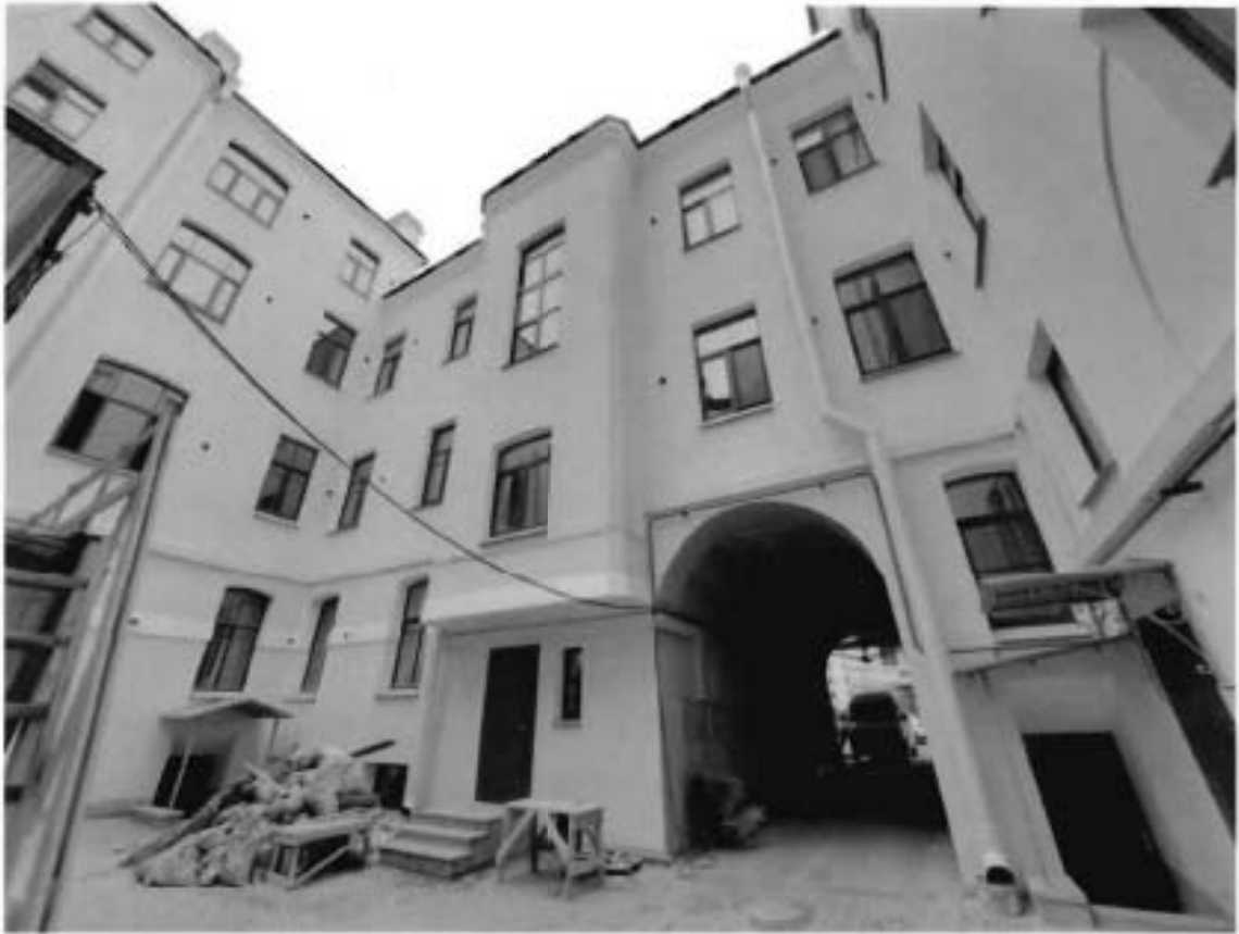
2. Общий вид на южный дворовой фасад объекта культурного наследия
