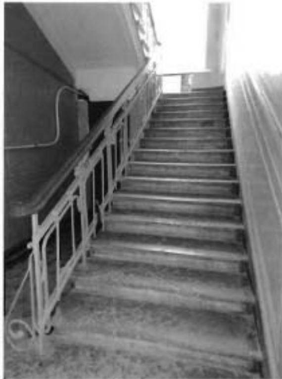
6. Парадная лестница Л-2 объекта культурного наследия
