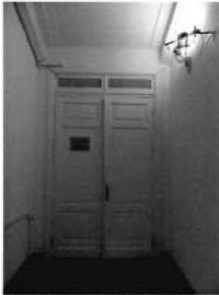
14. Современное дверное заполнение исторического проема между вестибюлем и служебным помещением
