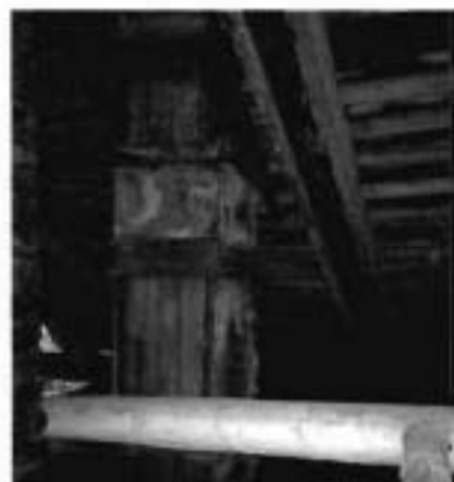
85. Чердачное помещение. Фрагмент кровельных конструкций.
