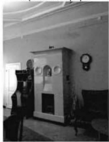
79. Помещение пятого этажа. Фрагмент интерьера – печь средистенная одноярусная.
