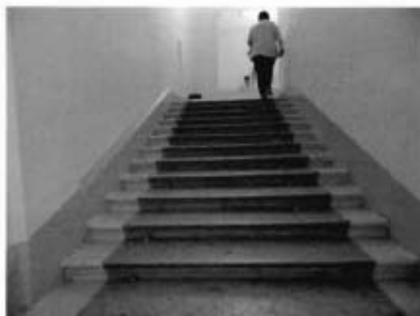
38. Фрагмент парадной лестницы в центральной части здания.
