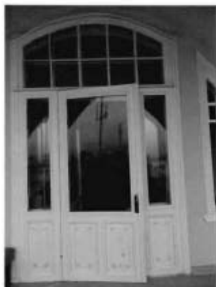
80. Шестой этаж. Балкон. Столярное заполнение дверного проема.
