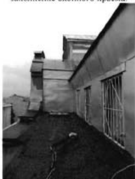
83. Мансардный этаж. Облицовка лицевой части. Кровельное покрытие.
