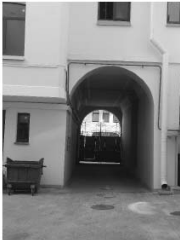
Фото 11. Арочный проезд дома № 5 со стороны внутреннего двора.
