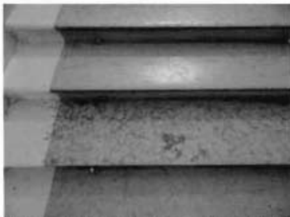
36. Известняковые ступени парадной лестницы в центральной части здания.
