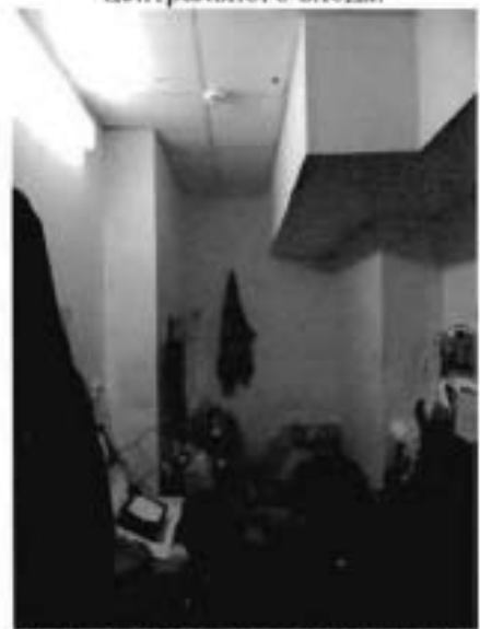
19. Внутренняя планировочная структура. Отделка служебных помещений западнее центрального входа.
