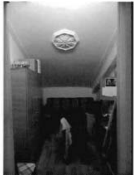
15. Внутренняя планировочная структура. Служебное помещение под центральной лестницей западнее центрального входа.
