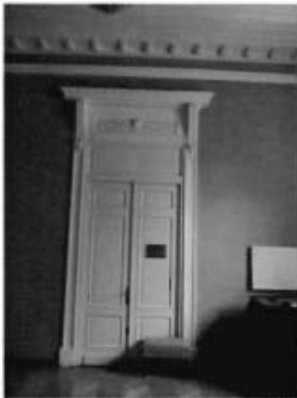
44. Вестибюль второго этажа центральной части здания. Дверное заполнение проема.
