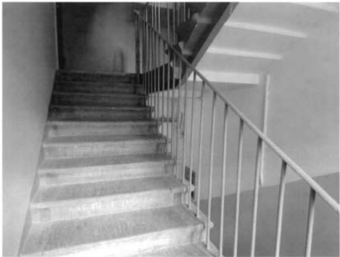
7. Лестница Л-3 объекта культурного наследия
