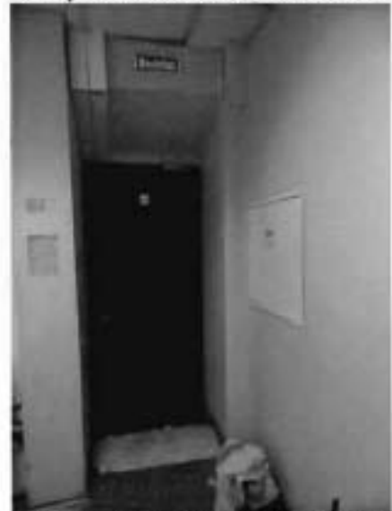
25. Внутренняя планировочная структура. Выход на эвакуационную лестницу в восточном крыле
