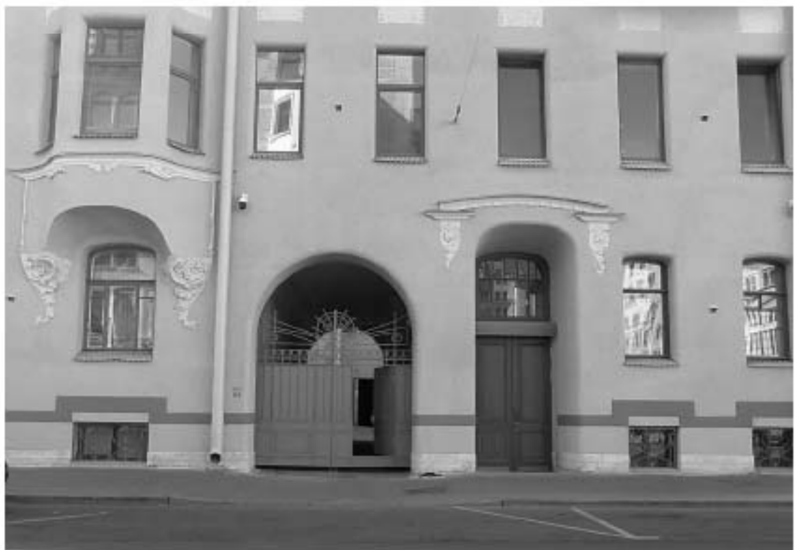
Фото 9. Отреставрированные и воссозданные архитектурные детали фасада дома № 5 по Баскову переулку (фрагмент): лепной декор низа эркера, лепной декор над порталом, деревянная дверь лицевого фасада со стеклянной фрамугой с восстановлением рисунка расстекловки, металлические решётки окон подвала, металлические ворота арочного проезда.
