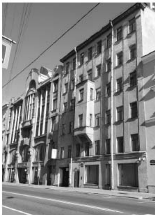
Фото 4. Общий вид лицевых фасадов д. № 10- 12 по ул. Некрасова в юго-западном направлении.
