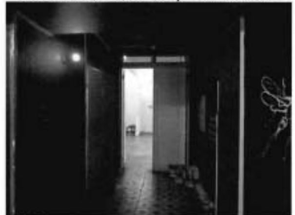
17. Внутренняя планировочная структура. Отделка служебных помещений западнее центрального входа.
