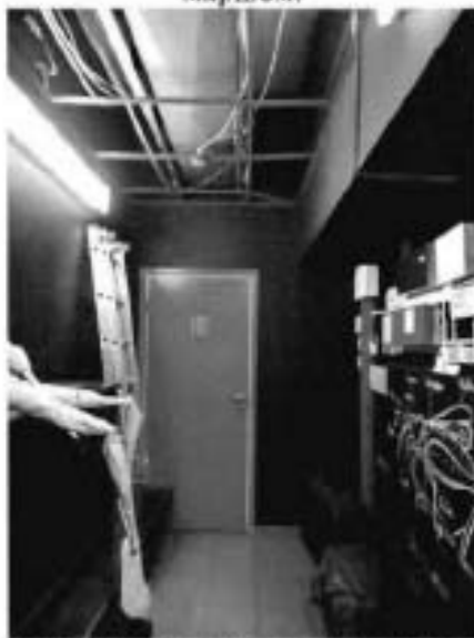
18. Внутренняя планировочная структура. Отделка служебных помещений западнее центрального входа.
