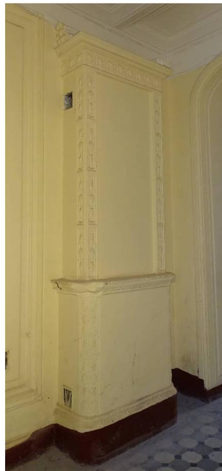
печь на лестнице Л2: двухъярусная гладкого поливного изразца, с нишей в верхней части, рельефным фризом, рельефные ребра в нижнем ярусе; топочное отверстие заложено;
