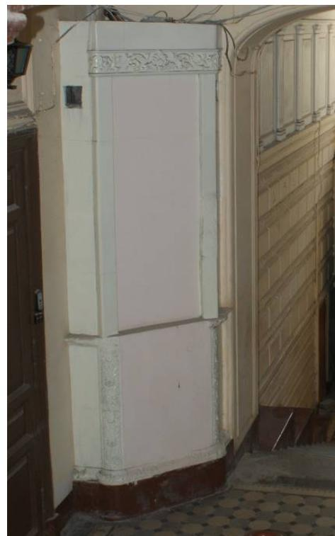
печь на лестнице Л3: угловая, двухъярусная, белого гладкого и рельефного орнаментированного поливного изразца (ребра в нижней части; фриз растительного орнамента); полочка, с закругленными краями; фигурное навершие в виде лучкового фронтона с рельефом в тимпане; топочное отверстие прямоугольной формы;
