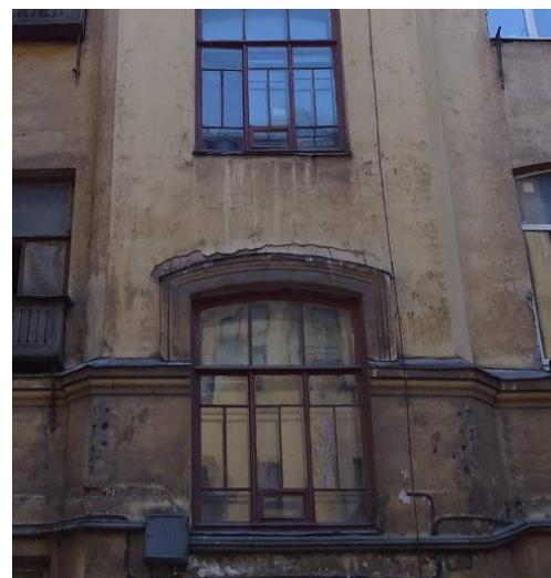
северо-восточная служба (двухэтажная): материал отделки цоколя – известняк; материал и характер отделки фасада – гладкая окрашенная штукатурка; исторический рисунок раскреповки; закругленные углы; исторические дверной и оконные проемы – местоположение, габариты, конфигурация; венчающий профилированный карниз;
