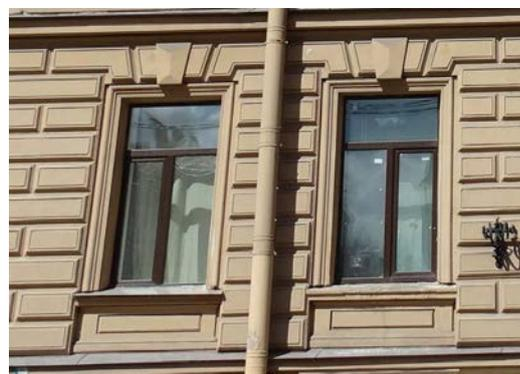
декоративное оформление оконных проемов 2-го этажа – рустованные профилированные наличники с веерными замковыми камнями с «алмазной гранью», филенки сложной конфигурации в подоконных простенках; декоративные «ножки» в подоконных простенках;
