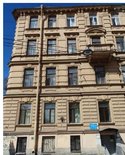
венчающий выносной профилированный карниз, с поясом иоников на волнитообразных кронштейнах, сухарики;
