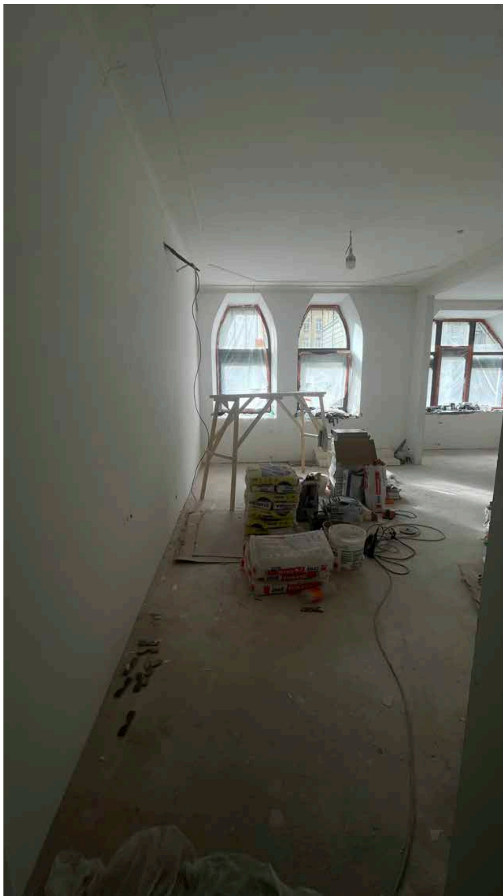
6. Вид на комнату (помещение 3/18.3);
