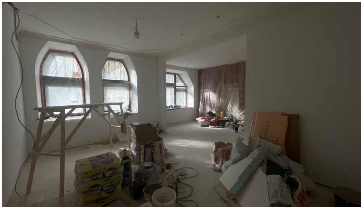
7. Фрагмент интерьера комнаты (помещение 3/18.3);
