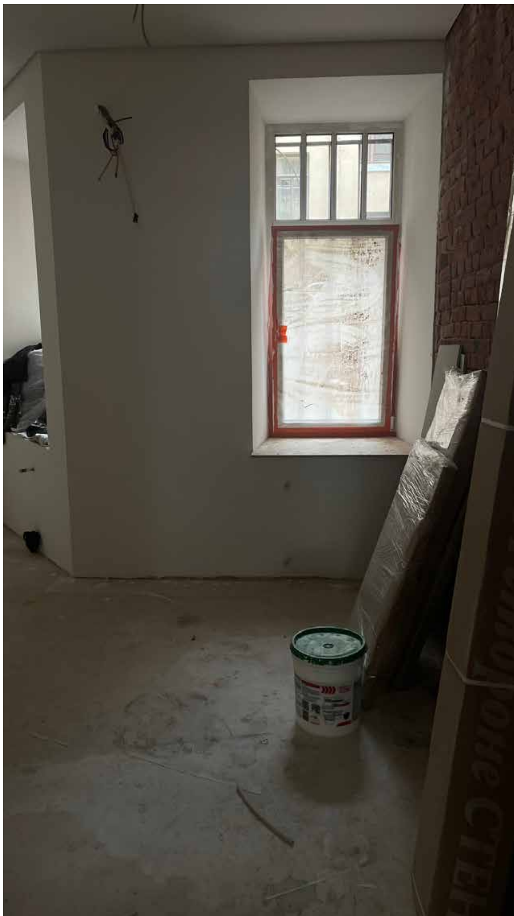
15.Фрагмент интерьера комнаты (помещение 8/17.5);
