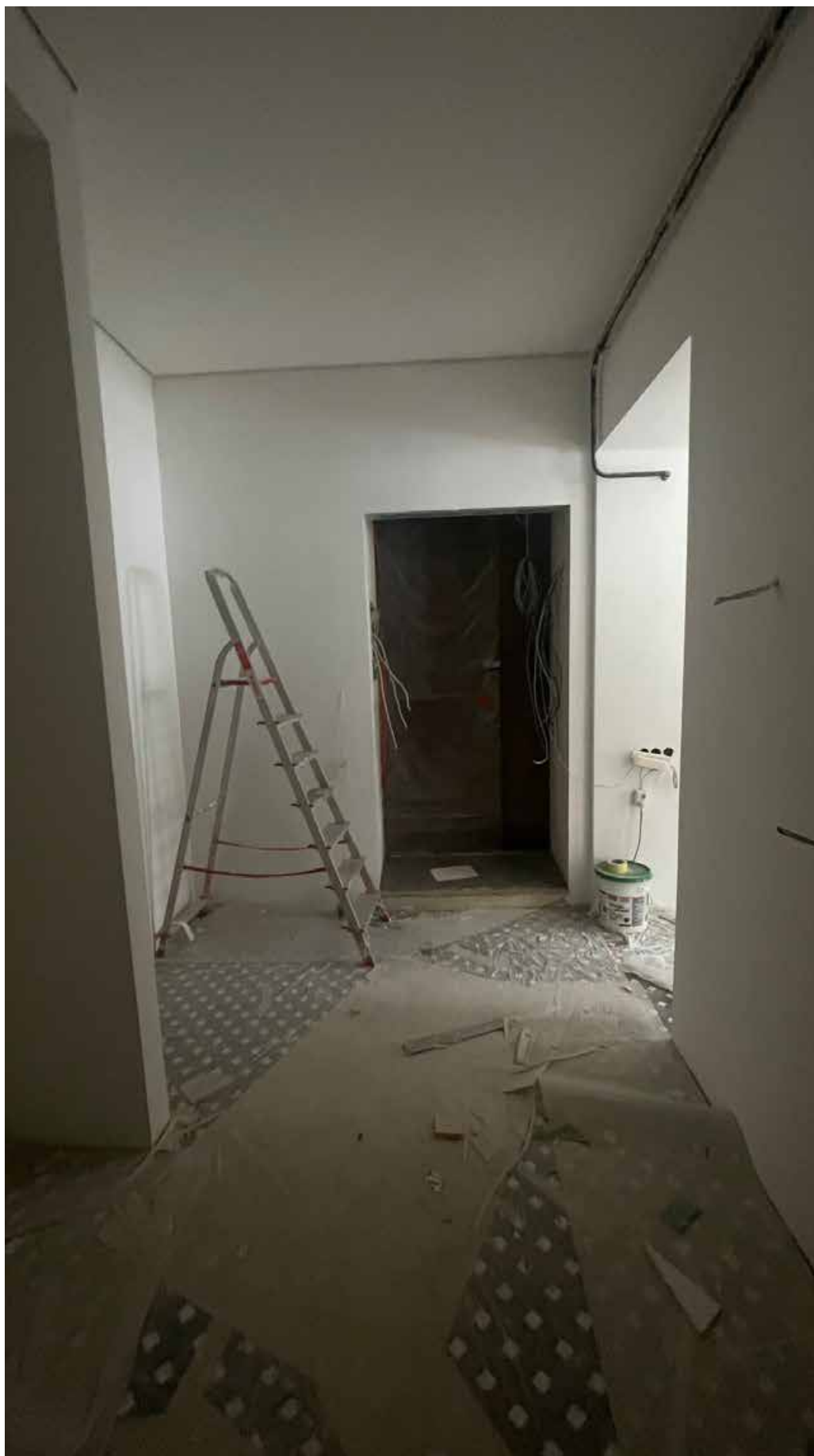
11. Фрагмент интерьера коридора (помещение 2/7);
