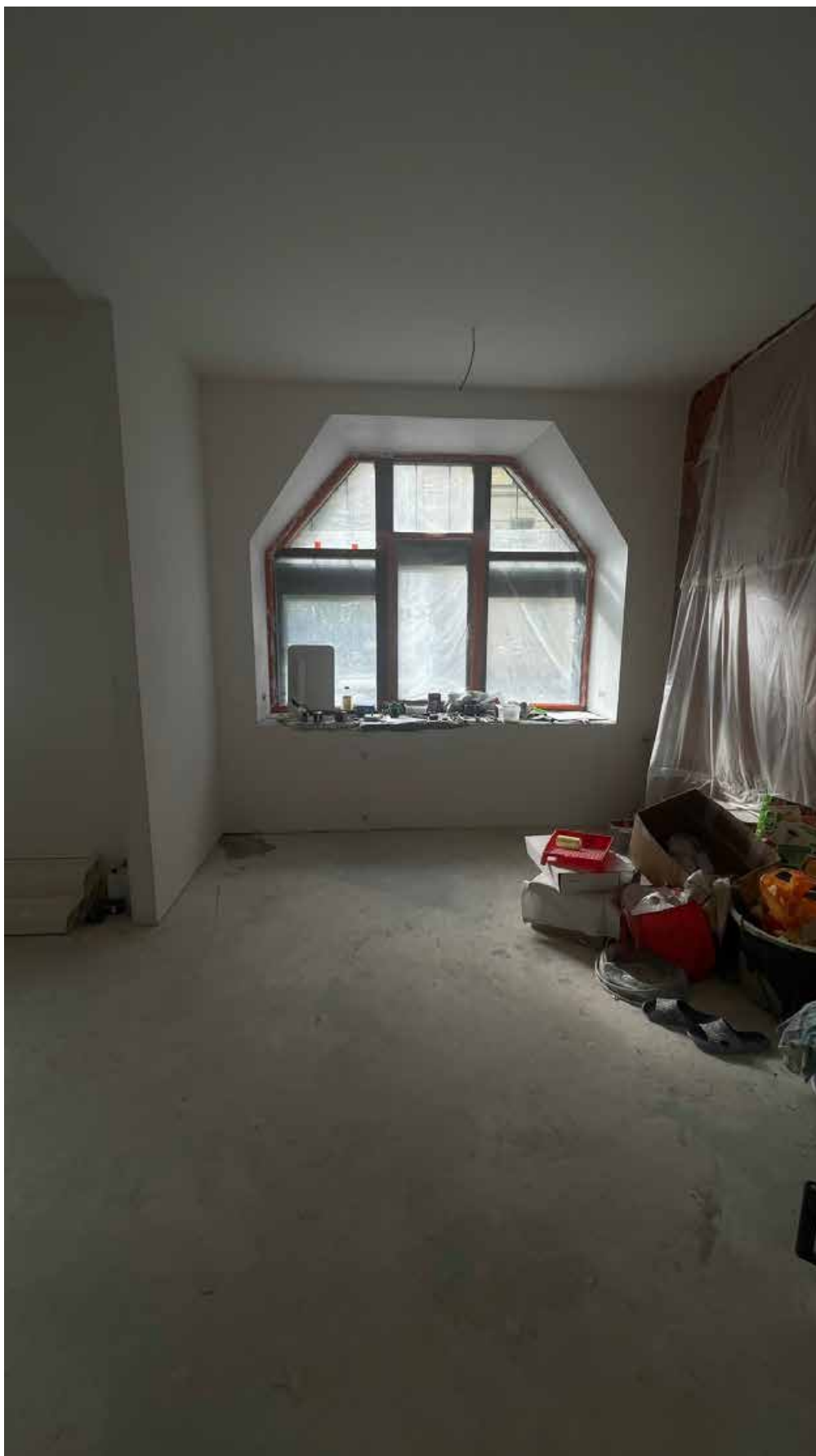
10.Фрагмент интерьера комнаты (помещение 4/22.2);
