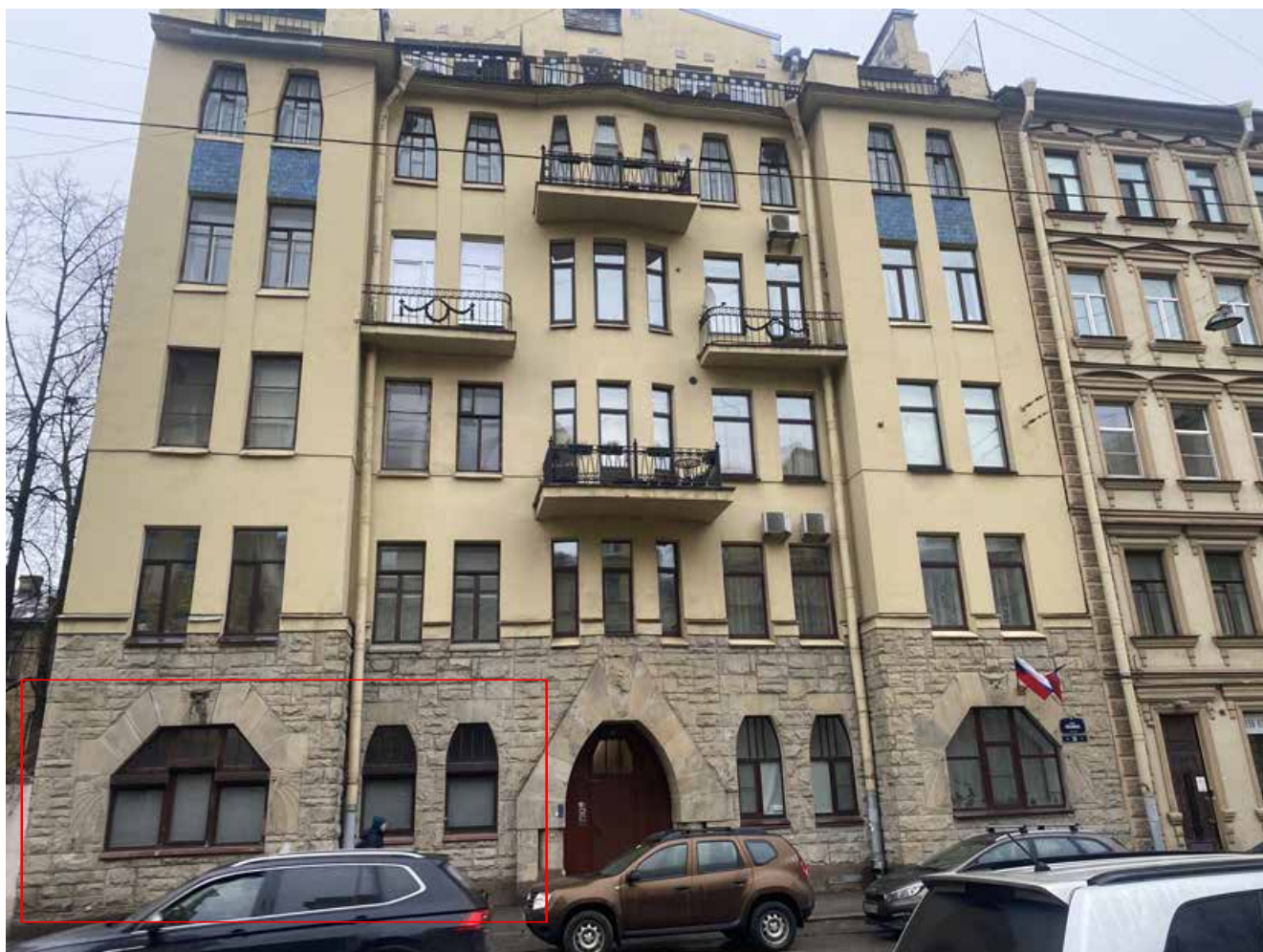
1. Вид на главный фасад здания и окна квартиры;
