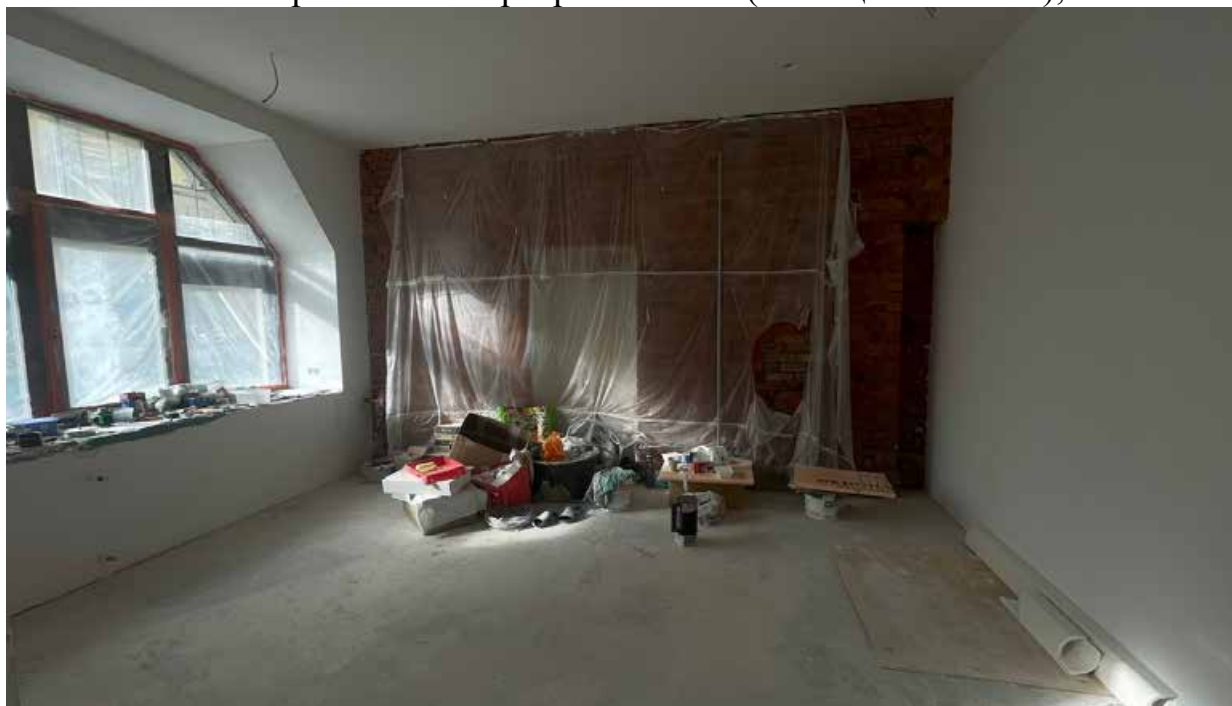
8. Фрагмент интерьера комнаты (помещение 4/22.2);
