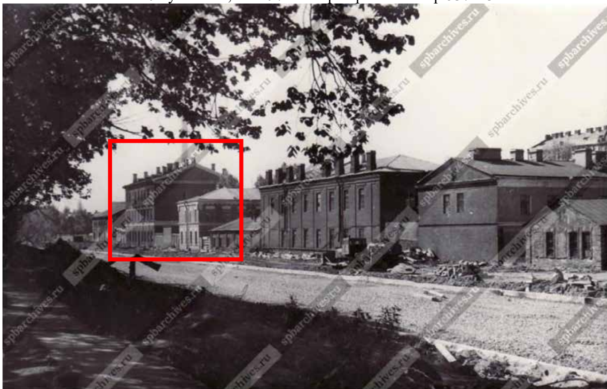
11. Вид на строительство новой улицы Введенского канала в районе зданий бывших казарм Семеновского и Егерского полков, 5-7. Дата съёмки: 26 мая 1978 г. ЦГАКФФД СПб. Фотодокумент Ар 211961
