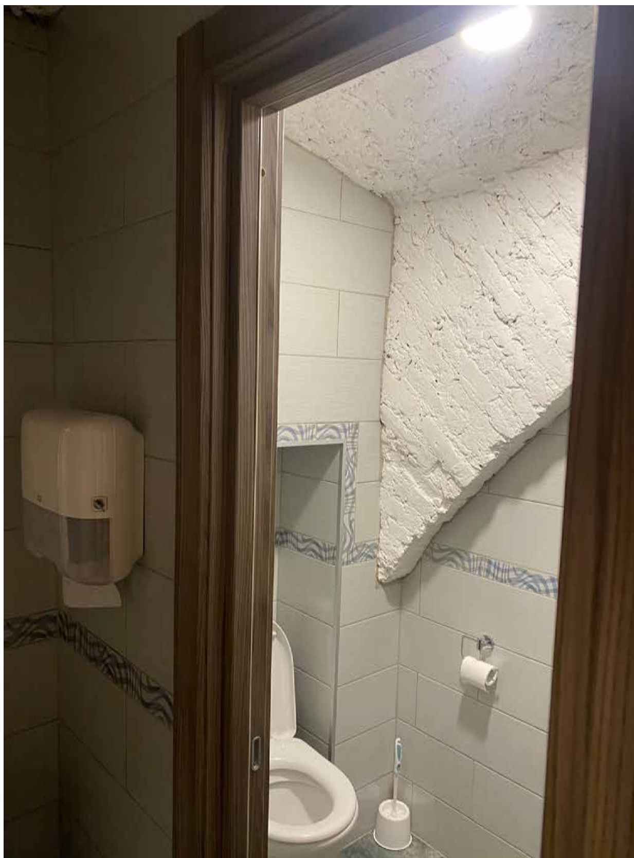
13.Фрагмент интеръера туалета (помещение 10/1.6);
