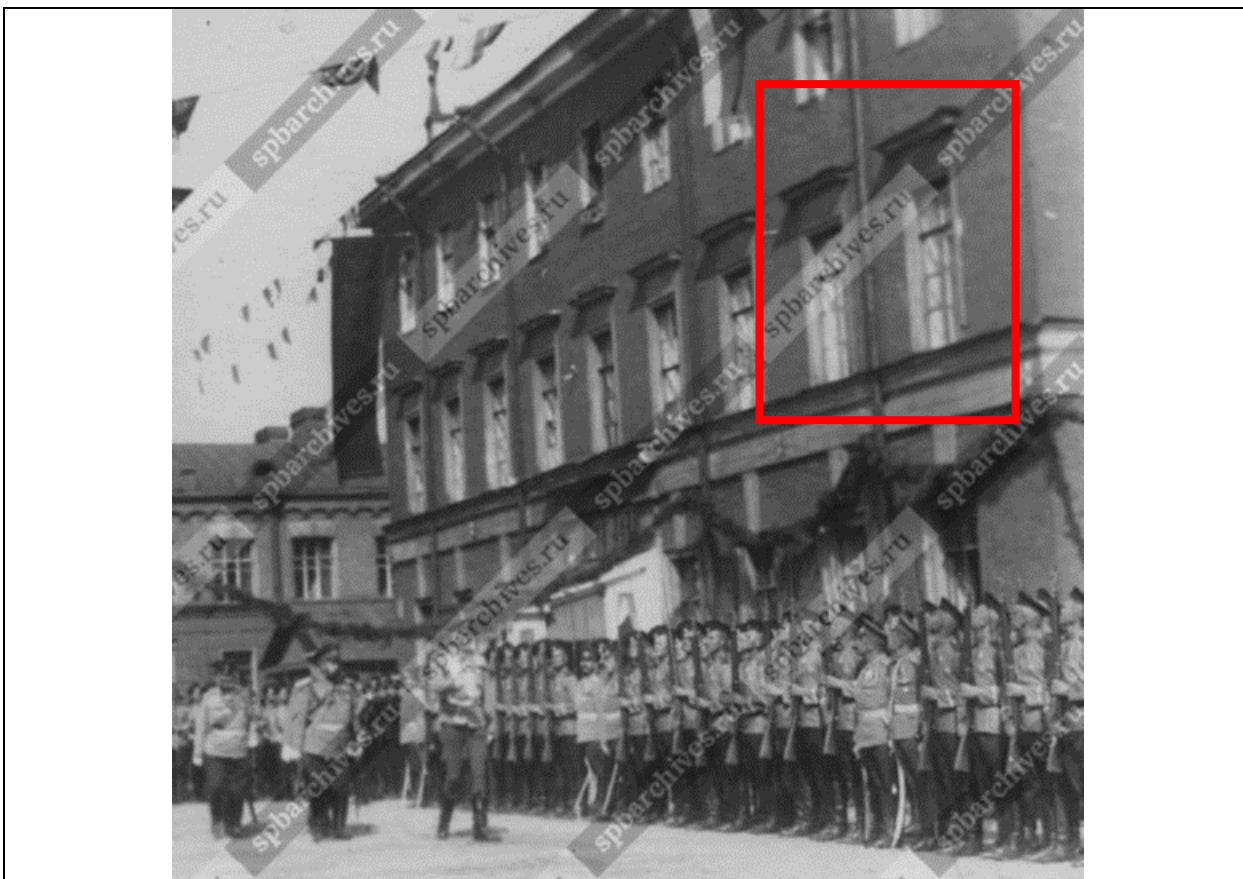
Фрагмент илл.5 датированной 1913 г. ЦГАКФФД СПб. Фотодокумент Д 17813. (Приложение №11). В уровне 2 этажа четко читается шестичастная расстекловка с двухчастной фрамугой оконного заполнения.
