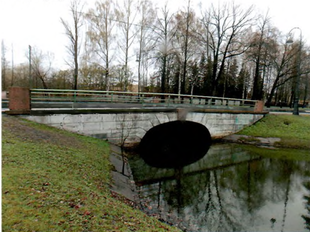
15. мост через р. Чухонку (на Южной дороге).
