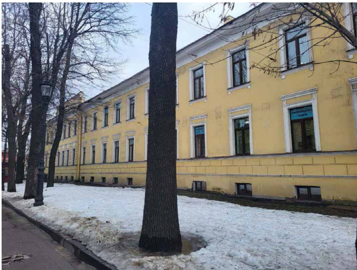
Фото 1. Объект культурного наследия регионального значения «Солдатская казарма» (г. Санкт-Петербург, Загородный пр., д. 48 лит. А), входящий в состав объекта культурного наследия регионального значения «Комплекс казарм Семеновского и Егерского полков».
