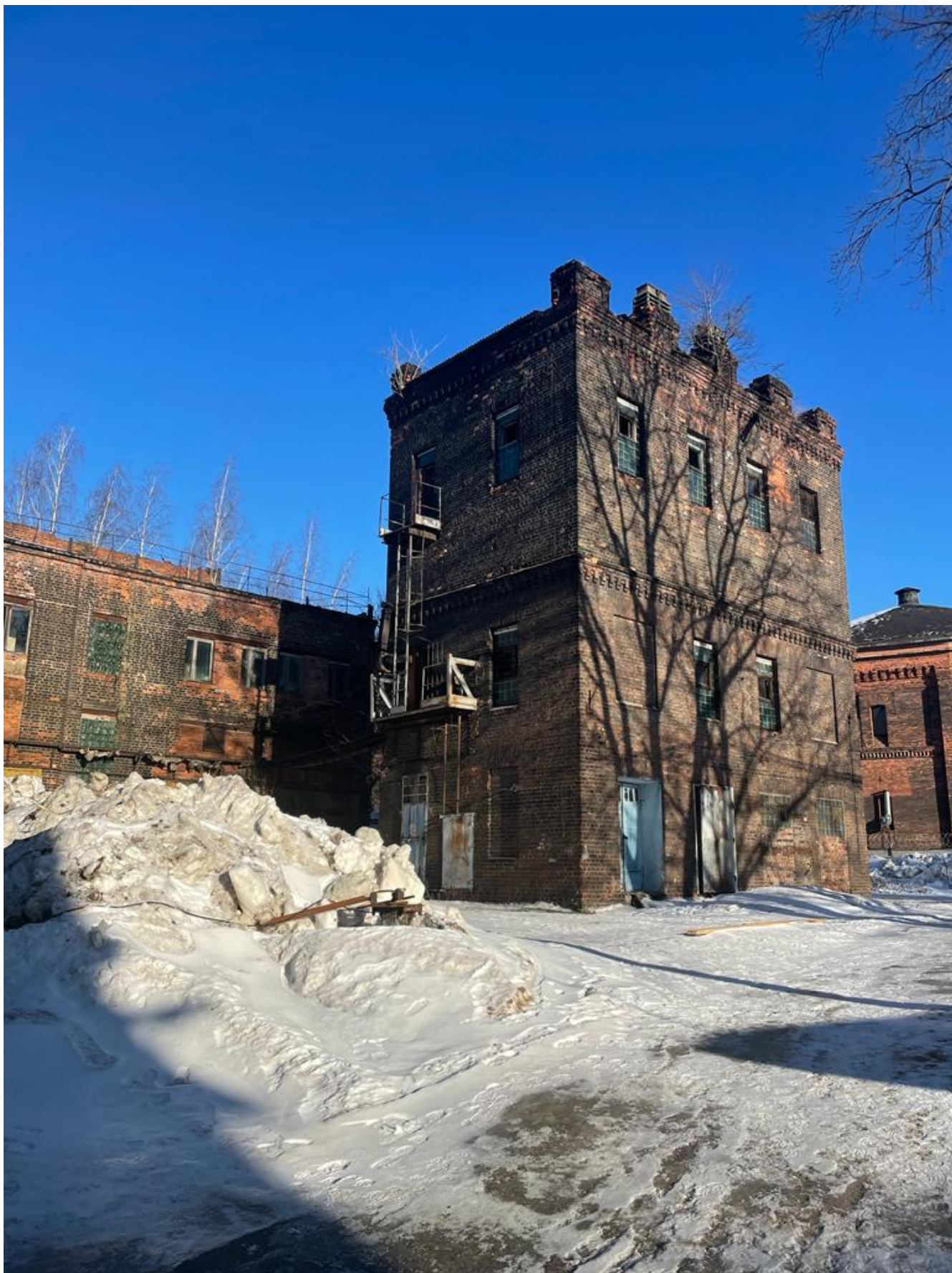
19. Выявленный объект культурного наследия «Электростанция Общества электрического освещения 1886 года», 1900–1910 гг., 1913–1915 гг., г. Санкт-Петербург, набережная Обводного канала, дом 76, литера В.
