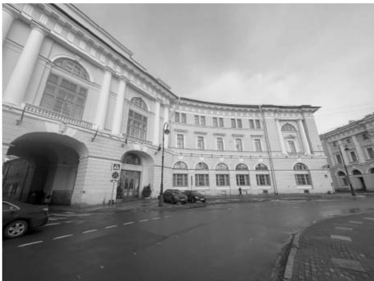
Фото 86. Общий вид фасада со стороны площади Ломоносова.
