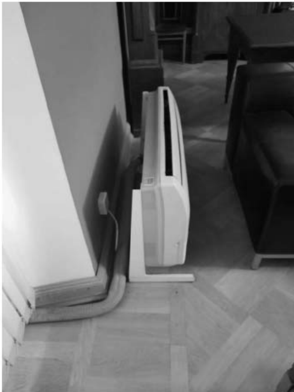
Фото 56. 3 этаж, каб. Б1.
