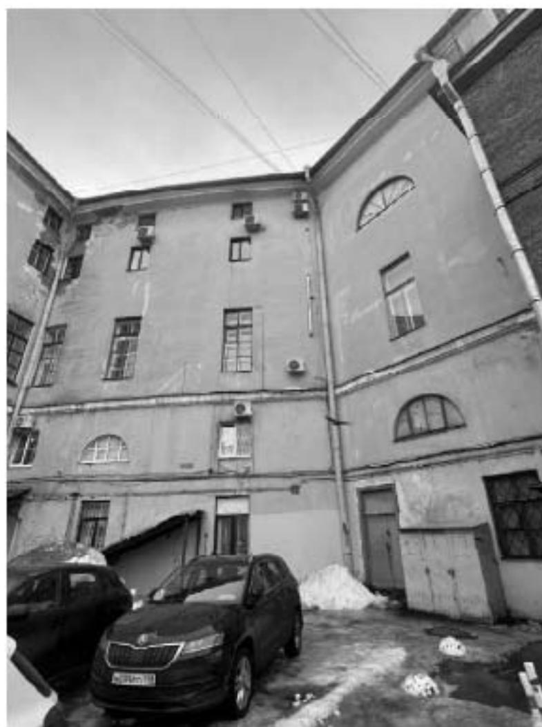
Фото 92. Общий вид фасада со стороны улицы Ломоносова.
