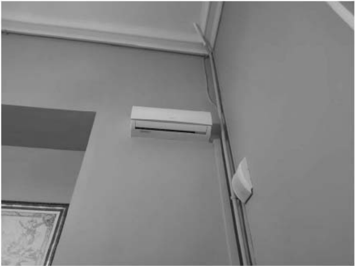
Фото 61. 3 этаж, каб. Б1.
