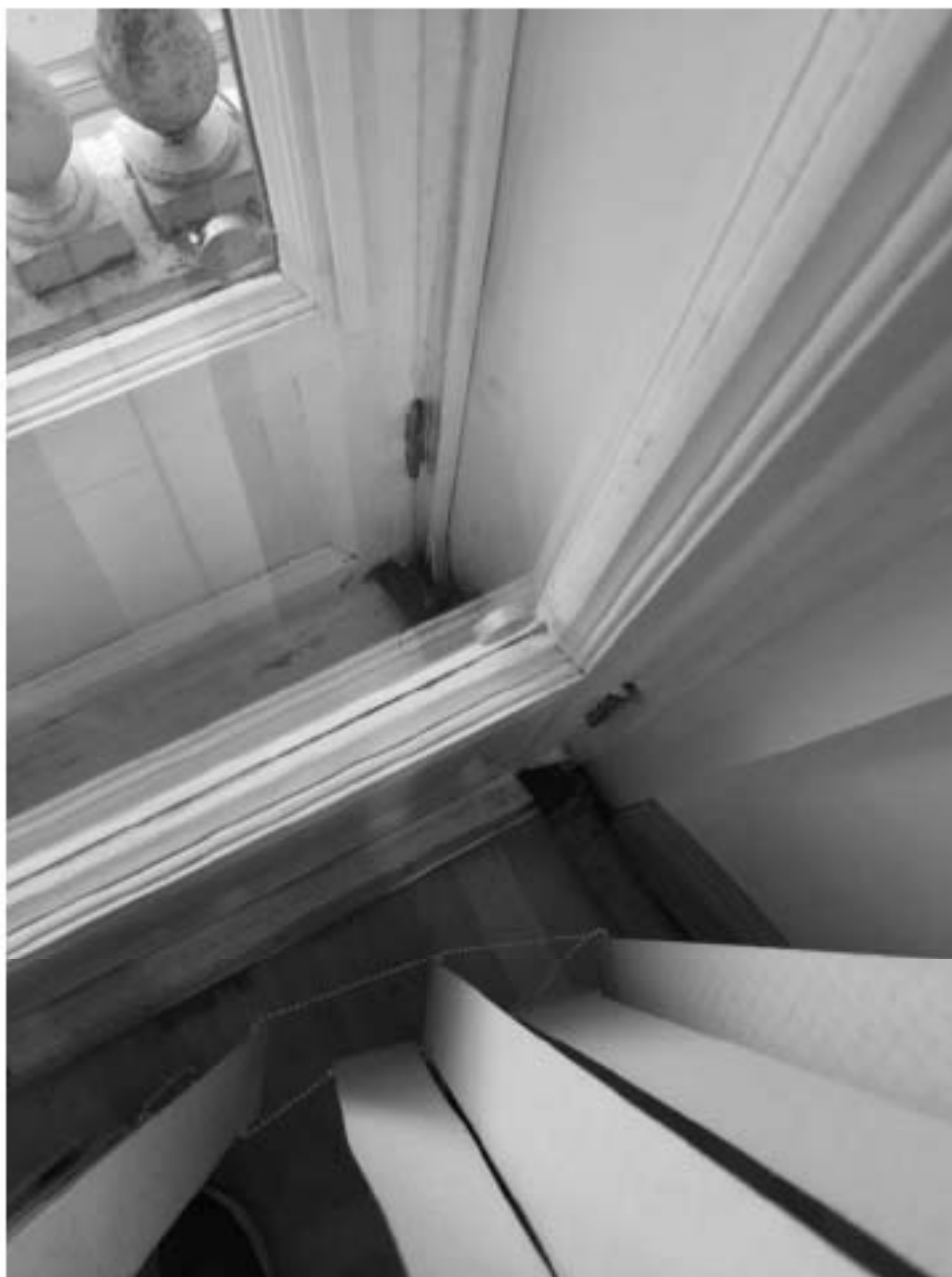
Фото 58. 3 этаж, каб. Б1.
