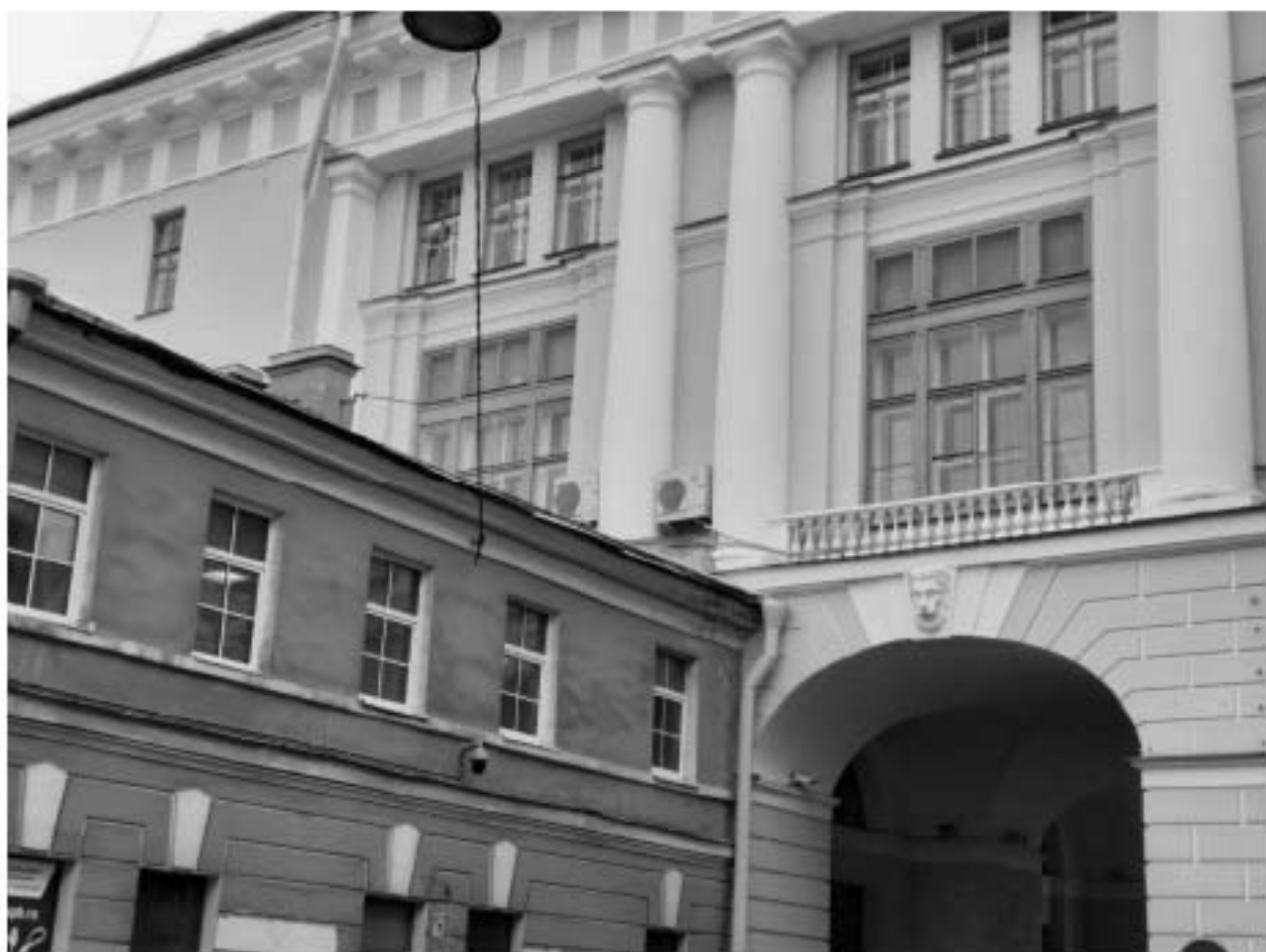
Фото 89. Общий вид фасада со стороны улицы Ломоносова.
