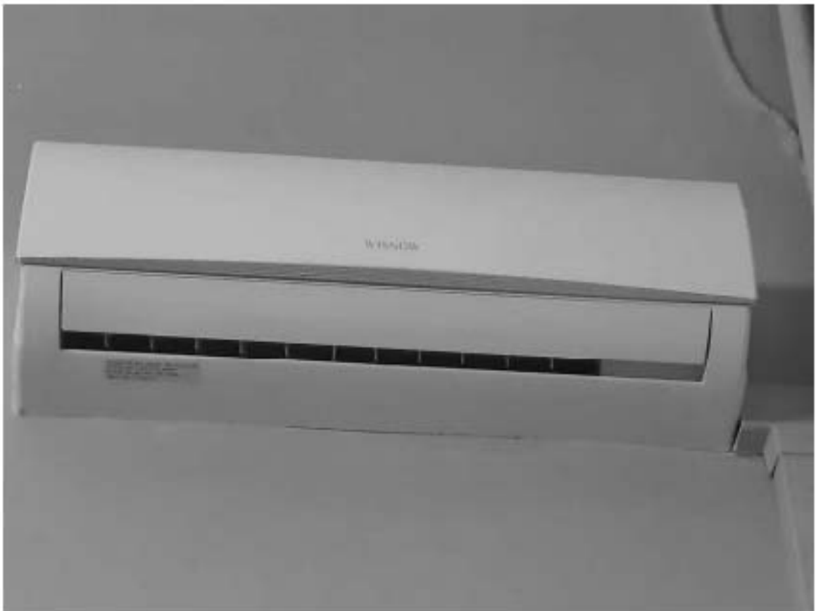
Фото 62. 3 этаж, каб. Б1.
