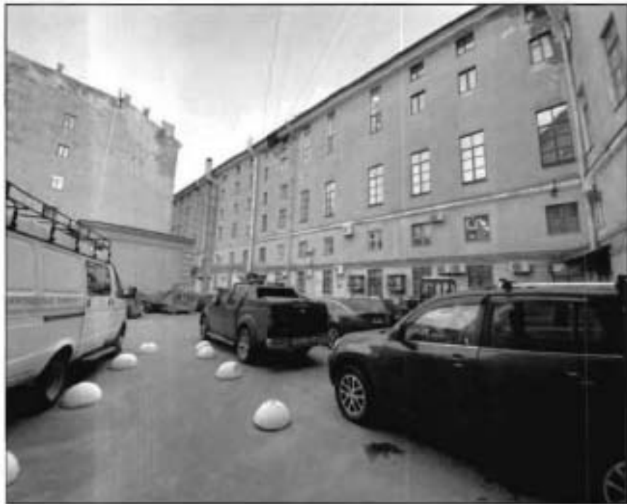
19. Дворовый фасад лицевого корпуса (ул. Зодчего Росси). Общий вид. Фото от 09.11.2021 г.
