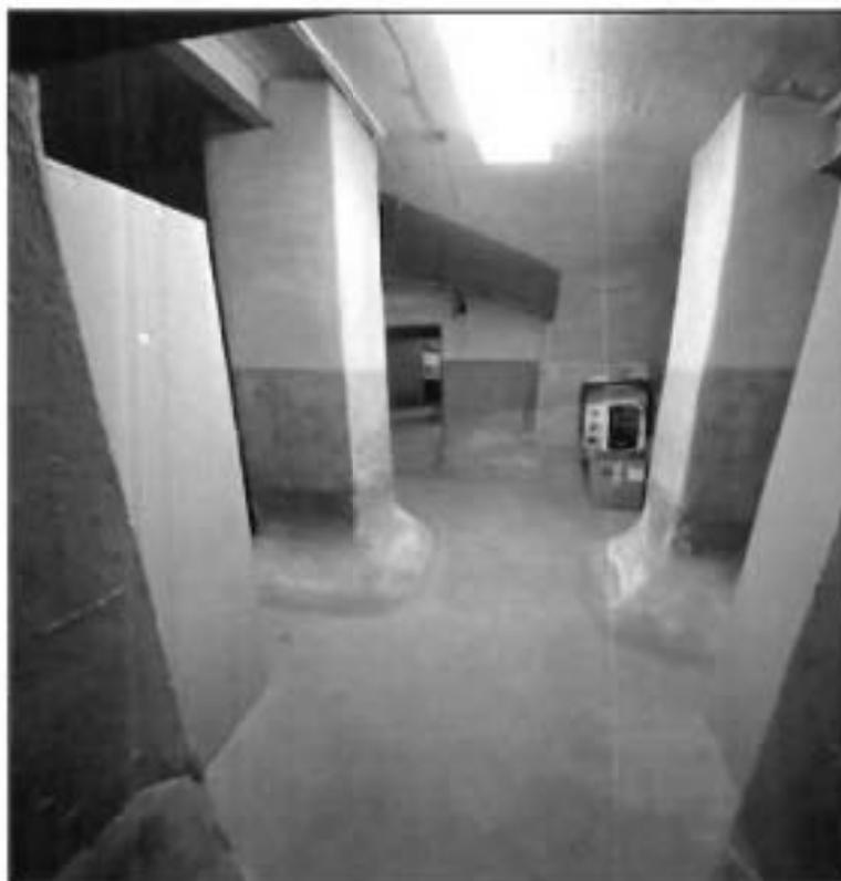
52. Пилоны подвальных помещений. Фото от 19.11.2021 г.
