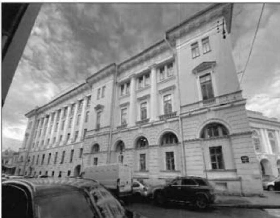
4. Общий вид на южный фасад со стороны Торгового переулка. Фото от 19.11.2021 г.
