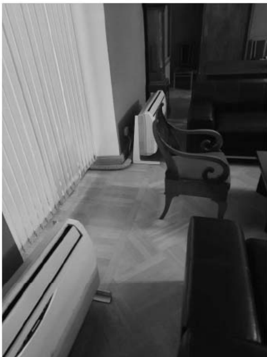
Фото 55. 3 этаж, каб. Б1.
