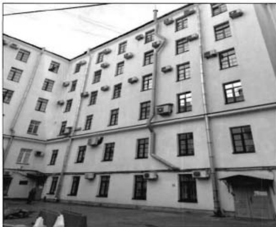
20. Восточный дворовый фасад дворового корпуса (центральный внутренний двор № 2). Фото от 09.11.2021 г.
