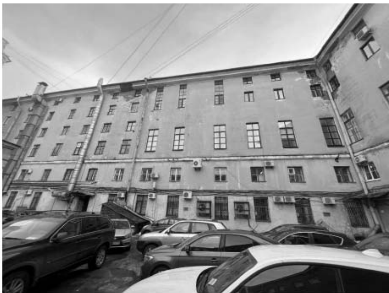
Фото 93. Общий вид фасада со стороны улицы Ломоносова.
