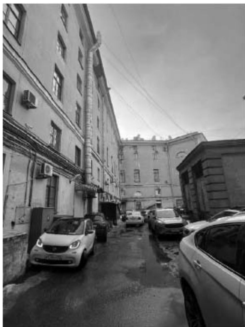
Фото 91. Общий вид фасада со стороны улицы Ломоносова.
