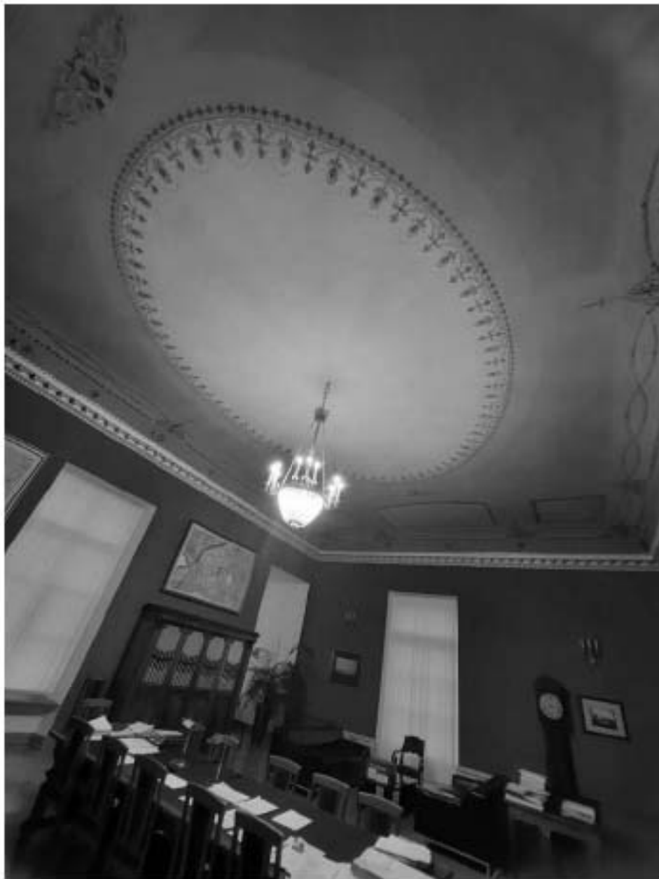
Фото 54. 3 этаж, каб. Б1.
