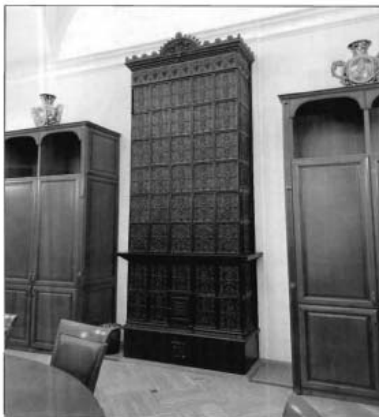
49. Печь средистенная, двухъярусная, облицована темно-коричневым рельефным изразцом (пом. (27-Н (3))). Фото от 16.11.2021 г.
