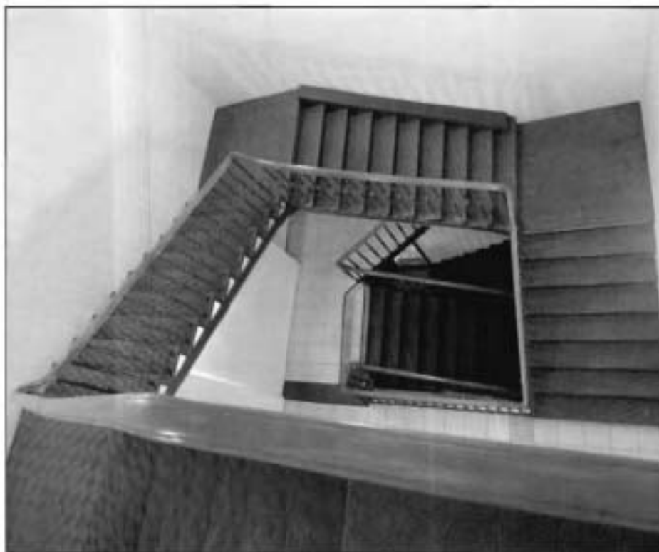
31. Четырехмаршевая железная лестница в пом. 21-Н (20) в угловой части корпусов по пл. Ломоносова и ул. Зодчего Росси. Фото от 16.11.2021 г.
