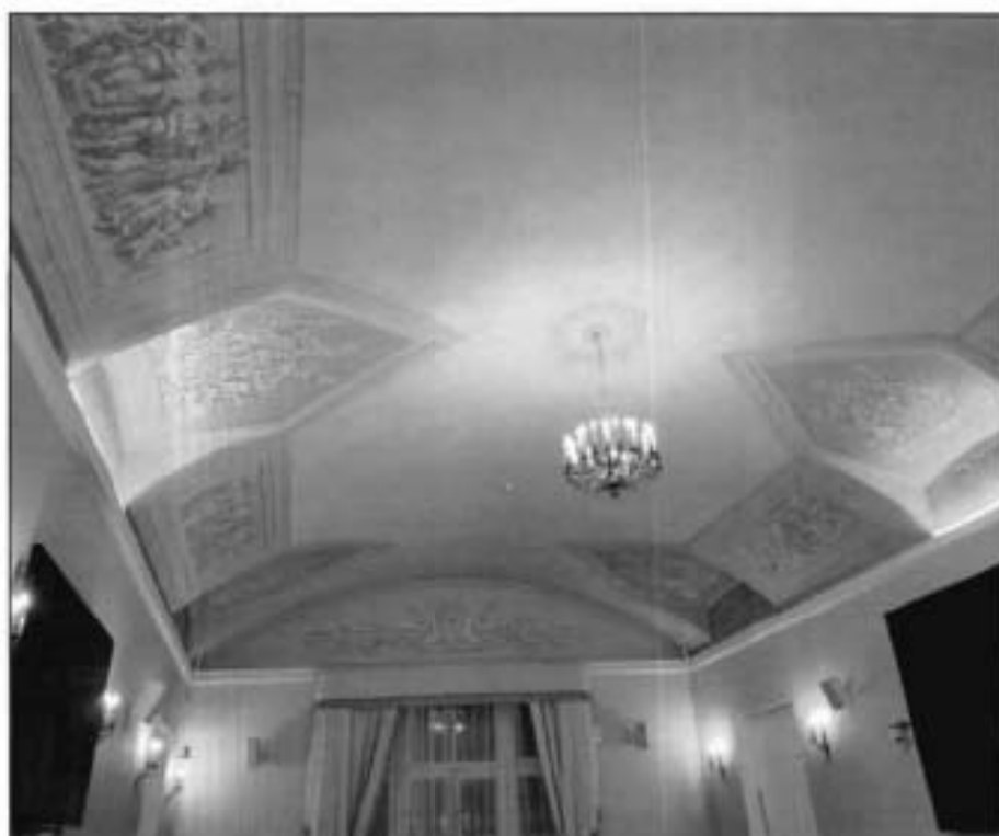
39. Декоративно художественная отделка помещений (пом. 30-Н (33)) в уровне 3-го этажа. Живописный плафон. Фото от 16.11.2021 г.
