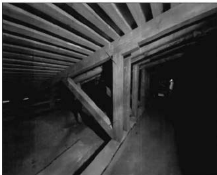
25. Стропильная система дворовых корпусов и флигелей (центральный дворовый флигель). Фото от 18.11.2021 г.
