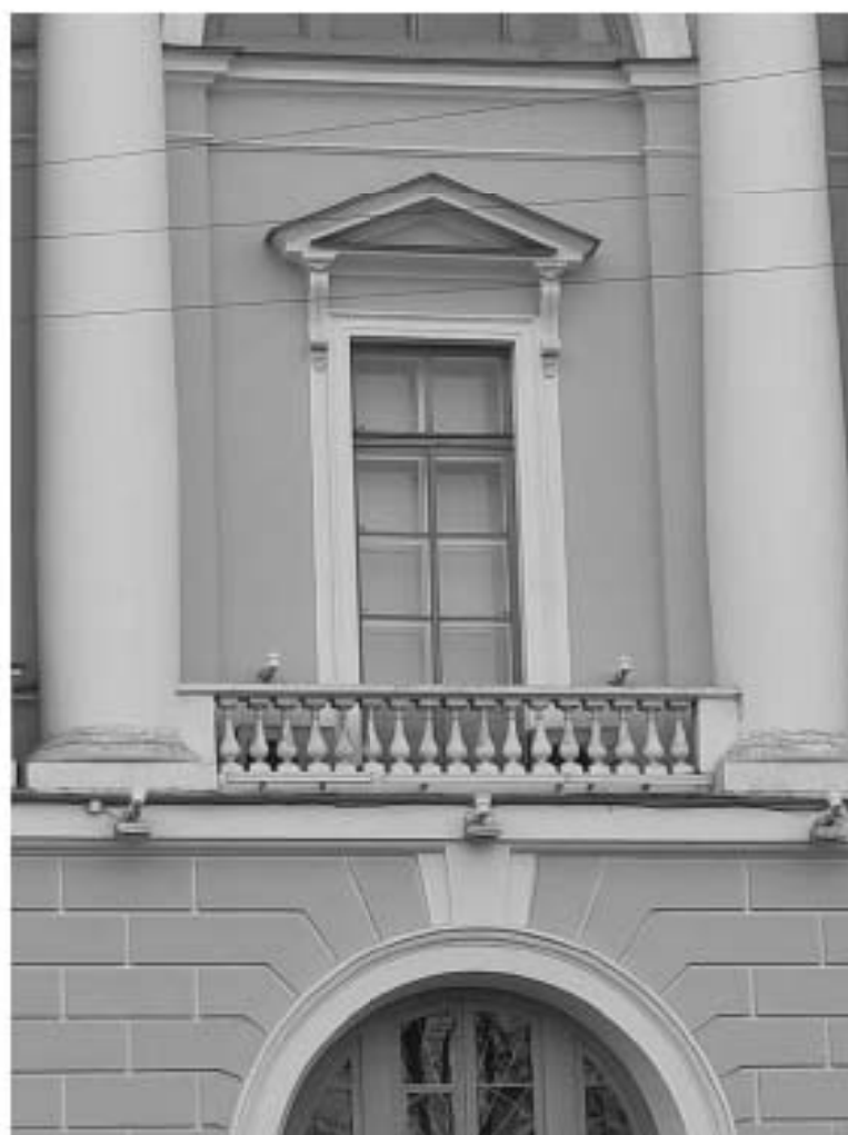
Фото 87. Общий вид фасада со стороны площади Ломоносова.
