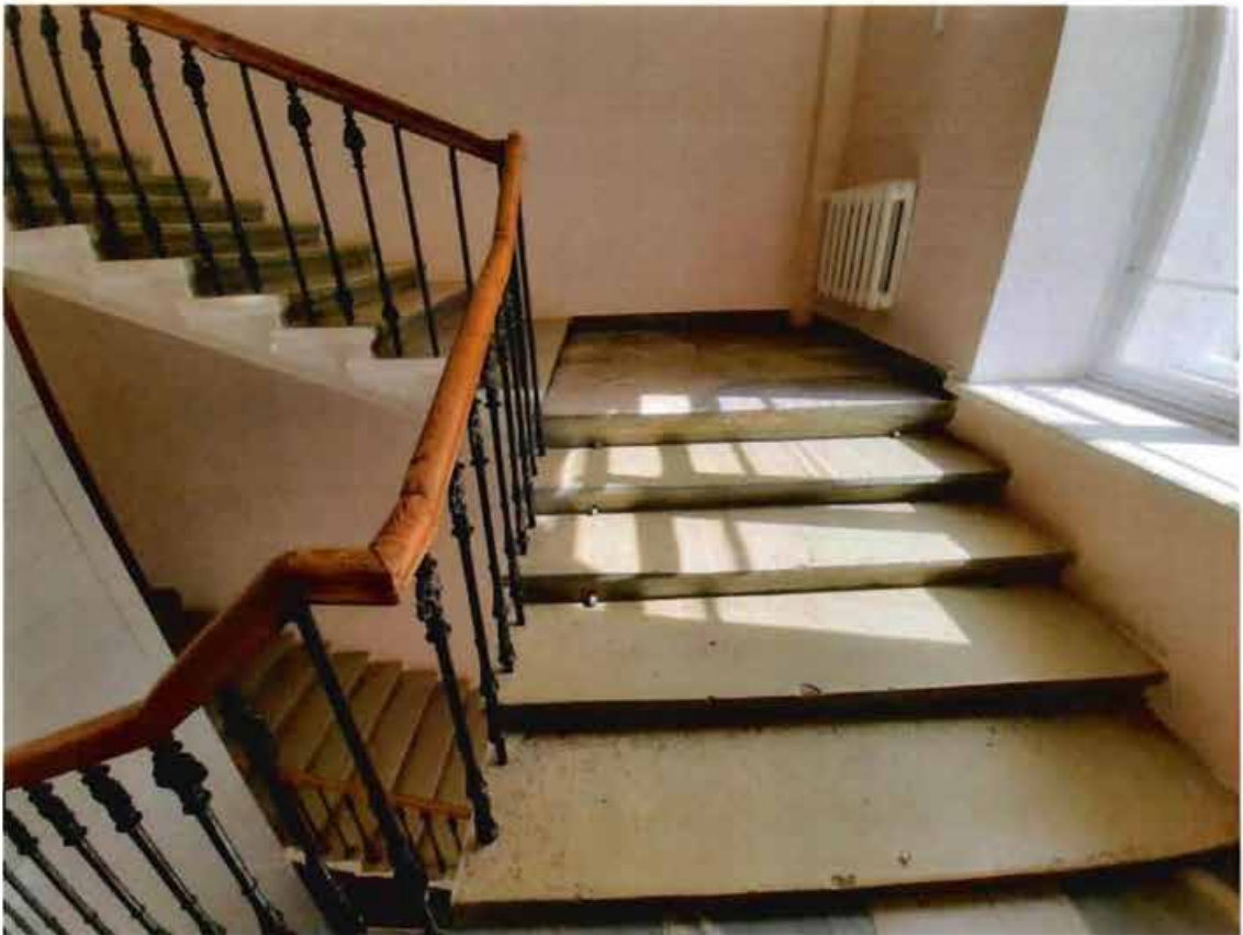
18. Лестница ЗЛК объекта культурного наследия (20.05.2022)
