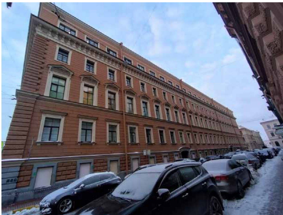
Фото 5. Лицевой фасад объекта культурного наследия федерального значения «Корпус для прислуги», входящего в состав объекта культурного наследия федерального значения «Дворец Великого князя Николая Николаевича (Ксенинский институт)» (со стороны Замятина переулка)
