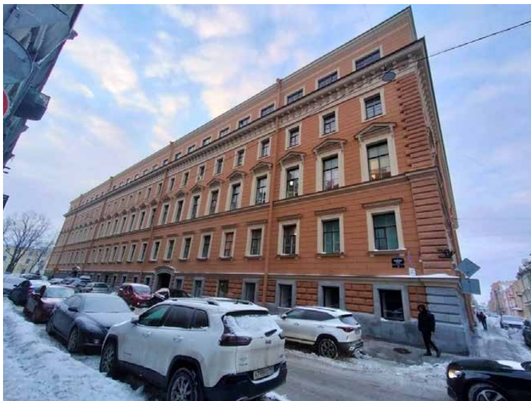
Фото 6. Лицевой фасад объекта культурного наследия федерального значения «Корпус для прислуги», входящего в состав объекта культурного наследия федерального значения «Дворец Великого князя Николая Николаевича (Ксенинский институт)» (со стороны Замятина переулка)
