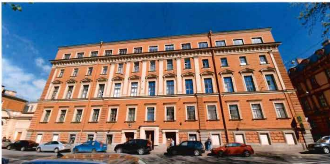
1. Общий вид на юго-восточный фасад объекта культурного наследия (20.05.2022)
