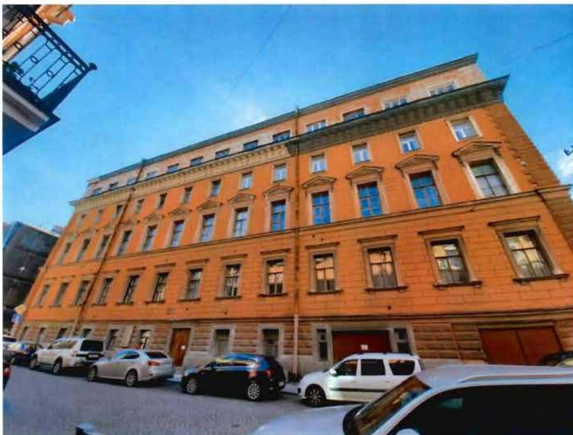
3. Общий вид на северо-западный фасад объекта культурного наследия (20.05.2022)
