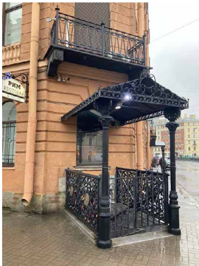
Фото 5. Фрагмент лицевого фасада выявленного объекта культурного наследия «Дом Зверкова (И.С. Никитина)», вход в пом. 4-Н
