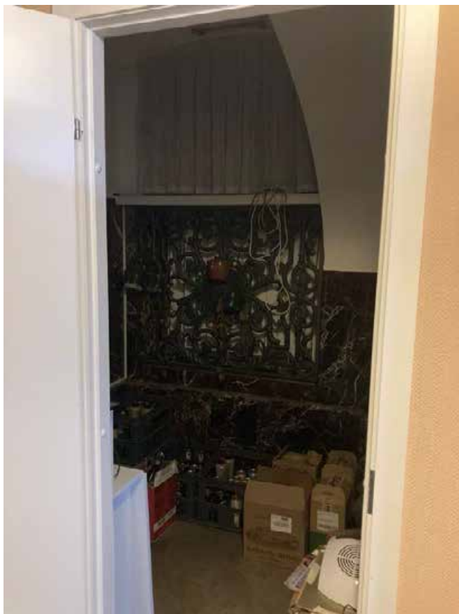
Фото 25. Интерьер помещения №4-Н выявленного объекта культурного наследия «Дом Зверкова (И.С. Никитина)»
