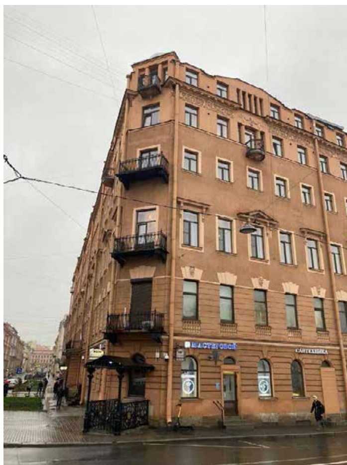
Фото 4. Фрагмент лицевого фасада выявленного объекта культурного наследия «Дом Зверкова (И.С. Никитина)»
