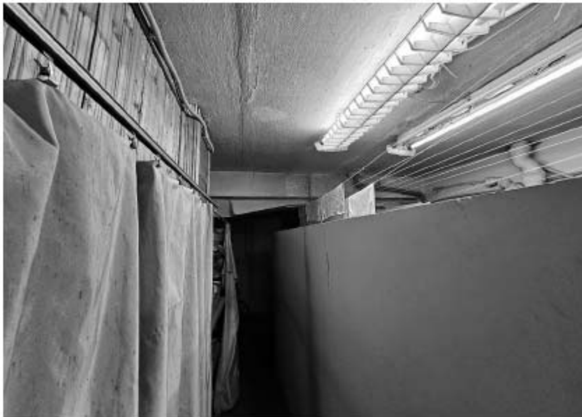
14. Выявленный объект культурного наследия «Особняк», в составе выявленного объекта культурного наследия «Особняк В.Ф. Друри (со службами, садом, кирпичной оградой)», по адресу: г. Санкт-Петербург, ул. Степана Разина, д. 86/231, лит. А. Общий вид пом. 1-Н (12) в уровне цокольного этажа.
