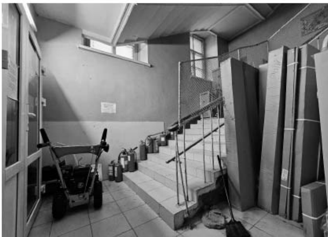
9. Выявленный объект культурного наследия «Особняк», в составе выявленного объекта культурного наследия «Особняк В.Ф. Друри (со службами, садом, кирпичной оградой)», по адресу: г. Санкт-Петербург, ул. Степана Разина, д. 86/231, лит. А. Общий вид объема лестницы 1-ЛК в уровне цокольного этажа.
