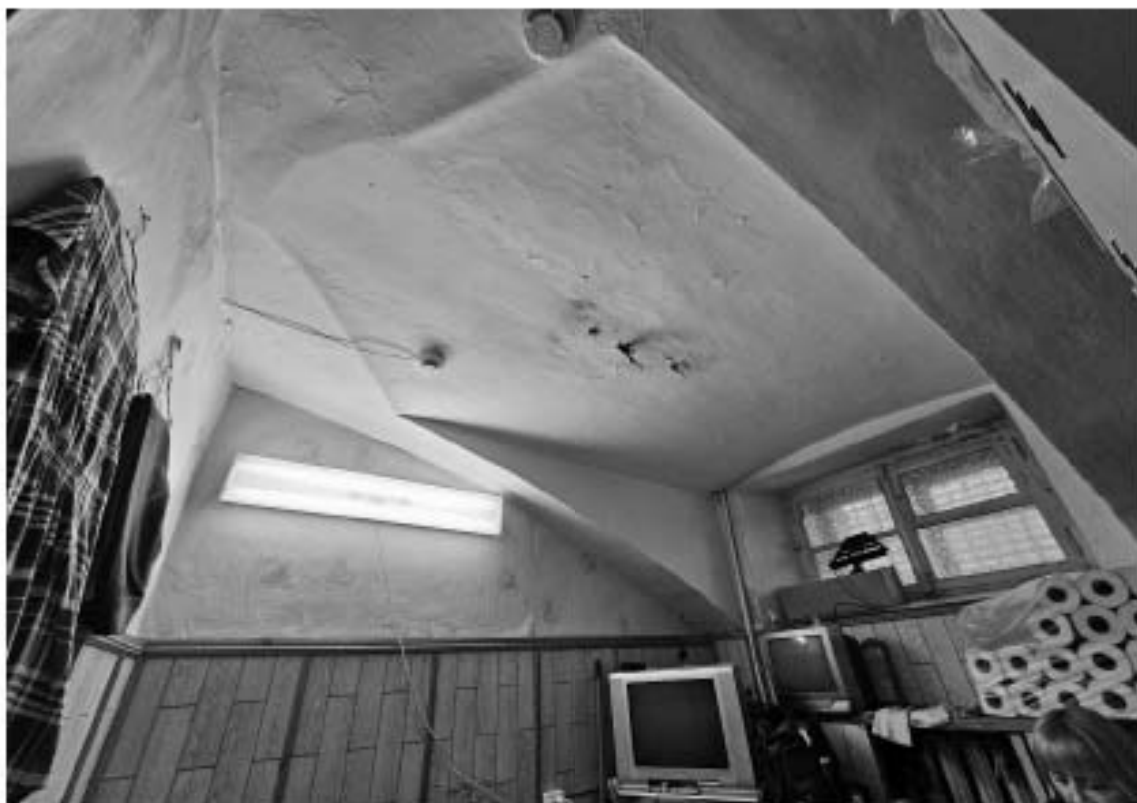
19. Выявленный объект культурного наследия «Особняк», в составе выявленного объекта культурного наследия «Особняк В.Ф. Друри (со службами, садом, кирпичной оградой)», по адресу: г. Санкт-Петербург, ул. Степана Разина, д. 86/231, лит. А. Общий вид пом. 6-Н (4) в уровне цокольного этажа.
