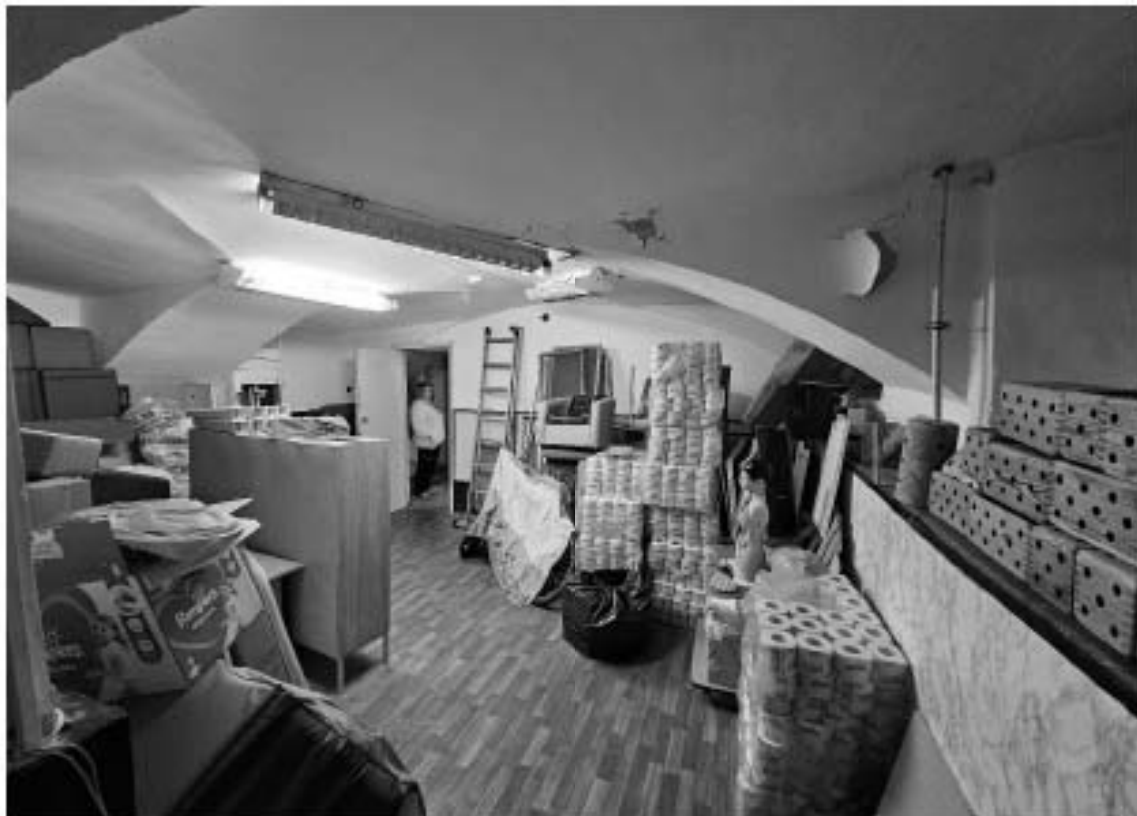
10. Выявленный объект культурного наследия «Особняк», в составе выявленного объекта культурного наследия «Особняк В.Ф. Друри (со службами, садом, кирпичной оградой)», по адресу: г. Санкт-Петербург, ул. Степана Разина, д. 86/231, лит. А. Общий вид пом. 1-Н (1) в уровне цокольного этажа.
