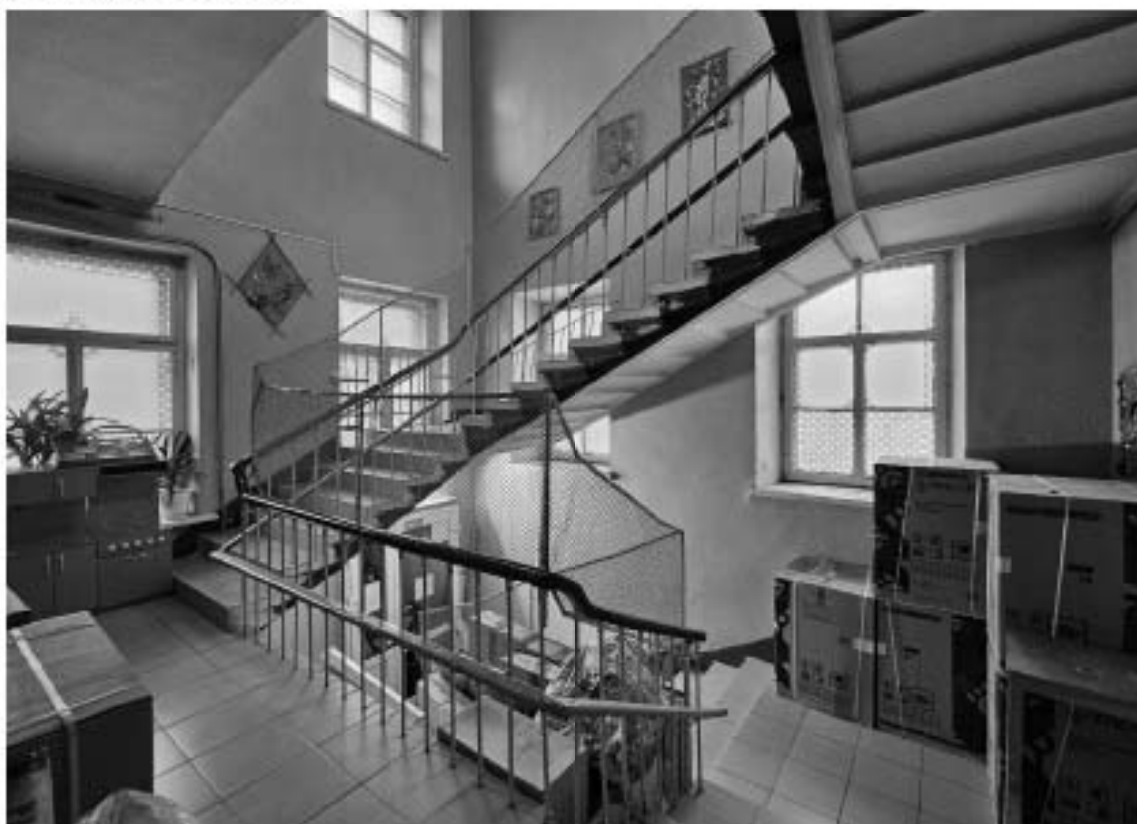
37. Выявленный объект культурного наследия «Особняк», в составе выявленного объекта культурного наследия «Особняк В.Ф. Друри (со службами, садом, кирпичной оградой)», по адресу: г. Санкт-Петербург, ул. Степана Разина, д. 86/231, лит. А. Общий вид объема лестницы 1-ЛК в уровне 1-го этажа.
