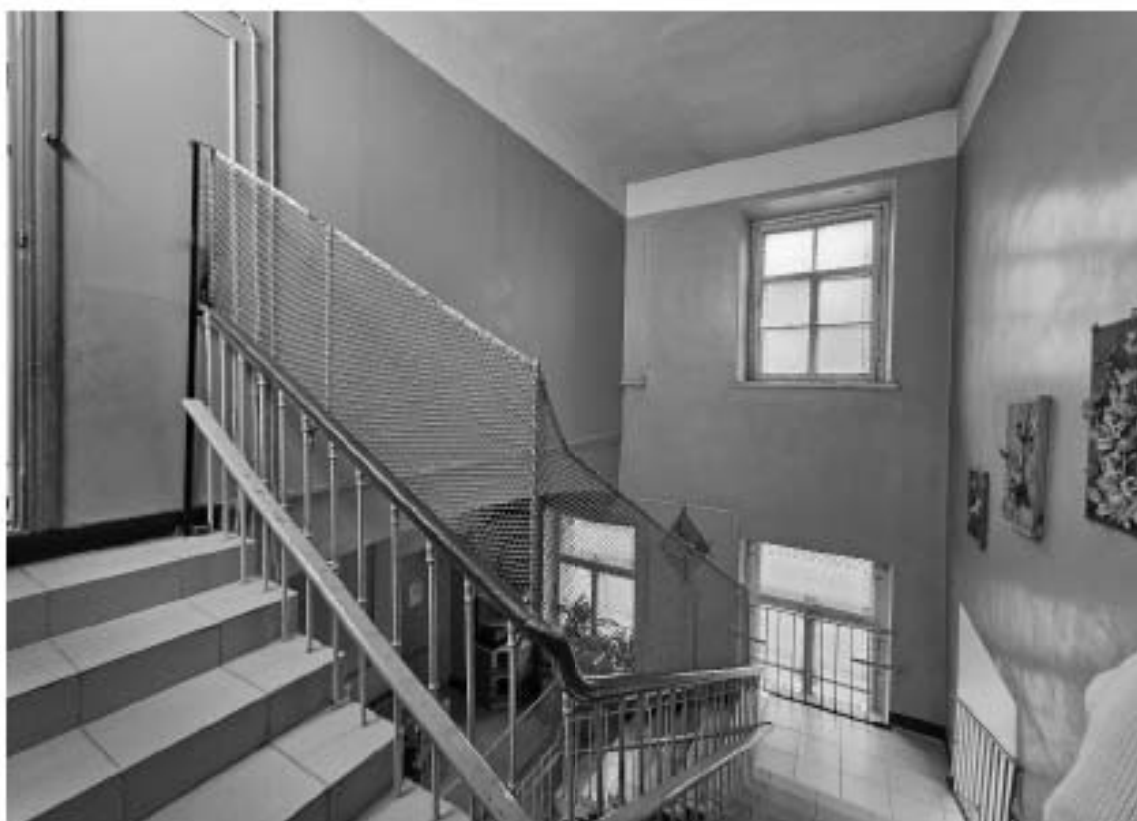
38. Выявленный объект культурного наследия «Особняк», в составе выявленного объекта культурного наследия «Особняк В.Ф. Друри (со службами, садом, кирпичной оградой)», по адресу: г. Санкт-Петербург, ул. Степана Разина, д. 86/231, лит. А. Общий вид объема лестницы 1-ЛК в уровне 2-го этажа.
