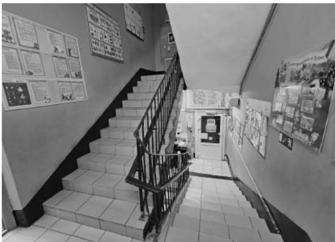
24. Выявленный объект культурного наследия «Особняк», в составе выявленного объекта культурного наследия «Особняк В.Ф. Друри (со службами, садом, кирпичной оградой)», по адресу: г. Санкт-Петербург, ул. Степана Разина, д. 86/231, лит. А. Общий вид лестницы 2-ЛК в уровне 1-го этажа.
