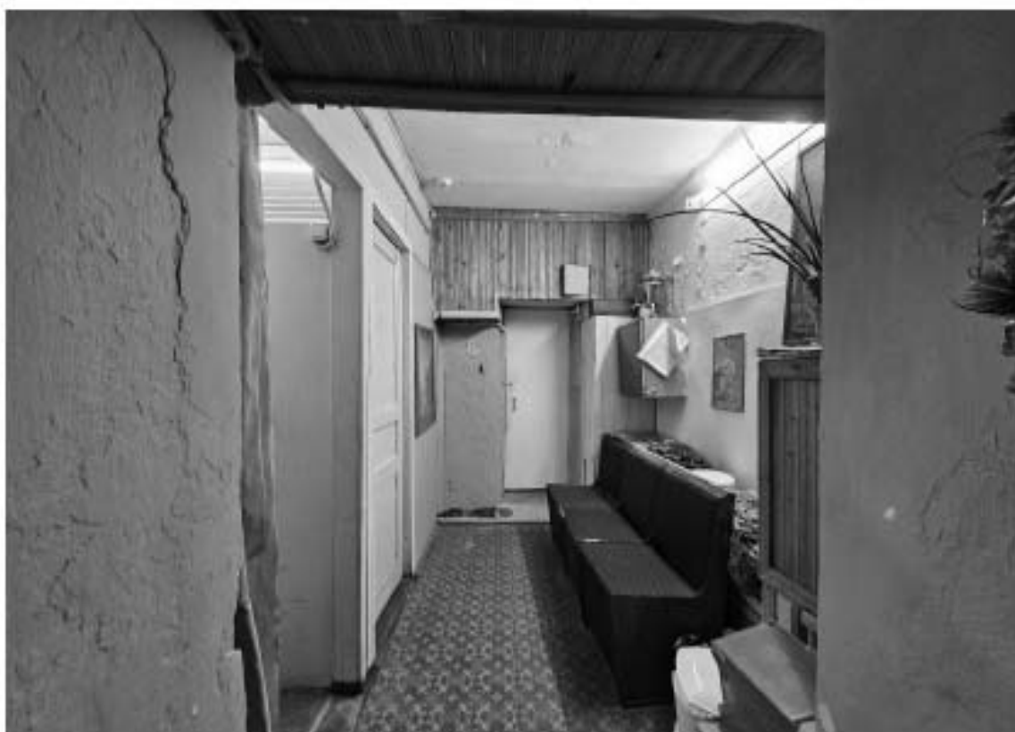
13. Выявленный объект культурного наследия «Особняк», в составе выявленного объекта культурного наследия «Особняк В.Ф. Друри (со службами, садом, кирпичной оградой)», по адресу: г. Санкт-Петербург, ул. Степана Разина, д. 86/231, лит. А. Общий вид пом. 1-Н (9) в уровне цокольного этажа.
